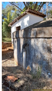
Foto 9 - Lateral do reservatório
