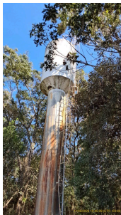
Foto 3 - Vista geral do reservatório
