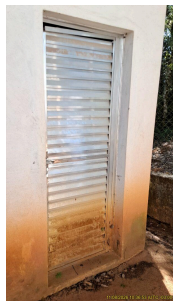
Foto 5 - Porta de acesso à elevatória
