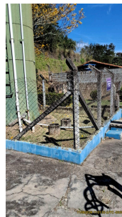
Foto 2 - Alamedado de delimitação da área
