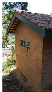
Foto 8 - Vista externa da elevatória
