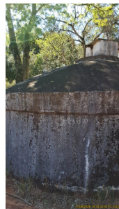
Foto 8 - Lateral do reservatório
