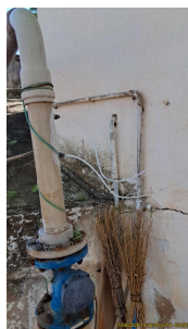
Foto 3 - Aplicação de cloro e flúor
