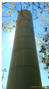
Foto 4 - Lateral do reservatório
