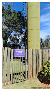
Foto 7 - Fachada do local do reservatório
