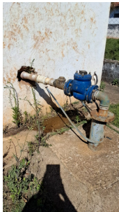
Foto 1 - Estrutura do poço
