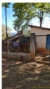
Foto 1 - Fachada do local onde está o reservatório
