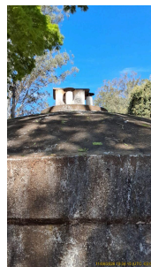
Foto 10 - Lateral do reservatório
