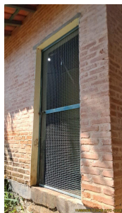
Foto 7 - Portão de acesso
