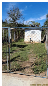
Foto 8 - Portão de entrada da área do poço
