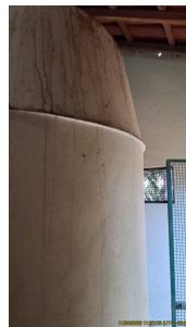
Foto 6 - Lateral do reservatório
