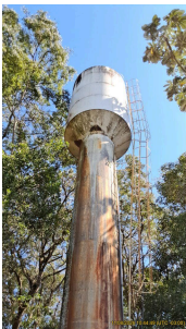
Foto 2 - Vista geral do reservatório
