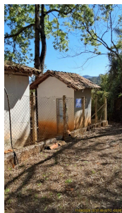
Foto 7 - Alambrado para cercamento do local
