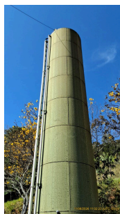
Foto 3 - Lateral do reservatório
