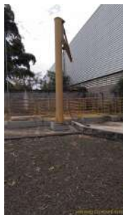
Foto 11 - Poços e talha para içamento.
