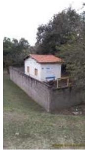
Foto 1 - Visão geral da elevatória.
