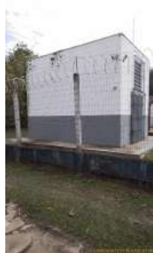
Foto 13 - Abrigo do gerador
