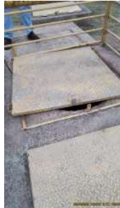
Foto 7 - Poço do cesto peneira
