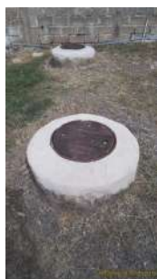
Foto 15 - Gradeamento grosseiro na entrada.
