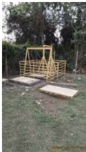
Foto 3 - Poços e talha para içamento.
