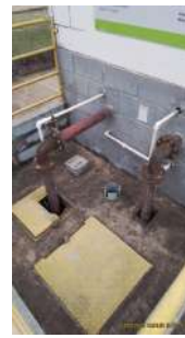
Foto 6 - Poço de sucção.
