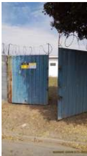
Foto 2 - Portão de acesso
