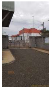
Foto 6 - Portão de acesso.
