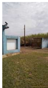
Foto 2 - Portão de acesso
