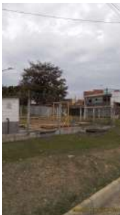
Foto 2 - Visão geral da elevatória.
