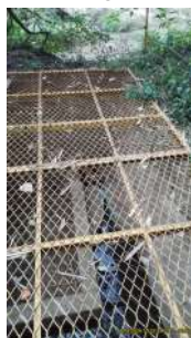
Foto 13 - Calha parshall no lançamento.
