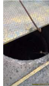
Foto 8 - Poço do cesto peneira
