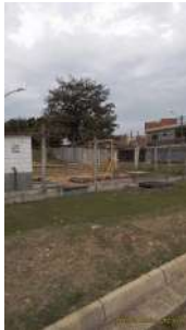
Foto 3 - Visão geral da elevatória.
