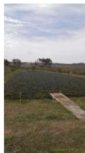
Foto 11 - Lagoa de maturação. De acordo com o prestador, os aguapés auxiliam na remoção de nitrogênio e fósforo presentes no efluente.
