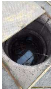
Foto 9 - Poço do cesto peneira
