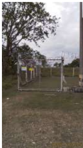
Foto 1 - Portão de acesso.
