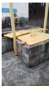
Foto 9 - Poço do cesto peneira
