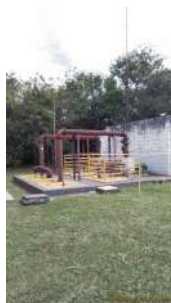
Foto 3 - Visão geral da elevatória.
