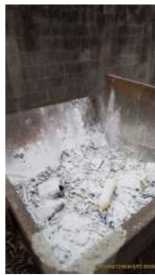
Foto 11 - Caçamba com detritos removidos pelo cesto peneira e cal aplicada inibir o odor.
