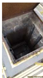
Foto 4 - Poço do cesto peneira
