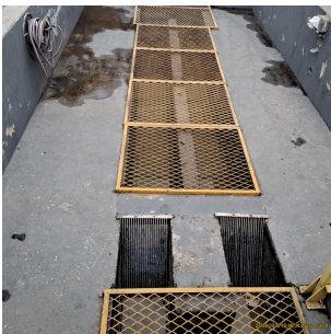
Foto 3 - Gradeamaneto e desarenador
