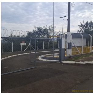
Foto 1 - Vista do interior da estação elevatória de esgoto Interlagos
