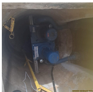
Foto 4 - Vista interna do poço de sucção
