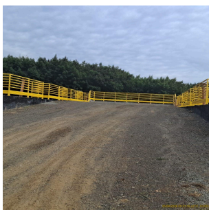
Foto 6 - Rampa de distribuição dos resíduos das elevatórias de esgoto para os geobags
