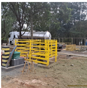
Foto 8 - Ponto de recebimento de efluente de banheiros químicos
