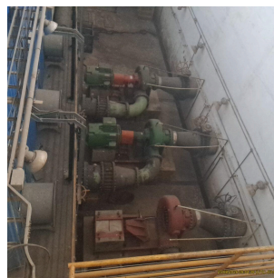
Foto 12 - Vista superior da elevatória
