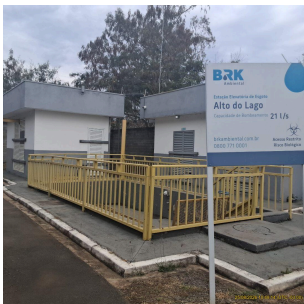
Foto 2 - Vista do interior da estação elevatória de esgoto Alto do Lago
