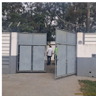
Foto 1 - Vista externa da estação elevatória de esgoto José Cortez
