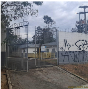
Foto 1 - Vista externa da estação elevatória de esgoto Alto do Lago
