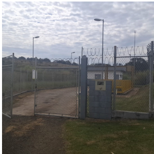
Foto 1 - Vista externa da estação elevatória de esgoto Rubi
