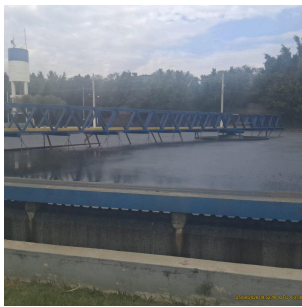
Foto 16 - Vista da saída do decantador primário
