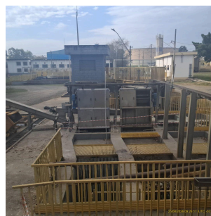
Foto 3 - Vista superior do tratamento preliminar
