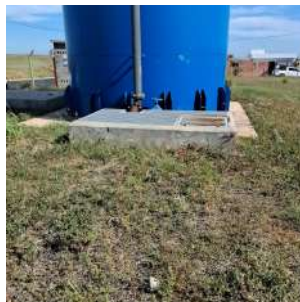
Foto 4 - Abertura final do tubo extravasor e seu local de lançamento.
