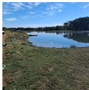
Foto 6 - Vista geral da lagoa anaeróbica.
