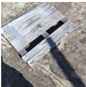
Foto 1 - Abertura com proteção inadequada.
