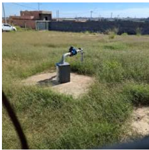
Foto 3 - Laje de proteção.
