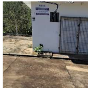
Foto 6 - Placa de identificação instalada na edificação onde se encontra o painel elétrico da bomba.
