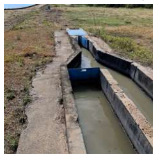
Foto 4 - Caixas de areia do sistema de tratamento preliminar de esgoto. Parte final com comporta para direcionamento do fluxo.
