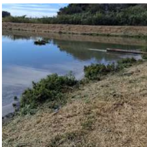
Foto 5 - Ponto de entrada do esgoto na lagoa anaeróbica.
