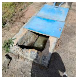
Foto 6 - Ponto de saída do tratamento preliminar.
