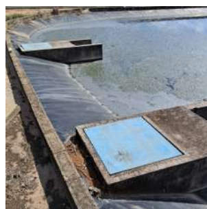
Foto 11 - Borda da lagoa aeróbica.
