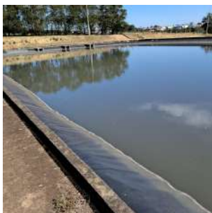
Foto 9 - Lagoas anaeróbicas. O sistema é composto por duas lagoas, com direcionamento do fluxo entre as unidades.
