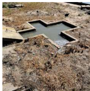
Foto 10 - Passagem do esgoto entre as lagoas anaeróbicas.
