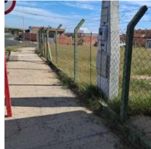
Foto 6 - Cercamento que abrange tanto o poço quanto o reservatório.
