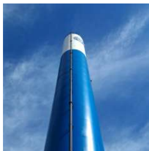
Foto 5 - Tubulação de abastecimento.
