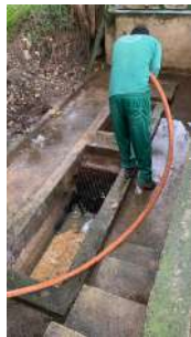
Foto 1 - Limpeza do gradeamento (registro feito pelo prestador).
