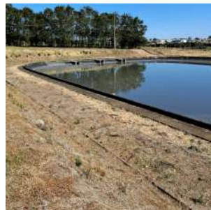
Foto 8 - Lagoas anaeróbicas. O sistema é composto por duas lagoas, com direcionamento do fluxo entre as unidades.
