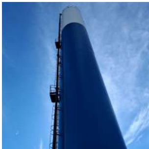
Foto 1 - Vista geral do reservatório.
