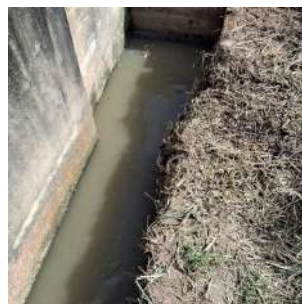
Foto 4 - Ponto de saída do efluente do sistema de tratamento preliminar para as lagoas.
