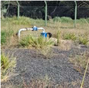
Foto 1 - Vista geral do poço.
