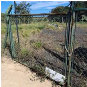
Foto 4 - Cercamento da área do poço.
