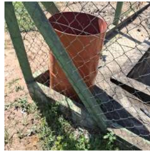
Foto 2 - Tambor para armazenamento de de resíduos retirado do gradeamento 1.
