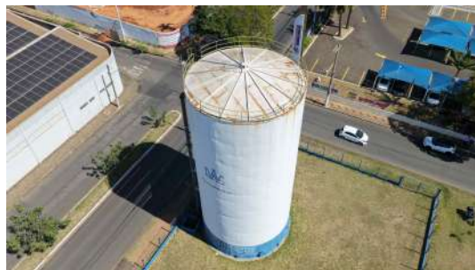
Foto 6 - Visão geral do reservatório
