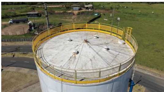
Foto 17 - Cobertura do reservatório.
