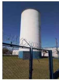
Foto 2 - Visão geral do reservatório
