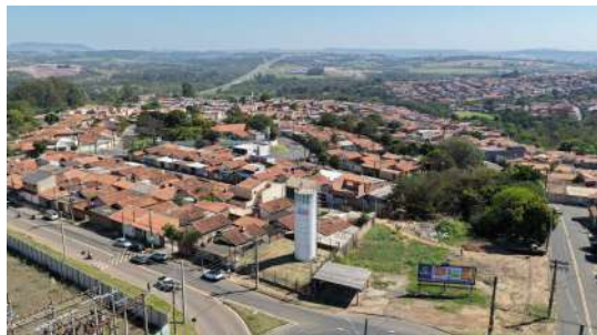
Foto 3 - Localização do reservatório.
