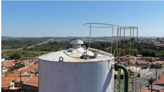
Foto 13 - Guarda corpo e chaminé de ventilação.
