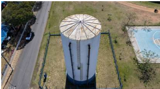
Foto 9 - Tubulação de alimentação, escada e extravasor.
