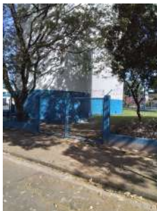
Foto 5 - Portão de acesso
