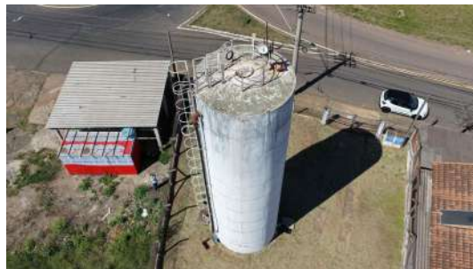
Foto 4 - Visão geral do reservatório
