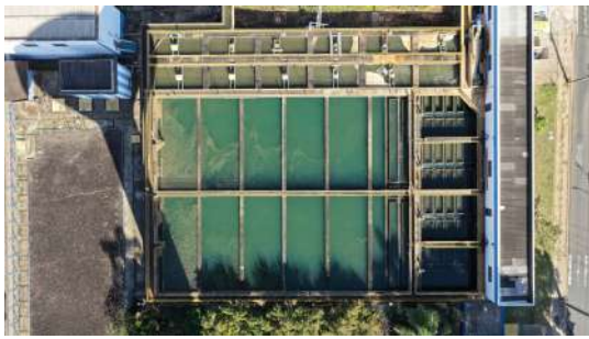
Foto 3 - Imagem aérea da ETA I.
