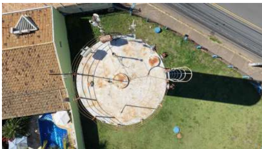
Foto 7 - Cobertura do reservatório.
