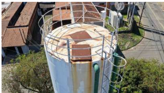
Foto 14 - Cobertura e guarda corpo.
