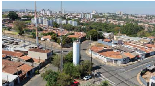
Foto 9 - Localização do reservatório.
