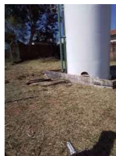
Foto 6 - Descida do extravasor
