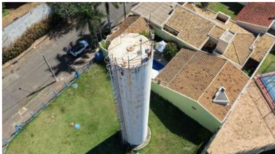
Foto 9 - Visão geral do reservatório
