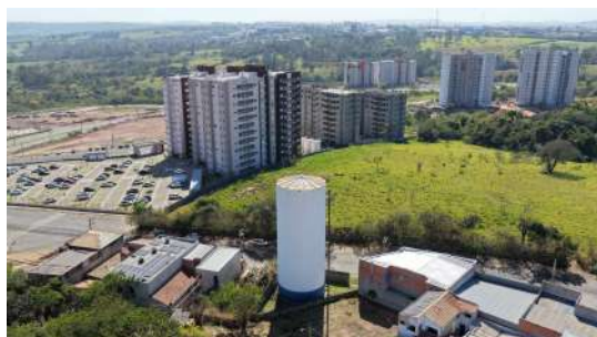
Foto 1 - Localização do reservatório Regina Picelli.
