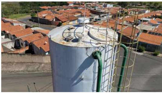
Foto 11 - Cobertura do reservatório.
