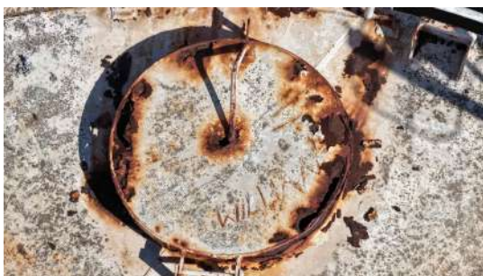
Foto 1 - Tampa de inspeção.
