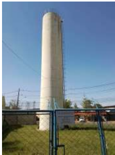
Foto 2 - Visão geral do reservatório
