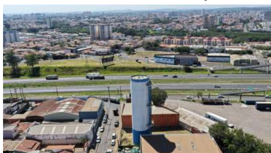
Foto 5 - Visão geral do reservatório.
