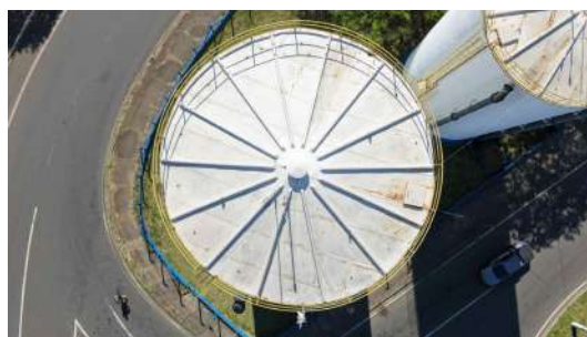
Foto 6 - Cobertura do reservatório Mãe Preta 1.
