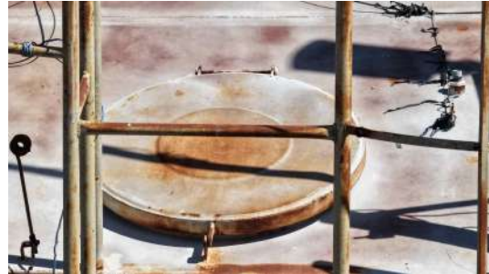
Foto 14 - Tampa de inspeção.
