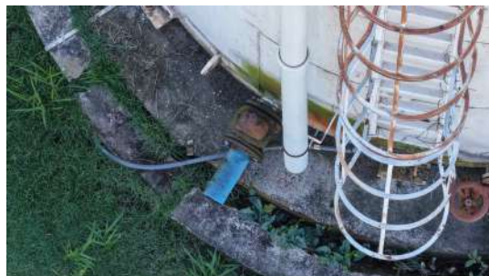
Foto 12 - Descida do extravasor.
