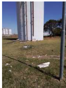
Foto 4 - Descida do extravasor
