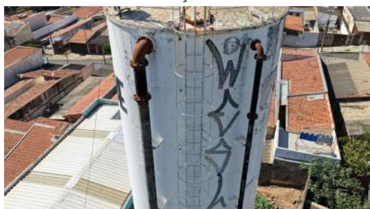
Foto 7 - Escada, alimentação e extravasor.
