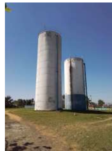
Foto 4 - Reservatórios Jardim Palmeiras
