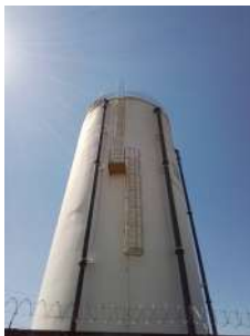
Foto 3 - Escada para manutenção
