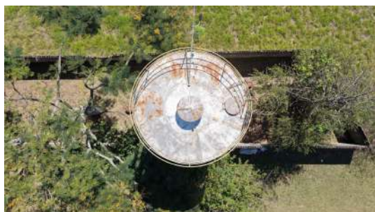
Foto 3 - Cobertura do reservatório.
