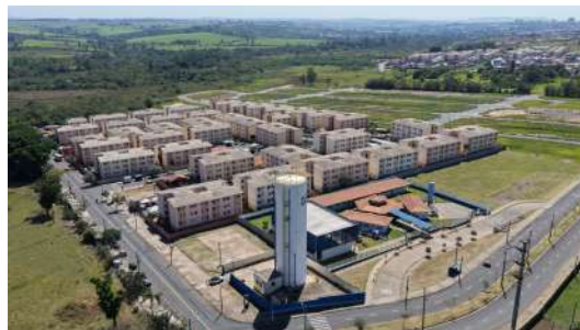
Foto 6 - Visão geral do reservatório.
