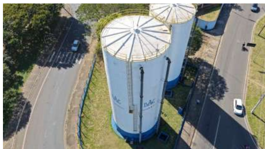
Foto 7 - Visão geral do reservatório.
