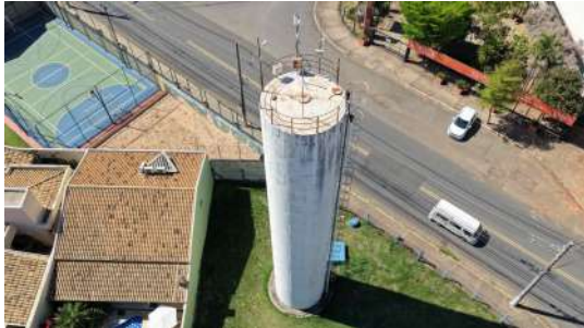
Foto 5 - Visão geral do reservatório
