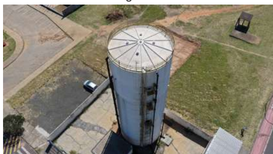
Foto 7 - Visão geral do reservatório
