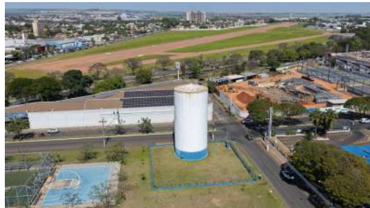
Foto 4 - Visão geral do reservatório
