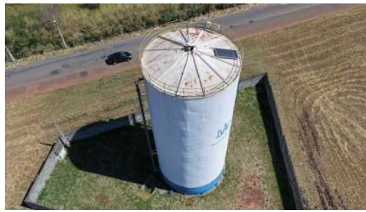
Foto 6 - Visão geral do reservatório.
