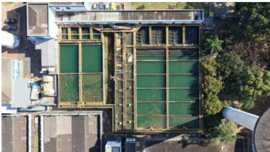
Foto 1 - Imagem aérea da ETA I.
