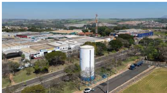
Foto 6 - Localização do reservatório.
