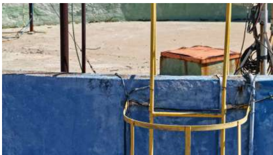
Foto 13 - Descida do aterramento.
