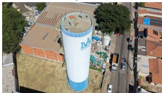
Foto 8 - Visão geral do reservatório.
