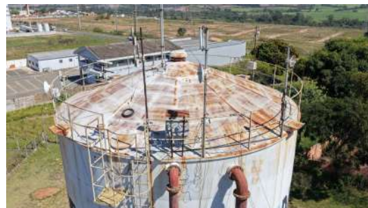
Foto 16 - Cobertura do reservatório.
