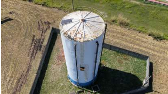
Foto 7 - Visão geral exibindo extravasor, tubo de alimentação e escada.
