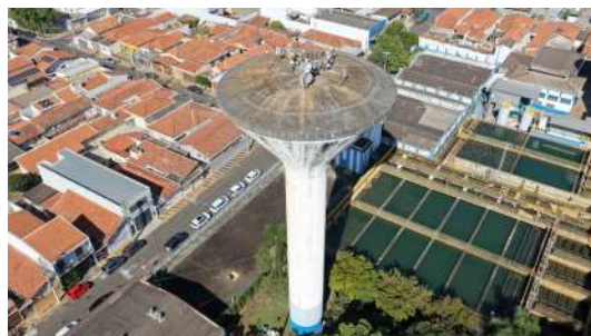
Foto 2 - Visão geral do reservatório
