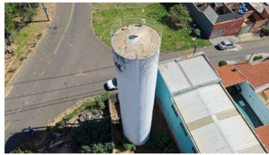
Foto 10 - Visão geral do reservatório.
