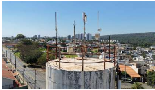
Foto 14 - Cobertura do reservatório
