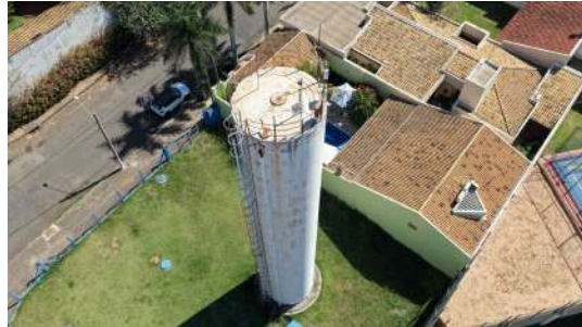
Foto 6 - Visão geral do reservatório
