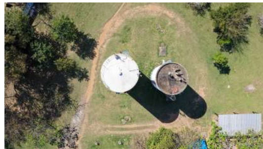
Foto 6 - Reservatórios Jardim Palmeiras
