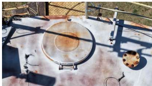
Foto 8 - Tampa de inspeção.
