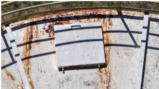
Foto 7 - Tampa de inspeção.
