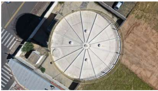
Foto 9 - Cobertura do reservatório.
