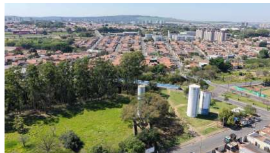
Foto 2 - Reservatório Diario Ville, próximo aos reservatórios Jd. Palmeiras
