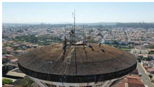
Foto 4 - Cobertura do reservatório.
