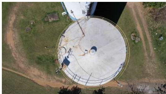
Foto 7 - Cobertura do reservatório metálico.
