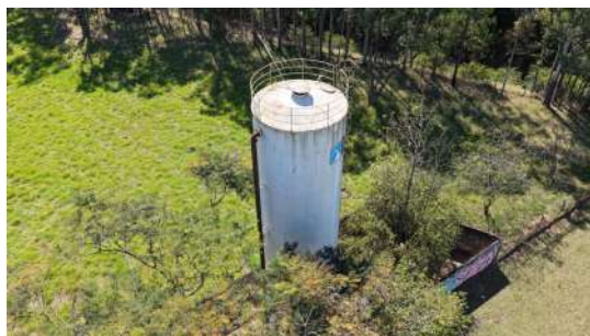
Foto 5 - Visão geral do reservatório.
