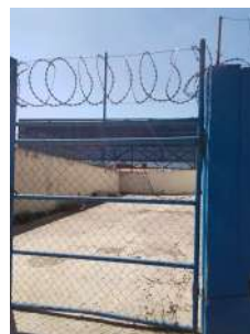
Foto 4 - Portão de acesso
