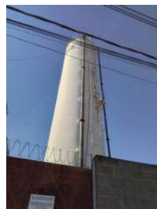
Foto 2 - Vista do reservatório
