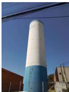
Foto 1 - Visão do reservatório
