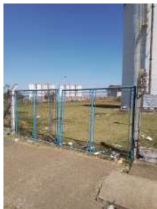
Foto 3 - Portão de acesso
