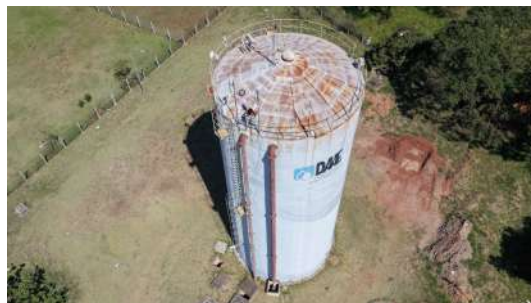
Foto 10 - Visão geral do reservatório. Visualiza-se o extravasor.
