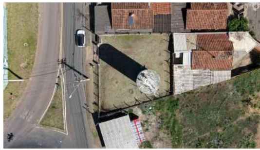
Foto 6 - Visão geral do reservatório
