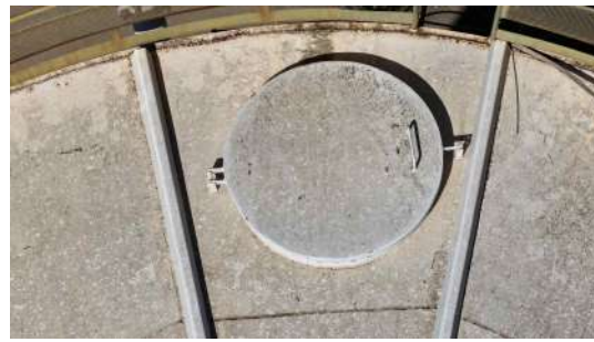
Foto 10 - Tampa de inspeção.
