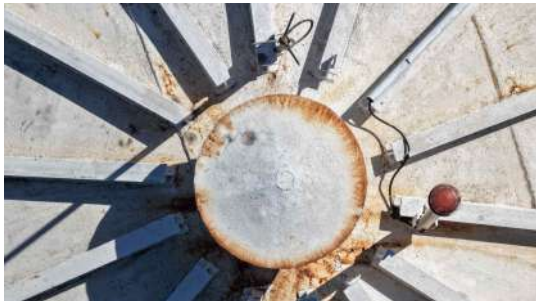
Foto 9 - Chaminé de ventilação.
