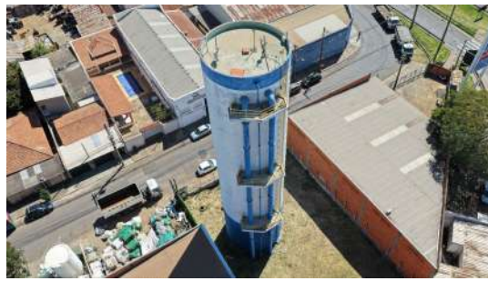
Foto 10 - Visão geral do reservatório.
