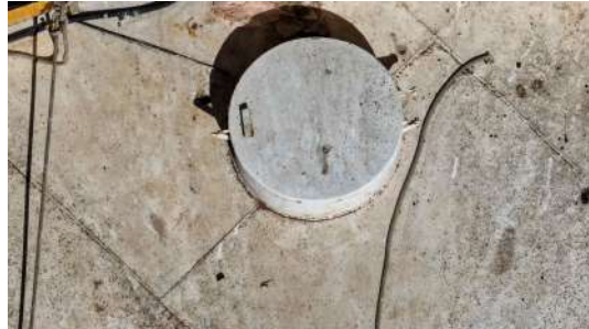
Foto 12 - Tampa de inspeção.
