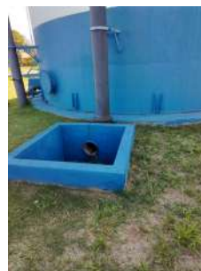
Foto 2 - Descida do extravasor
