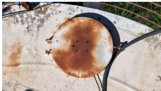
Foto 8 - Tampa de inspeção.
