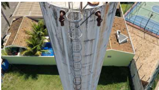
Foto 11 - Escada para manutenção.
