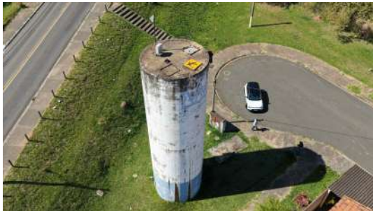
Foto 5 - Visão geral do reservatório.
