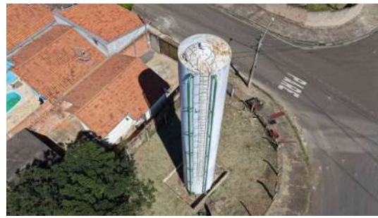
Foto 12 - Tubulação de alimentação e extravasor.
