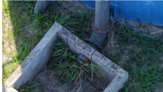
Foto 8 - Descida do extravasor.
