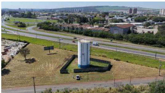
Foto 4 - Localização do reservatório.
