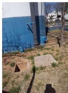
Foto 2 - Descida do extravasor
