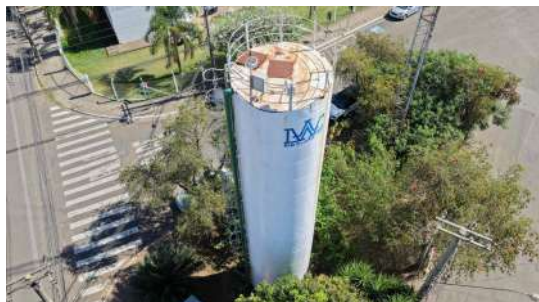
Foto 11 - Visão geral do reservatório.
