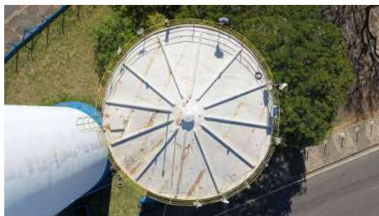
Foto 10 - Cobertura do reservatório.
