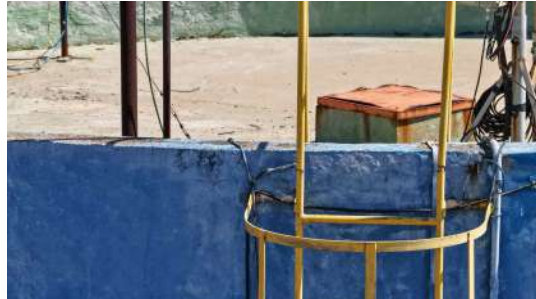
Foto 12 - Descida do aterramento.
