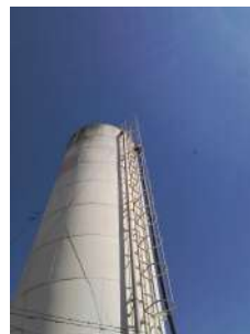
Foto 2 - Escada do reservatório
