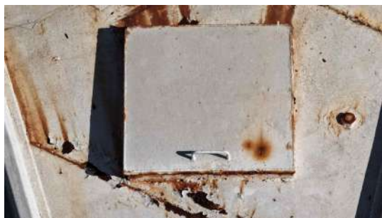
Foto 1 - Tampa de inspeção.
