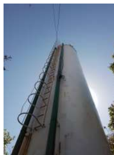
Foto 8 - Visão geral do reservatório
