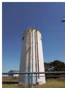
Foto 2 - Visão geral do reservatório
