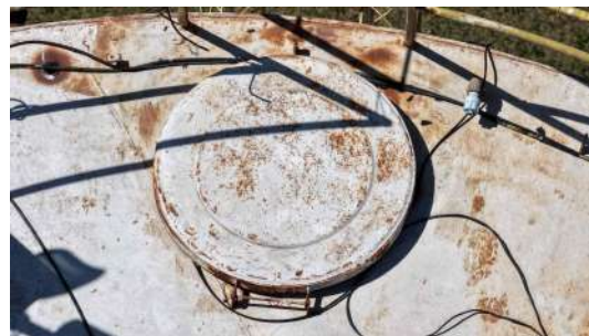
Foto 8 - Tampa de inspeção.
