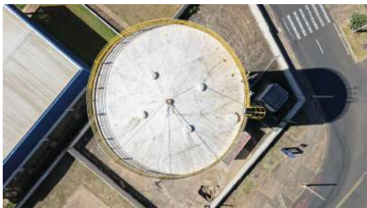
Foto 13 - Cobertura do reservatório.
