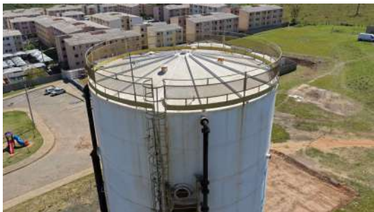
Foto 13 - Cobertura do reservatório.
