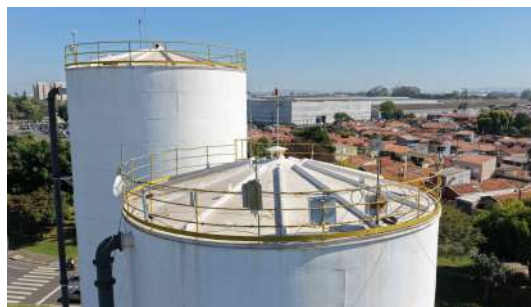
Foto 11 - Cobertura do reservatório.
