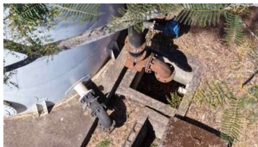
Foto 8 - Descida do extravasor.
