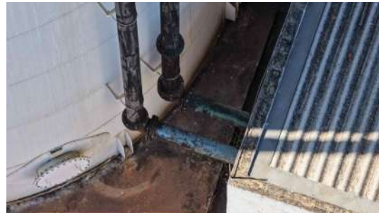
Foto 12 - Interligação do reservatório em elevatória situada no local.
