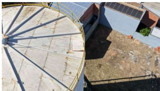
Foto 3 - Tampa de inspeção.
