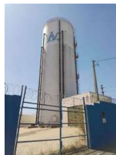
Foto 2 - Visão geral do reservatório elevado.
