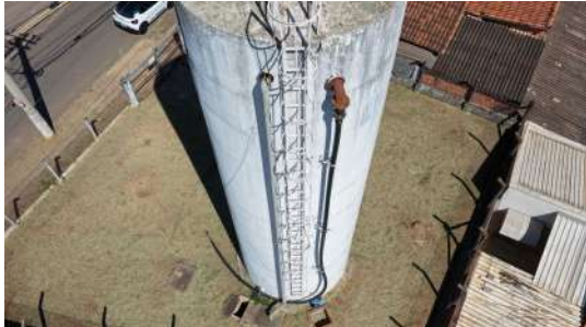
Foto 7 - Escada, alimentação e extravasor.
