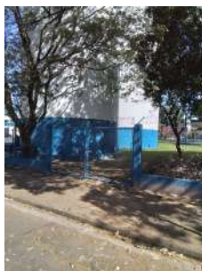
Foto 3 - Portão de acesso ao centro de reservação
