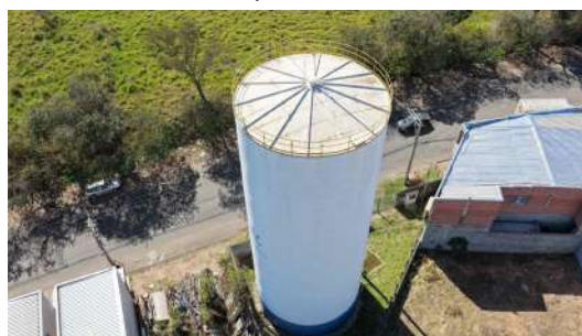
Foto 6 - Visão geral do reservatório
