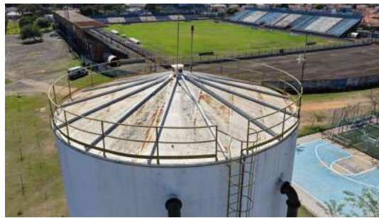
Foto 12 - Cobertura do reservatório.
