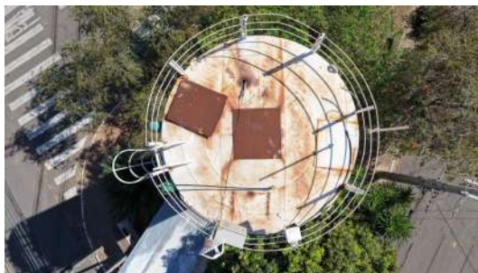
Foto 12 - Cobertura do reservatório.
