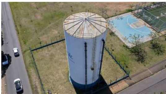
Foto 5 - Visão geral do reservatório
