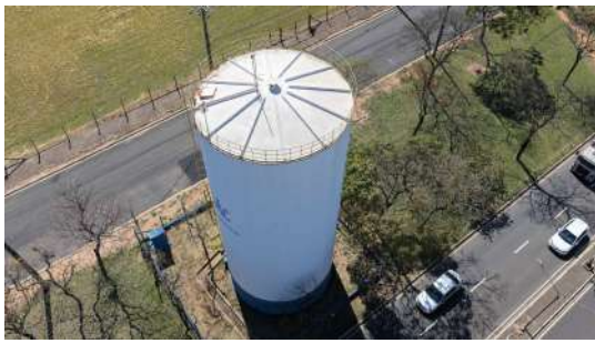
Foto 10 - Visão geral do reservatório
