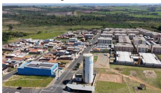
Foto 4 - Visão geral do reservatório
