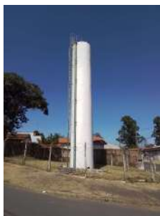
Foto 1 - Visão geral do reservatório
