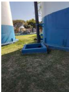
Foto 3 - Descida do extravasor
