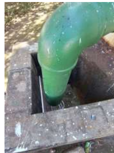
Foto 2 - Descida do extravasor
