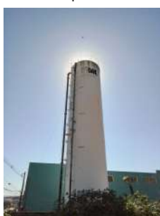
Foto 3 - Vista do reservatório
