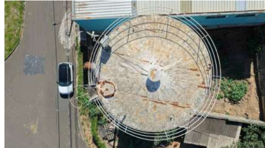
Foto 12 - Cobertura do reservatório.
