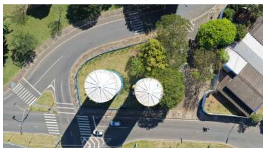
Foto 5 - Imagem aérea dos reservatórios.
