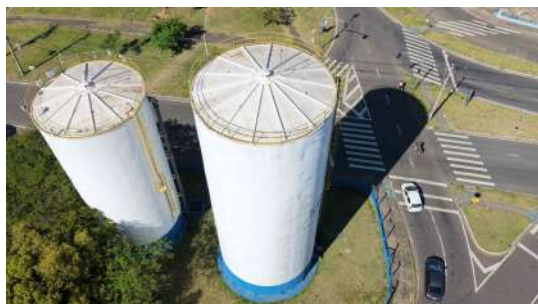
Foto 9 - Visão geral dos reservatório.
