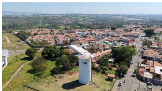
Foto 5 - Visão geral do reservatório.
