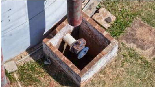
Foto 13 - Descida do extravasor.
