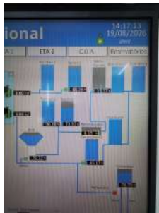
Foto 1 - Visualização do reservatório Boa Vista no sistema de telemetria do CCO, exibindo o nível do reservatório.
