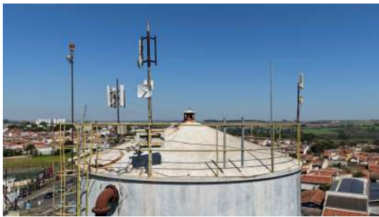
Foto 11 - Cobertura do reservatório metálico
