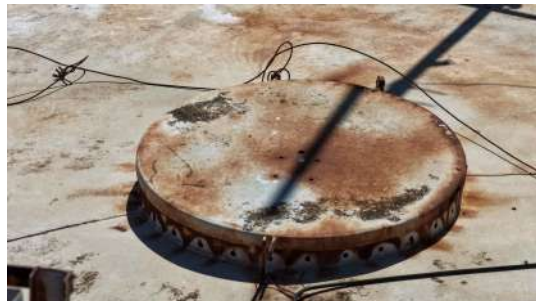
Foto 10 - Tampa de inspeção.
