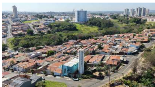
Foto 5 - Localização do reservatório.
