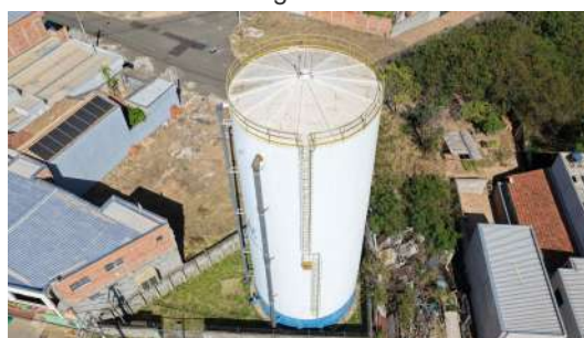
Foto 5 - Escada para acessar a cobertura.
