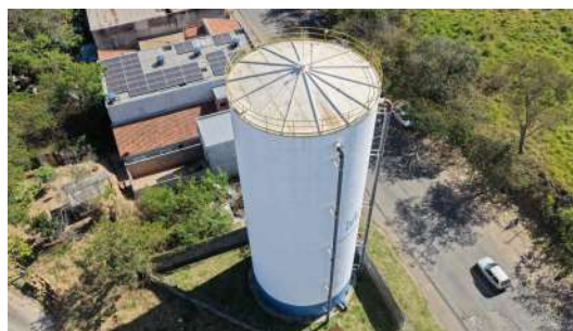
Foto 3 - Visão geral do reservatório
