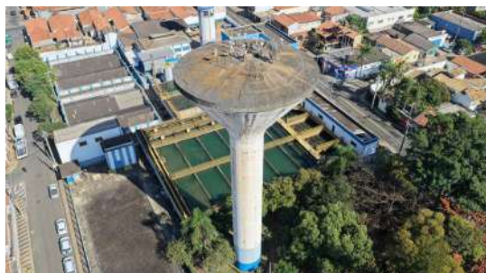
Foto 1 - Reservatório Cidade Nova ETA I.
