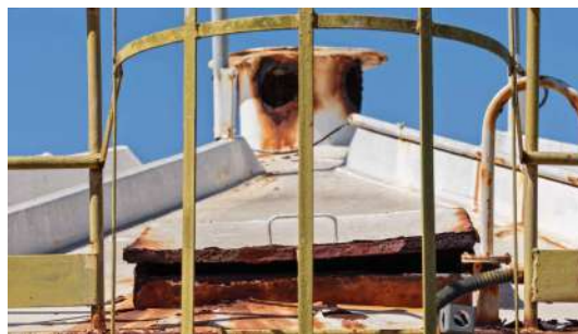
Foto 2 - Tampa de inspeção.
