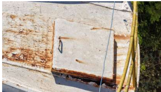
Foto 2 - Tampa de inspeção.
