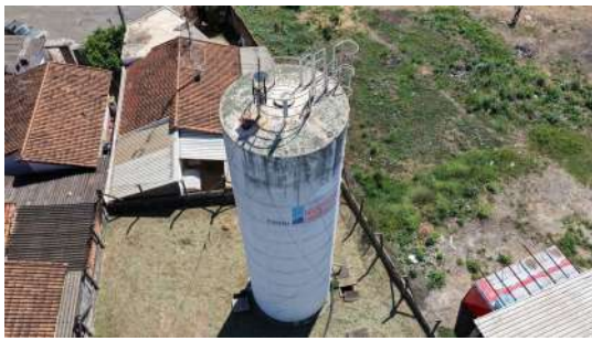
Foto 5 - Visão geral do reservatório
