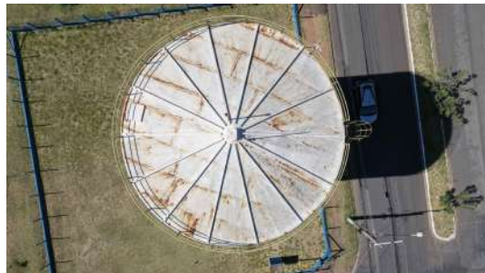
Foto 8 - Cobertura do reservatório.
