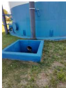
Foto 4 - Descida do extravasor
