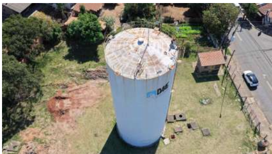
Foto 15 - Visão geral do reservatório.
