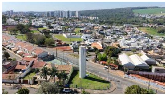
Foto 4 - Visão geral do reservatório
