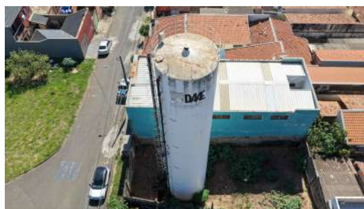
Foto 6 - Visão geral do reservatório.
