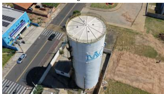
Foto 8 - Visão geral do reservatório
