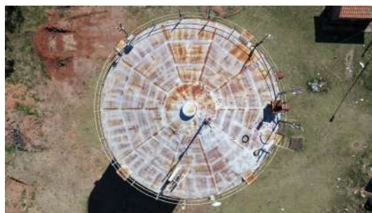
Foto 6 - Cobertura do reservatório.
