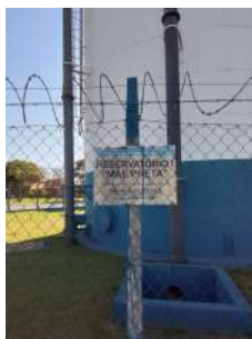
Foto 1 - Placa de identificação do reservatório
