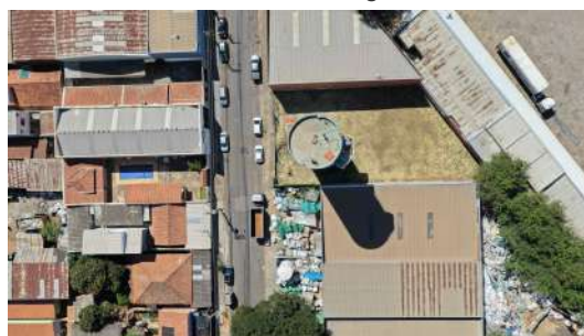
Foto 6 - Visão geral do reservatório.
