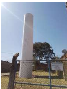
Foto 3 - Visão geral do reservatório
