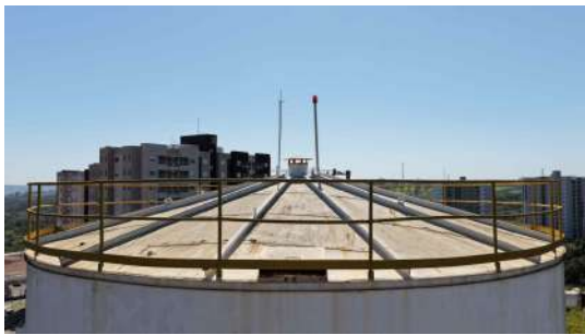
Foto 7 - Cobertura do reservatório.
