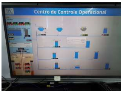
Foto 1 - Reservatório identificado como Castelo ETA I no CCO.
