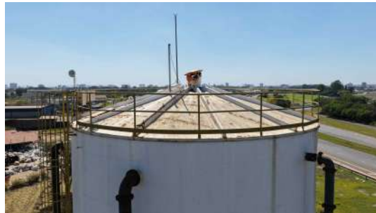
Foto 9 - Cobertura do reservatório.
