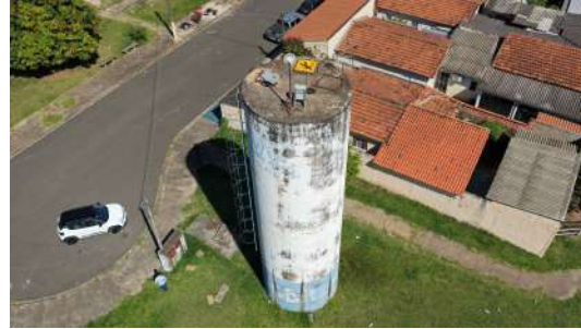
Foto 4 - Visão geral do reservatório.
