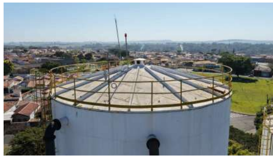
Foto 12 - Visualiza-se chaminé de ventilação e captor do SPDA.
