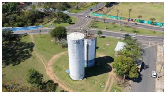
Foto 5 - Reservatórios Jardim Palmeiras
