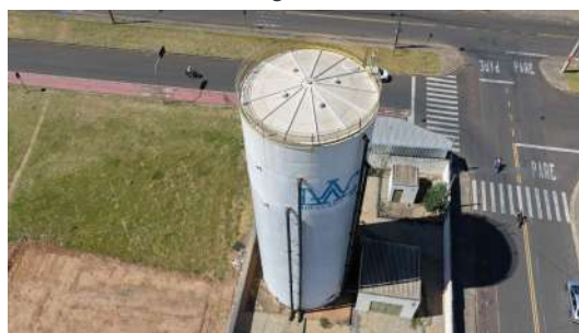
Foto 6 - Visão geral do reservatório
