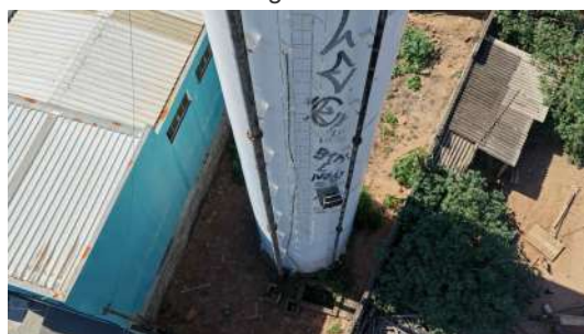
Foto 8 - Escada, alimentação e extravasor.
