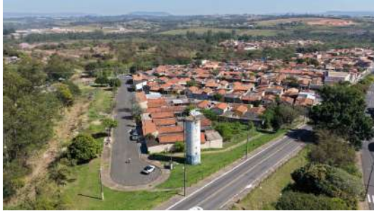
Foto 3 - Localização do reservatório.
