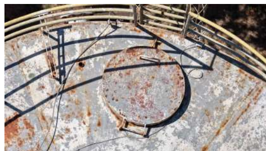
Foto 4 - Tampa de inspeção.
