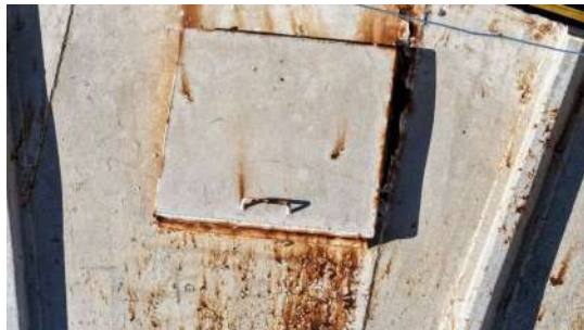
Foto 1 - Tampa de inspeção.
