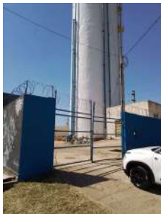
Foto 1 - Portão de acesso
