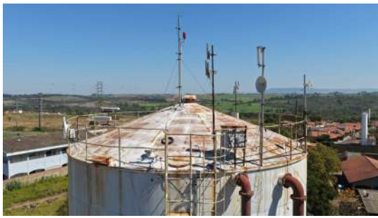
Foto 11 - Cobertura do reservatório.
