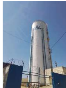
Foto 2 - Visão geral do reservatório
