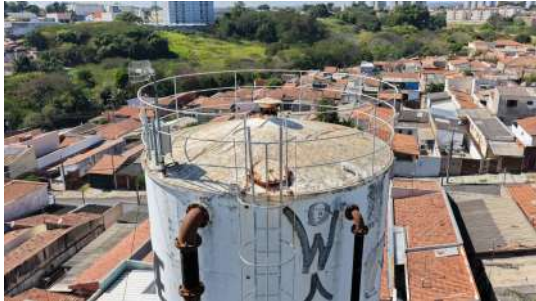
Foto 11 - Cobertura do reservatório.
