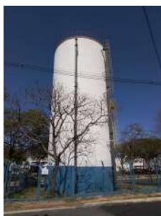
Foto 4 - Visão geral do reservatório
