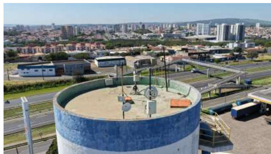
Foto 14 - Cobertura do reservatório
