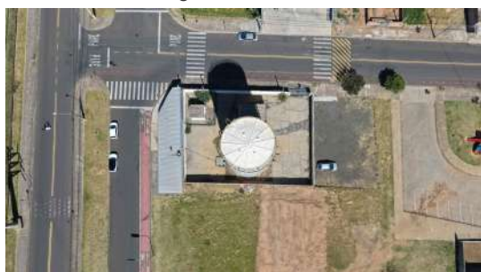
Foto 5 - Visão geral do reservatório
