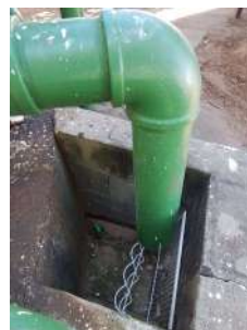
Foto 6 - Descida do extravasor
