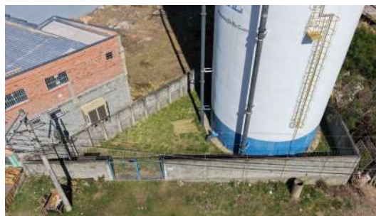
Foto 2 - Portão de acesso e muro no perímetro.
