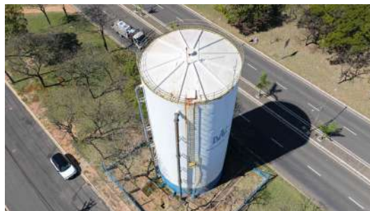
Foto 9 - Visão geral do reservatório
