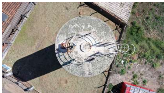
Foto 10 - Cobertura do reservatório.
