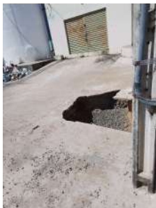
Foto 5 - Escavação no local
