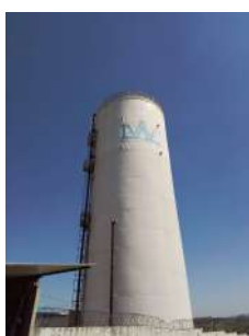
Foto 3 - Visão geral do reservatório elevado.
