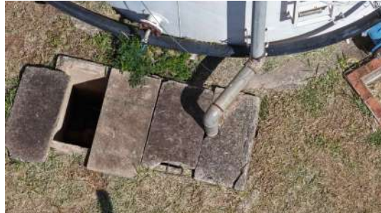
Foto 8 - Descida do extravasor.
