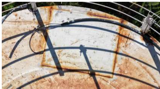
Foto 13 - Cobertura do reservatório.
