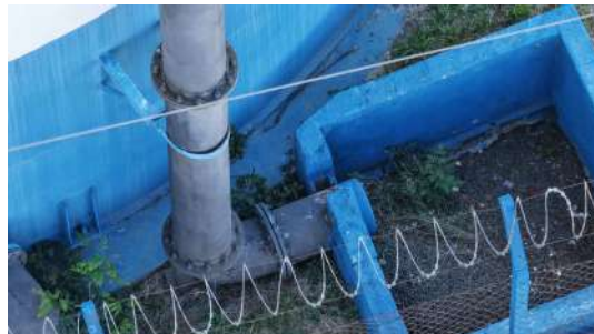
Foto 10 - Descida do extravasor.
