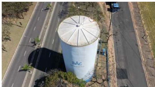
Foto 8 - Visão geral do reservatório
