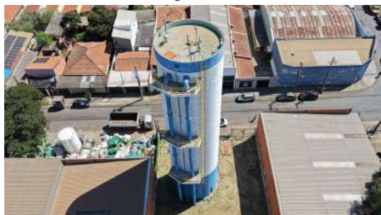
Foto 7 - Visão geral do reservatório.
