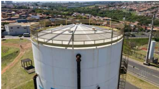
Foto 11 - Cobertura do reservatório.
