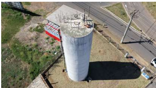
Foto 9 - Visão geral do reservatório
