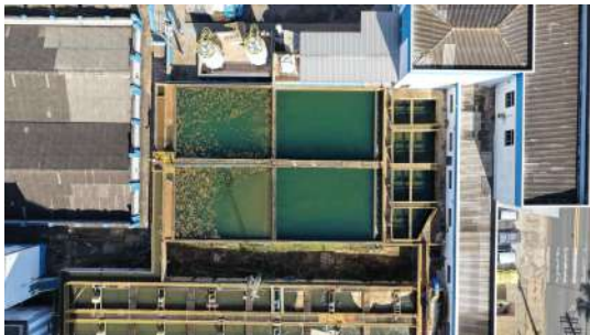
Foto 2 - Imagem aérea da ETA I.
