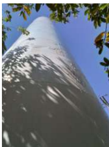
Foto 5 - Reparos executados no reservatório para tratamento de vazamentos
