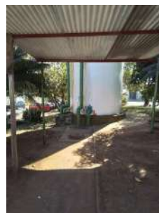
Foto 4 - Reservatório situado numa praça
