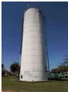
Foto 3 - Visão geral do reservatório
