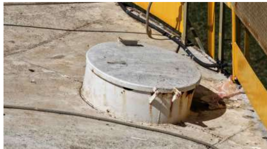
Foto 16 - Tampa de inspeção.
