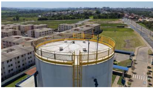
Foto 9 - Cobertura do reservatório.
