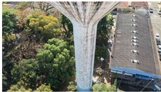
Foto 2 - Descida do cabo de aterramento.
