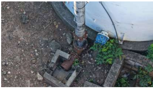
Foto 9 - Descida do extravasor.
