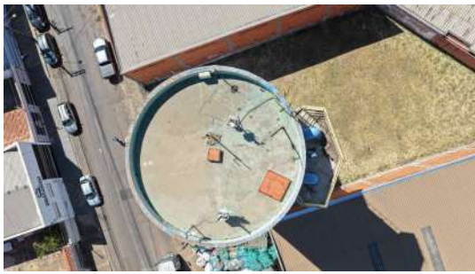
Foto 9 - Cobertura do reservatório.
