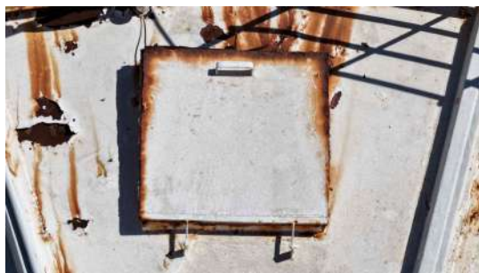
Foto 1 - Tampa de inspeção.
