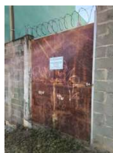
Foto 4 - Portão de acesso
