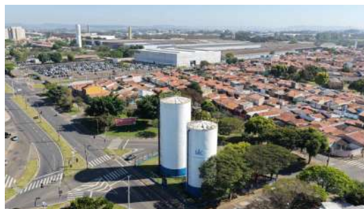
Foto 4 - Visão geral dos reservatórios Mãe Preta. O maior é o reservatório 1; o menor, o 2.
