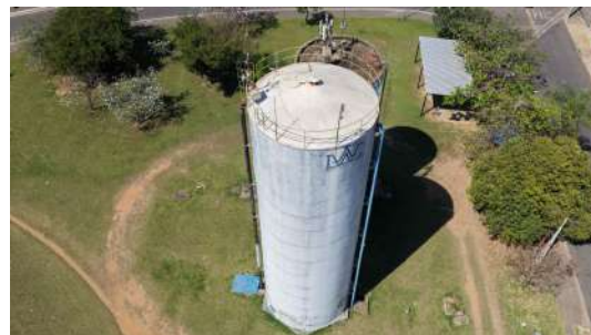
Foto 10 - Visão geral do reservatório.
