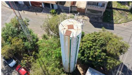
Foto 10 - Visão geral do reservatório.
