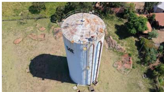
Foto 9 - Escada, alimentação e extravasor.
