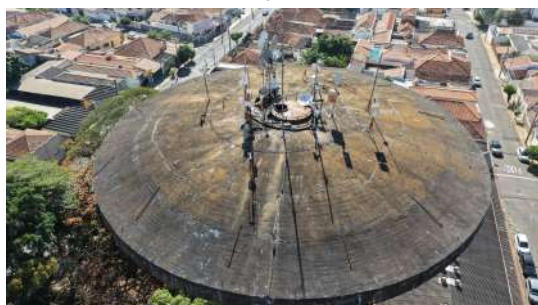
Foto 5 - Cobertura do reservatório.
