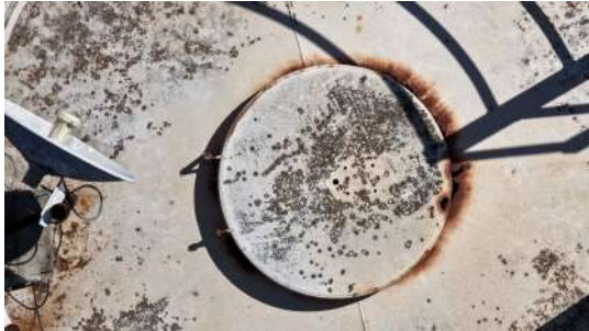
Foto 1 - Tampa de inspeção.
