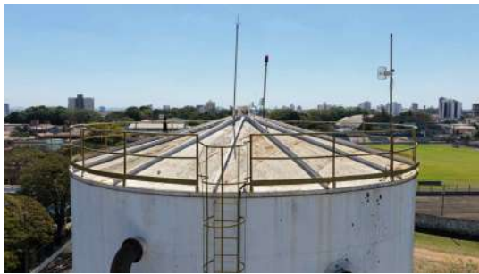
Foto 11 - Cobertura do reservatório.
