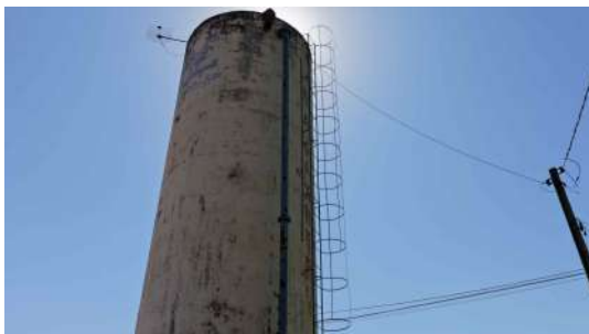
Foto 7 - Escada para acesso à cobertura.
