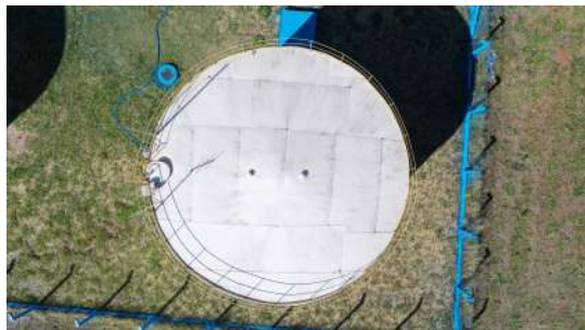
Foto 9 - Vista superior do reservatório (imagem de drone de 05/08/2026).
