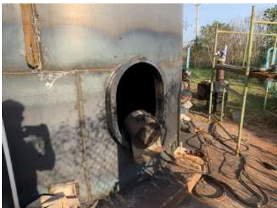
Foto 4 - Reforma do reservatório.
