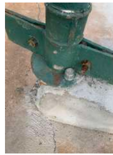
Foto 4 - Tubo de medição de nível.
