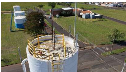
Foto 15 - Guarda-corpo superior (imagem de drone de 05/08/2026).
