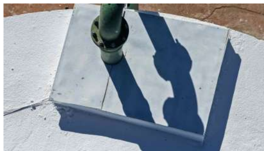
Foto 4 - Tampa de inspeção e tubulação de ventilação (imagem de drone de 05/08/2026).
