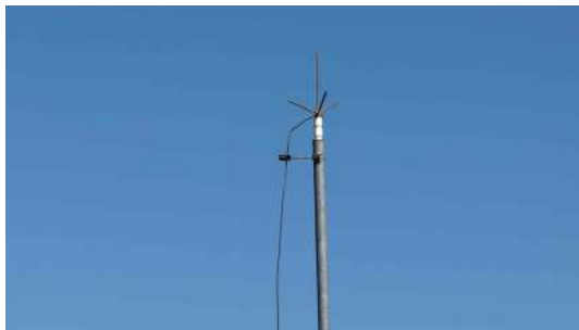
Foto 14 - Captor tipo Franklin (imagem de drone de 05/08/2026).
