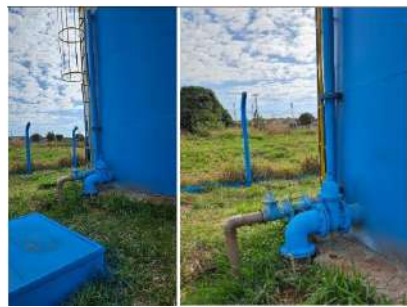
Foto 2 - Adequação apresentada pelo prestador no Protocolo 1286/2026 em 14/08/2026.
