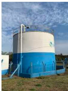
Foto 9 - Vista geral do reservatório e cercamento.
