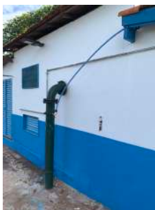
Foto 15 - Local de dosagem de produtos químicos no reservatório R 26.
