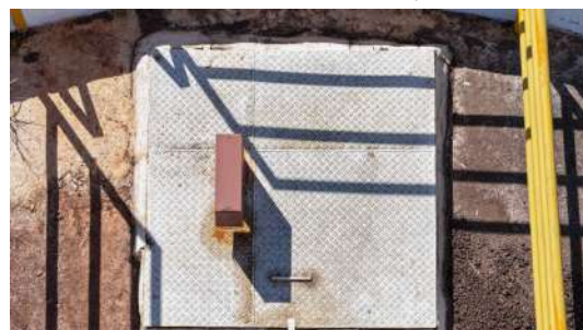
Foto 9 - Tampa de inspeção (imagem de drone de 05/08/2026).
