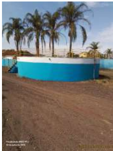
Foto 2 - Vista geral do reservatório.
