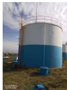
Foto 2 - Extravasor, guarda-corpo e SPDA.
