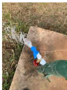
Foto 6 - Tomada de água bruta.
