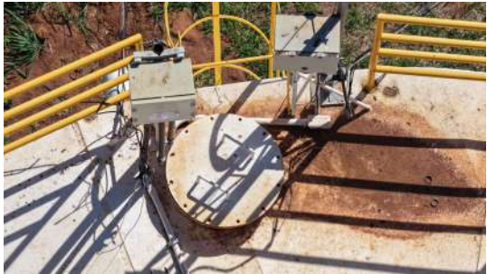
Foto 2 - Tampa de inspeção (imagem de drone de 05/08/2026).
