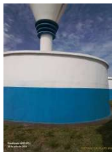
Foto 4 - Vista geral do reservatório.
