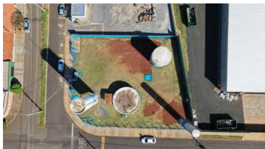
Foto 5 - Vista aérea de parte dos reservatórios do CR Jardim Parisi I: Na parte inferior da imagem R 21 (direita), R 18 (centro) e R19 (esquerda); na parte superior da imagem R 20 (direita) - (imagem de drone de 05/08/2026).
