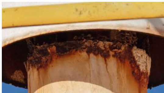
Foto 5 - Tubulação de ventilação (imagem de drone de 05/08/2026).
