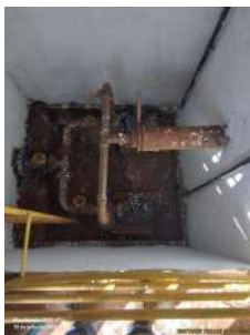
Foto 5 - Vista geral da EEAT.
