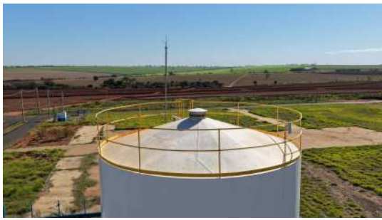
Foto 5 - Tubulação de ventilação (imagem de drone de 05/08/2026).
