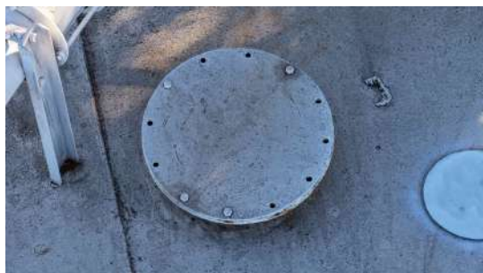
Foto 11 - Tampa de inspeção (imagem de drone de 05/08/2026).
