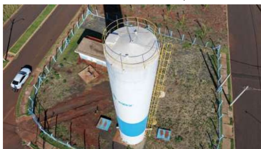
Foto 9 - Vista geral do reservatório (imagem de drone de 05/08/2026).
