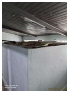
Foto 2 - Caixa de saída de água tratada ainda sem proteção adequada na parte superior.
