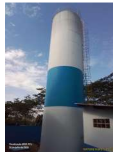
Foto 6 - Vista geral do reservatório.
