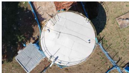
Foto 12 - Vista superior do reservatório (imagem de drone de 05/08/2026).
