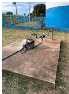
Foto 2 - Vista geral do poço.
