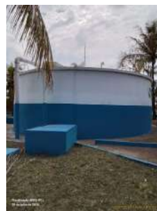
Foto 2 - Vista geral do reservatório.
