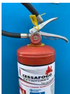
Foto 9 - Pressurização do extintor.
