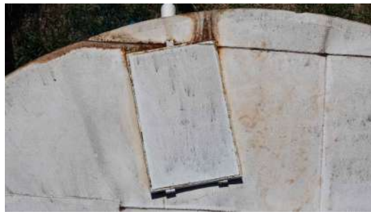
Foto 11 - Tampa de inspeção (imagem de drone de 05/08/2026).
