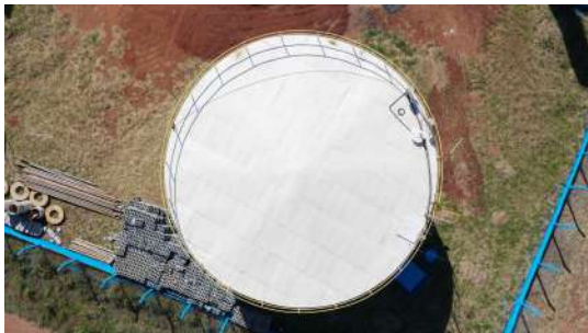
Foto 2 - Vista superior do reservatório (imagem de drone de 05/08/2026).
