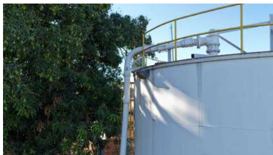
Foto 19 - Vista geral do reservatório (imagem de drone de 05/08/2026).
