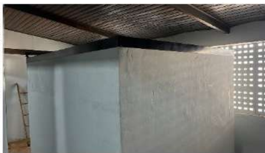
Foto 2 - Caixa de saída de água tratada ainda sem proteção adequada na parte superior.
