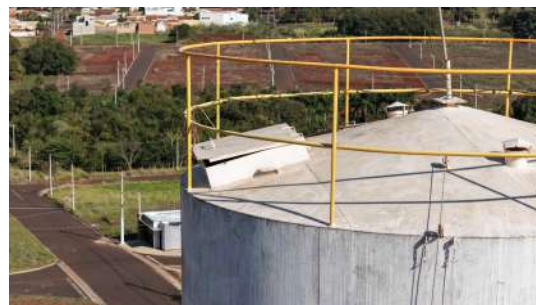
Foto 18 - Vista geral do reservatório (imagem de drone de 05/08/2026).
