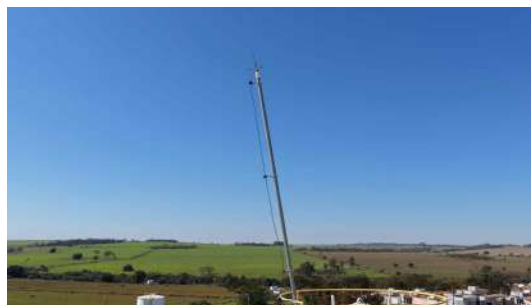
Foto 9 - Captor tipo Franklin (imagem de drone de 05/08/2026).
