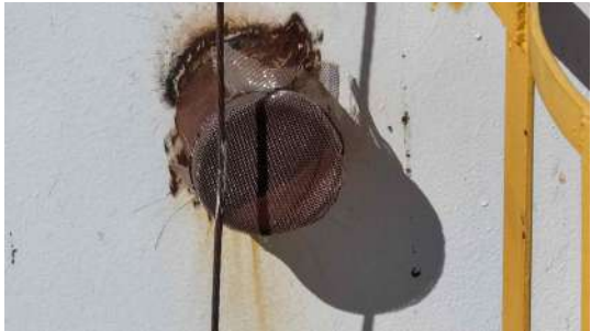
Foto 4 - Extravador (imagem de drone de 05/08/2026).
