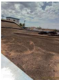
Foto 1 - Vista da laje superior do reservatório.
