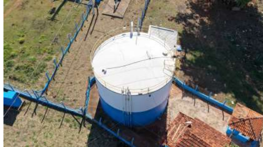
Foto 16 - Vista geral do reservatório (imagem de drone de 05/08/2026).
