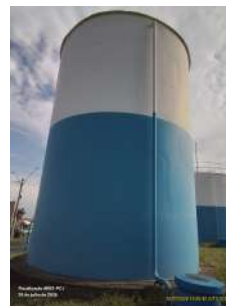
Foto 5 - Tubulação de apoio com alimentação que vem do Brasão.
