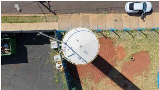
Foto 6 - Vista superior do reservatório (imagem de drone de 05/08/2026).
