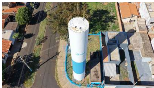
Foto 6 - Vista geral do reservatório (imagem de drone de 05/08/2026).
