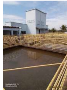
Foto 24 - Vista dos decantadores 3 e 4.
