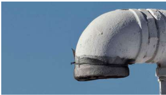
Foto 12 - Tubulação de ventilação (imagem de drone de 05/08/2026).
