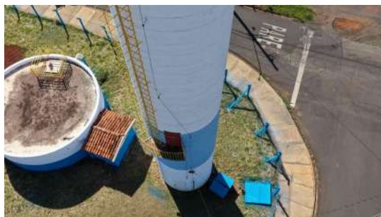
Foto 16 - Guarda-corpo escada (imagem de drone de 05/08/2026).
