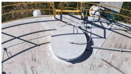
Foto 8 - Tampa de inspeção (imagem de drone de 05/08/2026).
