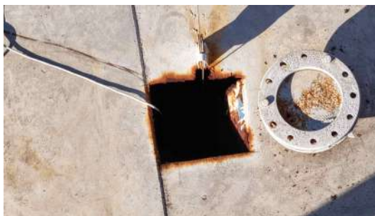
Foto 12 - Abertura no topo (imagem de drone de 05/08/2026).
