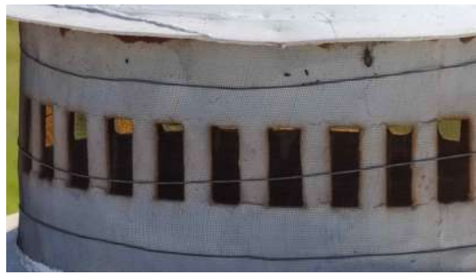
Foto 6 - Tubulação de ventilação (imagem de drone de 05/08/2026).
