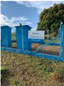
Foto 1 - Placa de identificação e cercamento.
