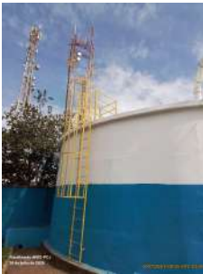
Foto 1 - Guarda-corpo da escada.
