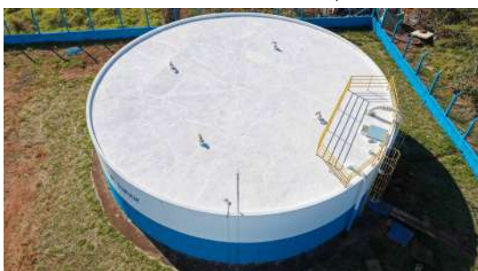
Foto 16 - Vista geral do reservatório (imagem de drone de 05/08/2026).
