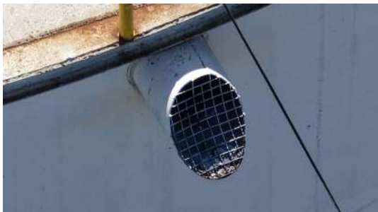
Foto 1 - Extravasor com grade, mas sem tela de proteção contra entrada de insetos e pequenos
