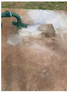
Foto 3 - Laje de proteção.
