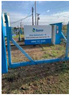
Foto 1 - Placa de identificação e cercamento.
