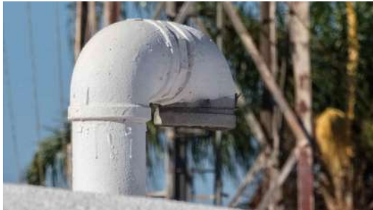
Foto 14 - Tubulação de ventilação (imagem de drone de 05/08/2026).
