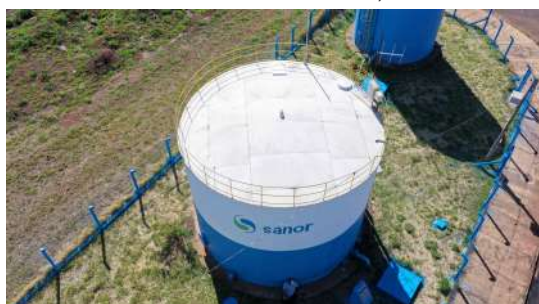
Foto 14 - Vista geral do reservatório (imagem de drone de 05/08/2026).
