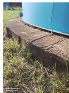
Foto 2 - Aterramento 2 do reservatório cortado.
