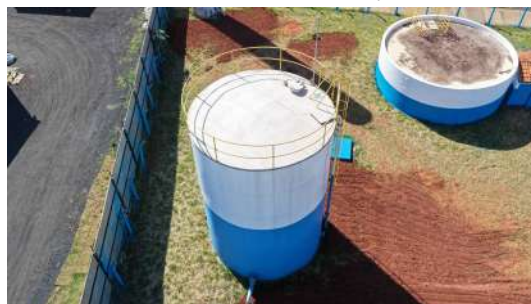
Foto 7 - Vista geral do reservatório (imagem de drone de 05/08/2026).
