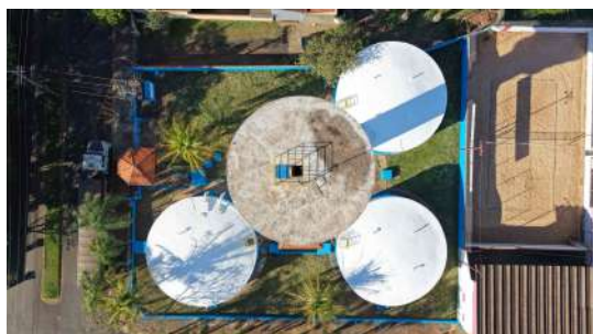
Foto 7 - Vista aérea de parte dos reservatórios da Caixa Torre: R 1 (canto inferior direito), R 4 (centro) e R 2 (canto inferior esquerdo) e R 3 (canto superior direito) - (imagem de drone de 05/08/2026).
