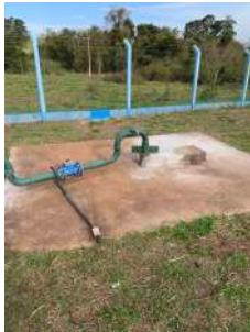
Foto 2 - Vista geral do poço.
