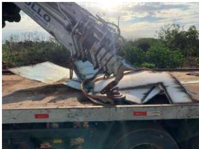
Foto 1 - Reforma do reservatório.
