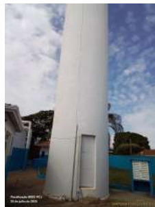
Foto 4 - Vista geral do reservatório.
