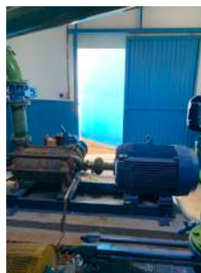
Foto 15 - Acesso 1 à EEAT.
