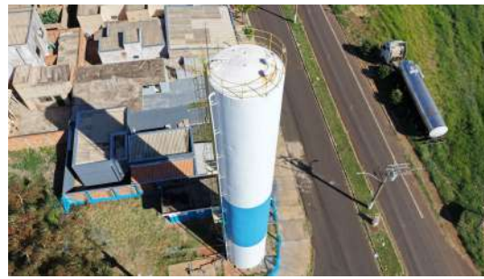
Foto 10 - Vista geral do reservatório (imagem de drone de 05/08/2026).
