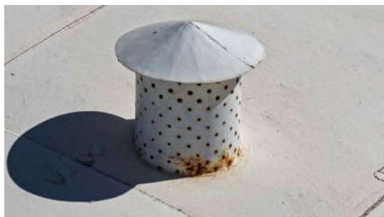
Foto 5 - Tubulação de ventilação (imagem de drone de 05/08/2026).
