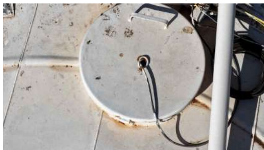
Foto 3 - Tampa de inspeção (imagem de drone de 05/08/2026).
