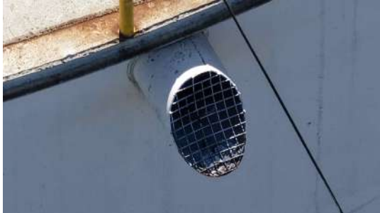
Foto 15 - Extravasor (imagem de drone de 05/08/2026).
