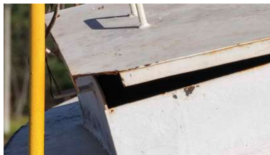
Foto 4 - Tampa de inspeção (imagem de drone de 05/08/2026).
