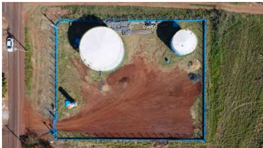
Foto 1 - Vista aérea dos reservatórios Brasão: R 29 (canto inferior esquerdo), R 16 (canto superior esquerdo) e R 17 (canto superior direito) - (imagem de drone de 05/08/2026).
