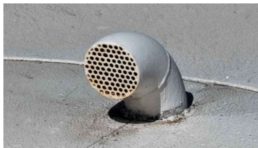
Foto 11 - Tubulação de ventilação. (imagem de drone de 05/08/2026).
