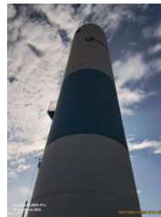
Foto 4 - Vista geral do reservatório.
