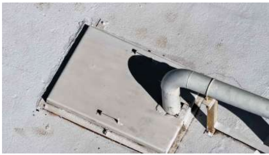
Foto 3 - Tampa de inspeção (imagem de drone de 05/08/2026).
