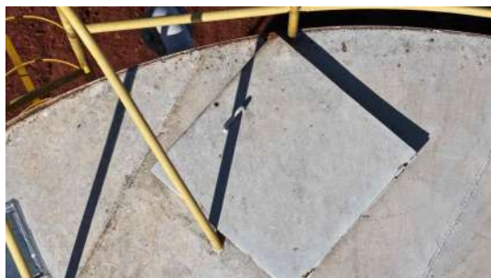
Foto 16 - Tampa de inspeção (imagem de drone de 05/08/2026).
