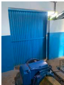
Foto 16 - Acesso 2 à EEAT.
