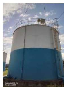
Foto 5 - Vista geral do reservatório.
