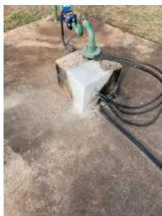
Foto 3 - Laje de proteção.
