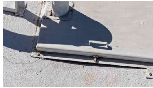
Foto 4 - Tampa de inspeção (imagem de drone de 05/08/2026).
