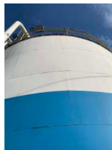
Foto 6 - Vista geral do reservatório.
