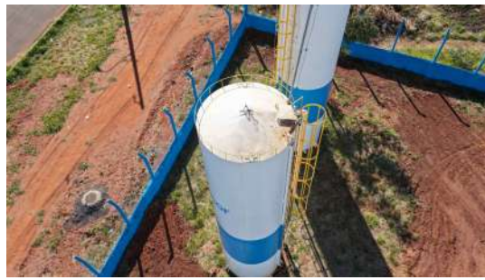
Foto 5 - Vista geral do reservatório (imagem de drone de 05/08/2026).
