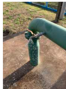
Foto 6 - Tomada de água bruta.
