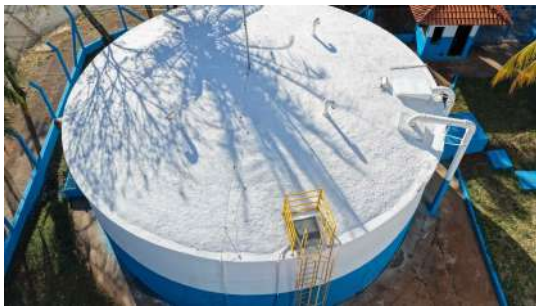
Foto 21 - Vista geral do reservatório (imagem de drone de 05/08/2026).
