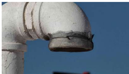
Foto 11 - Tubulação de ventilação (imagem de drone de 05/08/2026).
