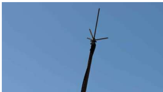
Foto 5 - Captor tipo Franklin (imagem de drone de 05/08/2026).
