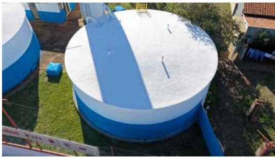
Foto 12 - Vista geral do reservatório (imagem de drone de 05/08/2026).
