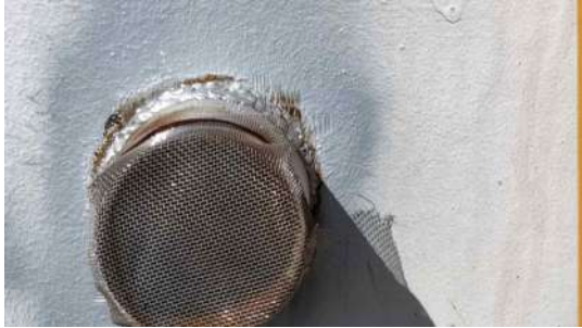
Foto 7 - Extravasor (imagem de drone de 05/08/2026).
