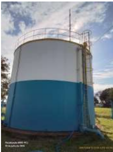
Foto 2 - Vista geral do reservatório.
