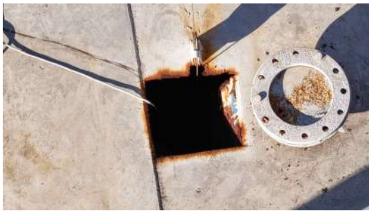
Foto 3 - Corrigir a abertura no topo e garantir a estanqueidade do reservatório contra entrada de contaminantes.
