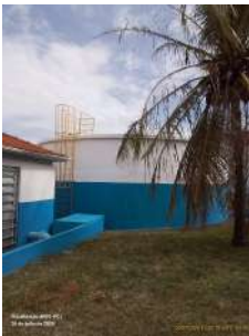
Foto 1 - Vista geral do reservatório.
