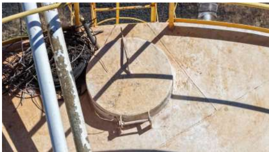
Foto 3 - Tampa de inspeção (imagem de drone de 05/08/2026).
