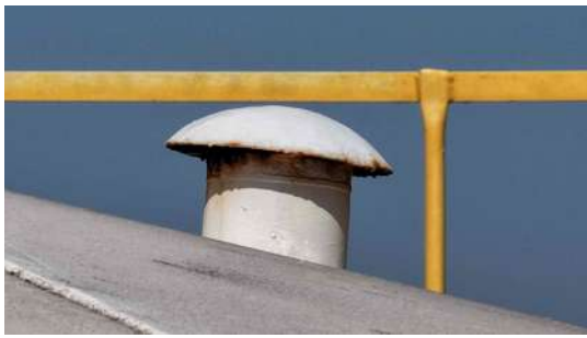
Foto 13 - Tubulação de ventilação (imagem de drone de 05/08/2026).
