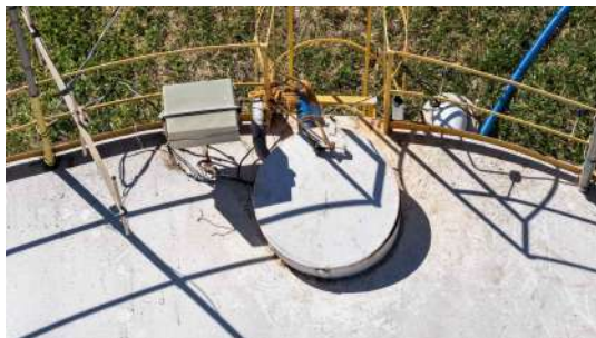
Foto 10 - Tampa de inspeção (imagem de drone de 05/08/2026).
