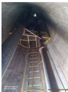
Foto 5 - Vista do interior do reservatório. Guarda-corpo da escad.
