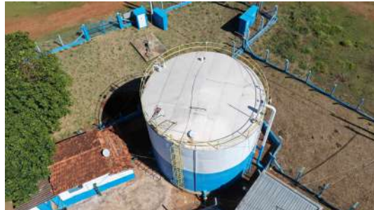
Foto 18 - Vista geral do reservatório (imagem de drone de 05/08/2026).
