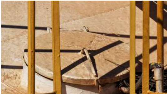
Foto 9 - Tampa de inspeção (imagem de drone de 05/08/2026).
