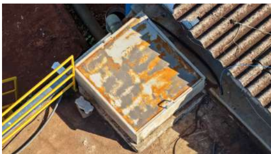
Foto 4 - Tampa de inspeção (imagem de drone de 05/08/2026).
