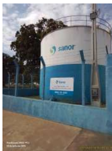
Foto 1 - Placa de identificação e cercamento.
