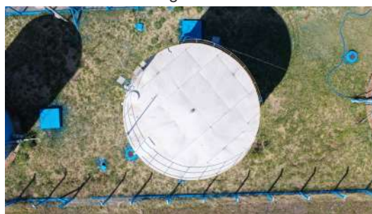
Foto 7 - Vista superior do reservatório (imagem de drone de 05/08/2026).
