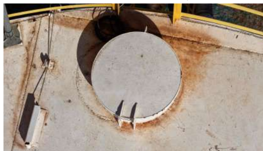
Foto 3 - Tampa de inspeção (imagem de drone de 05/08/2026).
