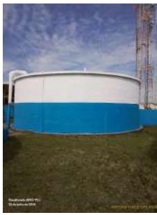
Foto 3 - Vista geral do reservatório.
