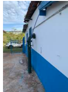
Foto 16 - Local de dosagem de produtos químicos no reservatório R 26.
