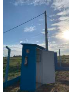
Foto 6 - Extintor de incêndio.
