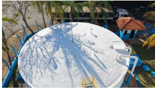
Foto 14 - Captor e descida do SPDA (imagem de drone de 05/08/2026).
