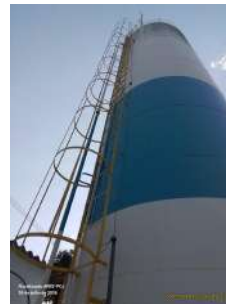
Foto 2 - Descida do SPDA e guarda-corpo da escada.
