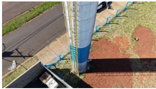
Foto 17 - Vista geral do reservatório (imagem de drone de 05/08/2026).
