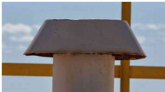
Foto 6 - Tubulação de ventilação (imagem de drone de 05/08/2026).
