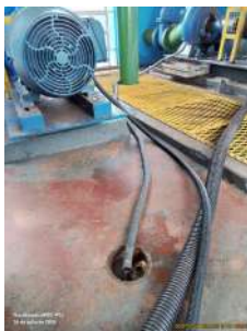
Foto 9 - Detalhe do sistema de drenagem de água da gaxeta.
