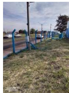
Foto 7 - Cercamento e acesso.
