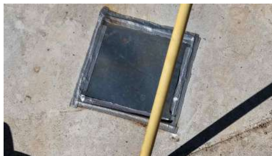
Foto 15 - Tampa de inspeção (imagem de drone de 05/08/2026).
