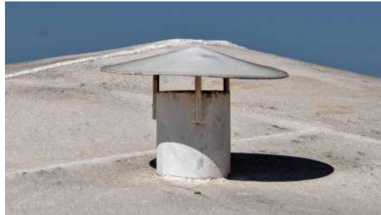
Foto 15 - Tubulação de ventilação. (imagem de drone de 05/08/2026).
