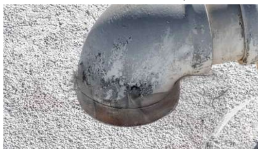
Foto 7 - Tubulação de ventilação (imagem de drone de 05/08/2026).
