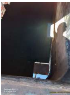
Foto 3 - Interior do reservatório com água.
