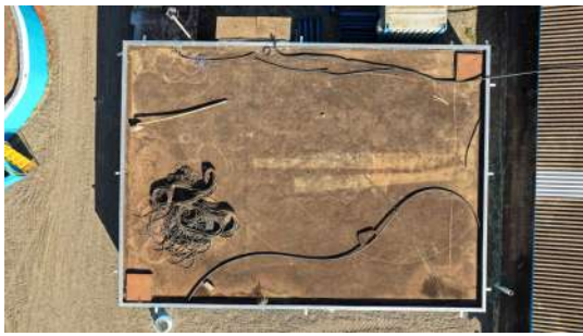
Foto 5 - Vista superior do reservatório (imagem de drone de 05/08/2026).
