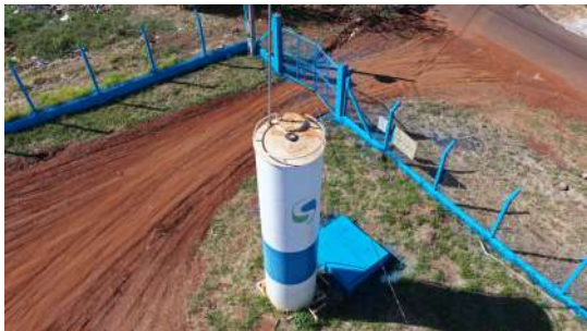
Foto 4 - Vista geral do reservatório (imagem de drone de 05/08/2026).
