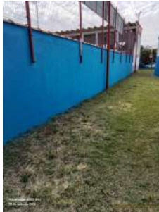
Foto 5 - Cercamento do fundo da área.
