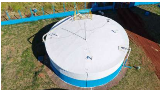
Foto 11 - Vista geral do reservatório (imagem de drone de 05/08/2026).
