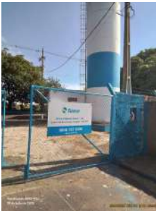
Foto 1 - Placa de identificação e cercamento.
