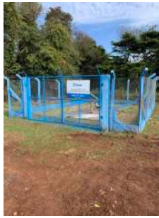
Foto 1 - Placa de identificação e cercamento.
