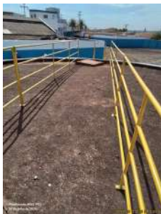
Foto 7 - Tampa de inspeção e guarda-corpo.
