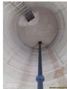
Foto 6 - Vista da laje de fundo do reservatório.
