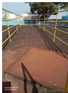
Foto 6 - Tampa de inspeção e guarda-corpo.
