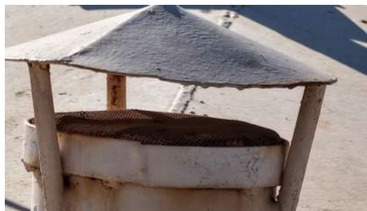
Foto 6 - Tubulação de ventilação (imagem de drone de 05/08/2026).
