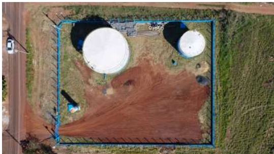
Foto 1 - Vista aérea dos reservatórios Braço: R 29 (canto inferior esquerdo), R 16 (canto superior esquerdo) e R 17 (canto superior direito) - (imagem de drone de 05/08/2026).
