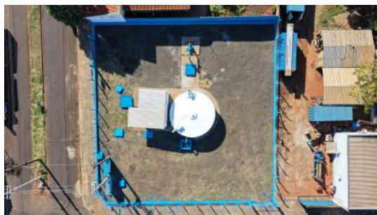
Foto 1 - Vista superior do reservatório (imagem de drone de 05/08/2026).
