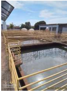
Foto 23 - Vista dos decantadores 1 e 2.
