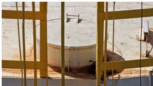
Foto 4 - Tampa de inspeção (imagem de drone de 05/08/2026).
