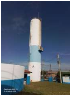
Foto 1 - Vista geral do reservatório.
