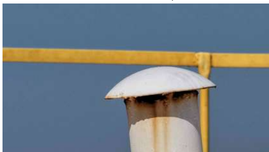
Foto 12 - Tubulação de ventilação (imagem de drone de 05/08/2026).
