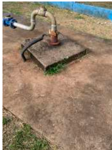
Foto 3 - Laje de proteção.
