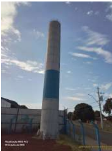
Foto 1 - Vista geral do reservatório.
