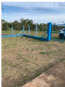
Foto 7 - Acesso e cercamento.
