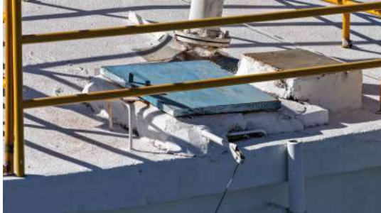
Foto 5 - Tampa de inspeção (imagem de drone de 05/08/2026).
