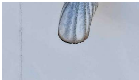
Foto 2 - Extravasador sem tela de proteção contra entrada de insetos e pequenos animais.
