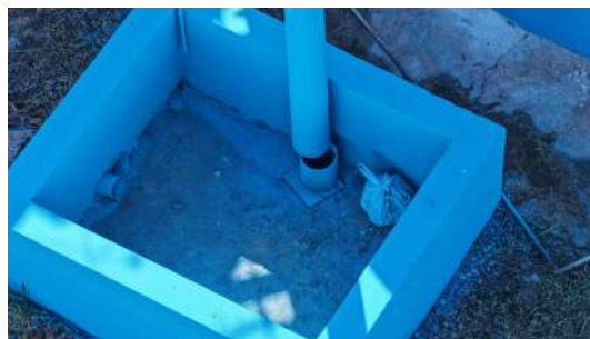
Foto 6 - Extravador (imagem de drone de 05/08/2026).
