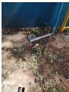
Foto 1 - Aterramento cortado.
