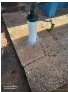
Foto 3 - Laje de proteção.
