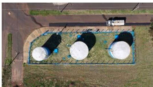
Foto 6 - Vista aérea de parte dos reservatórios do CR Jardim Parisi: R32 (direita), R33 (centro) e R34 (esquerda) - (imagem de drone de 05/08/2026).
