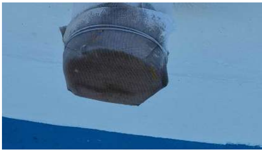
Foto 10 - Extravasor (imagem de drone de 05/08/2026).
