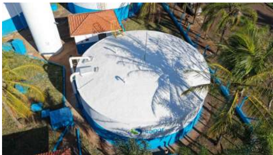
Foto 15 - Vista geral do reservatório (imagem de drone de 05/08/2026).
