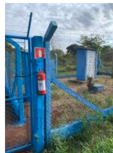
Foto 6 - Extintor de incêndio.
