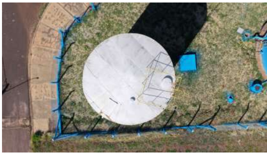
Foto 10 - Vista superior do reservatório (imagem de drone de 05/08/2026).
