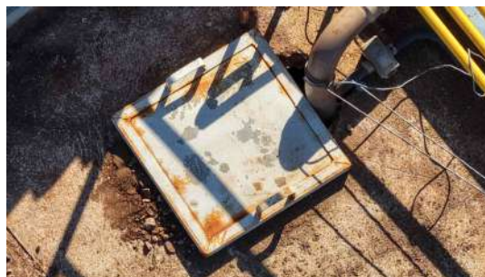
Foto 5 - Tampa de inspeção (imagem de drone de 05/08/2026).
