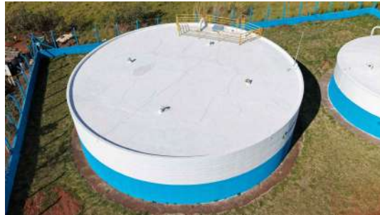
Foto 13 - Vista geral do reservatório (imagem de drone de 05/08/2026).
