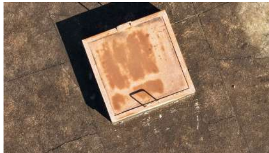
Foto 3 - Tampa de inspeção (imagem de drone de 05/08/2026).
