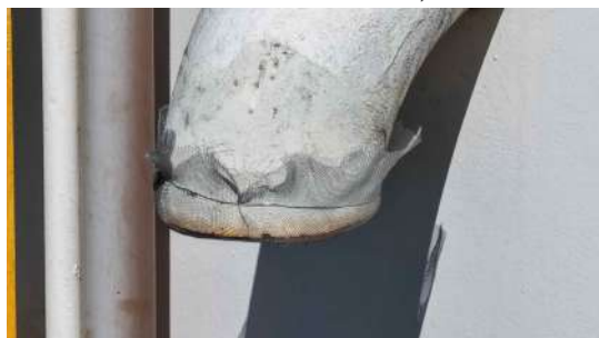
Foto 11 - Extravasor (imagem de drone de 05/08/2026).
