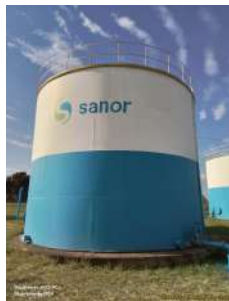
Foto 6 - Vista geral do reservatório.
