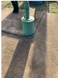
Foto 3 - Laje de proteção.
