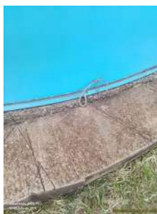
Foto 1 - Aterramento 1 do reservatório cortado.
