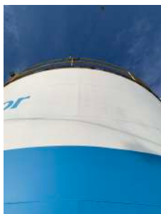
Foto 5 - Vista geral do reservatório.
