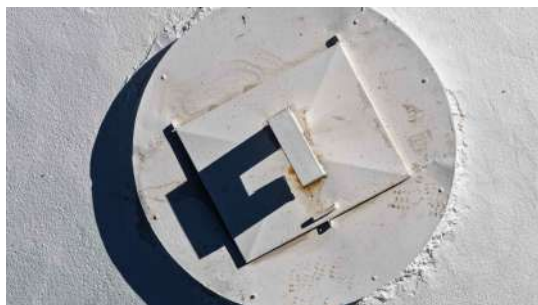
Foto 3 - Tampa de inspeção e tubulação de ventilação (imagem de drone de 05/08/2026).
