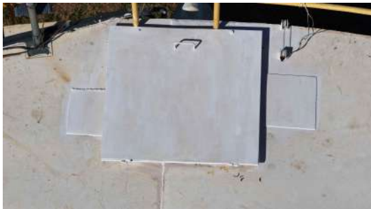
Foto 4 - Tampa de inspeção (imagem de drone de 05/08/2026).
