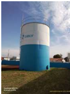
Foto 1 - Vista geral do reservatório.
