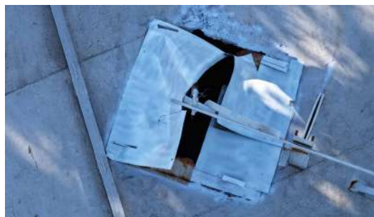
Foto 20 - Abertura no topo (imagem de drone de 05/08/2026).
