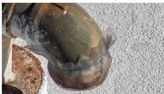
Foto 6 - Tubulação de ventilação (imagem de drone de 05/08/2026).
