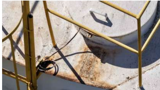
Foto 13 - Tampa de inspeção (imagem de drone de 05/08/2026).
