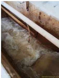
Foto 17 - Aplicação de PAC no canal de entrada.
