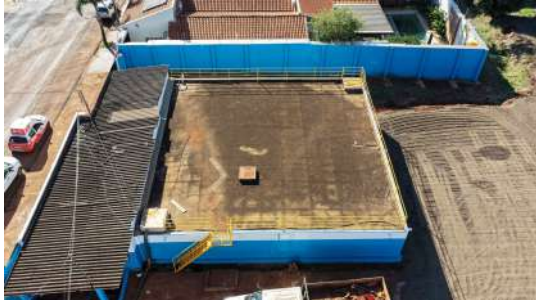
Foto 8 - Vista geral do reservatório (imagem de drone de 05/08/2026).
