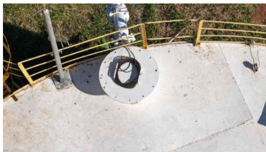
Foto 3 - Tampa de inspeção (imagem de drone de 05/08/2026).
