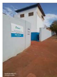
Foto 2 - Placa de identificação e cercamento.
