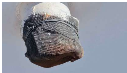
Foto 6 - Extravasor (imagem de drone de 05/08/2026).
