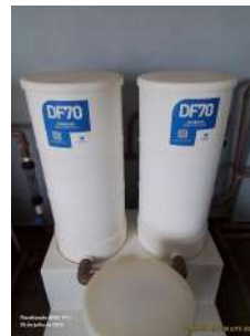
Foto 30 - Sistema de aplicação de flúor.
