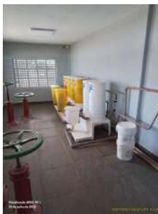
Foto 27 - Sistema de pastilhas para aplicação de cloro e flúor.
