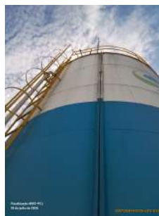
Foto 4 - Vista geral do reservatório.
