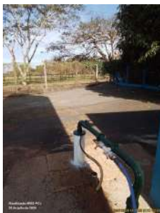
Foto 7 - Vista geral do poço e cercamento.
