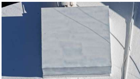
Foto 5 - Tampa de inspeção e tubulação de ventilação (imagem de drone de 05/08/2026).
