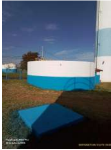
Foto 3 - Vista geral do reservatório.
