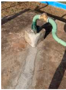
Foto 3 - Laje de proteção.
