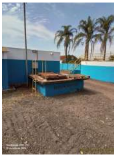
Foto 3 - Vista externa da EEAT.
