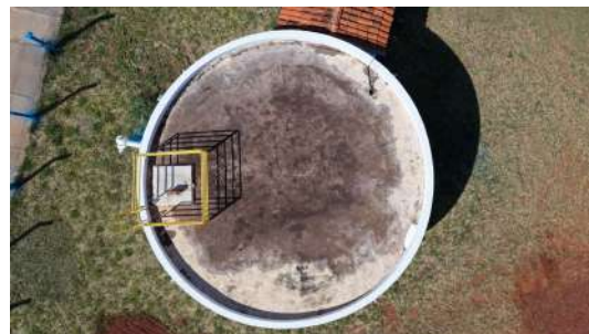
Foto 8 - Vista superior do reservatório (imagem de drone de 05/08/2026).
