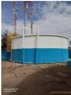
Foto 2 - Vista geral do reservatório.
