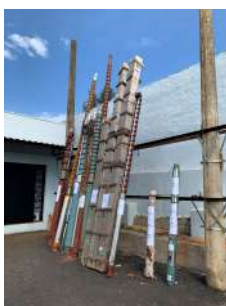
Foto 17 - Estoque de bombas reservas dos poços na ETA.
