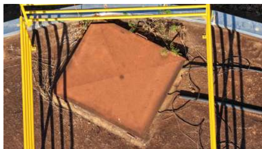
Foto 13 - Tampa de inspeção (imagem de drone de 05/08/2026).
