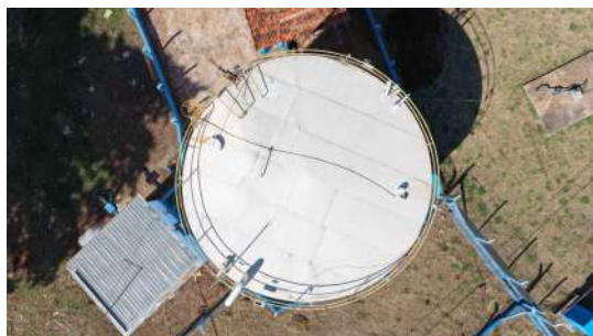
Foto 1 - Vista superior do reservatório.
