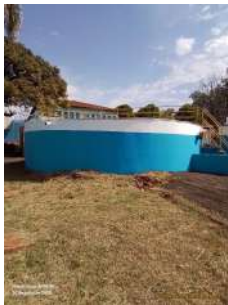
Foto 4 - Vista geral do reservatório.
