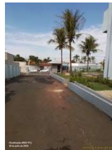
Foto 39 - Cercamento e acesso à ETA.
