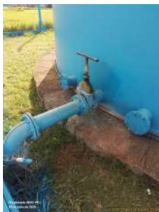
Foto 7 - Registro sem vazamento.
