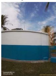
Foto 5 - Vista geral do reservatório.
