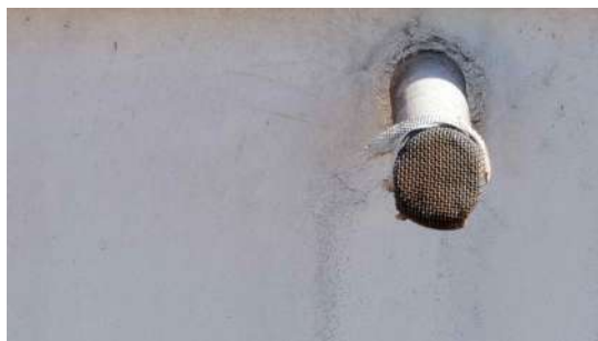
Foto 12 - Extravasor (imagem de drone de 05/08/2026).
