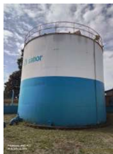
Foto 2 - Vista geral do reservatório.
