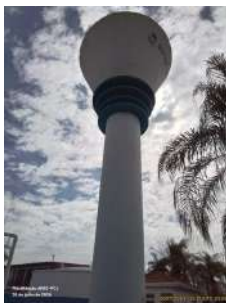
Foto 1 - Vista geral do reservatório.
