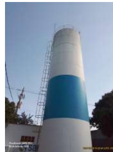
Foto 4 - Vista geral do reservatório.
