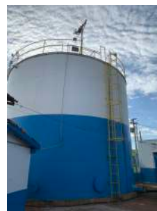
Foto 2 - Vista geral do reservatório.
