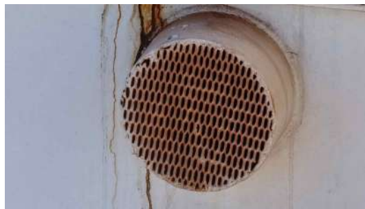
Foto 5 - Extravasor (imagem de drone de 05/08/2026).
