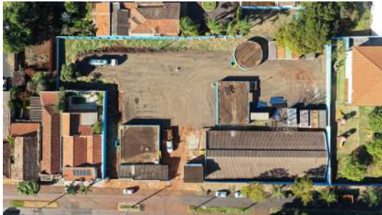
Foto 1 - Vista aérea dos reservatórios da ETA: R 5 (canto inferior direito), R 7 (centro direito) e R 6 (canto inferior esquerdo) e R 8 (canto superior direito) - (imagem de drone de 05/08/2026).
