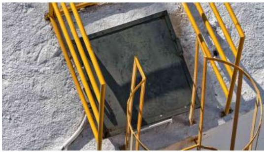
Foto 11 - Tampa de inspeção (imagem de drone de 05/08/2026).
