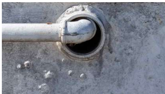
Foto 8 - Extravasor (imagem de drone de 05/08/2026).
