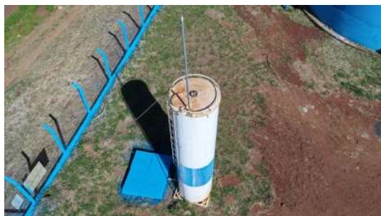
Foto 8 - Vista geral do reservatório (imagem de drone de 05/08/2026).
