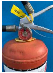
Foto 14 - Pressurização do extintor.
