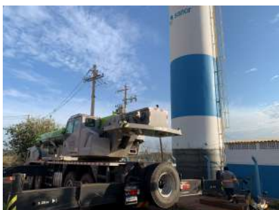
Foto 5 - Reforma do reservatório.
