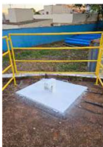
Foto 1 - Adequação apresentada pelo prestador no Protocolo 1286/2026 em 14/08/2026.
