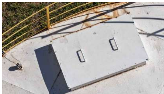
Foto 4 - Tampa de inspeção (imagem de drone de 05/08/2026).
