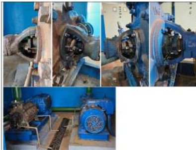
Foto 5 - Adequação apresentada pelo prestador no Protocolo 1286/2026 em 14/08/2026.
