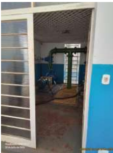
Foto 1 - Acesso à EEAT.
