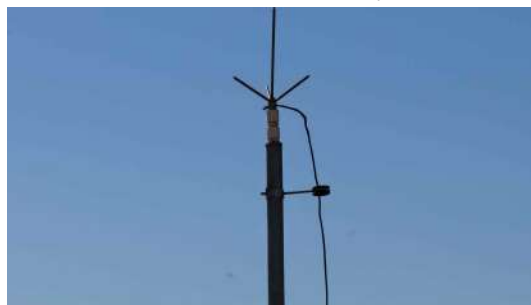
Foto 4 - Captor tipo Franklin (imagem de drone de 05/08/2026).
