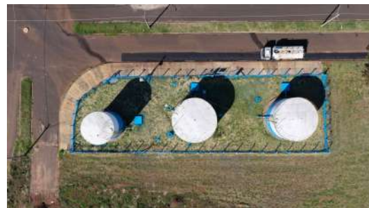
Foto 9 - Vista aérea de parte dos reservatórios do CR Jardim Parisi: R32 (direita), R33 (centro) e R34 (esquerda) - (imagem de drone de 05/08/2026).
