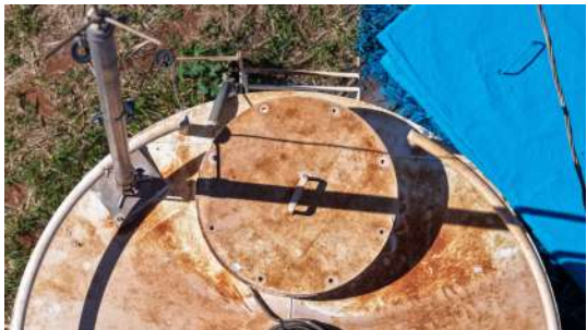
Foto 3 - Tampa de inspeção (imagem de drone de 05/08/2026).
