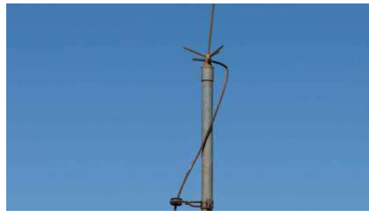
Foto 14 - Captor tipo Franklin (imagem de drone de 05/08/2026).
