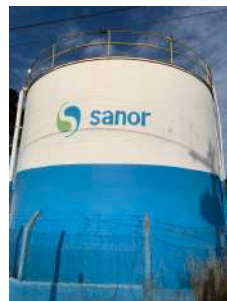
Foto 10 - Vista geral do reservatório.
