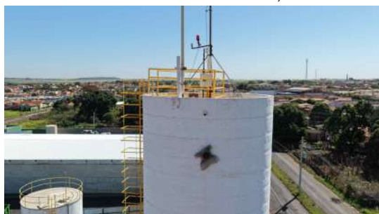
Foto 12 - Extravasor (imagem de drone de 05/08/2026).
