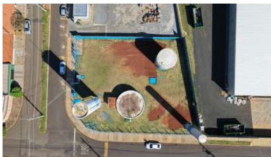
Foto 9 - Vista aérea de parte dos reservatórios do CR Jardim Parisi I: Na parte inferior da imagem R 21 (direita), R 18 (centro) e R19 (esquerda); na parte superior da imagem R 20 (direita) - (imagem de drone de 05/08/2026).
