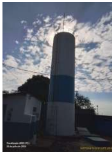
Foto 1 - Vista geral do reservatório.
