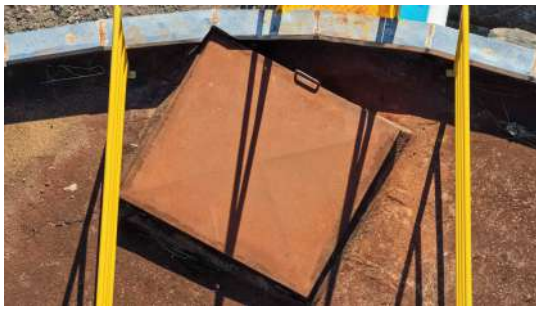
Foto 14 - Tampa de inspeção (imagem de drone de 05/08/2026).
