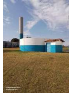
Foto 2 - Vista geral do reservatório.
