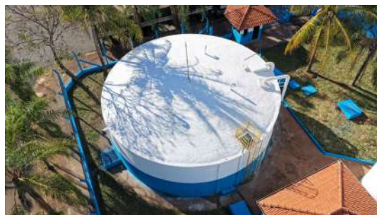
Foto 20 - Vista geral do reservatório (imagem de drone de 05/08/2026).
