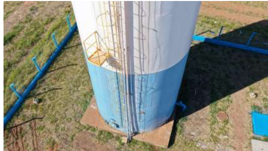
Foto 10 - Guarda-corpo da escada (imagem de drone de 05/08/2026).
