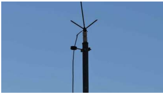
Foto 8 - Captor tipo Franklin (imagem de drone de 05/08/2026).
