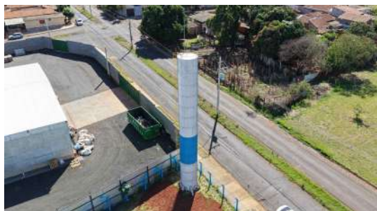
Foto 10 - Vista geral do reservatório (imagem de drone de 05/08/2026).
