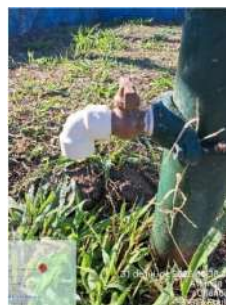
Foto 2 - Adequação apresentada pelo prestador no Protocolo 1286/2026 em 14/08/2026.
