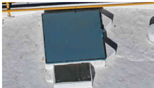
Foto 3 - Tampa de inspeção (imagem de drone de 05/08/2026).
