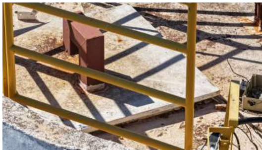
Foto 11 - Tampa de inspeção e tubulação de ventilação (imagem de drone de 05/08/2026).
