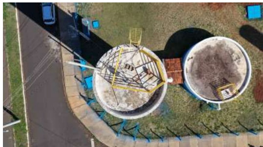
Foto 10 - Vista superior do reservatório (imagem de drone de 05/08/2026).
