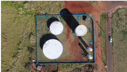
Foto 1 - Vista aérea dos reservatórios Siena: R 12 (canto inferior esquerdo), R 13 (canto superior esquerdo), R 27 (canto superior direito) e R14 e 15 (canto inferior direito) - (imagem de drone de 05/08/2026).
