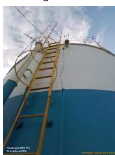
Foto 3 - Descida do SPDA e guarda-corpo da escada.
