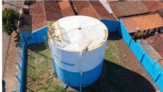
Foto 2 - Realizara pintura de proteção contra corrosão.
