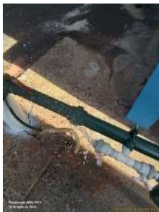
Foto 5 - Tomada de água bruta.
