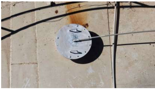
Foto 13 - Tampa de inspeção (imagem de drone de 05/08/2026).
