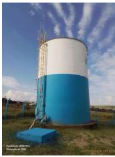
Foto 1 - Vista geral do reservatório.
