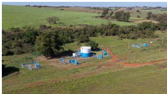
Foto 11 - Vista superior do reservatório (imagem de drone de 05/08/2026).
