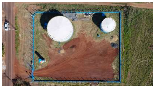
Foto 1 - Vista aérea dos reservatórios Brasão: R 29 (canto inferior esquerdo), R 16 (canto superior esquerdo) e R 17 (canto superior direito) - (imagem de drone de 05/08/2026).
