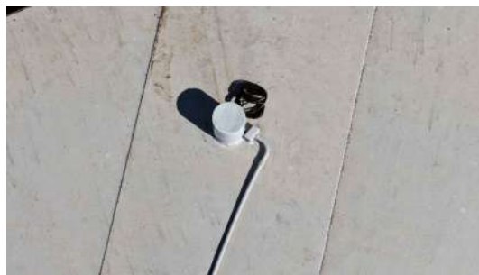
Foto 2 - Detalhe de elemento na parte superior do reservatório.
