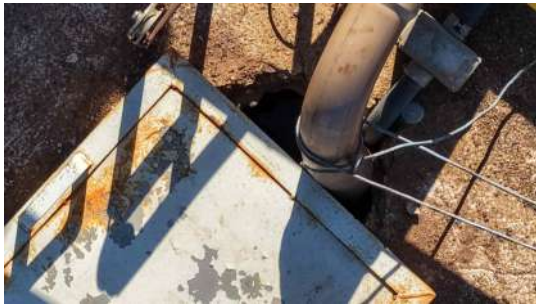
Foto 1 - Abertura na laje do reservatório.
