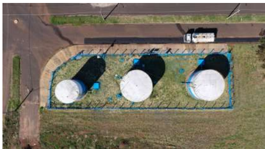
Foto 8 - Vista aérea de parte dos reservatórios do CR Jardim Parisi: R32 (direita), R33 (centro) e R34 (esquerda) - (imagem de drone de 05/08/2026).
