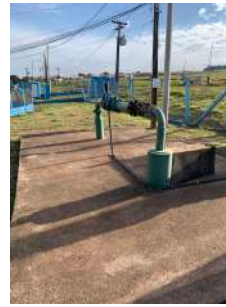
Foto 2 - Vista geral do poço.
