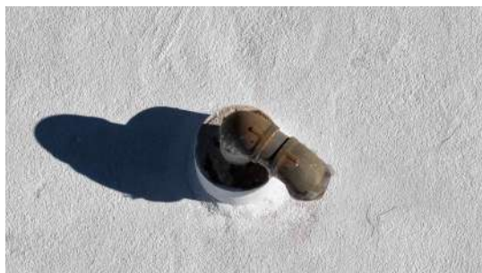
Foto 4 - Tubulação de ventilação (imagem de drone de 05/08/2026).
