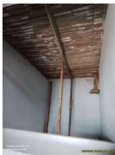
Foto 1 - Laje escorada entre os filtros 1 e 2 com o 3 e 4.
