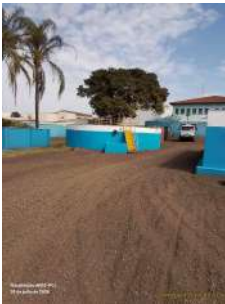
Foto 1 - Vista geral do reservatório.
