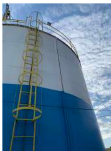
Foto 3 - Guarda-corpo da escada.
