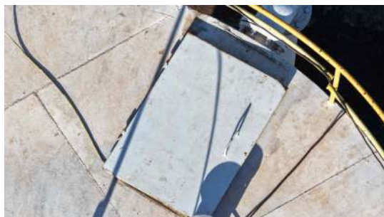
Foto 3 - Tampa de inspeção (imagem de drone de 05/08/2026).
