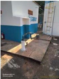
Foto 2 - Vista geral do poço.
