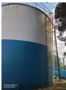
Foto 5 - Guarda-corpo da escada.
