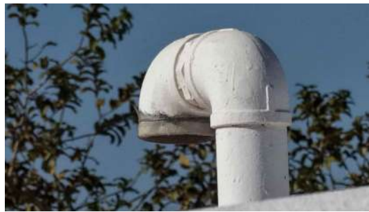
Foto 13 - Tubulação de ventilação (imagem de drone de 05/08/2026).
