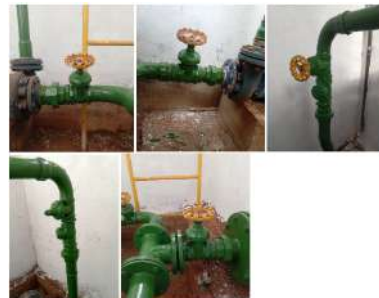
Foto 3 - Adequação apresentada pelo prestador no Protocolo 1286/2026 em 14/08/2026.
