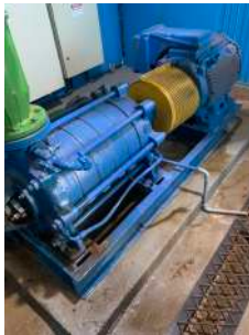
Foto 9 - Drenagem da água de lubrificação das gaxetas da bomba 2.
