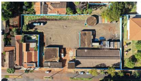
Foto 4 - Vista aérea dos reservatórios da ETA: R 5 (canto inferior direito), R 7 (centro direito) e R 6 (canto inferior esquerdo) e R 8 (canto superior direito) - (imagem de drone de 05/08/2026).
