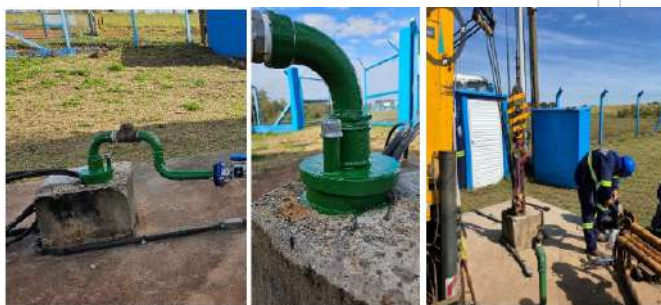
Foto 2 - Adequação apresentada pelo prestador no Protocolo 1286/2026 em 14/08/2026.
