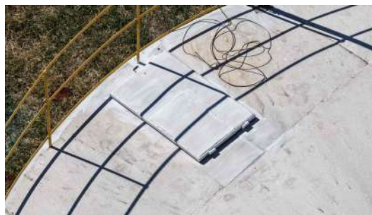
Foto 9 - Tampa de inspeção (imagem de drone de 05/08/2026).
