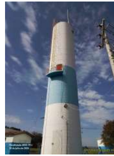
Foto 2 - Vista geral do reservatório, guarda-corpo e descida do SPDA.
