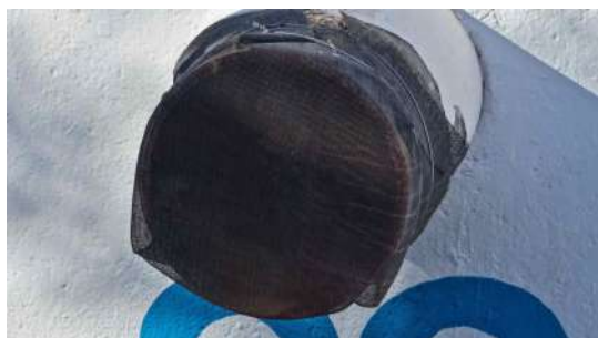
Foto 10 - Extravasor (imagem de drone de 05/08/2026).
