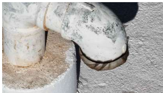
Foto 5 - Tubulação de ventilação (imagem de drone de 05/08/2026).
