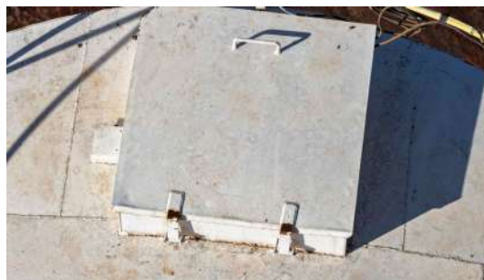
Foto 2 - Tampa de inspeção (imagem de drone de 05/08/2026).
