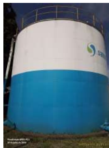
Foto 8 - Vista geral do reservatório.
