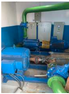
Foto 5 - Vista geral da EEAT.
