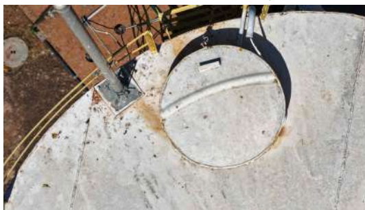
Foto 12 - Tampa de inspeção (imagem de drone de 05/08/2026).
