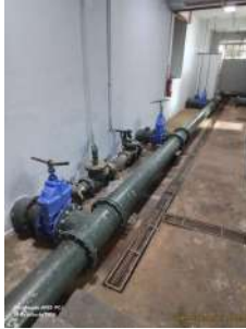
Foto 33 - Tubulação de saída dos filtros sem vazamento.
