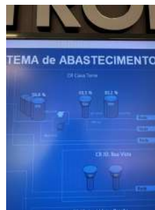
Foto 23 - Detalhes da unidade no CCO.
