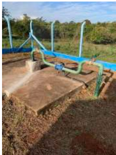
Foto 2 - Vista geral do poço.
