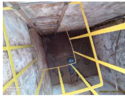
Foto 4 - Vista do acesso à EEAT.
