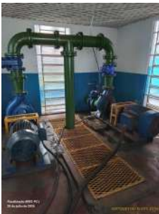
Foto 2 - Vista interna da EEAT.
