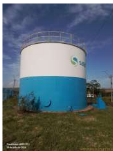
Foto 1 - Vista geral do reservatório.
