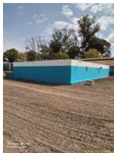
Foto 2 - Vista geral do reservatório.
