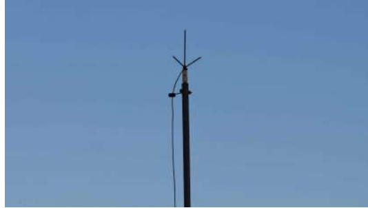
Foto 8 - Captor tipo Franklin (imagem de drone de 05/08/2026).
