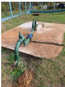
Foto 7 - Vista geral do poço e cercamento.
