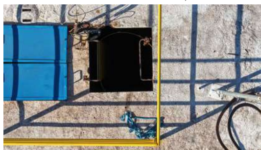
Foto 9 - Tampa de inspeção e acesso da escada interna (imagem de drone de 05/08/2026).
