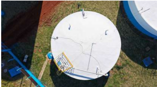
Foto 7 - Vista geral do reservatório (imagem de drone de 05/08/2026).
