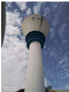
Foto 3 - Vista geral do reservatório.
