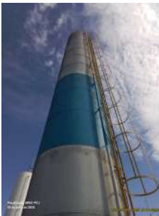
Foto 3 - Vista geral do reservatório.
