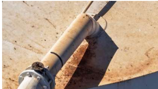
Foto 3 - Realizara pintura de proteção contra corrosão.
