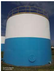
Foto 5 - Vista geral do reservatório.
