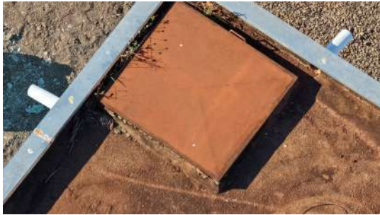
Foto 7 - Tampa de inspeção (imagem de drone de 05/08/2026).
