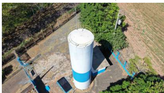
Foto 23 - Vista geral do reservatório (imagem de drone de 05/08/2026).
