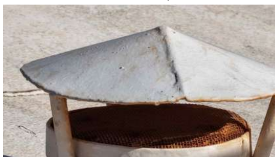
Foto 7 - Tubulação de ventilação (imagem de drone de 05/08/2026).
