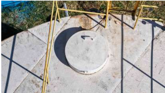
Foto 12 - Tampa de inspeção (imagem de drone de 05/08/2026).
