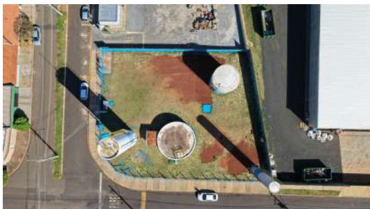
Foto 7 - Vista aérea de parte dos reservatórios do CR Jardim Parisi I: Na parte inferior da imagem R 21 (direita), R 18 (centro) e R19 (esquerda); na parte superior da imagem R 20 (direita) - (imagem de drone de 05/08/2026).
