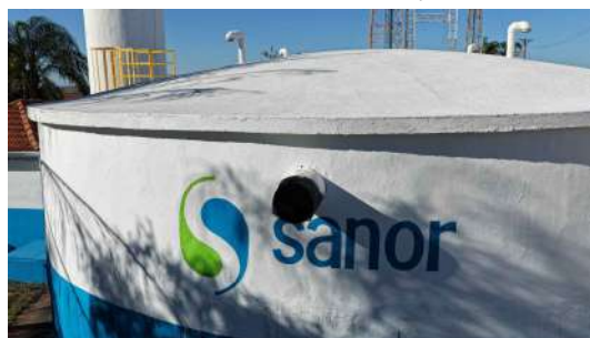
Foto 9 - Extravasor (imagem de drone de 05/08/2026).
