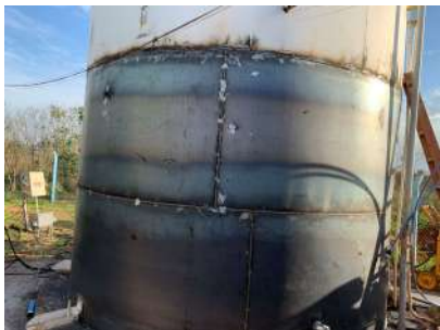
Foto 3 - Reforma do reservatório.
