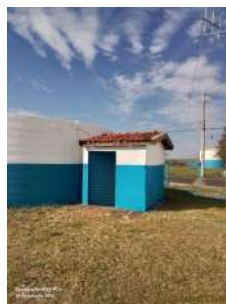
Foto 2 - Vista externa da EEAT.
