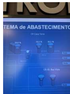
Foto 22 - Detalhes da unidade no CCO.
