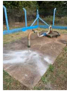
Foto 2 - Vista geral do poço.
