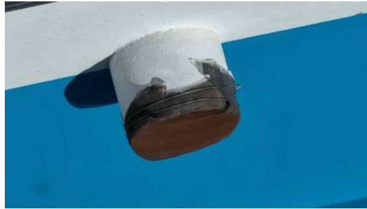
Foto 8 - Extravasor (imagem de drone de 05/08/2026).
