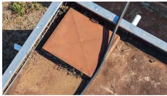
Foto 6 - Tampa de inspeção (imagem de drone de 05/08/2026).
