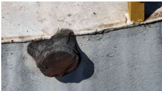
Foto 13 - Extravador (imagem de drone de 05/08/2026).
