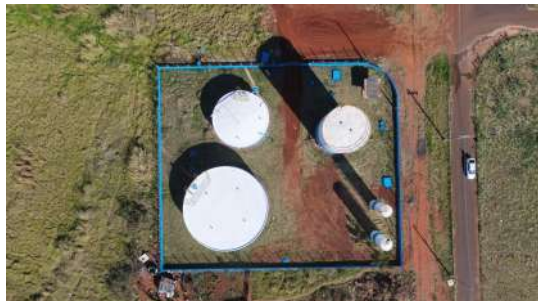
Foto 1 - Vista aérea dos reservatórios Siena: R 12 (canto inferior esquerdo), R 13 (canto superior esquerdo), R 27 (canto superior direito) e R14 e 15 (canto inferior direito) - (imagem de drone de 05/08/2026).
