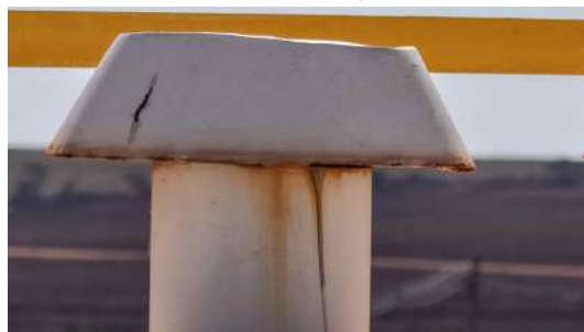
Foto 7 - Tubulação de ventilação (imagem de drone de 05/08/2026).
