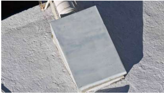
Foto 13 - Tubulação de alimentação (imagem de drone de 05/08/2026).
