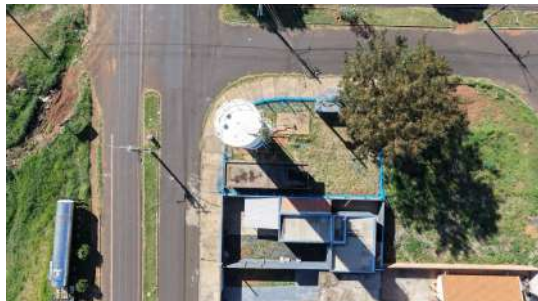
Foto 1 - Vista superior do reservatório (imagem de drone de 05/08/2026).
