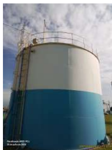
Foto 4 - Extravasor e guarda-corpo.
