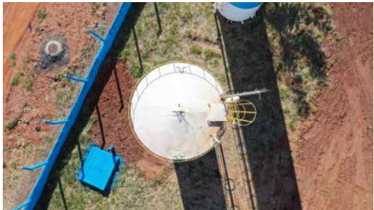
Foto 2 - Vista superior do reservatório (imagem de drone de 05/08/2026).
