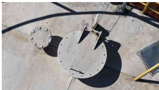
Foto 14 - Tampa de inspeção (imagem de drone de 05/08/2026).
