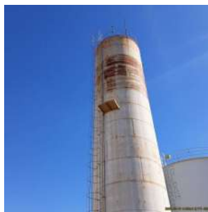
Foto 6 - Guarda-corpos e haste do para-raios no topo do reservatório.
