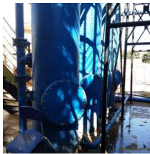
Foto 10 - Vista dos quatro filtros a partir do solo.
