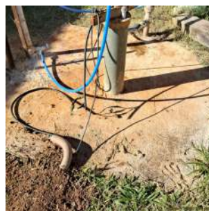
Foto 4 - Detalhe da laje de proteção.
