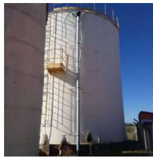
Foto 4 - Vista geral do Reservatório São Judas.
