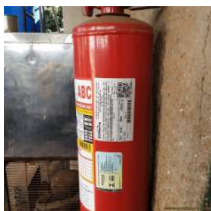
Foto 1 - Detalhe da etiqueta de controle de manutenções do extintor.
