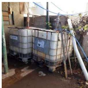
Foto 1 - Tanques de produtos químicos armazenados de forma inadequada.
