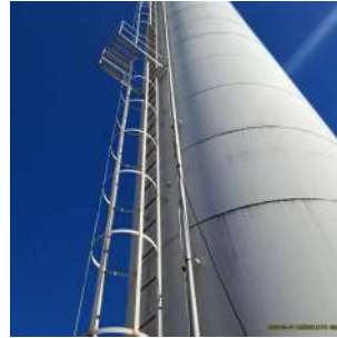
Foto 2 - Vista geral do reservatório.
