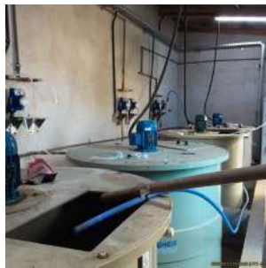
Foto 12 - Vista geral da nova sala de armazenamento de produtos químicos.
