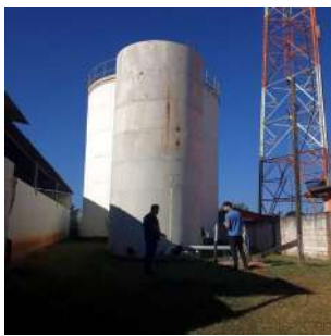
Foto 3 - Vista geral da área. Em primeiro plano está o Poço São Judas e o reservatório desativado.
