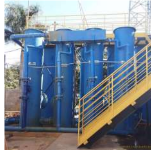
Foto 3 - Vista geral da ETA.
