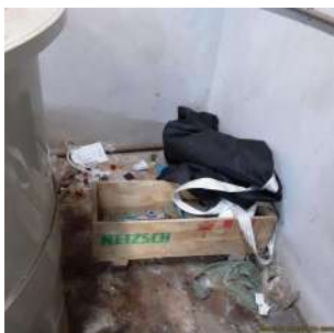
Foto 3 - Segundo bag do sistema, localizado no interior de um dos diques de contenção da casa de química.
