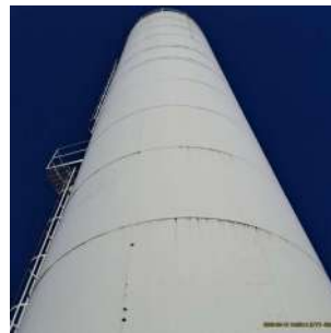
Foto 3 - Escadas de acesso ao topo do reservatório. À direita, a tubulação de entrada da água no reservatório.
