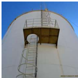
Foto 3 - Escadas de acesso ao topo do reservatório.
