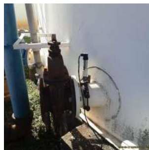
Foto 9 - Equipamento de telemetria para medição de nível.
