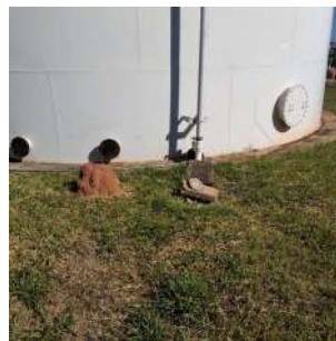
Foto 4 - Base do reservatório, no centro, a tubulação de entrada de água.
