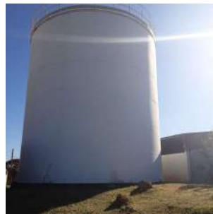
Foto 5 - Vista geral do Reservatório São Judas.
