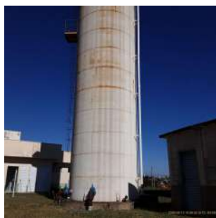
Foto 3 - Vista geral do reservatório.
