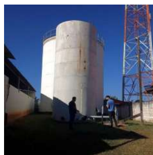
Foto 2 - Vista geral da área. Em primeiro plano está o Poço São Judas e o reservatório desativado.
