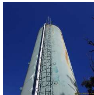
Foto 7 - Escada de acesso ao topo do reservatório. À direita da escada, próximo ao topo do reservatório, se encontra o tubo extravasor.
