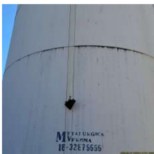
Foto 6 - Medidor de nível.
