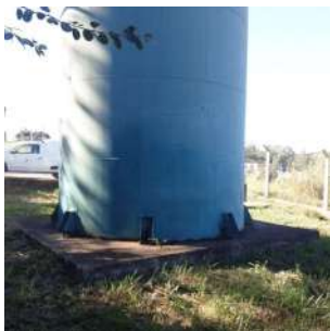
Foto 4 - Vista geral da base do reservatório.
