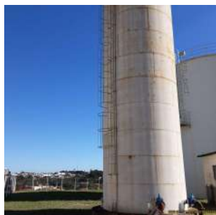
Foto 5 - Escadas de acesso ao topo do reservatório.
