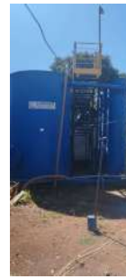
Foto 2 - Vista geral da ETA.
