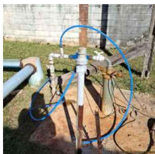
Foto 3 - Vista geral do poço.
