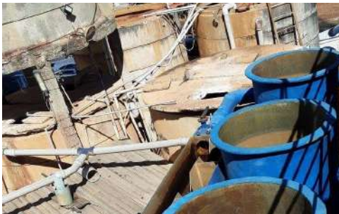
Foto 1 - À esquerda, estruturas da antiga ETA mantidas no local.
