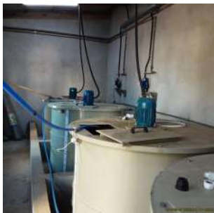
Foto 11 - Vista geral da nova sala de armazenamento de produtos químicos.
