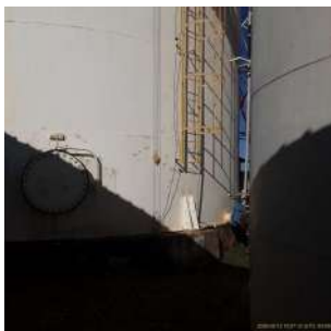
Foto 6 - Escadas de acesso ao topo do reservatório.
