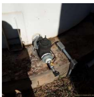
Foto 10 - Equipamento de telemetria para medição de nível.
