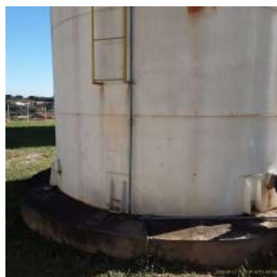
Foto 7 - Detalhe do aterramento do para-raios.
