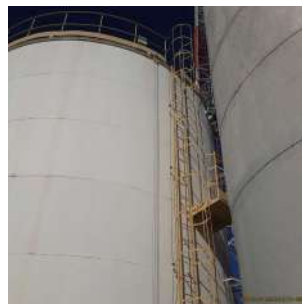
Foto 7 - Escadas de acesso e guarda-corpos do topo do reservatório.
