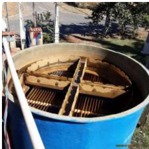
Foto 7 - Vista superior do decantador.
