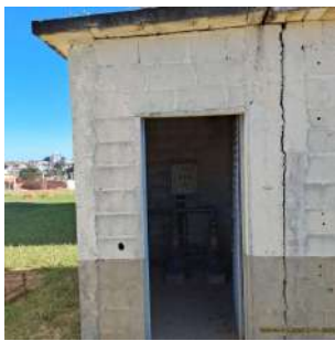
Foto 3 - Vista geral da edificação que abriga a elevatória.
