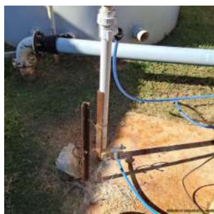
Foto 8 - Depósito de pastilhas para cloração e fluoretação da água.
