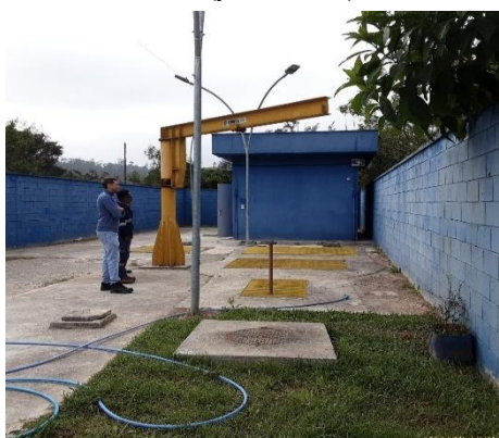
Foto 3 - EEE Botujuru IIA: Vista geral da elevatória após conclusão das melhorias (julho/2025).
