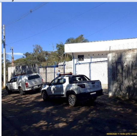
Foto 1 - EEE 4.1 – SÃO MARTINHO: Cercamento de área e portão de acesso à elevatória. Esta EEE está localizada em uma via sem nome, próximo à Rua Um.
