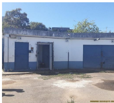
Foto 6 - EEE Oceania: Edificação que abriga os equipamentos elétricos da elevatória (agosto/2026).
