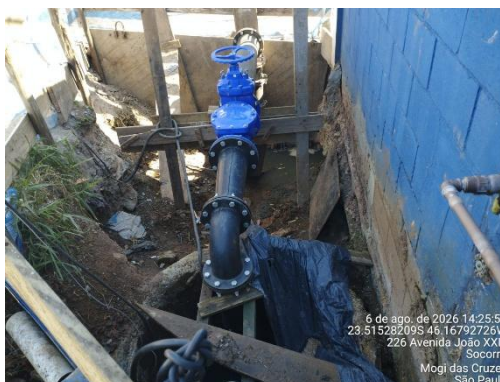
Foto 4 - EEE JD. SÃO PEDRO: Reforma da elevatória em andamento.
