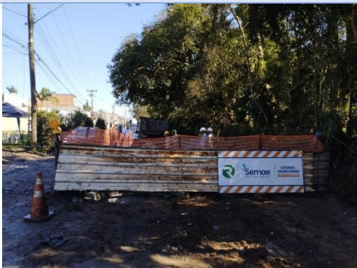
Foto 1 – Obra de implantação da estação elevatória de esgoto (EEE-3.2).
