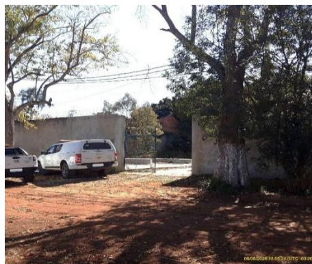
Foto 4 - EEE 2.1 – VARINHAS II: Cercamento da área e portão de acesso à elevatória. Esta EEE está localizada na Rua Padre Albino Bareta, na altura do nº 1961-2397.
