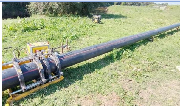
Foto 2 - Obras de implantação do coletor tronco (registros do prestador).
