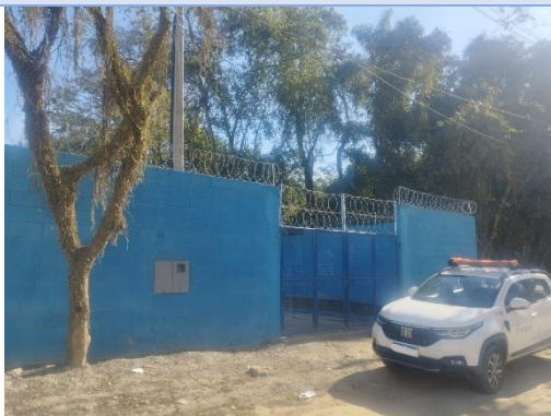
Foto 1 - EEE BEIJA FLOR: Cercamento de área e portão de acesso à elevatória. Esta EEE está localizada na Estr. do Beija Flor.
