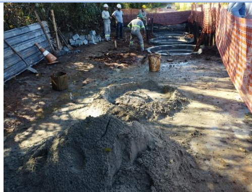
Foto 2 - Obra de implantação da estação elevatória de esgoto (EEE-3.2).
