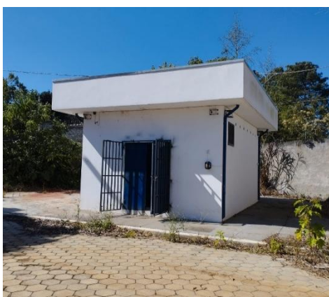
Foto 5 - EEE 2. 1 – VARINHAS II: Edificação para abrigo de equipamentos e painéis elétricos.
