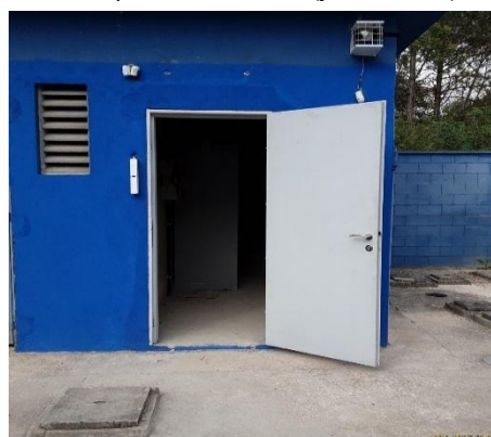
Foto 4 - EEE Botujuru IIA: Edificação para abrigo de equipamentos e painéis elétricos (julho/2025).
