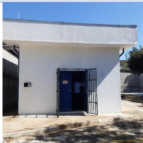
Foto 2 - EEE 4. 1 – SÃO MARTINHO: Edificação para abrigo de equipamentos e painéis elétricos.
