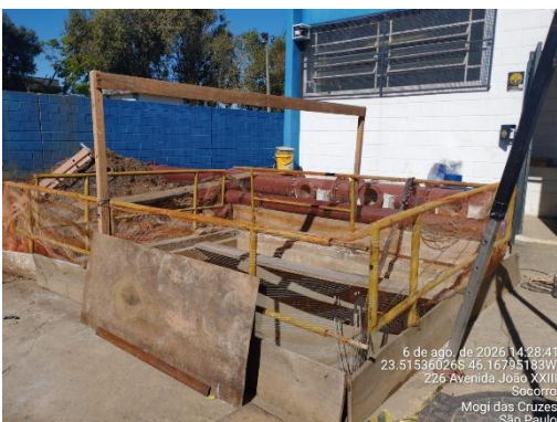
Foto 3 - EEE JD. SÃO PEDRO: Reforma da elevatória em andamento.
