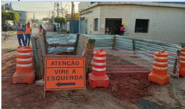
Foto 1 – Obras de implantação da rede coletora (registros do prestador).
