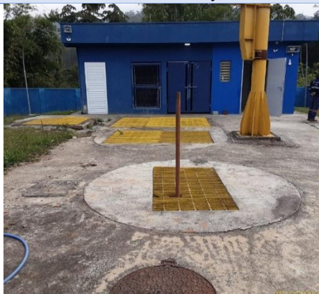
Foto 1 - EEE Botujuru I: Vista geral da elevatória após conclusão das melhorias (julho/2025).
