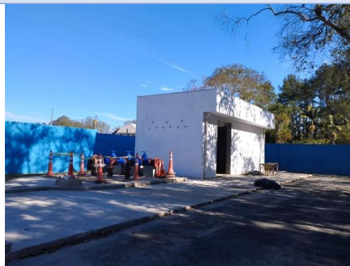
Foto 2 - EEE BEIJA FLOR: Vista geral da edificação, ainda sem equipamentos e instalações elétricas.
