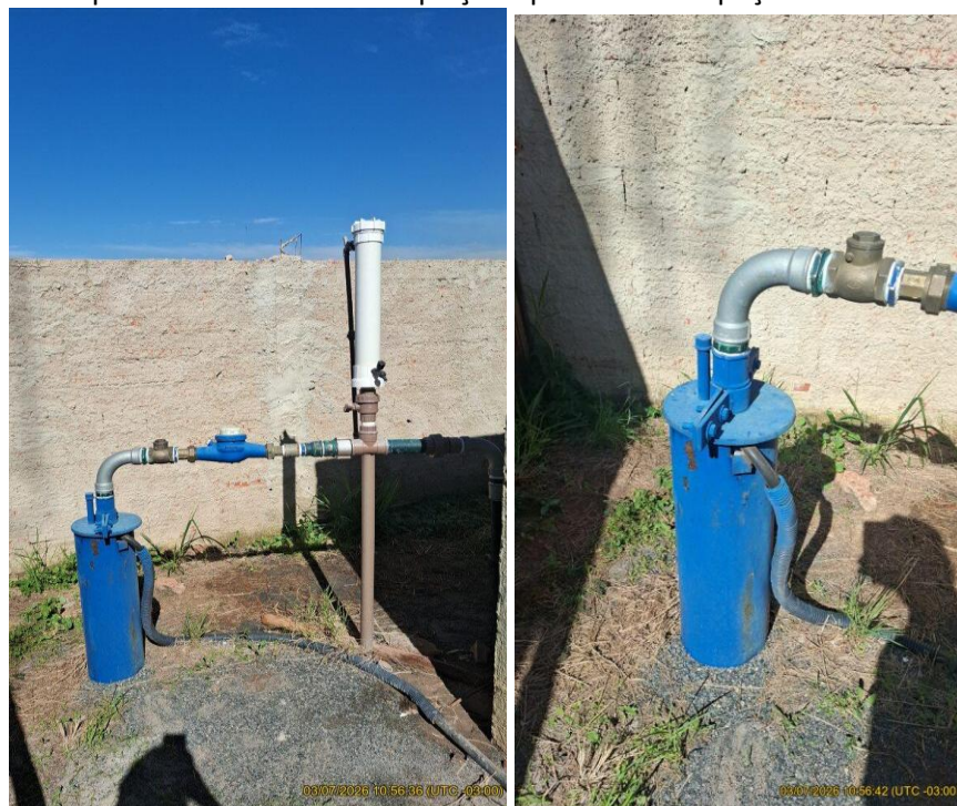
Figura TEC 4 – Aprofundamento e readequação operacional do poço do Jardim São Francisco.
