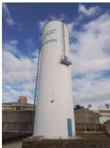
Foto 3 - Visão geral do reservatório elevado.
