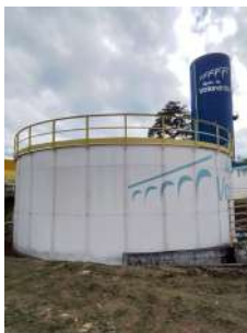
Foto 8 - Visão geral do reservatório metálico apoiado com 500m³.
