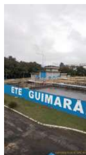
Foto 12 - Visão da ETE a partir do tratamento preliminar.
