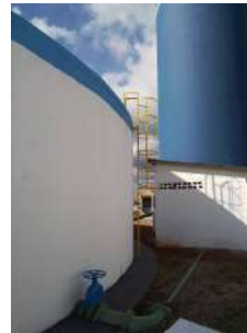
Foto 4 - Escada do reservatório e saída para e elevatória que recalca para o elevado.
