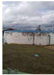
Foto 4 - Reservatório Serrano apoiado de concreto.
