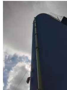
Foto 6 - Alimentação do reservatório.
