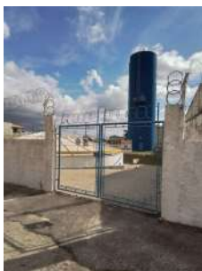
Foto 1 - Acesso ao centro de reservação Itapeva.
