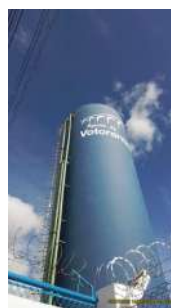
Foto 2 - Visão geral do reservatório elevado.
