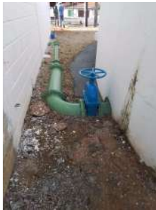
Foto 3 - Saída do reservatório para uma elevatória.
