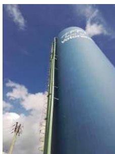
Foto 5 - Tubulações do reservatório.
