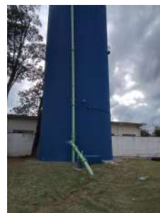
Foto 4 - Alimentação do reservatório.
