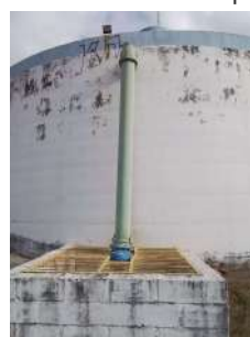
Foto 5 - Alimentação do reservatório.
