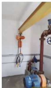
Foto 13 - Estrutura para içamento dos equipamentos.
