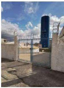
Foto 1 - Acesso ao centro de reservação Itapeva.
