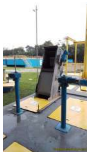
Foto 3 - Gradeamento inicial mecanizado.
