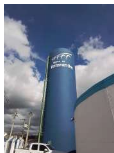
Foto 6 - Visão geral do reservatório.
