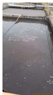
Foto 21 - Módulo em decantação.
