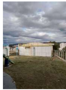
Foto 4 - Visão geral do reservatório metálico.
