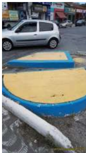
Foto 1 - Poços da elevatória contendo gradeamento e duas bombas submersíveis.
