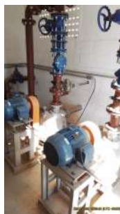
Foto 7 - Bombas centrífugas autoescurvantes.
