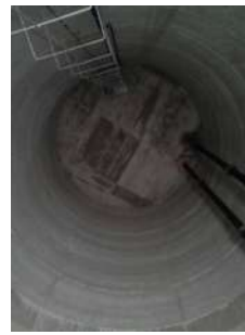
Foto 11 - Interior da câmara inferior.
