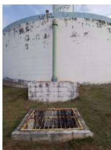
Foto 6 - Entrada do reservatório.
