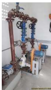
Foto 6 - Bombas centrífugas auto escorvantes
