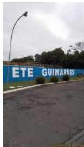
Foto 7 - Fachada da ETE.
