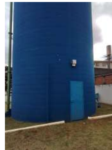
Foto 7 - Acesso à câmara inferior.
