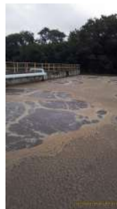
Foto 26 - Aeração no reator 2.
