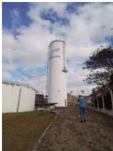
Foto 2 - Reservatório elevado e apoiado.
