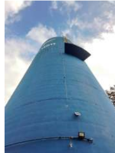
Foto 8 - Descida do aterramento.
