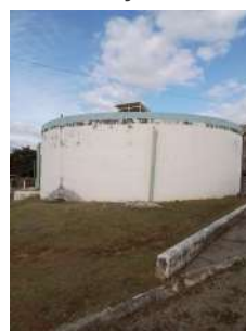
Foto 7 - Extravador do reservatório.
