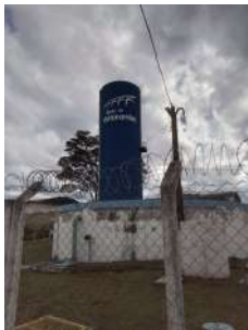
Foto 2 - Reservatório apoiado de concreto.
