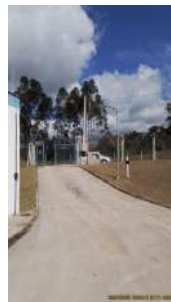
Foto 4 - Portão de acesso
