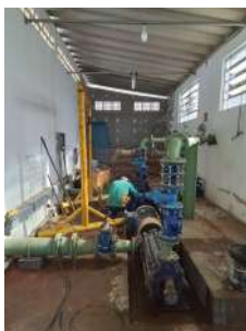
Foto 3 - Elevatória em obras para adequações.
