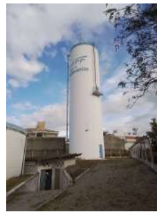
Foto 6 - Elevatória e reservatório.
