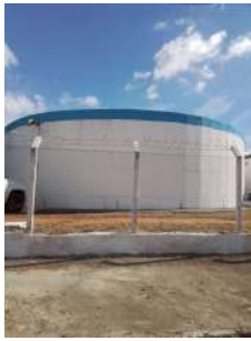
Foto 1 - Visão geral do reservatório apoiado.
