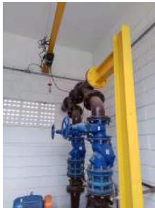
Foto 9 - Recalque e estrutura para manutenção.
