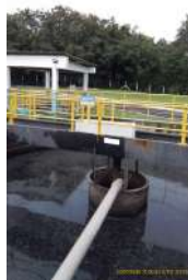
Foto 4 - Adensador de lodo.
