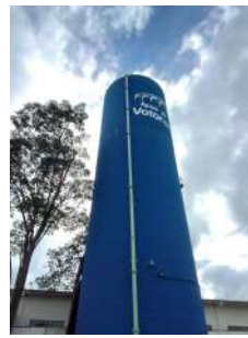
Foto 6 - Visão geral do reservatório elevado.
