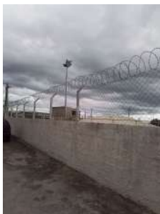
Foto 15 - Muro e cerca no perímetro.
