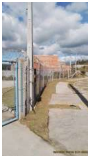
Foto 3 - Cercamento no perímetro.
