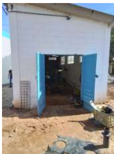
Foto 1 - Entrada da casa de bombas que abriga duas elevatórias: São João para presídio e para Aldeia da Mata. O local estava passando por reforma.
