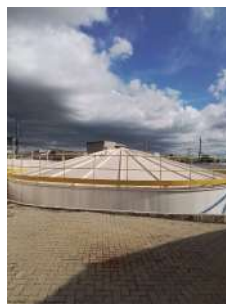
Foto 2 - Um dos reservatórios metálicos apoiados.
