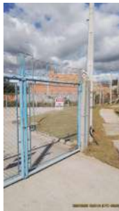
Foto 2 - Portão de acesso
