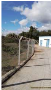
Foto 4 - Cercamento no perímetro.
