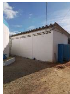
Foto 4 - Casa de bombas.
