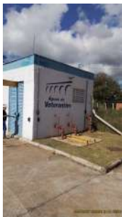
Foto 5 - Visão geral da elevatória.
