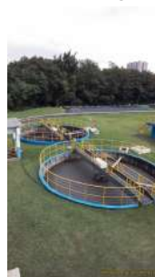
Foto 17 - Adensadores de lodo.
