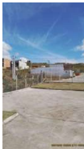
Foto 6 - Cercamento no perímetro.
