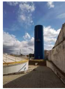
Foto 2 - Visão geral do reservatório elevado.
