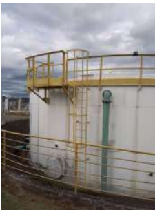
Foto 1 - Escada para acessar a cobertura e tubulação de alimentação do reservatório.
