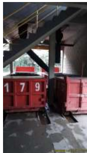
Foto 11 - Caçamba para acondicionamento do lodo ressecado pelas centrífugas.
