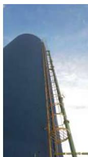
Foto 3 - Escada de acesso à cobertura.
