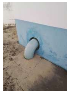
Foto 2 - Entrada na elevatória.
