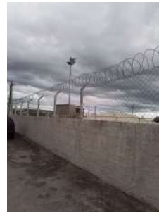
Foto 5 - Cerca e muro no perímetro.
