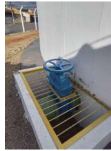
Foto 2 - Saída do reservatório.
