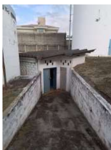
Foto 1 - Acesso à elevatória.
