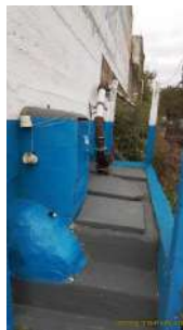
Foto 2 - Visão da elevatória.
