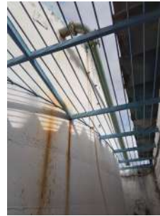
Foto 6 - Tubulação do reservatório apoiado de concreto.
