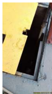
Foto 2 - Chegada do efluente à ETE.
