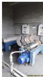
Foto 15 - Centrífugas de lodo.
