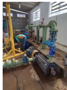
Foto 2 - Obras em execução. A unidade foi ampliada para abrigar bomba reserva da elevatória Aldeia da Mata. A concessionária aproveitou a intervenção para realizar manutenção e adequações na elevatória para o presídio.
