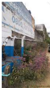
Foto 5 - Recalque da elevatória.
