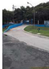
Foto 8 - Portão de acesso.
