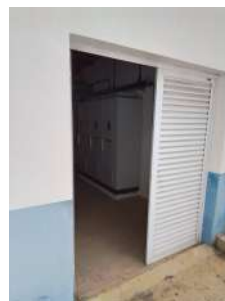
Foto 3 - Acesso à casa de bombas.
