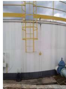
Foto 12 - Escada e medidor de nível.
