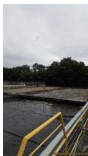
Foto 20 - Reator 1. Ao fundo o módulo 1-C realizando aeração.
