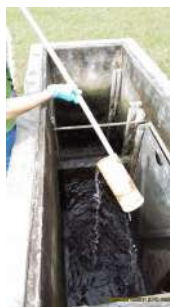
Foto 34 - Efluente tratado antes do lançamento.
