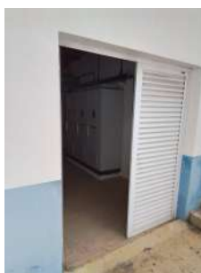
Foto 1 - Acesso à casa de bombas Itapeva, que abriga 2 elevatórias: Itapeva para Vic Verona e Itapeva apoiado para elevado.
