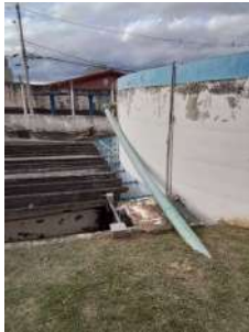
Foto 7 - Reservatório apoiado e tubulação de alimentação.
