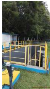
Foto 4 - Caixa de areia em manutenção.
