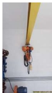
Foto 9 - Estrutura para içamento dos equipamentos.
