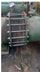
Foto 7 - Substituição da válvula BR3 pelo prestador para sanar o vazamento. Fonte: enviada pela CSJ em 04/08/2026.
