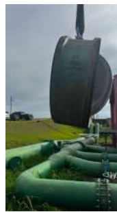
Foto 6 - Substituição da válvula BR3 pelo prestador para sanar o vazamento. Fonte: enviada pela CSJ em 04/08/2026.
