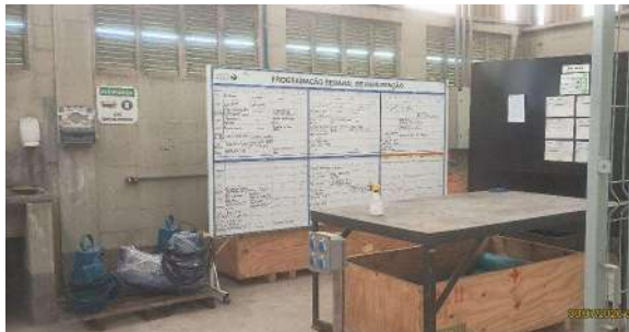
Foto 1 - Vista geral de uma das salas do prédio de manutenção e almoxarifado da ETE Jundiaí.
