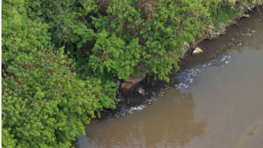
Foto 108 - Vista aérea da saída 3 da ETEJ.
