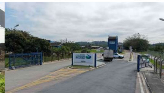
Foto 95 - Vista da entrada da ETEJ.
