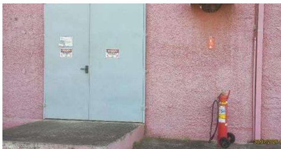
Foto 80 - Entrada e extintor de incêndio do prédio dos sopradores da lagoa de aeração 3.
