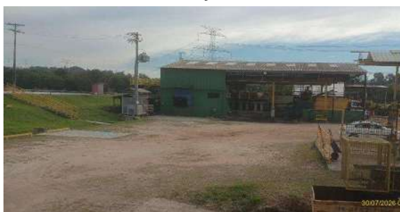
Foto 49 - Vista geral do setor das centrífugas de lodo.
