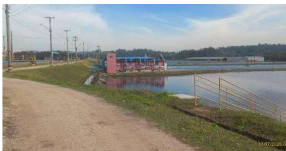
Foto 69 - Lagoas de decantação (direita) e, ao fundo, primeiro abrigo dos sopradores.
