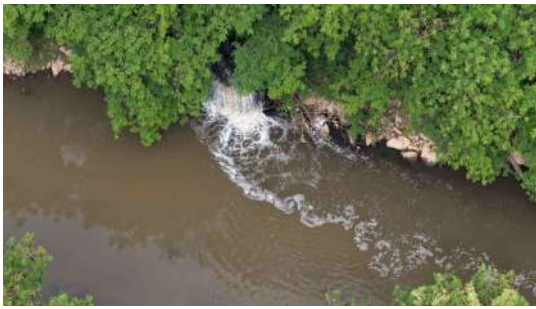
Foto 106 - Vista aérea da saída 2 da ETEJ.
