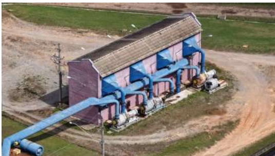
Foto 102 - Vista aérea do segundo abrigo de sopradores.
