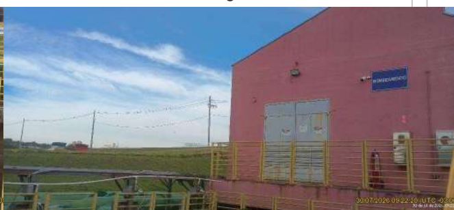
Foto 39 - Abrigo dos painéis e demais equipamentos elétricos da estação elevatória de esgoto.
