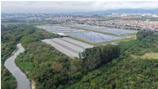
Foto 98 - Vista aérea geral da ETEJ (lagoas e galpões de compostagem) e do Rio Jundiáí.
