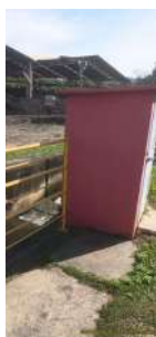
Foto 90 - Abrigo do medidor de vazão da saída 3.
