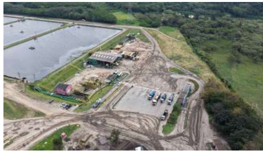
Foto 97 - Vista aérea geral da ETEJ.
