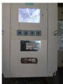
Foto 3 - Medidor de vazão da saída 1. Fonte: enviada pela CSJ em 04/08/2026.
