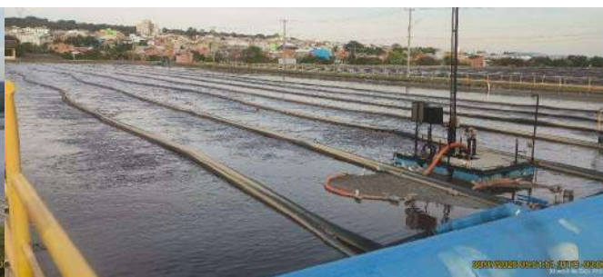
Foto 70 - Lagoas de aeração.
