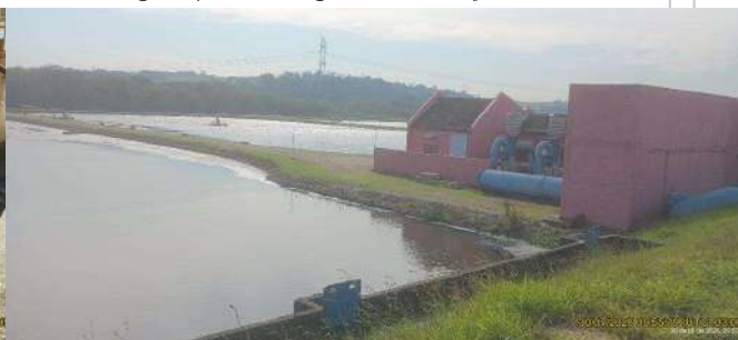
Foto 73 - Lagoas de decantação (esquerda) e, ao fundo, primeiro abrigo dos sopradores.
