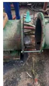
Foto 4 - Substituição da válvula BR3 pelo prestador para sanar o vazamento. Fonte: enviada pela CSJ em 04/08/2026.
