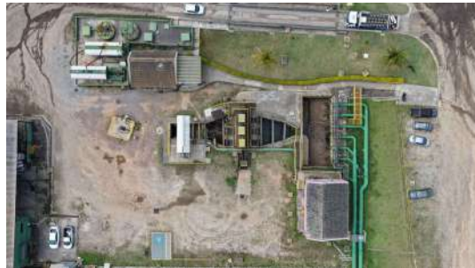
Foto 99 - Vista aérea do prédio do controle operacional, tratamento preliminar e estação elevatória de esgoto.
