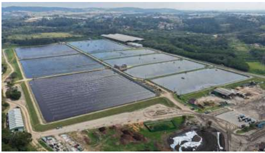
Foto 96 - Vista aérea geral da ETEJ.
