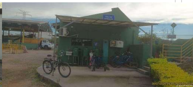
Foto 28 - Prédio do controle operacional da ETEJ.
