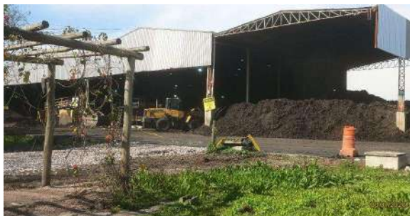
Foto 94 - Vista geral de um dos galpões de compostagem do lodo gerado na ETEJ.
