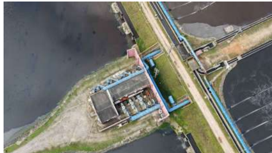
Foto 101 - Vista aérea do primeiro abrigo de sopradores.
