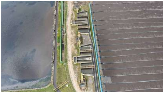
Foto 100 - Vista aérea dos desarenadores.
