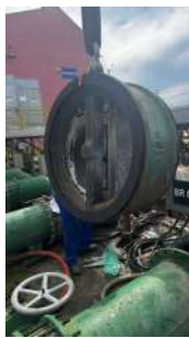
Foto 5 - Substituição da válvula BR3 pelo prestador para sanar o vazamento. Fonte: enviada pela CSJ em 04/08/2026.
