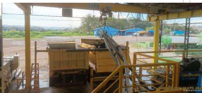
Foto 57 - Destinação do lodo já centrifugado para encaminhamento à compostagem.
