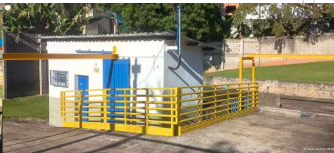
Foto 16 - Vista geral da EEE.
