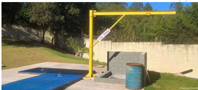
Foto 8 - Chegada de esgoto 1 da EEE.
