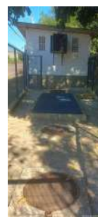
Foto 8 - Entrada do esgoto e, ao fundo, casa de bombas.
