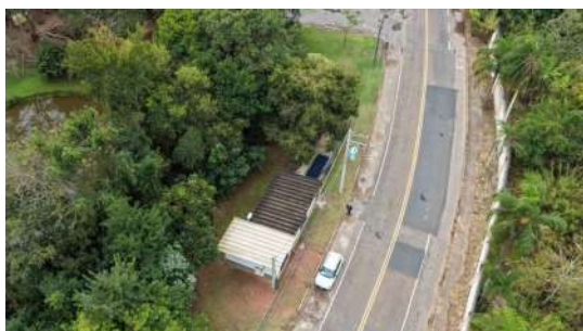
Foto 5 - Vista aérea da EEE Corrupira.
