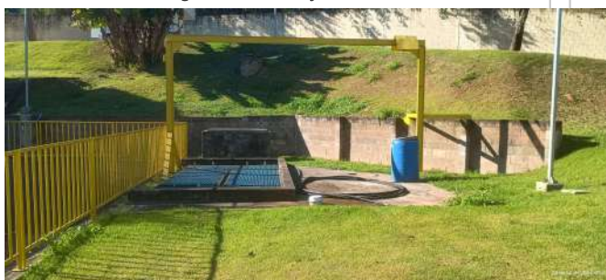
Foto 22 - Segunda entrada de esgoto, direcionado para o tanque pulmão, após passar por gradeamento.
