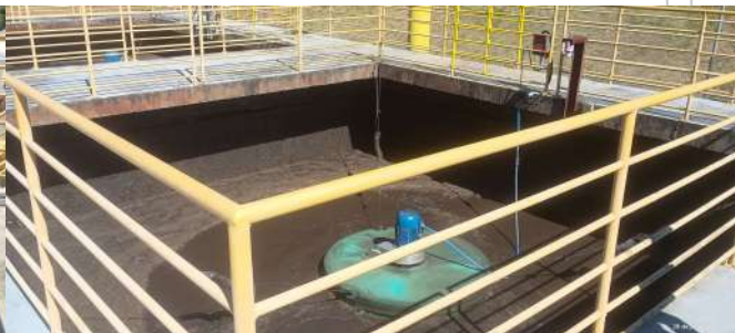
Foto 18 - Um dos dois tanques de aeração.
