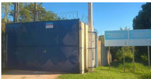
Foto 1 - Entrada da EEE e placa da obra de reforma e ampliação.
