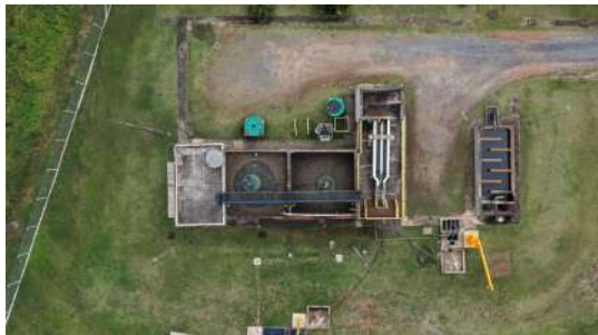
Foto 2 - Vista área da ETE São José.
