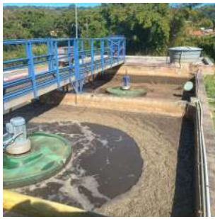
Foto 9 - Vista dos tanques de aeração da ETE.
