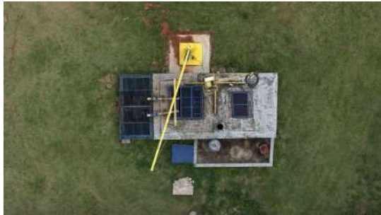
Foto 8 - Vista aérea da estação elevatória na chegada do esgoto na ETE.
