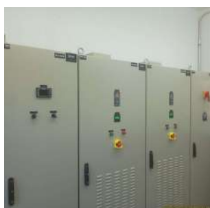
Foto 12 - Painéis elétricos e de comando da nova casa de bombas.
