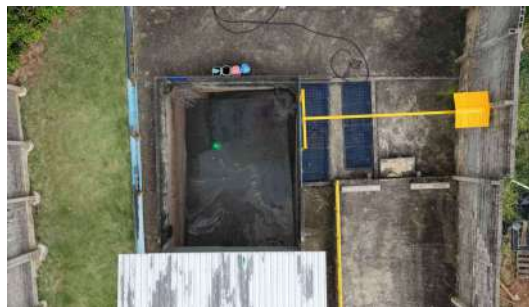
Foto 14 - Vista aérea da EEE.
