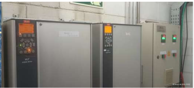
Foto 16 - Painéis elétricos e de comando da EEE.
