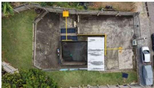
Foto 13 - Vista aérea da EEE.
