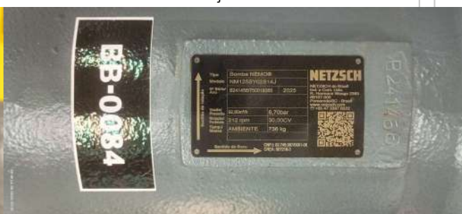
Foto 19 - Placa de especificações técnicas da bomba do conjunto 1.
