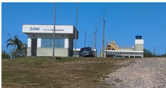
Foto 1 - Vista geral da entrada e identificação da ETE.
