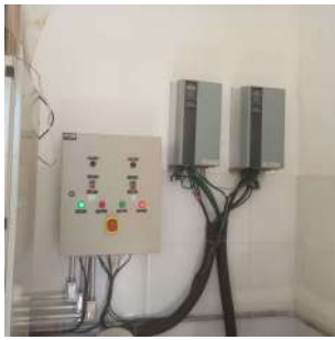
Foto 5 - Painéis elétricos e de comando da EEE.
