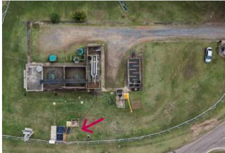
Foto 7 - Foto aérea da ETE São José e indicação do local da EEE.
