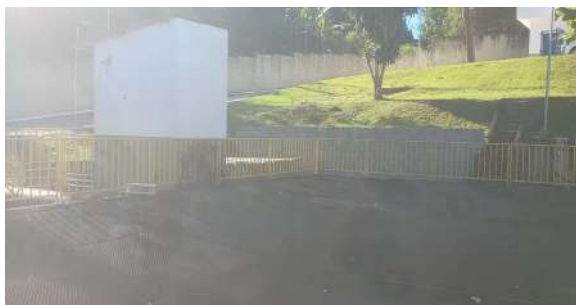
Foto 25 - Vista geral do tanque pulmão e, ao fundo, antiga casa de bombas (ainda em operação).
