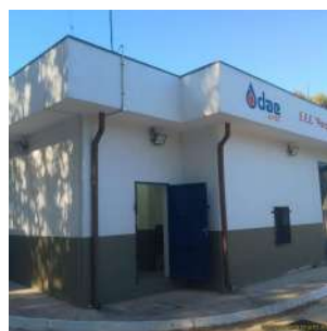
Foto 11 - Entrada da nova casa de bombas.
