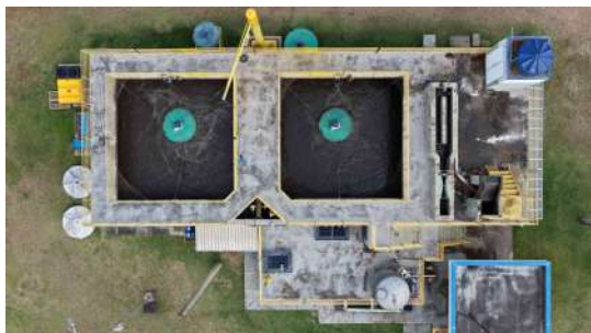
Foto 13 - Vista aérea da ETE e tanques de tratamento.
