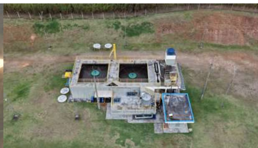
Foto 12 - Vista aérea da ETE e tanques de tratamento.
