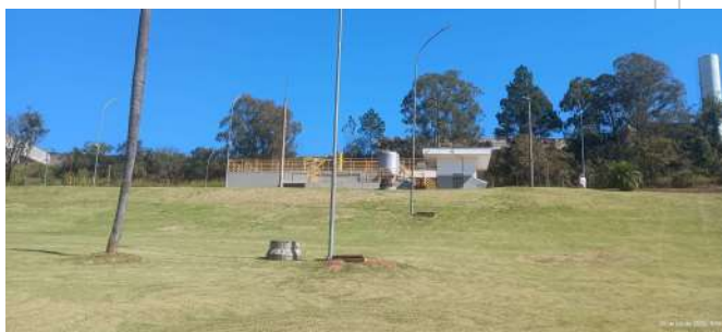
Foto 3 - Vista geral externa da ETE.
