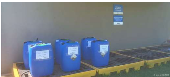
Foto 21 - Produtos químicos armazenados na ETE.
