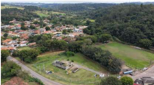
Foto 1 - Vista aérea geral da ETE São José.
