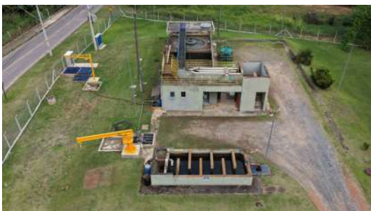
Foto 3 - Vista área da ETE São José.
