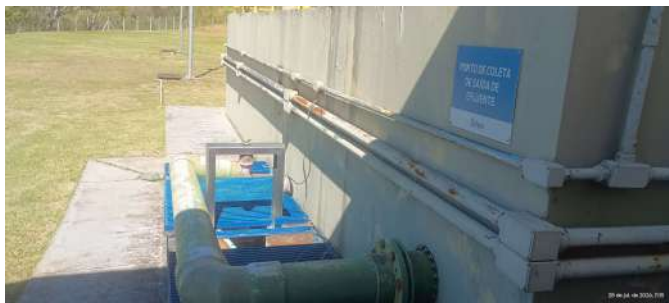
Foto 23 - Saída do efluente, pós desinfecção.
