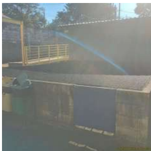
Foto 5 - Tela de cobertura do tanque de acúmulo.
