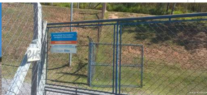
Foto 2 - Placa de identificação da ETE.
