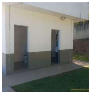
Foto 33 - Sala operacional e banheiro da EEE.
