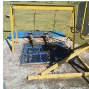
Foto 10 - Vista geral da EEE.
