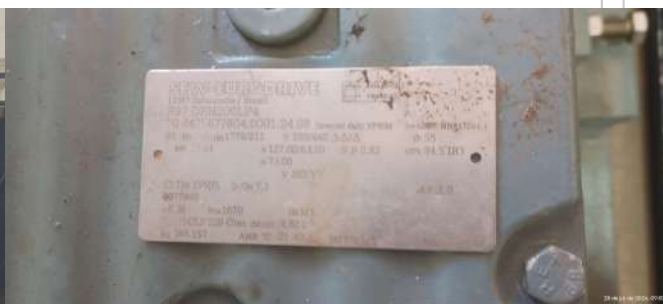
Foto 12 - Placa de especificações técnicas do motor de um dos conjuntos motobomba.
