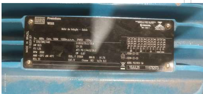
Foto 29 - Placa de especificações técnicas do motor do conjunto motobomba do meio.
