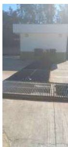
Foto 9 - Novo canal de chegada do esgoto e preliminar (gradeamento e caixa desarenadora) para a nova casa de bombas.
