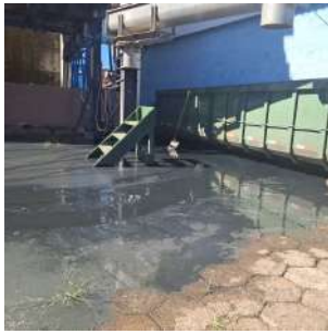
Foto 1 - Detalhe do vazamento próximo ao secador
