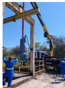
Foto 2 - Evidência de instalação da bomba reserva fornecida pelo SAAE em 17/08/2026
