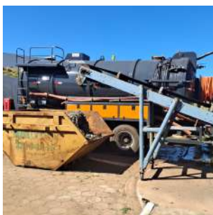
Foto 3 - Caçamba para armazenamento de resíduos do gradeamento
