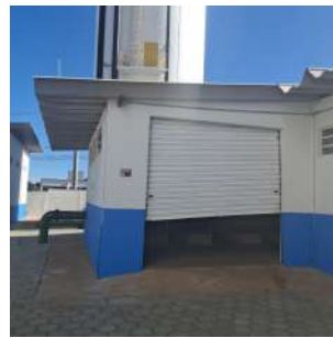
Foto 2 - Vista externa da casa de bombas do centro de reservação Cedrinho
