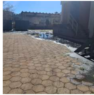
Foto 2 - Detalhe do vazamento próximo ao sistema de desidratação de lodo
