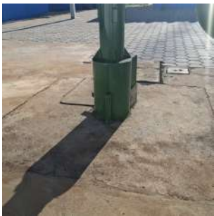
Foto 4 - Laje de proteção do poço Cedrinho
