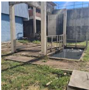
Foto 3 - Detalhe do vazamento no barrilete
