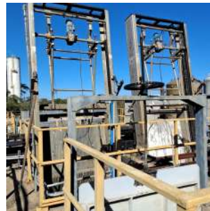
Foto 2 - Gradeamento grosso mecanizado
