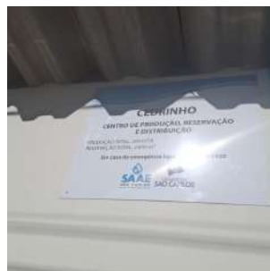
Foto 6 - Placa de identificação do centro de produção, reservação e distribuição Cedrinho
