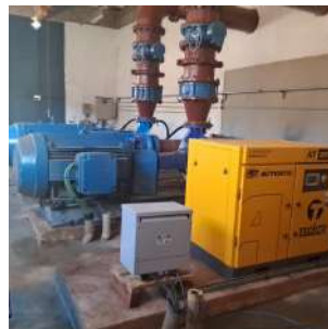
Foto 19 - Compressor parafuso
