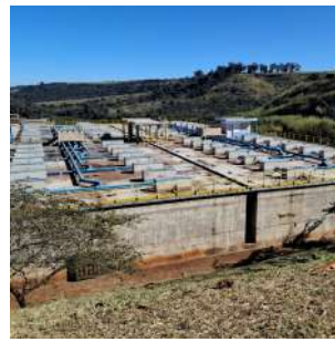
Foto 8 - UASB (Ampliação)
