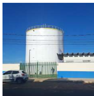
Foto 2 - Vista externa do portão de acesso e reservatório apoiado Cedrinho
