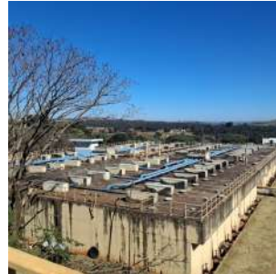
Foto 9 - Vista superior dos UASBs
