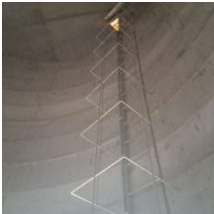
Foto 3 - Escada com guarda-corpo no interior do reservatório elevado Cedrinho
