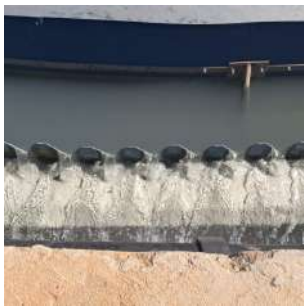
Foto 16 - Saída do flutador (ampliação)
