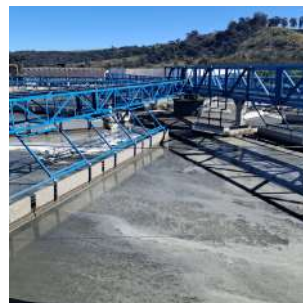
Foto 15 - Flotador (ampliação)
