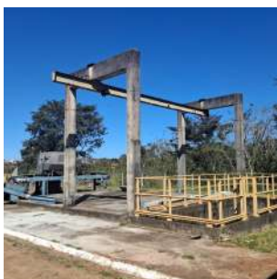
Foto 6 - Poço de sucção da EEE3 Monjolinho
