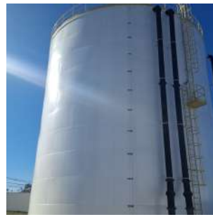
Foto 7 - Escada de acesso e guarda-corpos
