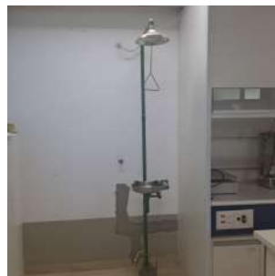
Foto 25 - Chuveiro de emergência do laboratório
