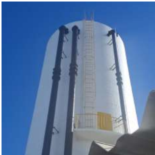
Foto 2 - Escada de acesso externa e guarda-corpos
