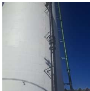
Foto 5 - Tubulação de saída para distribuição
