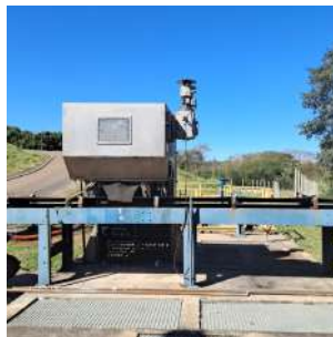
Foto 2 - Gradeamento mecanizado
