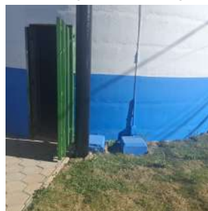
Foto 8 - Portão de acesso e base do reservatório Cedrinho elevado
