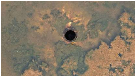
Foto 6 - Tubulação de ventilação.
