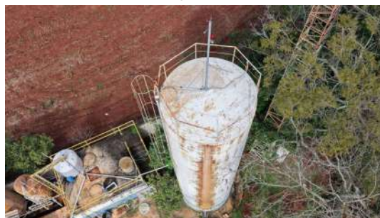
Foto 9 - Escada de acesso ao topo do reservatório e parte superior, ambas dotadas de guarda-corpo.
