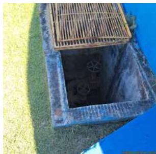
Foto 3 - Registro de gaveta para controle do fluxo de água.
