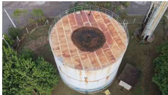
Foto 7 - Vista lateral do reservatório.
