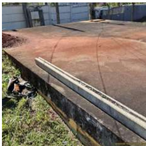
Foto 1 - Vista da parte superior do reservatório.
