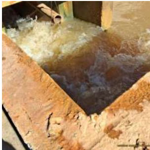
Foto 3 - Ponto de adição de produto químico.
