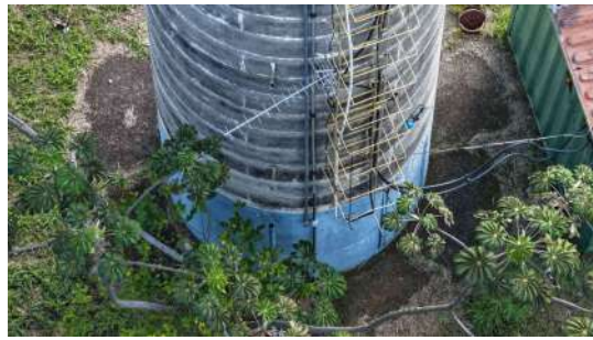
Foto 14 - Base do reservatório.
