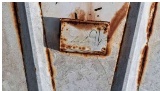
Foto 5 - Abertura de ventilação.
