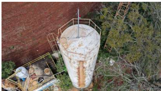
Foto 10 - Vista geral do reservatório.
