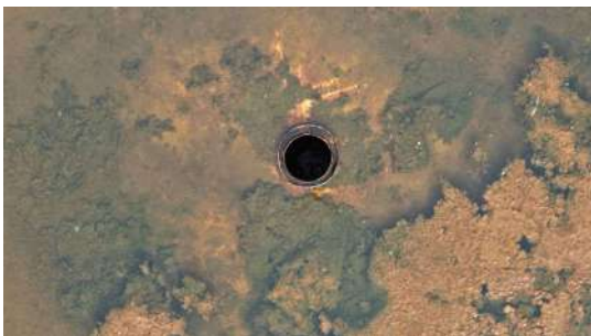
Foto 1 - Tubo de ventilação sem proteção.
