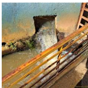
Foto 57 - Ponto de entrada no floculador (módulo 1).
