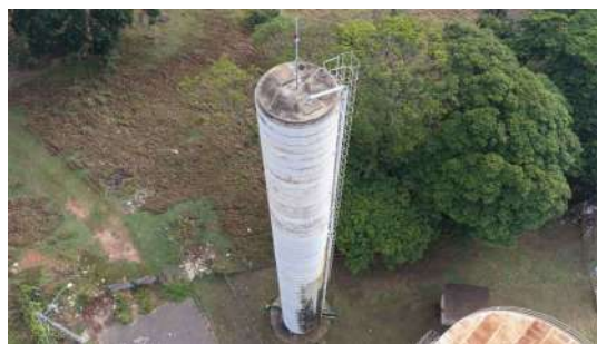
Foto 6 - Vista lateral do reservatório.
