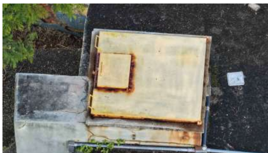
Foto 3 - Tampa de inspeção.
