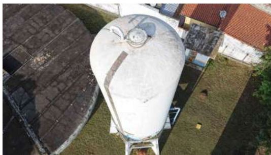
Foto 6 - Vista lateral do reservatório.
