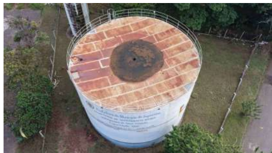
Foto 9 - Vista lateral do reservatório.
