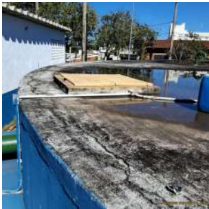
Foto 4 - Tampa de inspeção.
