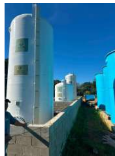
Foto 19 - Tanques de armazenamento de produtos químicos da nova ETA em fase de implantação.
