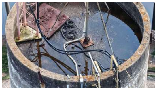
Foto 9 - Vista superior do reservatório detalhada.
