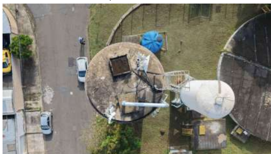
Foto 3 - Vista superior do reservatório elevado II.
