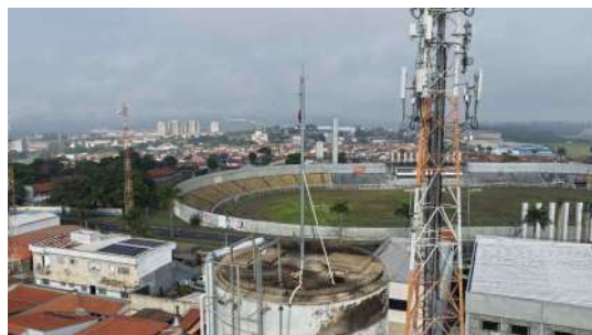
Foto 2 - Topo do reservatório sem guarda-corpo
