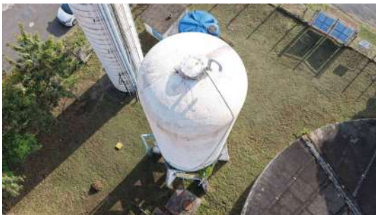
Foto 1 - Vista da parte superior do reservatório.
