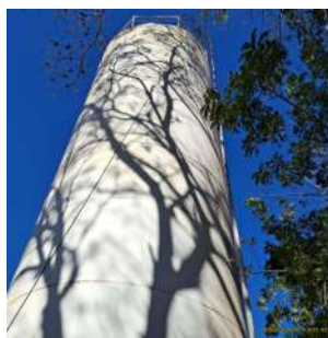
Foto 4 - Vista lateral do reservatório.
