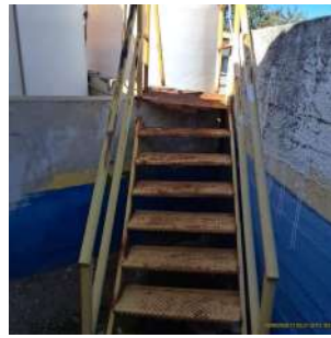
Foto 6 - Escada de acesso à parte superior do reservatório.
