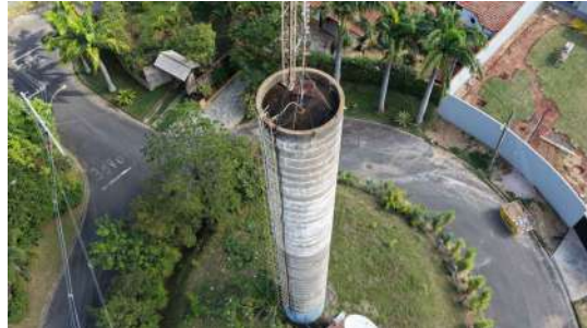
Foto 15 - Vista geral do reservatório, reservatório sem tubulação de abastecimento aparente na parte externa.
