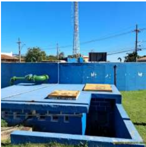
Foto 3 - Vista geral do reservatório. Ao seu lado, encontra-se a estação elevatória responsável pelo
