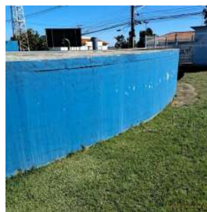
Foto 5 - Vista lateral do reservatório.
