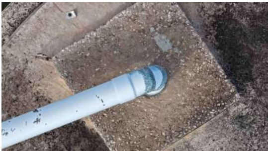
Foto 2 - Tubulação de abastecimento.
