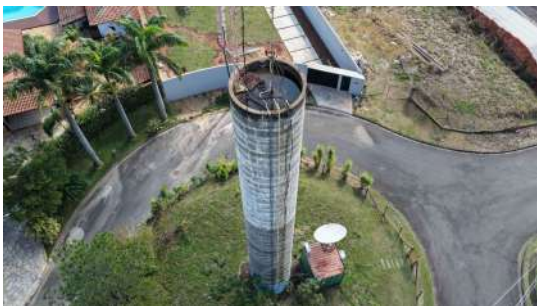
Foto 8 - Vista lateral do reservatório, com destaque para a escada de acesso ao topo do reservatório.
