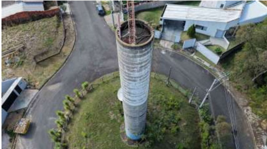
Foto 6 - Vista lateral do reservatório.
