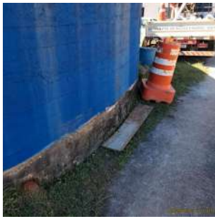
Foto 5 - Vista lateral do reservatório.
