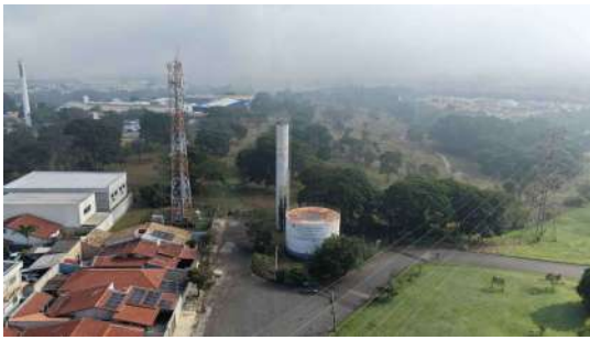
Foto 1 - Vista do entorno dos reservatórios, destacando a localização no município.
