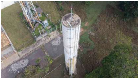
Foto 4 - Vista geral do reservatório.
