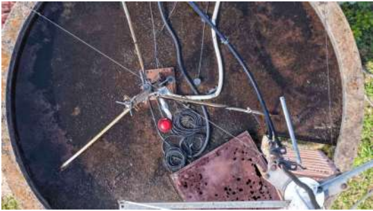
Foto 3 - Vista superior do reservatório detalhada.
