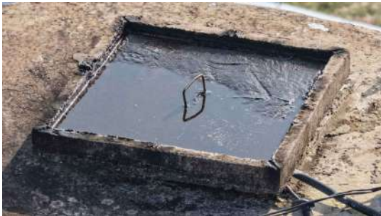
Foto 12 - Tampa de inspeção.
