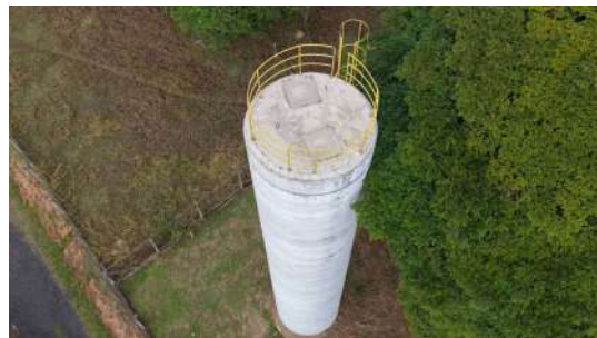
Foto 9 - Vista lateral do reservatório.
