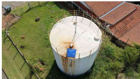
Foto 7 - Vista lateral do reservatório, com destaque para a tubulação de abastecimento.
