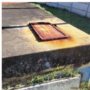
Foto 5 - Tampa de inspeção.
