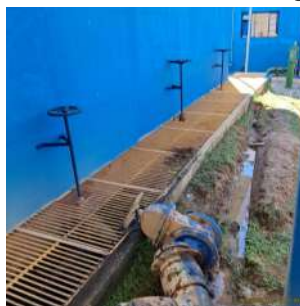
Foto 76 - Registros para controle e direcionamento do fluxo de água.
