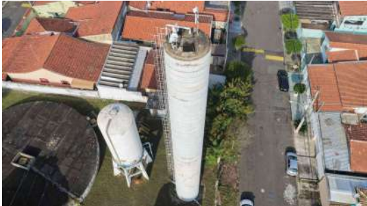
Foto 10 - Vista lateral do reservatório elevado II.
