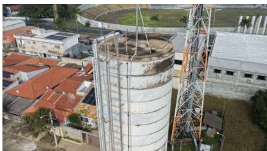
Foto 12 - Topo do reservatório.
