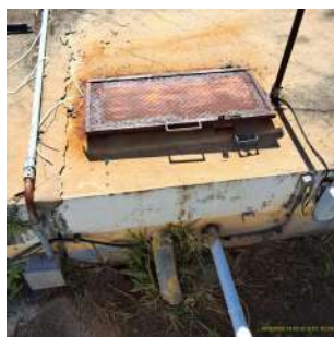
Foto 3 - Tampa de inspeção.
