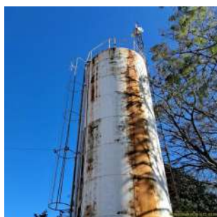
Foto 1 - Vista geral do reservatório.
