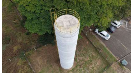
Foto 6 - Vista geral do reservatório, evidenciando o cercamento da área onde se encontra instalado.
