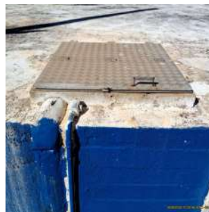
Foto 2 - Tampa de inspeção.
