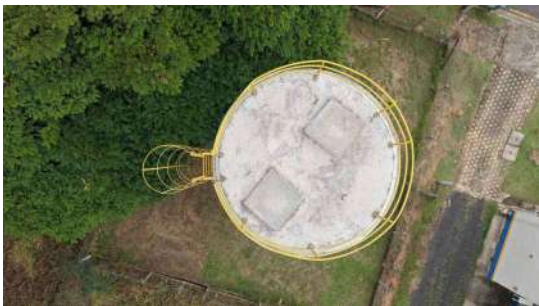
Foto 2 - Topo do reservatório.
