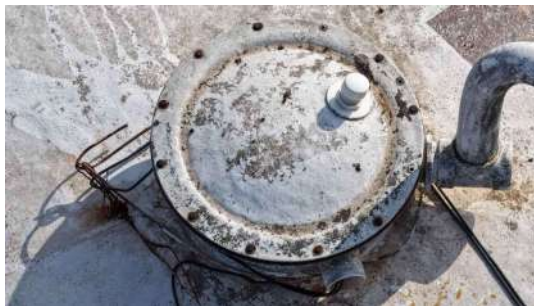
Foto 2 - Tampa de inspeção.
