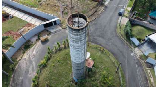
Foto 7 - Vista lateral do reservatório.
