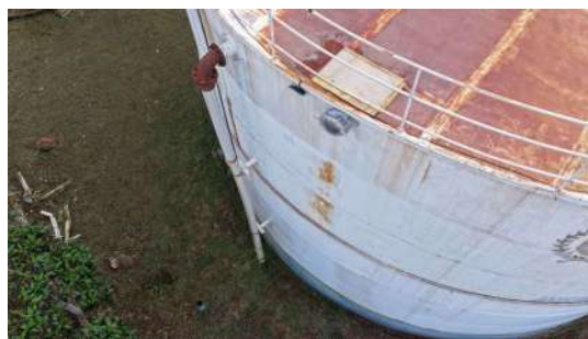
Foto 11 - Tubo extravasor e ponto de abastecimento de água.
