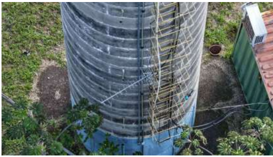
Foto 13 - Vista detalhada da estrutura do reservatório.
