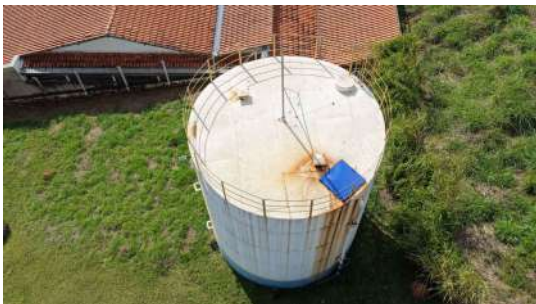
Foto 6 - Vista lateral do reservatório.
