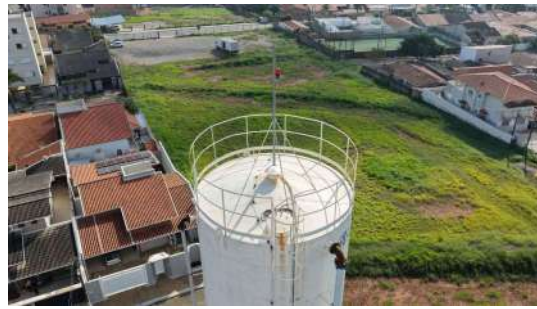
Foto 19 - Topo do reservatório.
