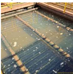
Foto 5 - Elevada quantidade de flocos em suspensão e tubulação coletora da água decantada parcialmente submersa nos módulos 2 e 3.
