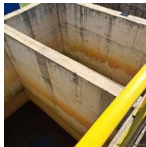
Foto 29 - Decantador (módulo 6).
