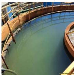
Foto 59 - Decantador (módulo 1).
