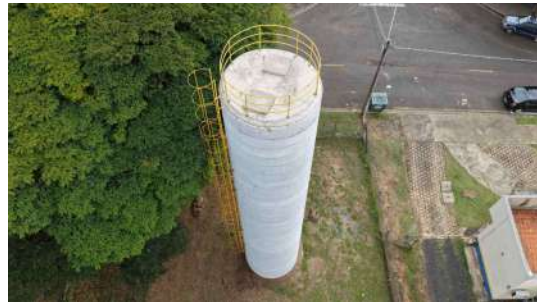
Foto 7 - Vista lateral do reservatório, destacando a escada de acesso ao topo equipada com guarda-corpo.
