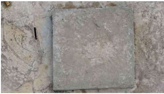
Foto 3 - Tampas de inspeção existentes no reservatório (duas unidades).
