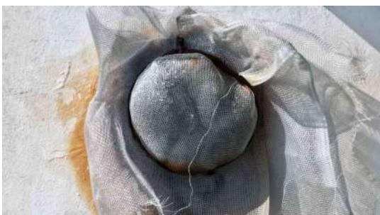
Foto 18 - Tela de proteção instalada no tubo extravasor.
