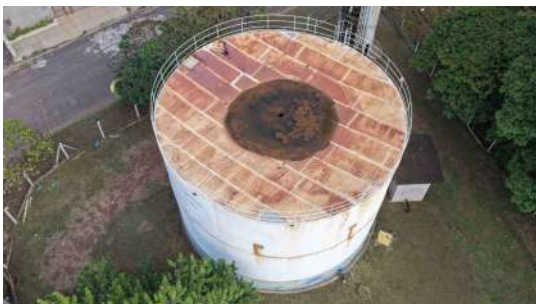
Foto 8 - Vista lateral do reservatório.
