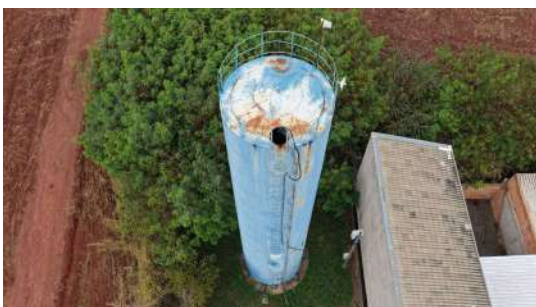
Foto 4 - Vista lateral do reservatório.
