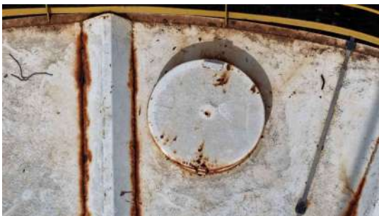
Foto 4 - Tampa de inspeção.
