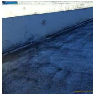
Foto 2 - Abertura de ventilação.
