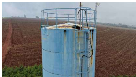
Foto 9 - Topo do reservatório.
