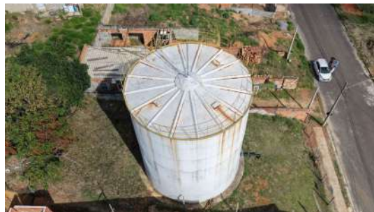
Foto 7 - Vista lateral do reservatório.
