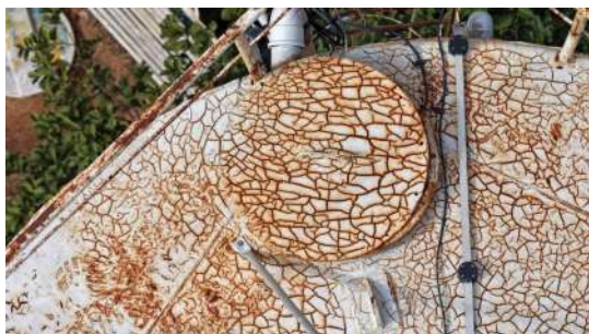
Foto 8 - Tampa de inspeção.
