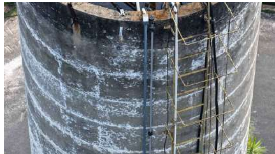
Foto 10 - Vista detalhada da estrutura do reservatório.
