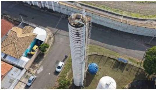
Foto 8 - Vista lateral do reservatório elevado II.
