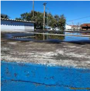
Foto 1 - Vista da parte superior do reservatório.
