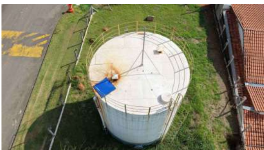
Foto 8 - Vista lateral do reservatório.
