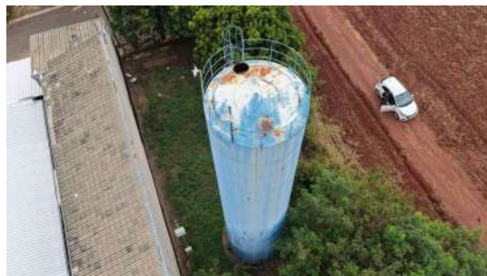
Foto 7 - Vista lateral do reservatório.
