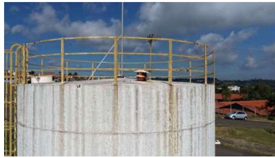
Foto 11 - Topo do reservatório.
