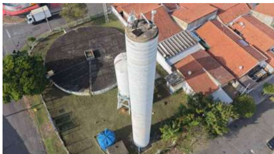
Foto 6 - Vista geral do reservatório elevado II.
