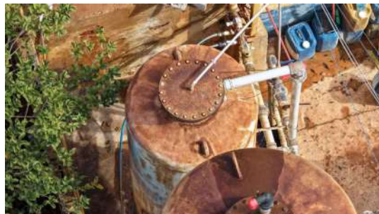
Foto 15 - Vista do topo do filtro.
