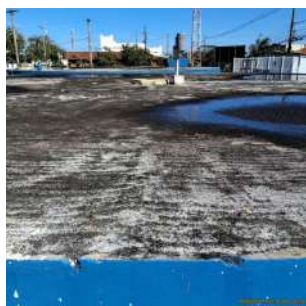
Foto 1 - Vista da parte superior do reservatório, com destaque para tampa de inspeção ao centro.
