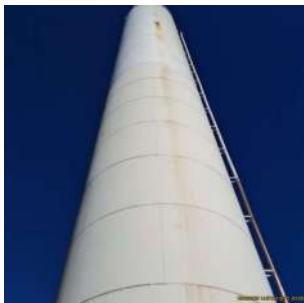
Foto 11 - Vista lateral do reservatório.
