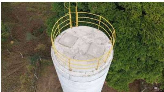
Foto 10 - Topo do reservatório, com destaque para o guarda-corpo instalado em sua parte superior.
