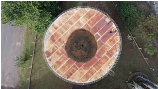
Foto 4 - Vista superior do reservatório apoiado.
