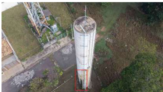
Foto 1 - Região com aparente umidade (destacada pelo retângulo vermelho).
