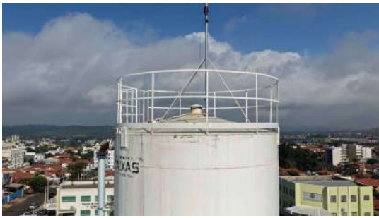
Foto 18 - Topo do reservatório, com destaque para o guarda-corpo e o para-raios do SPDA.
