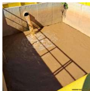
Foto 68 - O lodo gerado nos módulos da ETA é direcionado para a lagoa de decantação, onde ocorre a sedimentação dos sólidos. A água sobrenadante é posteriormente recirculada para a entrada da ETA.
