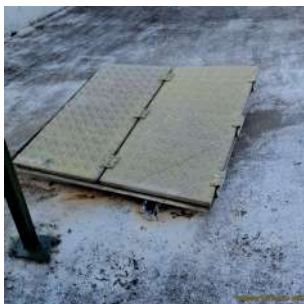
Foto 3 - Tampa de inspeção.
