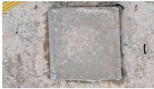
Foto 4 - Tampas de inspeção existentes no reservatório (duas unidades).
