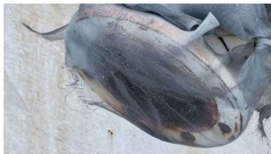
Foto 13 - Tubo extravasor com tela de proteção.
