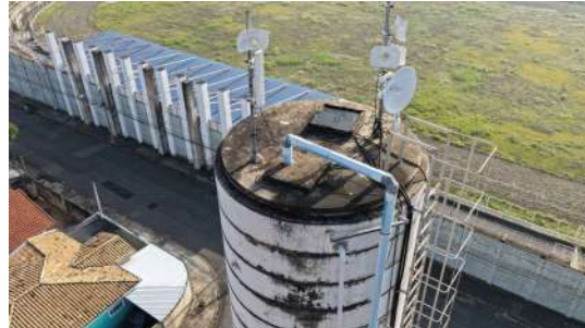
Foto 11 - Topo do reservatório, com destaque para o tubo extrusor.
