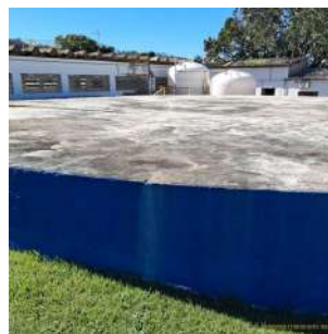
Foto 4 - Vista geral do reservatório.
