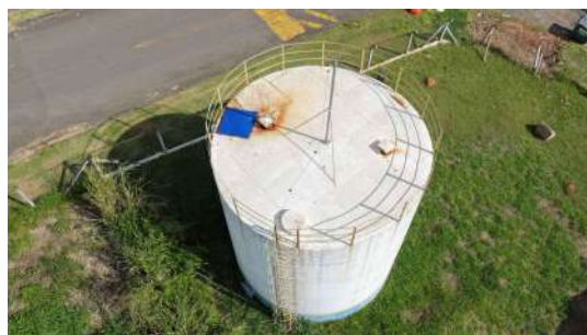
Foto 9 - Vista lateral do reservatório.
