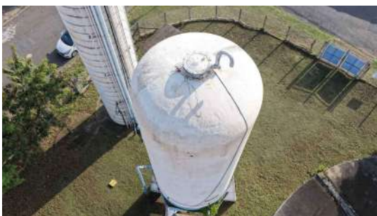
Foto 3 - Vista geral do reservatório.
