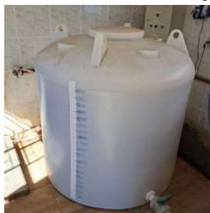
Foto 86 - Tanque de armazenamento de produto químico (hipoclorito de sódio).
