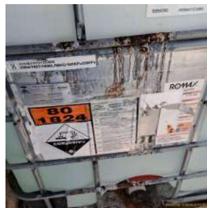
Foto 8 - Detalhe da etiqueta afixada ao tanque de hidróxido de sódio.
