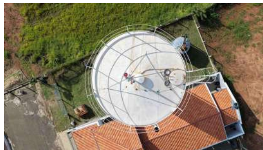
Foto 14 - Vista da parte superior do reservatório.
