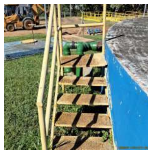
Foto 2 - Escada de acesso à parte superior do reservatório.
