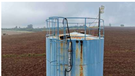
Foto 12 - Topo do reservatório, com destaque para a tubulação de abastecimento e o guarda-corpo instalado na parte superior.
