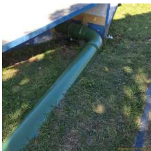
Foto 5 - Ponto de abastecimento do reservatório.
