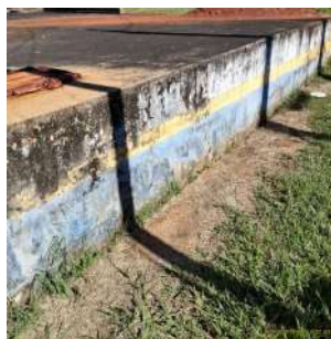
Foto 6 - Vista lateral do reservatório.
