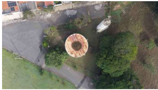
Foto 2 - Vista superior dos dois reservatórios.
