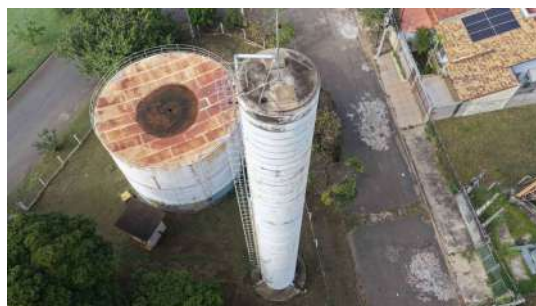
Foto 9 - Vista lateral do reservatório.
