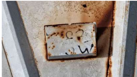
Foto 3 - Abertura de ventilação.
