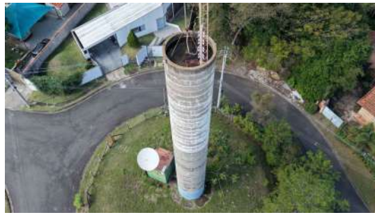
Foto 5 - Vista lateral do reservatório.
