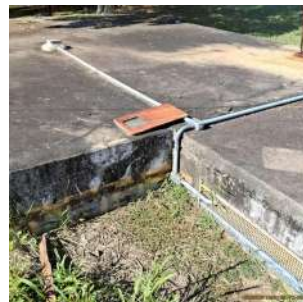
Foto 2 - Vista da parte superior do reservatório.
