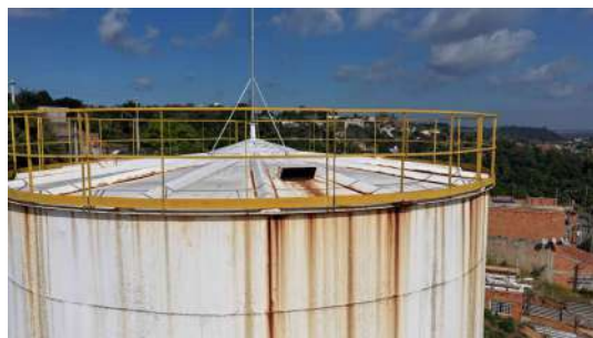
Foto 13 - Vista do topo do reservatório.
