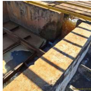
Foto 11 - Ponto de entrada no floculador (módulo 4)..
