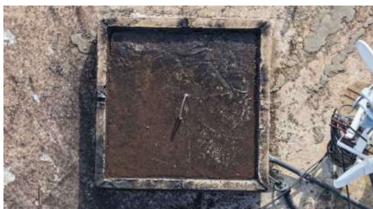
Foto 4 - Tampa de inspeção.
