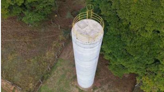
Foto 5 - Vista geral do reservatório, reservatório sem tubulação de abastecimento aparente na parte externa.
