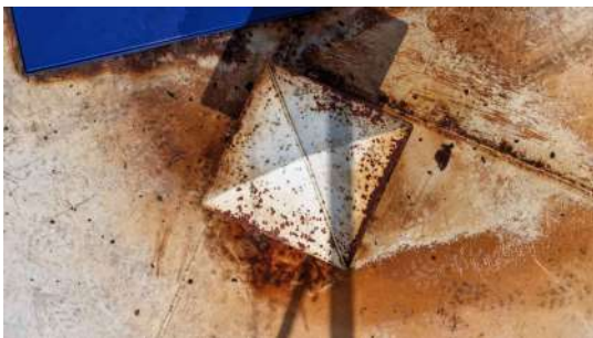
Foto 4 - Tubo de ventilação.
