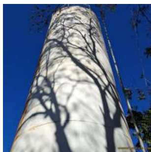
Foto 3 - Vista lateral do reservatório.
