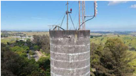
Foto 16 - Topo do reservatório.
