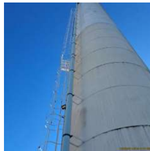
Foto 12 - Vista lateral do reservatório.
