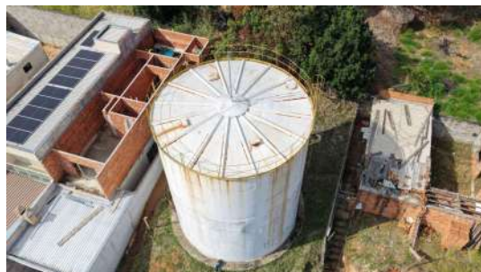
Foto 9 - Vista lateral do reservatório.
