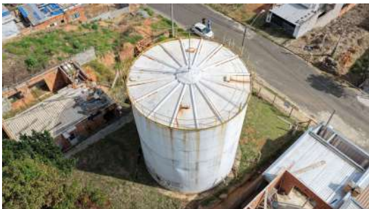
Foto 6 - Vista geral do reservatório.
