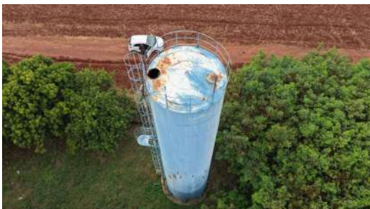
Foto 6 - Vista lateral do reservatório.
