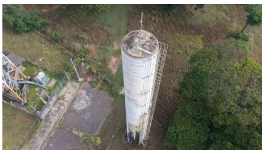
Foto 5 - Escada de acesso ao topo do reservatório, dotada de guarda-corpo.
