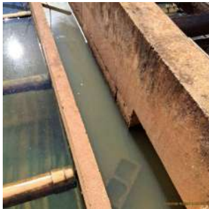
Foto 12 - Canaleta de passagem da água do floculador para o decantador (módulo 4)..
