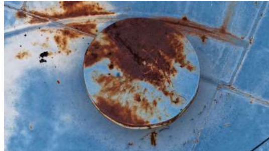
Foto 3 - Tampa de inspeção de uma das duas aberturas de inspeção do reservatório.
