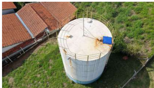
Foto 5 - Vista lateral do reservatório.
