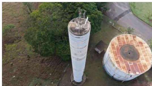
Foto 7 - Vista lateral do reservatório.
