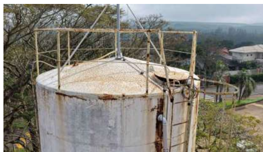
Foto 13 - Topo do reservatório, com destaque para a tubulação de abastecimento e o tubo de ventilação.
