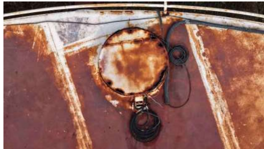
Foto 5 - Tampa de inspeção.
