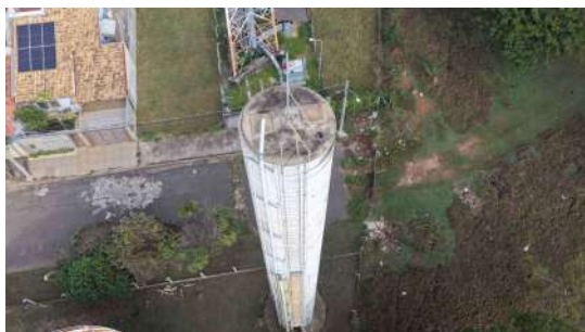
Foto 10 - Vista lateral do reservatório.
