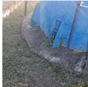
Foto 4 - Base do reservatório.
