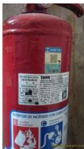
Foto 7 - Detalhe da etiqueta de controle de manutenções do extintor.
