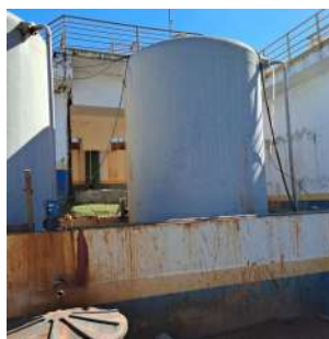
Foto 82 - Tanque de armazenamento de produto químico.
