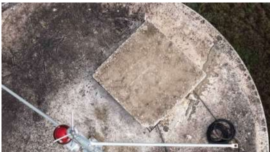
Foto 3 - Tampa de inspeção.
