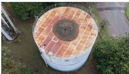
Foto 10 - Vista lateral do reservatório.
