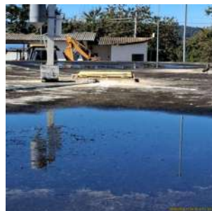
Foto 4 - Parte superior do reservatório.
