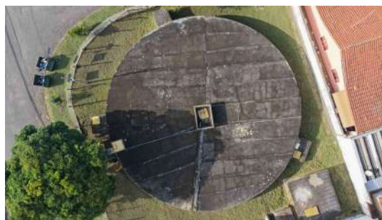
Foto 2 - Vista superior do reservatório semienterrado.
