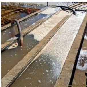
Foto 7 - Canaletas onde se inicia o processo de formação de flocos, com elevado nível de água.
