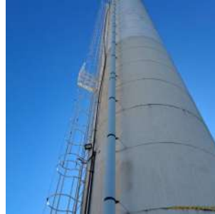
Foto 2 - Escada de acesso ao topo do reservatório e tubulação de entrada de água.
