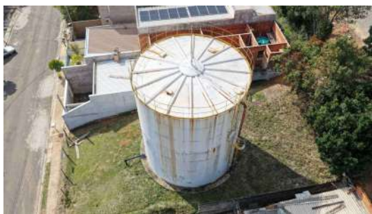
Foto 10 - Vista lateral do reservatório.
