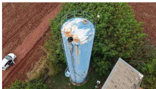
Foto 5 - Vista lateral do reservatório.
