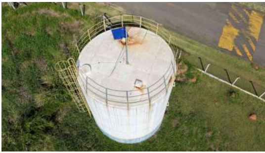
Foto 10 - Vista lateral do reservatório.
