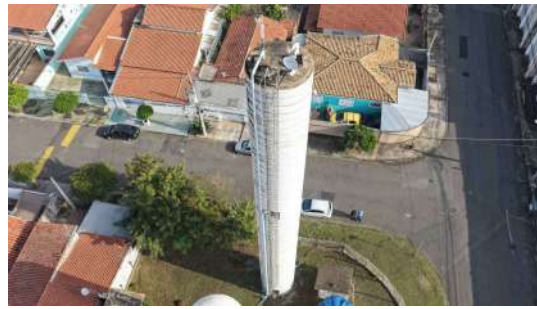
Foto 9 - Vista lateral do reservatório elevado II.
