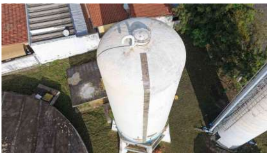
Foto 5 - Vista lateral do reservatório.
