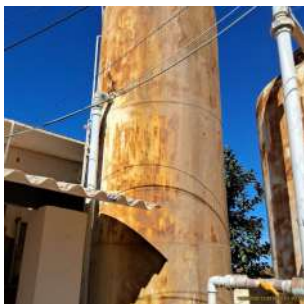
Foto 10 - Flocculador/decantador.
