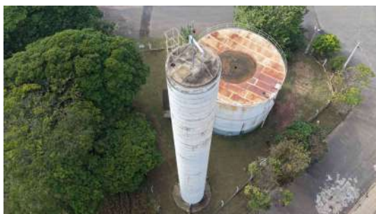
Foto 8 - Vista lateral do reservatório.
