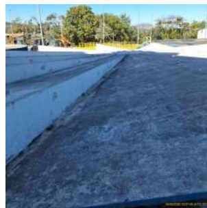
Foto 4 - Vista da parte superior do reservatório.
