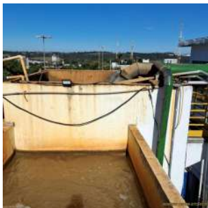
Foto 5 - Vista geral do ponto de captação.
