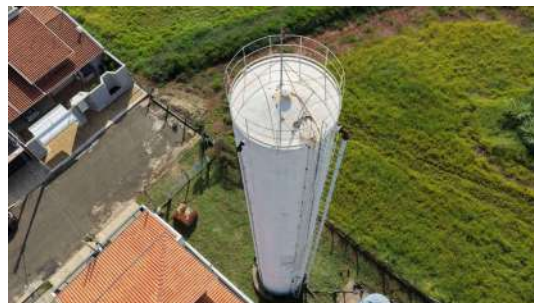
Foto 17 - Vista lateral do reservatório, com destaque para o tubo extravasor.
