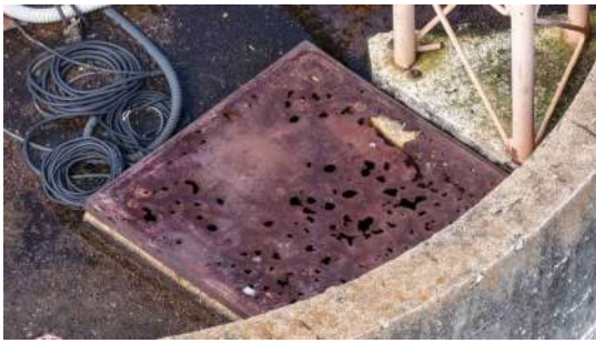
Foto 4 - Tampa de inspeção.
