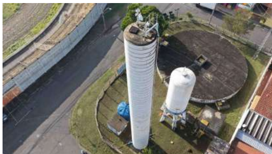
Foto 7 - Vista lateral do reservatório elevado II.
