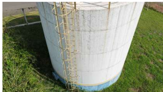
Foto 15 - Escada de acesso ao topo do reservatório, equipada com guarda-corpo.
