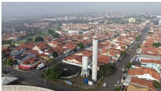
Foto 1 - Vista do entorno dos reservatórios, destacando a localização das estruturas no município.
