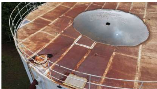
Foto 12 - Topo do reservatório, destacando guarda-corpo na parte superior.
