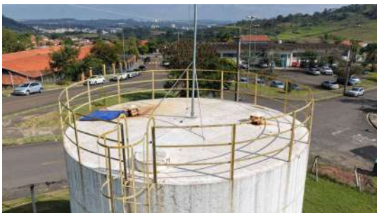
Foto 14 - Topo do reservatório, com destaque para o guarda-corpo localizado na parte superior.
