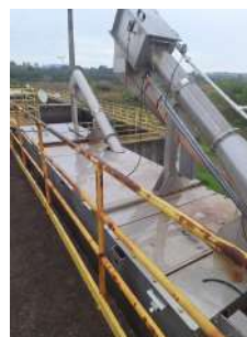
Foto 2 - Sistema de tratamento preliminar em manutenção (2)
