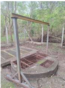
Foto 2 - Acesso para manutenção
