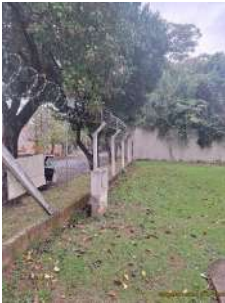
Foto 3 - Cercamento da área
