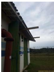
Foto 5 - Acesso para manutenção
