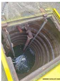
Foto 5 - Poço de sucção
