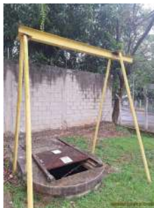
Foto 3 - Acesso para manutenção
