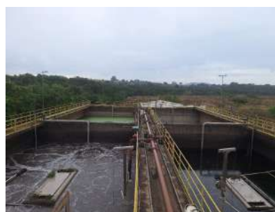
Foto 2 - Visão superior - tanques de aeração
