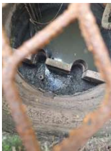
Foto 1 - Poço de sucção - chegada do esgoto sem gradeamento
