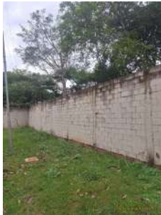
Foto 4 - Cercamento de área com muro de alvenaria
