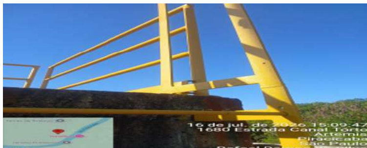
Foto 3 - Melhoria de acesso ao tratamento preliminar - evidência do prestador
