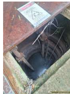
Foto 4 - Poço de sucção
