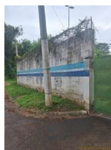
Foto 2 - Cercamento - muro de alvenaria
