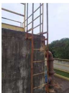
Foto 1 - Acesso ao tratamento preliminar
