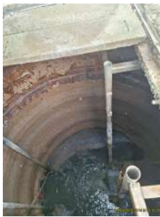
Foto 1 - Gradeamento retirado para manutenção
