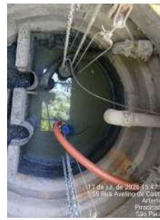
Foto 2 - Segundo conjunto instalado antes da emissão do envio do relatório de fiscalização.
