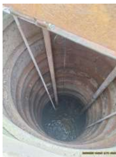
Foto 3 - Poço de sucção
