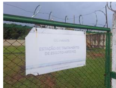
Foto 12 - Identificação da ETE
