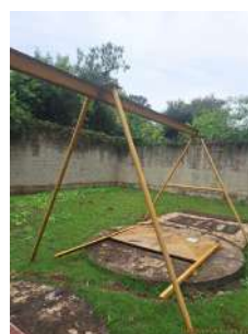
Foto 7 - Acesso para manutenção
