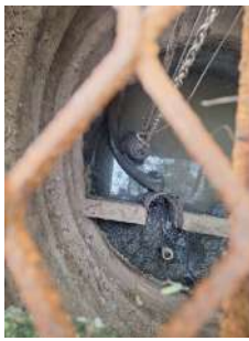
Foto 3 - Poço de sucção
