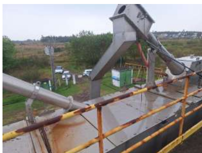
Foto 1 - Sistema de tratamento preliminar em manutenção
