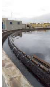
Foto 13 - Consertar defletor no decantador secundário 1.
