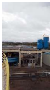
Foto 124 - Vista superior do sistema de tratamento de lodo.
