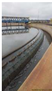
Foto 54 - Vista do decantador primário 4.
