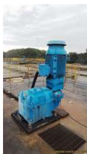
Foto 41 - Motor de agitação do carrossel 2.
