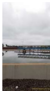
Foto 53 - Vista do decantador primário 4.
