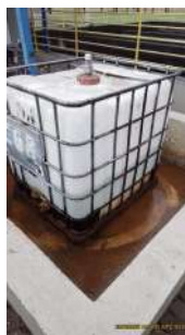
Foto 6 - Drenar líquido acumulado na bacia de retenção do hipoclorito.
