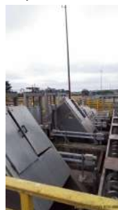
Foto 42 - Peneiras finas e rosca de transporte de material sólido removido.
