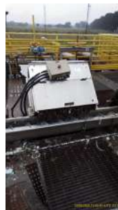
Foto 29 - Rosca de remoção de resíduos do gradeamento.
