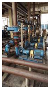
Foto 128 - Injetora de lodo quente.
