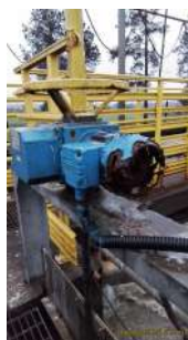
Foto 2 - Realizar a recuperação dos motores e comportas do tratamento preliminar.
