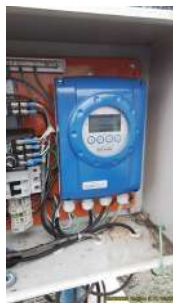
Foto 23 - Medidor de vazão após preliminar (momento 2).
