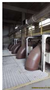
Foto 34 - Cinco bombas nomeadas de A ate E da frente pro fundo. Funcionam de 3 a 4 bombas por vez.
