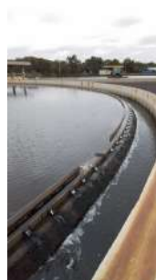
Foto 8 - Consertar defletor no decantador secundário 6.
