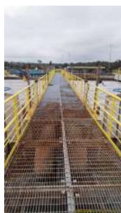
Foto 65 - Passarela reator aeróbio 2 e 3.
