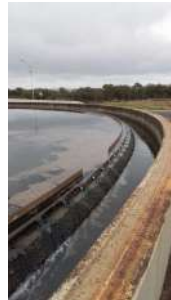
Foto 10 - Consertar defletor no decantador secundário 3.
