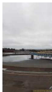
Foto 47 - Vista do decantador primário 1.
