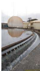
Foto 56 - Vista do decantador primário 1.
