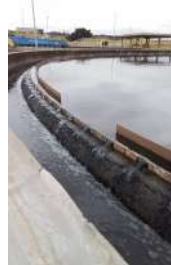
Foto 12 - Consertar defletor no decantador secundário 2.
