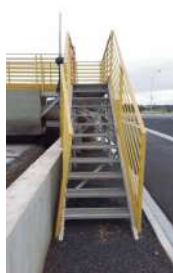
Foto 3 - Corrimão solto no reator aeróbio 6.
