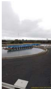
Foto 77 - Decantadores secundários 5 e 6.
