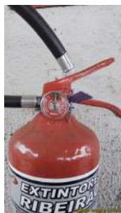
Foto 7 - Pressurização do extintor das centrífugas.
