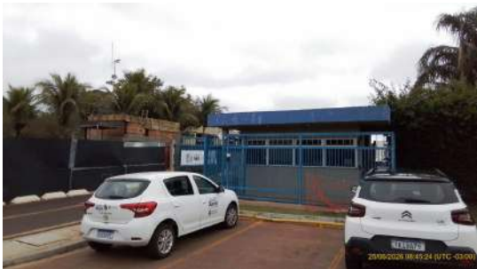
Foto 1 - Guaita de acesso à ETE.
