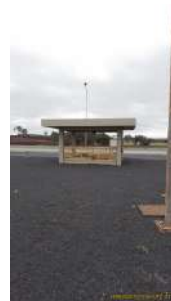
Foto 89 - EEE dos decantadores secundários 3 e 4.
