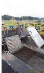
Foto 27 - Duas grades automáticas e uma reserva manual.
