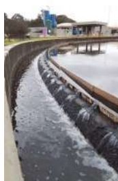
Foto 11 - Consertar defletor no decantador secundário 2.
