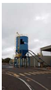
Foto 105 - Silo de lodo desidratado em reforma.
