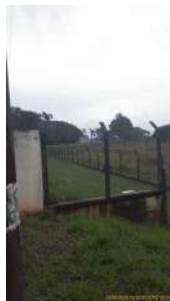
Foto 74 - Cercamento da área.
