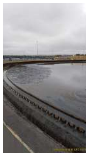
Foto 52 - Vista do decantador primário 2.
