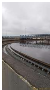
Foto 55 - Vista do decantador primário 1.
