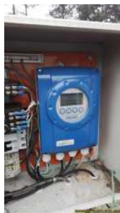
Foto 22 - Medidor de vazão após preliminar (momento 1).
