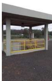
Foto 94 - EEE sobrenadantes dos decantadores 3 e 4.
