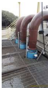
Foto 54 - Recirculação de lodo com três bombas sendo um reserva. Na ampliação terá a quarta linha.
