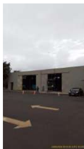
Foto 27 - Acesso à EEE de chegada.
