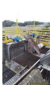
Foto 28 - Comportas pós gradeamento.
