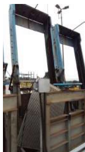
Foto 3 - Consertar grade automática no tratamento preliminar.
