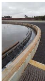
Foto 7 - Consertar defletor no decantador secundário 5.
