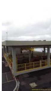
Foto 78 - EEE dos decantadores secundários 4, 5 e 6.
