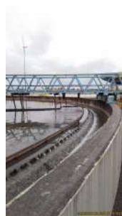
Foto 57 - Vista do decantador primário 3.
