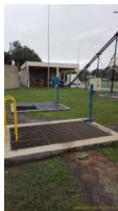
Foto 24 - Medidor de vazão após preliminar.
