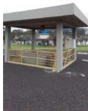
Foto 98 - EEE sobrenadantes dos decantadores 1 e 2
