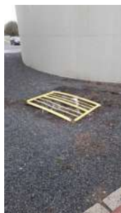
Foto 115 - Guarda-corpo substituído dos adensadores.
