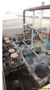
Foto 59 - EEE de descarte de lodo primario para o adensador. Três bombas sendo 1 reserva.
