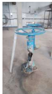
Foto 2 - Consertar as válvulas de comporta das células das bombas da EEE de chegada.
