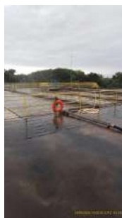
Foto 43 - Carrossel 1 e 2 de lodos ativados por aeração prolonga.
