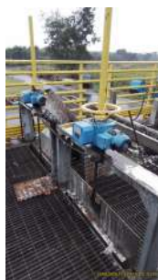
Foto 1 - Realizar a recuperação dos motores e comportas do tratamento preliminar.
