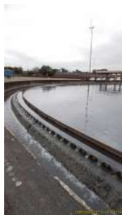
Foto 58 - Vista do decantador primário 3.
