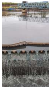
Foto 5 - Consertar defletor no decantador primário
