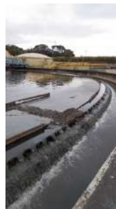
Foto 6 - Consertar defletor no decantador primário
