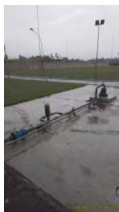
Foto 68 - Poço de abastecimento da ETE.
