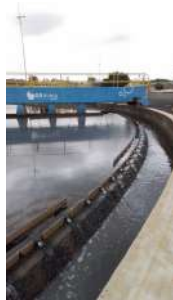
Foto 9 - Consertar defletor no decantador secundário 4.
