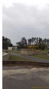
Foto 48 - Vista do decantador secundário 2.
