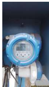
Foto 49 - Mostrador de vazão (momento 1).
