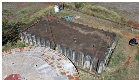
Foto 15 - Tubulações de respiro (imagem de drone de 08/06/2026).
