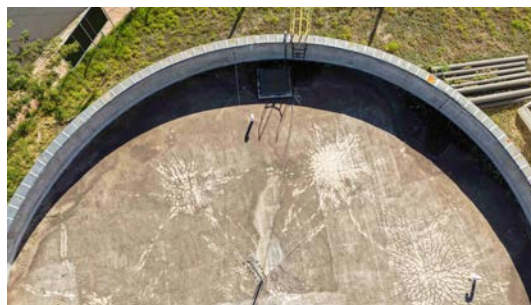
Foto 12 - Tampa de inspeção (imagem de drone de 08/06/2026).
