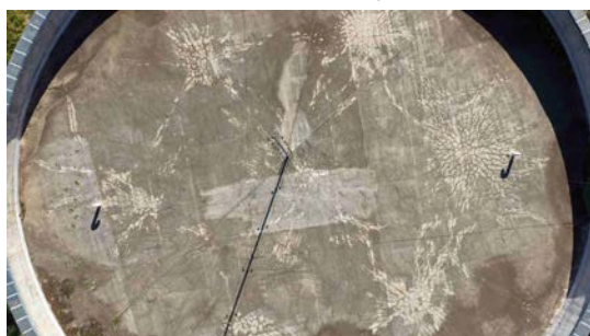
Foto 13 - Para-raio e tubulações de ventilação (imagem de drone de 08/06/2026).
