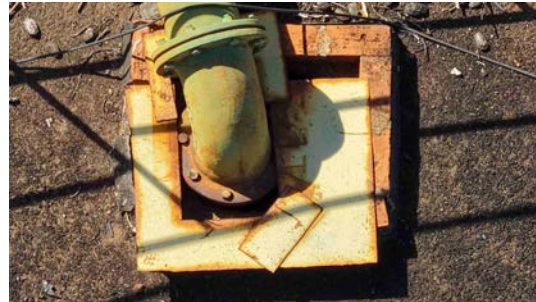
Foto 14 - Tampa de inspeção (imagem de drone de 08/06/2026).
