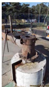
Foto 6 - Vista do poço com sistema de recalque desmontado.
