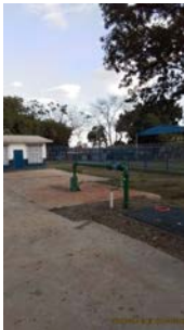
Foto 2 - Vista geral do poço.
