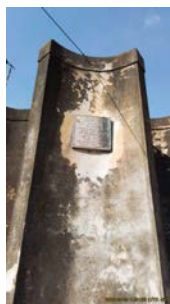
Foto 4 - Placa de obra do reservatório.
