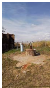
Foto 3 - Vista geral do poço.
