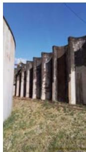
Foto 8 - Vista geral do reservatório.
