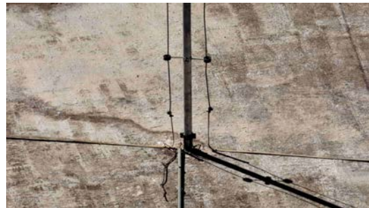
Foto 18 - Cabeamento do SPDA (imagem de drone de 08/06/2026).
