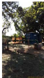
Foto 8 - Vista geral do poço.
