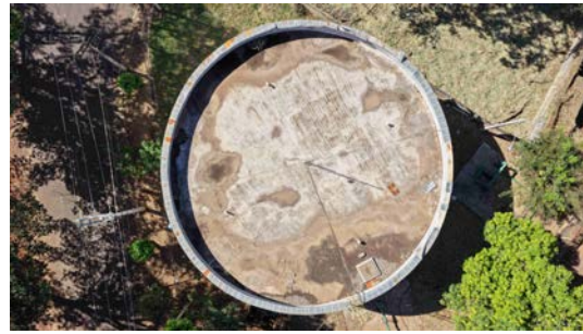
Foto 2 - Vista superior do reservatório (imagem de drone de 08/06/2026).
