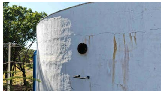
Foto 16 - Acesso de tubulação fechado (imagem de drone de 08/06/2026).
