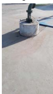
Foto 3 - Laje de proteção do poço.
