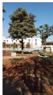
Foto 5 - Vista geral do poço.
