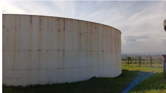
Foto 12 - Vista geral do reservatório.
