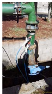
Foto 11 - Dosagem dos produtos químicos.
