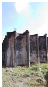
Foto 11 - Vista geral do reservatório.
