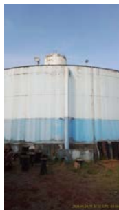
Foto 1 - Vista geral do reservatório.
