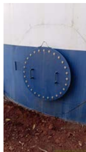
Foto 6 - Tampa de inspeção no costado do reservatório.
