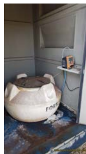
Foto 16 - Armazenamento de flúor.
