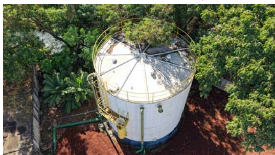
Foto 13 - Vista superior do reservatório (imagem de drone de 08/06/2026).
