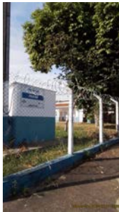
Foto 1 - Placa de identificação e cercamento da área.
