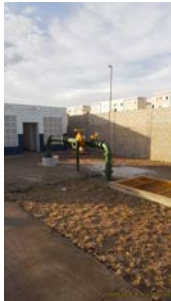
Foto 3 - Vista geral da captação.
