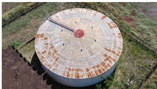
Foto 27 - Vista superior do reservatório (imagem de drone de 08/06/2026).
