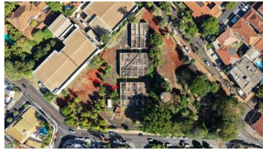
Foto 2 - Reservatório identificado pela seta (imagem de drone de 08/06/2026)..
