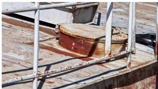
Foto 31 - Tampa de inspeção (imagem de drone de 08/06/2026).
