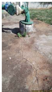
Foto 3 - Laje do poço.
