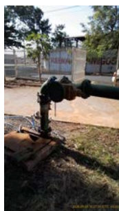
Foto 7 - Vista do acesso ao poço.
