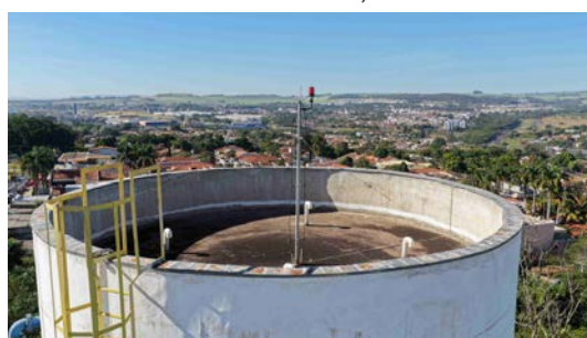
Foto 18 - Guarda-corpo e para-raio (imagem de drone de 08/06/2026)
