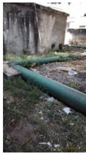
Foto 17 - Tubulação de sucção.
