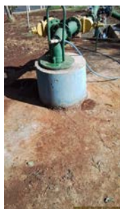
Foto 6 - Laje de proteção.
