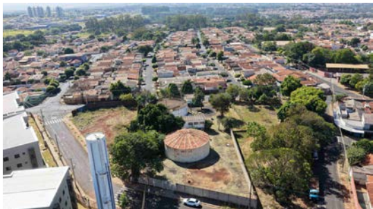
Foto 1 - Vista geral dos reservatórios (imagem de drone de 08/06/2026).
