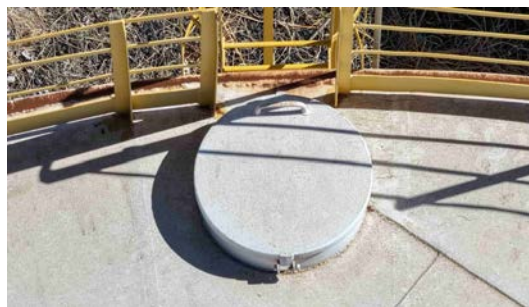
Foto 12 - Tampa de inspeção (imagem de drone de 08/06/2026).
