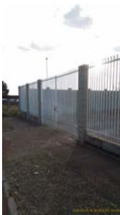
Foto 2 - Cercamento da área.
