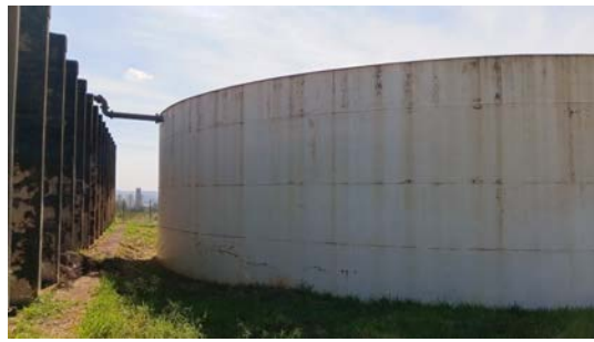
Foto 11 - Vista geral do reservatório.
