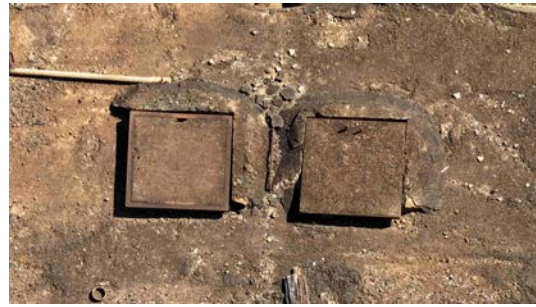
Foto 21 - Tampas de inspeção (imagem de drone de 08/06/2026).
