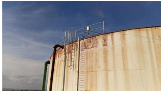
Foto 3 - Escada e guarda corpo existentes na estrutura.
