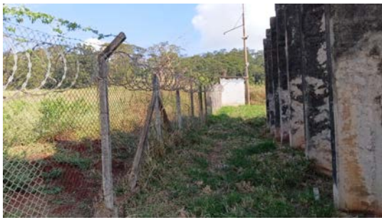
Foto 10 - Vista geral da área interna da unidade, evidenciando cercamento com alambrado.
