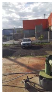
Foto 22 - Cercamento da área.
