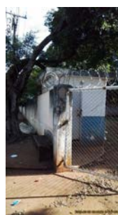
Foto 2 - Vista do cercamento e acesso ao local.
