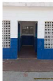
Foto 10 - Abrigo do sistema de dosagem química.
