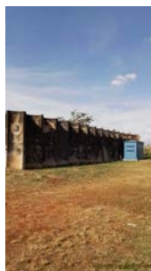
Foto 2 - Vista geral do reservatório.
