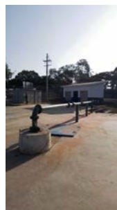
Foto 2 - Vista geral da captação.
