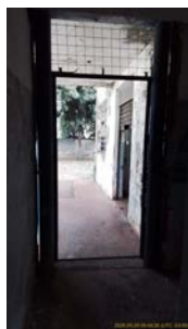
Foto 17 - Vista interna do abrigo de dosagem química.
