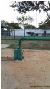
Foto 3 - Vista geral do poço.
