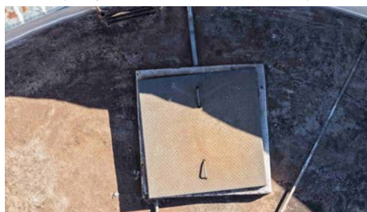
Foto 14 - Tampa de inspeção (imagem de drone de 08/06/2026).
