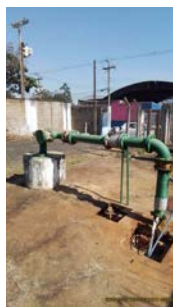
Foto 9 - Vista geral do poço.
