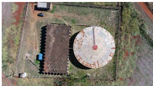
Foto 21 - Vista superior do reservatório (imagem de drone de 08/06/2026).
