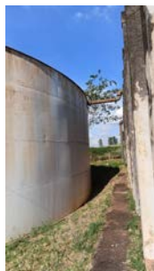
Foto 8 - Vista geral do reservatório.
