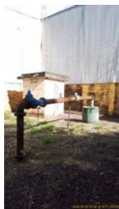
Foto 9 - Vista geral do poço.
