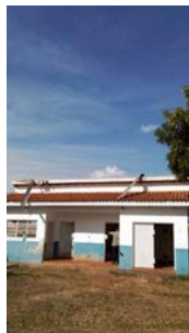
Foto 1 - Consertar calha do telhado.
