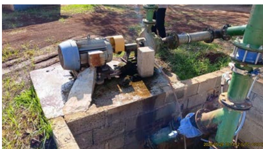
Foto 5 - Vista geral da EEA.
