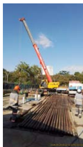
Foto 3 - Tubulação interna de recalque do poço retirada para manutenção.
