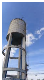
Foto 4 - Vista geral do reservatório.
