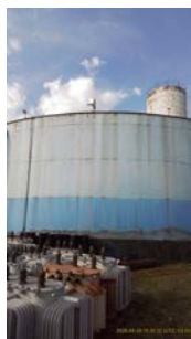
Foto 3 - Vista geral do reservatório.
