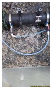
Foto 10 - Dosagem dos produtos químicos.
