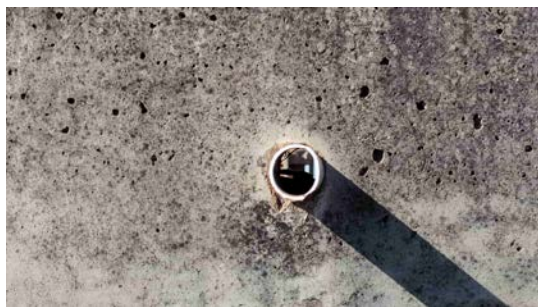
Foto 12 - Dreno da laje.
