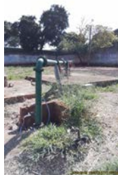
Foto 9 - Vista geral do poço.
