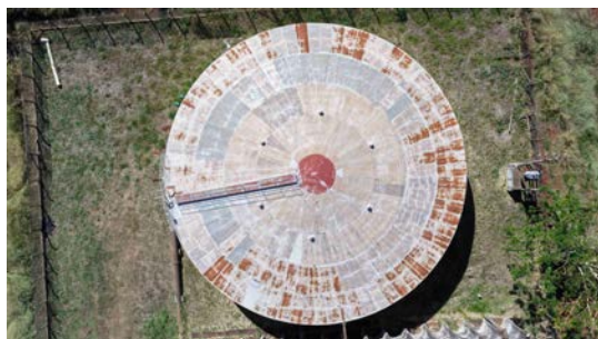
Foto 23 - Vista superior do reservatório (imagem de drone de 08/06/2026).
