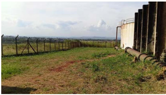
Foto 1 - Vista geral da área interna da unidade, evidenciando cercamento com alambrado.
