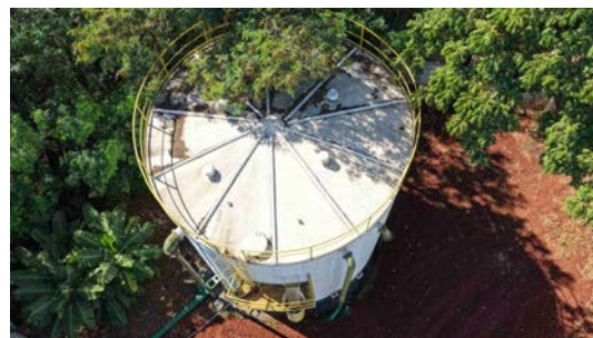
Foto 16 - Vista superior do reservatório (imagem de drone de 08/06/2026).
