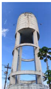
Foto 13 - Vista geral do reservatório.
