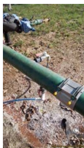
Foto 8 - Dosagem dos produtos químicos.
