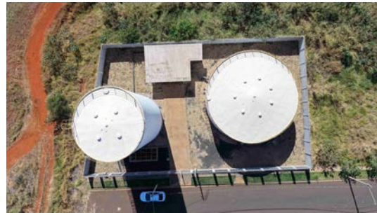
Foto 2 - Vista superior dos reservatórios (imagem de drone de 08/06/2026).
