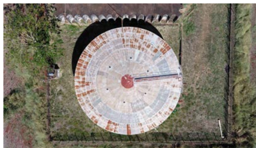
Foto 22 - Vista superior do reservatório (imagem de drone de 08/06/2026).
