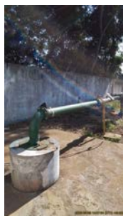
Foto 3 - Vista geral do poço.
