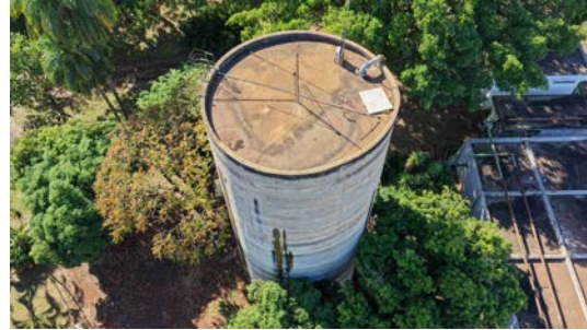
Foto 6 - Vista superior do reservatório (imagem de drone de 08/06/2026).
