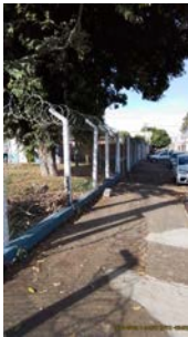
Foto 2 - Cercamento da área.
