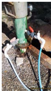
Foto 9 - Dosagem dos produtos químicos.
