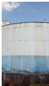
Foto 11 - Vista geral do reservatório.
