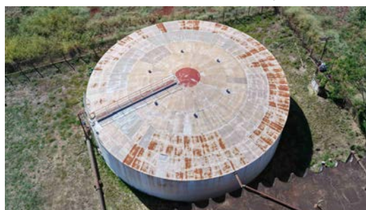
Foto 26 - Vista superior do reservatório (imagem de drone de 08/06/2026).
