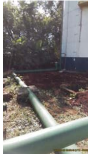
Foto 19 - Tubulação de sucção.
