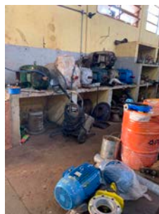
Foto 6 - Estoque de motores.
