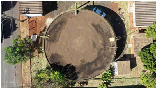
Foto 3 - Vista superior do reservatório (imagem de drone de 08/06/2026).
