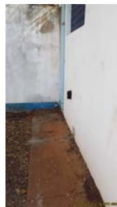
Foto 20 - Sistema de alarme contra furtos.
