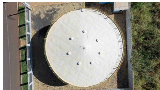
Foto 10 - Vista superior do reservatório (imagem de drone de 08/06/2026).
