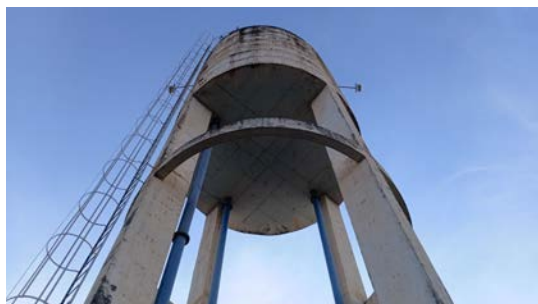
Foto 7 - Vista geral do reservatório, escadas e guarda corpos à esquerda.
