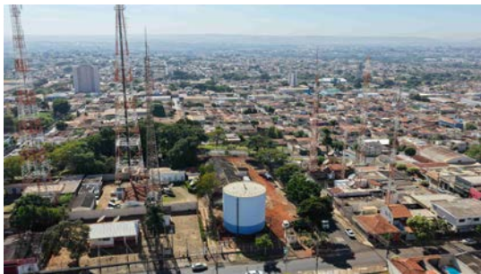
Foto 1 - Vista geral dos reservatórios (imagem de drone de 08/06/2026).
