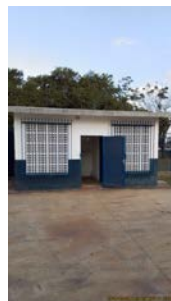
Foto 11 - Abrigo do sistema de dosagem química.
