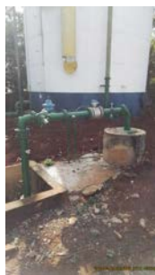
Foto 5 - Vista geral do poço.
