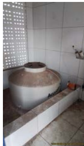
Foto 12 - Armazenamento de cloro.
