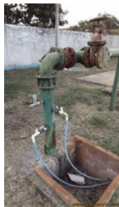
Foto 7 - Dosagem dos produtos químicos.
