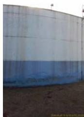
Foto 7 - Vista geral do reservatório.
