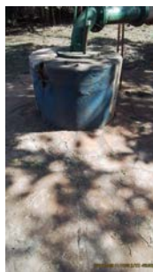
Foto 3 - Laje do poço.
