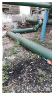
Foto 16 - Tubulação de sucção.
