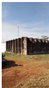
Foto 1 - Vista geral do reservatório.
