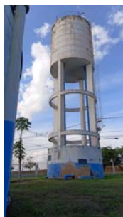
Foto 3 - Vista geral do reservatório.
