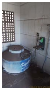
Foto 21 - Armazenamento de flúor.
