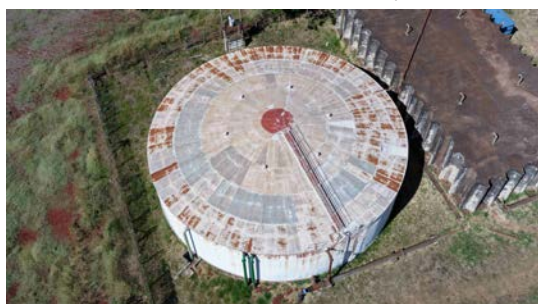
Foto 25 - Vista superior do reservatório (imagem de drone de 08/06/2026).
