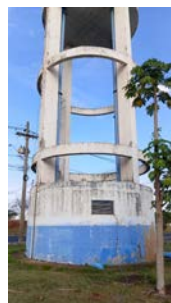
Foto 14 - Vista geral do reservatório.
