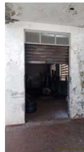
Foto 2 - Acesso à EEA.
