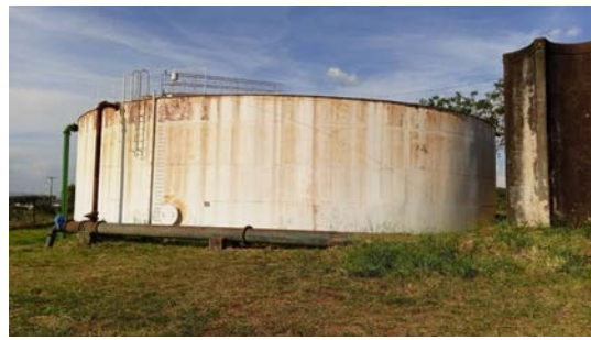
Foto 2 - Vista geral do reservatório.
