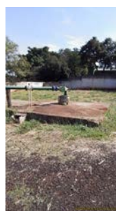
Foto 2 - Vista geral do poço.
