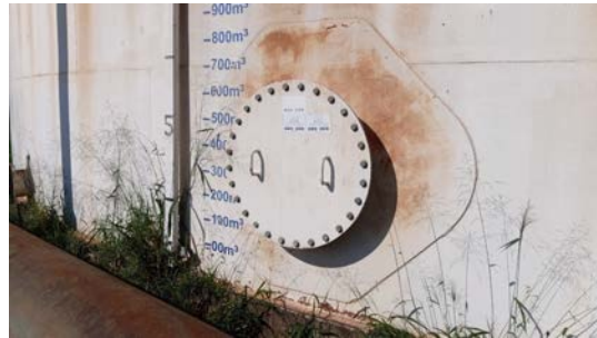
Foto 5 - Tampa de inspeção instalada no costado.
