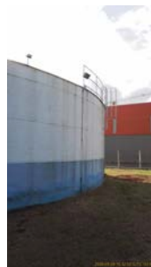
Foto 8 - Vista geral do reservatório.
