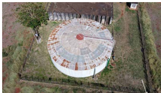
Foto 24 - Vista superior do reservatório (imagem de drone de 08/06/2026).
