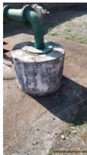
Foto 3 - Laje de proteção.
