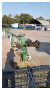
Foto 7 - Vista geral da captação.
