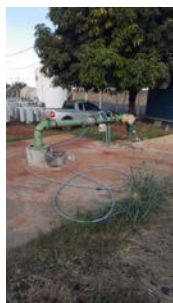
Foto 15 - Vista geral do poço.
