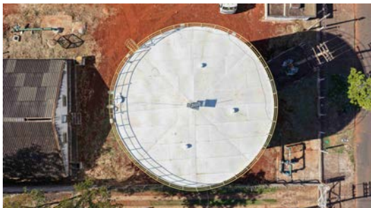
Foto 3 - Vista superior do reservatório (imagem de drone de 08/06/2026).
