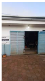
Foto 3 - Acesso ao painel de energia do poço.
