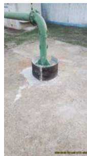
Foto 4 - Laje de proteção.
