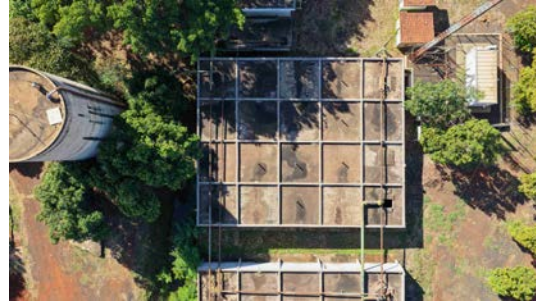
Foto 4 - Vista superior do reservatório (imagem de drone de 08/06/2026).
