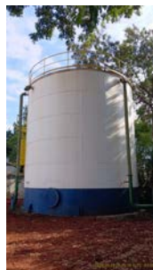
Foto 4 - Vista geral do reservatório.
