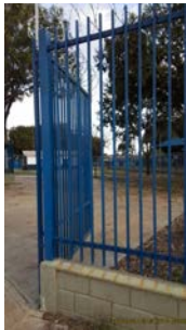
Foto 1 - Vista externa, acesso e cercamento da área.
