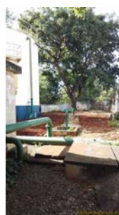
Foto 4 - Vista geral do poço.
