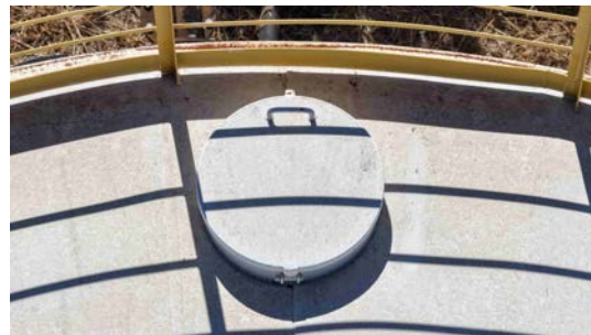
Foto 4 - Tampa de inspeção (imagem de drone de 08/06/2026).
