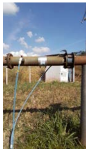
Foto 7 - Dosagem dos produtos químicos.
