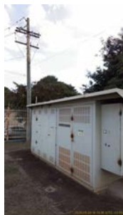
Foto 9 - Transformador 500kva.
