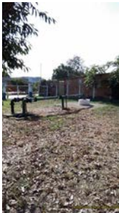
Foto 3 - Vista geral do poço.
