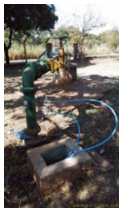
Foto 7 - Dosagem dos produtos químicos.
