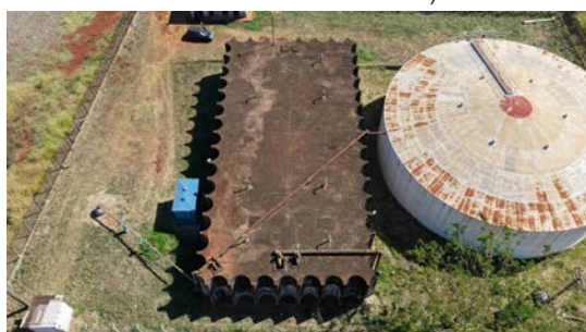
Foto 18 - Vista superior do reservatório (imagem de drone de 08/06/2026).
