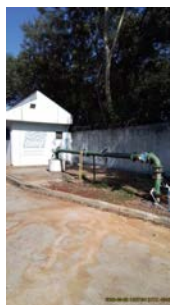
Foto 2 - Vista geral do poço.
