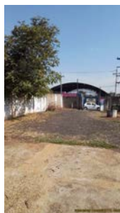
Foto 12 - Cercamento e acesso ao poço.
