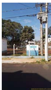
Foto 1 - Vista externa do poço cercado com alambrado.
