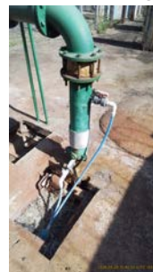
Foto 8 - Dosagem dos produtos químicos.
