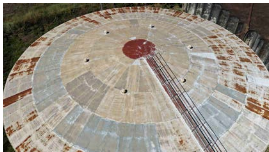
Foto 33 - Guarda-corpo (imagem de drone de 08/06/2026).
