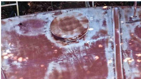
Foto 9 - Tampa de inspeção (imagem de drone de 08/06/2026).
