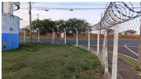
Foto 5 - Vista interna da unidade, evidenciando cercamento da área.
