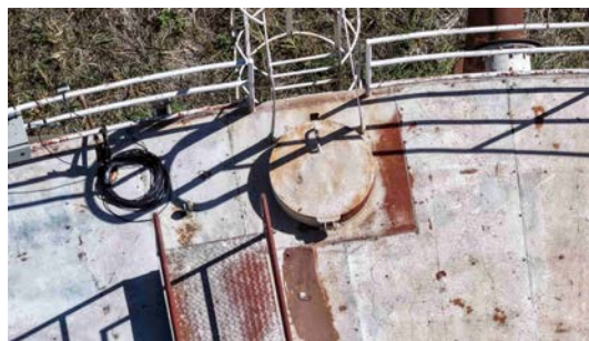
Foto 30 - Tampa de inspeção (imagem de drone de 08/06/2026).
