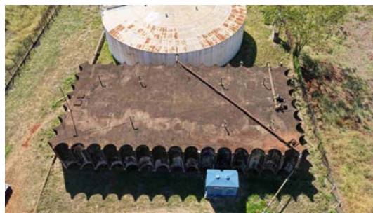
Foto 17 - Vista superior do reservatório (imagem de drone de 08/06/2026).
