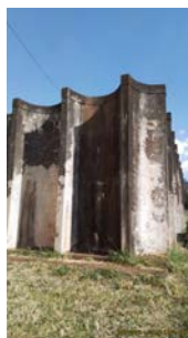
Foto 7 - Vista geral do reservatório.
