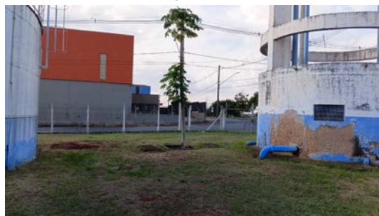
Foto 6 - Vista interna da unidade, evidenciando cercamento da área.
