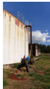
Foto 18 - Tubulação de saída do reservatório.
