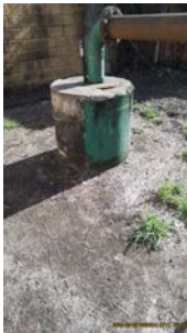
Foto 6 - Laje de proteção.
