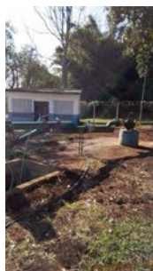
Foto 10 - Vista geral do poço.
