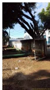
Foto 19 - Cercamento da área.
