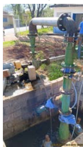
Foto 7 - A EEA pressuriza três linhas de rede.
