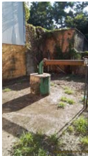
Foto 3 - Vista geral do poço.
