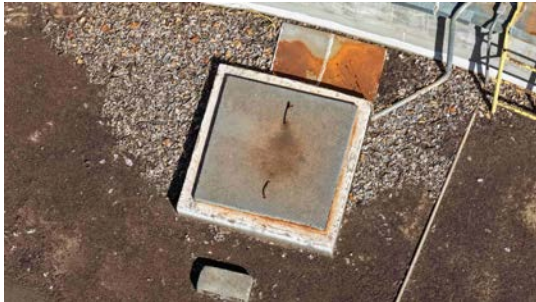
Foto 13 - Tampa de inspeção (imagem de drone de 08/06/2026).
