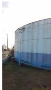
Foto 6 - Vista geral do reservatório.
