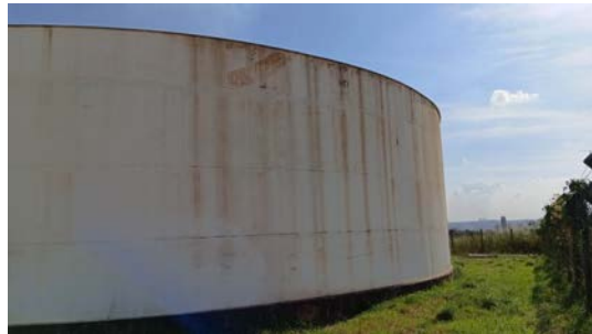
Foto 14 - Vista geral do reservatório.
