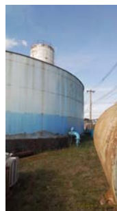
Foto 4 - Vista geral do reservatório.
