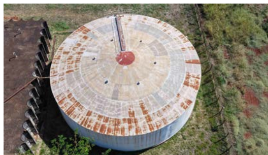
Foto 28 - Vista superior do reservatório (imagem de drone de 08/06/2026).
