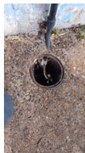
Foto 12 - Aterramento do SPDA.
