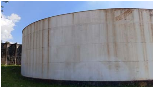
Foto 13 - Vista geral do reservatório.
