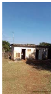
Foto 14 - Acesso ao painel de energia do poço.
