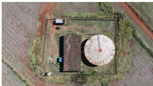
Foto 14 - Vista superior do reservatório (imagem de drone de 08/06/2026).
