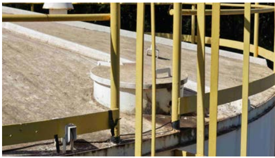
Foto 19 - Tampa de inspeção (imagem de drone de 08/06/2026).
