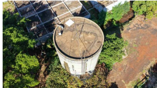
Foto 8 - Vista superior do reservatório (imagem de drone de 08/06/2026).
