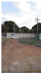
Foto 3 - Acesso e cercamento.
