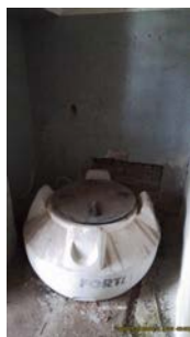
Foto 15 - Armazenamento de flúor.
