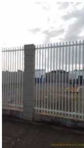
Foto 1 - Cercamento da área.
