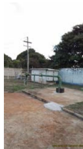
Foto 2 - Vista geral do poço.
