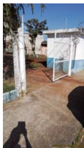
Foto 4 - Vista do acesso.
