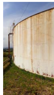
Foto 9 - Vista geral do reservatório.
