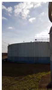
Foto 9 - Vista geral do reservatório.
