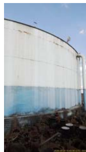
Foto 10 - Vista geral do reservatório.
