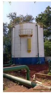
Foto 2 - Vista geral do reservatório.
