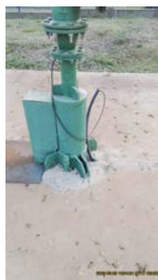
Foto 4 - Laje de proteção.
