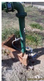
Foto 8 - Dosagem dos produtos químicos.
