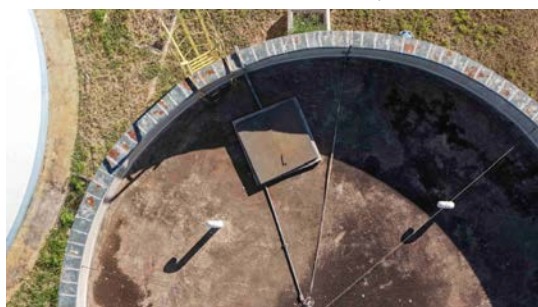
Foto 13 - Tampa de inspeção (imagem de drone de 08/06/2026).
