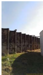
Foto 12 - Vista geral do reservatório.
