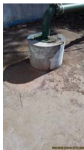
Foto 4 - Laje de proteção.
