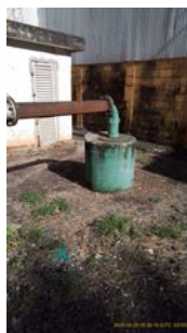
Foto 7 - Vista geral do poço.
