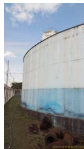
Foto 12 - Vista geral do reservatório.
