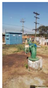
Foto 6 - Vista geral do poço.
