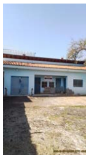
Foto 10 - Abrigo do sistema de dosagem química.
