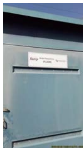
Foto 13 - Identificação e acesso ao armazenamento de flúor.
