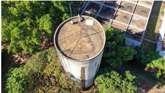
Foto 7 - Vista superior do reservatório (imagem de drone de 08/06/2026).
