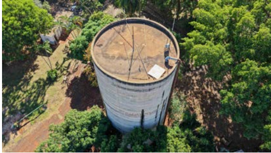
Foto 5 - Vista superior do reservatório (imagem de drone de 08/06/2026).
