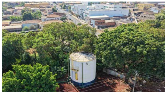
Foto 11 - Vista superior do reservatório (imagem de drone de 08/06/2026).
