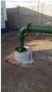
Foto 4 - Vista do poço.
