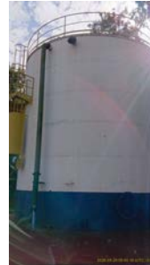
Foto 3 - Vista geral do reservatório.
