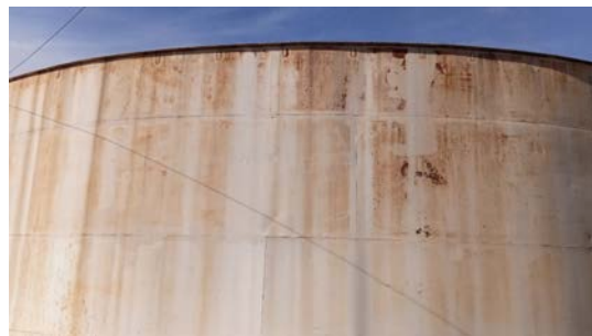
Foto 7 - Vista geral do reservatório.
