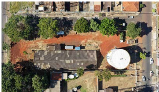
Foto 2 - Vista geral dos reservatórios (imagem de drone de 08/06/2026).
