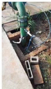
Foto 21 - Dosagem dos produtos químicos.
