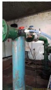
Foto 10 - Dosagem dos produtos químicos.
