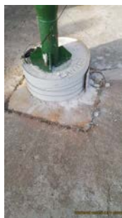
Foto 5 - Laje de proteção do poço.
