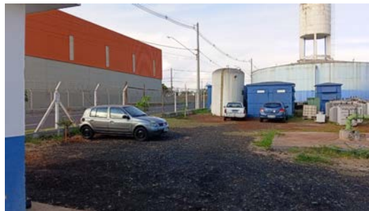
Foto 2 - Vista interna da unidade, evidenciando cercamento da área.
