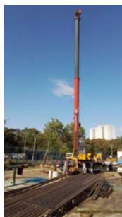
Foto 9 - Tubulação interna de recalque do poço retirada para manutenção.
