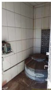
Foto 19 - Armazenamento de flúor.
