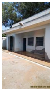
Foto 11 - Abrigo do sistema de dosagem química.
