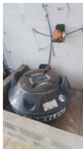
Foto 12 - Armazenamento de flúor.
