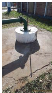
Foto 4 - Laje de proteção.
