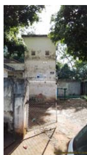
Foto 1 - Vista do acesso ao poço.
