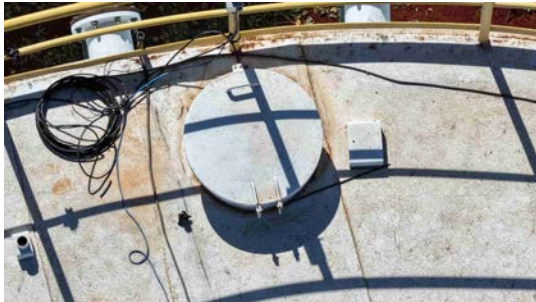
Foto 11 - Tampa de inspeção (imagem de drone de 08/06/2026).
