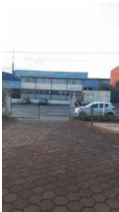
Foto 2 - Acesso ao poço.
