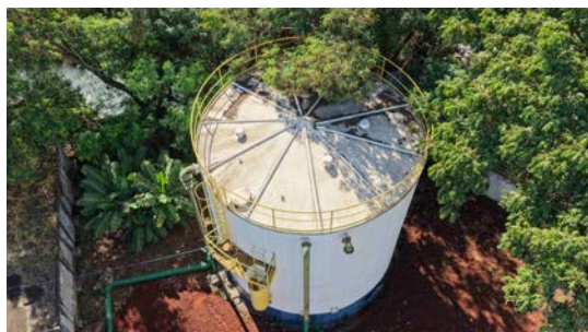
Foto 15 - Vista superior do reservatório (imagem de drone de 08/06/2026).
