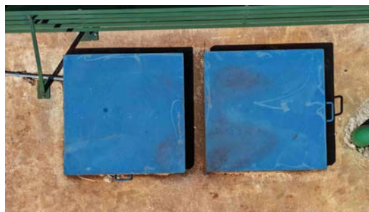
Foto 6 - Tampa de inspeção (imagem de drone de 08/06/2026).
