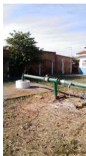
Foto 11 - Vista geral do poço.
