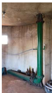
Foto 17 - Tubulação de saída do reservatório.
