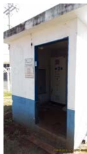
Foto 17 - Abrigo do painel de energia.
