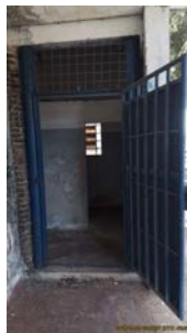
Foto 14 - Abrigo do sistema de dosagem química.
