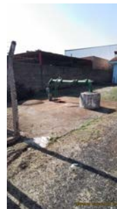
Foto 2 - Vista geral do poço.
