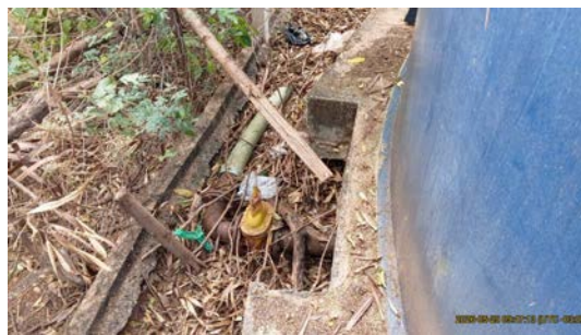
Foto 10 - Tubulação de dreno do reservatório.
