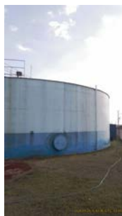
Foto 13 - Vista geral do reservatório.
