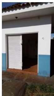
Foto 13 - Acesso ao painel de energia do poço.
