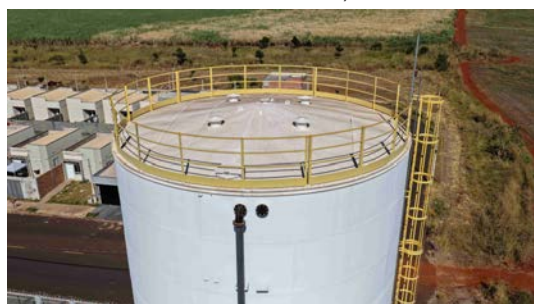
Foto 18 - Guarda-corpo (imagem de drone de 08/06/2026).
