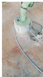
Foto 16 - Laje de proteção.
