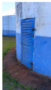
Foto 8 - Porta de acesso ao interior da base do reservatório, onde está instalada uma EEA.
