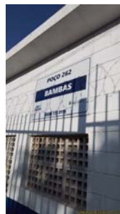
Foto 15 - Placas de identificação.
