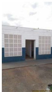
Foto 19 - Abrigo do sistema de dosagem química.
