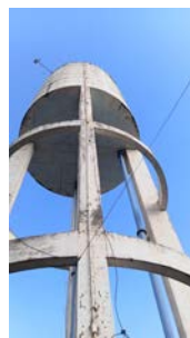
Foto 10 - Vista geral do reservatório.
