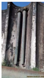
Foto 6 - Extravasor do reservatório.
