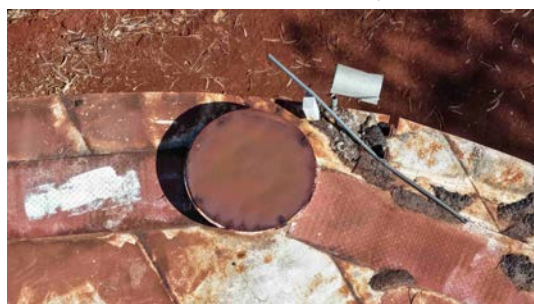
Foto 10 - Tampa de inspeção (imagem de drone de 08/06/2026).
