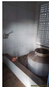
Foto 13 - Armazenamento de flúor.
