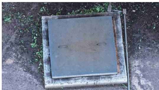
Foto 11 - Tampa de inspeção (imagem de drone de 08/06/2026).
