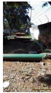
Foto 18 - Tubulação de sucção.
