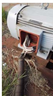
Foto 1 - Fechar a tampa de proteção da fiação do motor.
