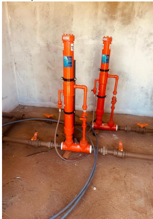
Figura TEC 2(E) – Dosadores para aplicação de produtos químicos em tabletes.
