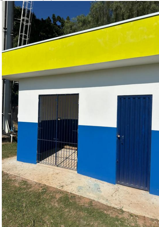
Figura TEC 2(D) – Casa de produtos químicos.
