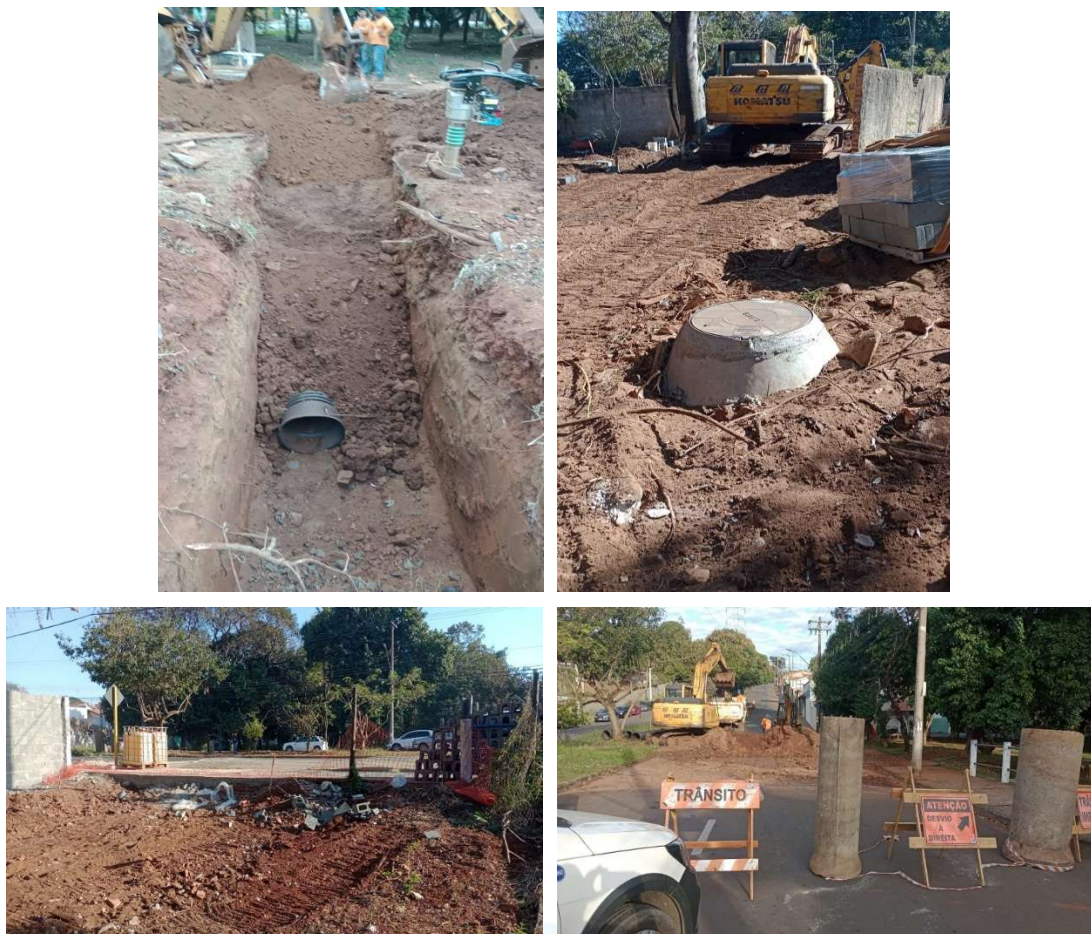
Figura TEC 4 – Substituição do coletor de esgoto do Recreio São Judas Tadeu - Margem esquerda do córrego do Gregório trecho da rodovia SP 310 até a av. Vicente Pelicano no bairro Recreio São Judas Tadeu – Fonte: SAAE São Carlos
