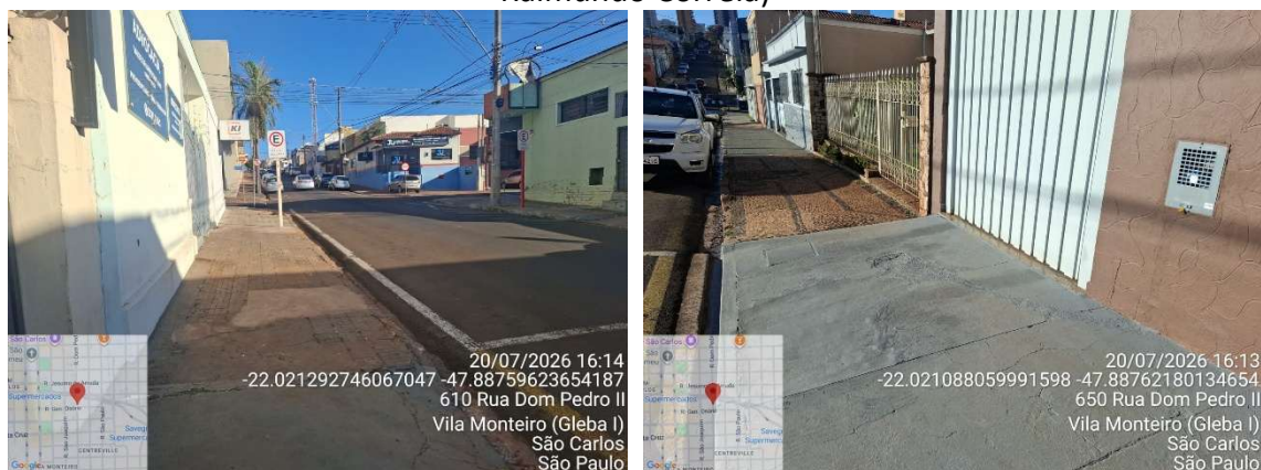
Figura TEC 6 – Substituição de redes de água da Rua Dom Pedro (trecho da rodoviária até a rua Raimundo Correia)
