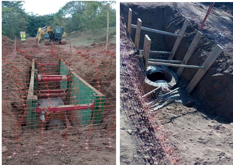
Figura TEC 3 – Substituição do interceptor de esgoto da margem esquerda do córrego do monjolinho, trecho compreendido entre a captação do espraído até a Av. do Bosque (interior da UFSCAR) – Fonte: SAAE São Carlos
