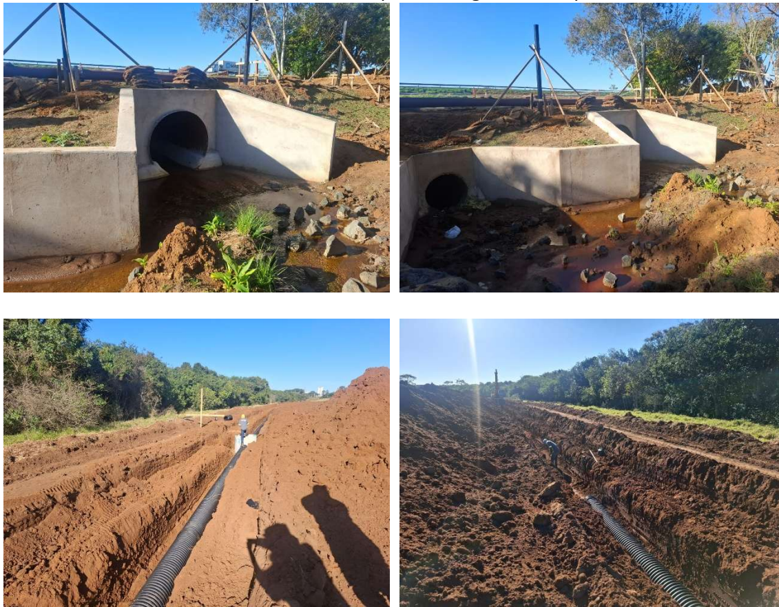
Figura TEC 7 – Obras de construção do interceptor de esgoto do empreendimento Porto Royale
