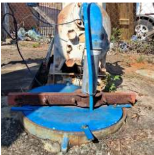
Foto 3 - Poço de sucção
