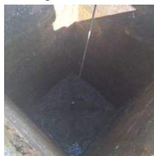
Foto 4 - Vista do cesto da elevatória
