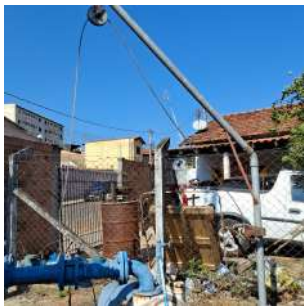
Foto 5 - Talha de içamento
