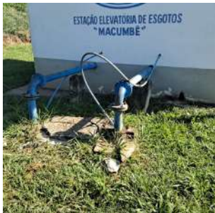
Foto 3 - Poço de sucção
