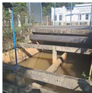
Foto 5 - Vista superior da tomada de água
