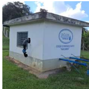
Foto 4 - Casa de bombas
