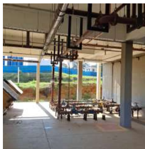
Foto 10 - Bombeamento de lodo
