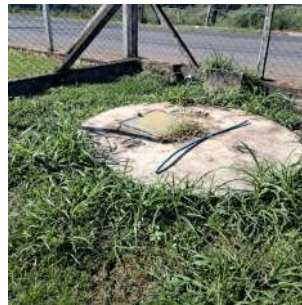
Foto 2 - Chegada do esgoto
