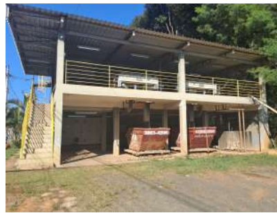
Foto 14 - Tratamento de lodo da ETA
