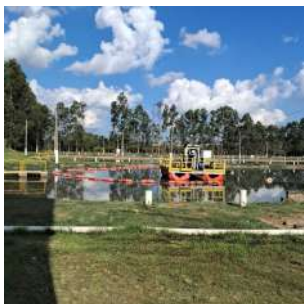
Foto 5 - Plataforma de dragagem de lodo
