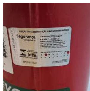
Foto 2 - Extintor com validade expirada (fev/26)
