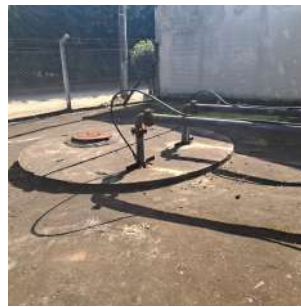
Foto 6 - Poço de sucção
