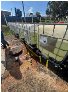
Foto 1 - Indícios de vazamento
