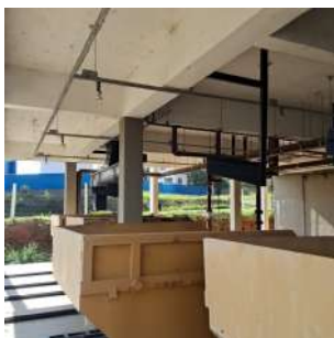
Foto 9 - Coleta de lodo adensado
