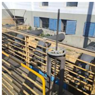
Foto 6 - Poço de sucção
