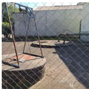
Foto 1 - Vista externa da EEE Antônio Rosário
