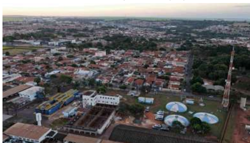
Foto 7 - Vista geral da área onde se localiza o reservatório.
