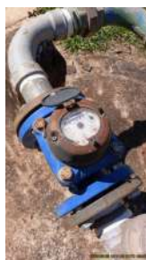
Foto 1 - Macromedidor não está registrando o volume captado.
