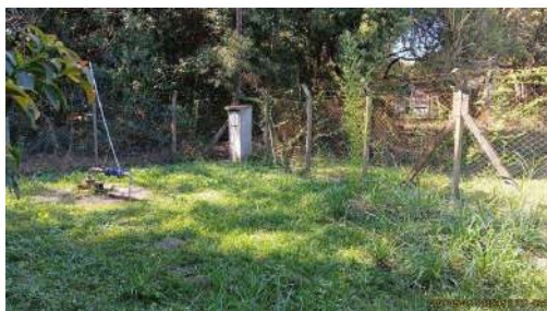
Foto 4 - Vista geral da área interna da unidade, evidenciando cercamento do perímetro.
