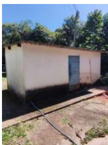
Foto 7 - Edificação que abriga caixa de mistura águas dos poços e caixa de passagem da água dos drenos.
