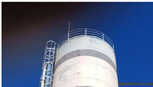
Foto 8 - Vista do topo do reservatório, guarda corpos.
