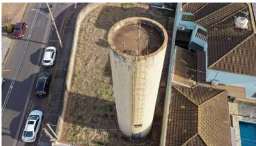
Foto 2 - Vista geral do reservatório.
