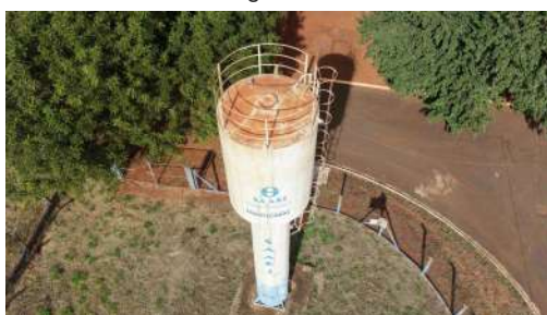
Foto 3 - Vista geral do reservatório.
