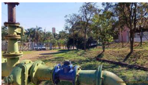
Foto 6 - Vista da área interna da unidade, evidenciando cercamento com alambrado.
