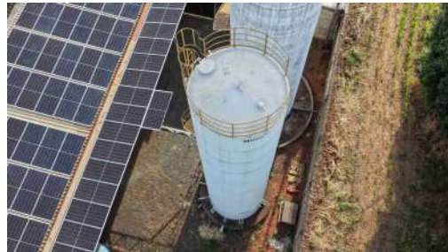
Foto 3 - Vista geral do reservatório.
