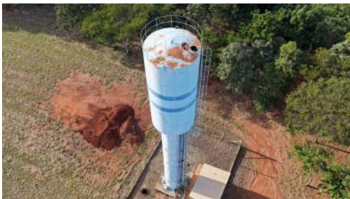
Foto 4 - Vista geral do reservatório.
