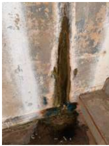
Foto 1 - Vazamento 1.
