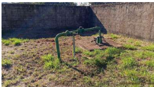
Foto 7 - Vista geral da captação.
