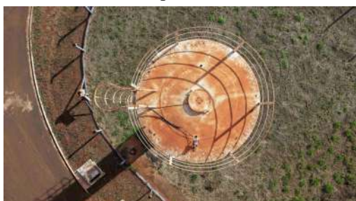
Foto 6 - Vista superior do reservatório.
