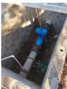
Foto 15 - Registro de manobra em caixa de passagem nas vizinhanças do poço.
