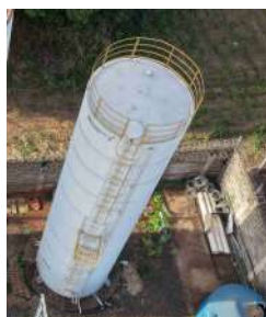
Foto 8 - Tubo extravasor à esquerda da escada, tubo de alimentação à direita dela e tubulação de saída na parte inferior, à direita do tubo de alimentação.
