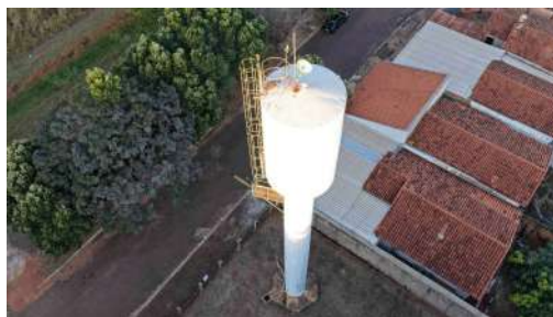
Foto 3 - Vista geral do reservatório.
