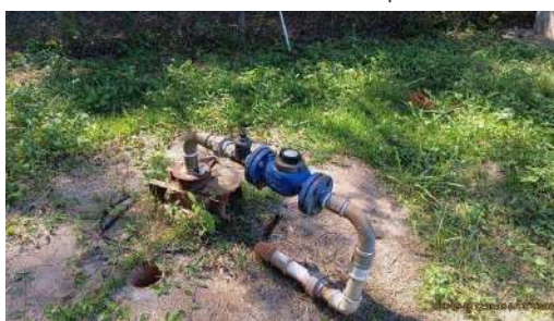
Foto 5 - Vista geral da captação.
