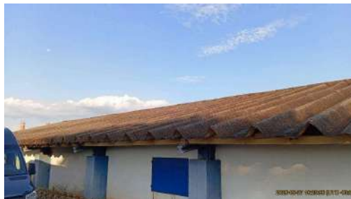
Foto 13 - Telhado do reservatório.
