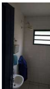
Foto 42 - Chuveiro no vestiário 2.
