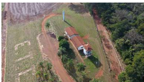
Foto 48 - Edificação de apoio próxima à entrada da unidade.
