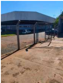
Foto 1 - Cercamento do perímetro.
