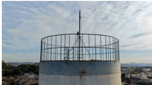
Foto 6 - Vista em perfil da parte superior do reservatório, antena do SPDA.
