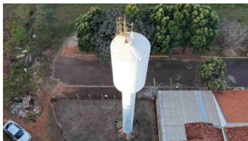
Foto 2 - Vista geral do reservatório.
