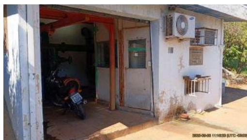
Foto 1 - Vista da edificação que abriga a EEA.
