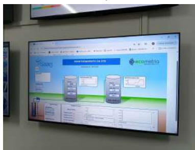
Foto 14 - Interface no CCO do Prestador exibindo nível dos reservatórios localizados junto a ETA. Os tres reservatórios de 1000 m3 são vaso comunicantes, sendo apresentados com um reservatório de 3000 m3 na imagem.
