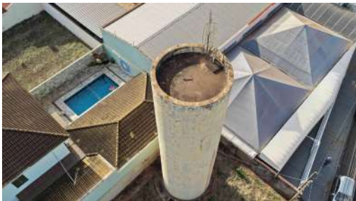
Foto 4 - Vista geral do reservatório.
