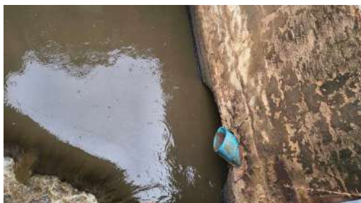
Foto 3 - Interior da caixa de passagem à montante dos desarenadores.
