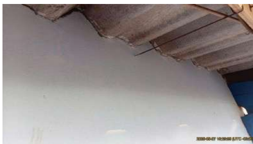
Foto 11 - A alvenaria das paredes segue até as telhas.
