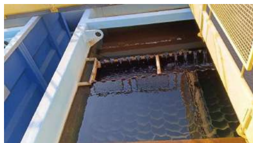
Foto 3 - Vertedores desnivelados.
