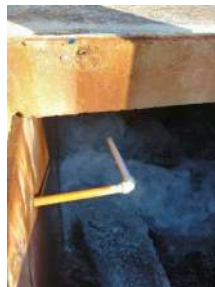
Foto 12 - Interior da caixa de passagem adjacente ao poço.
