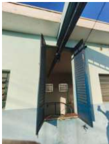
Foto 5 - Porta de acesso para manutenções.
