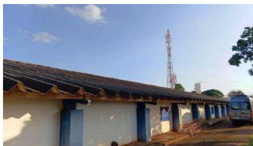
Foto 2 - Vista geral do reservatório.
