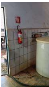
Foto 1 - Extintor de incêndio existente no local.
