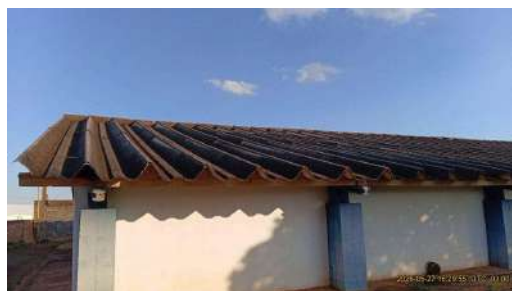
Foto 1 - Vista geral do reservatório.
