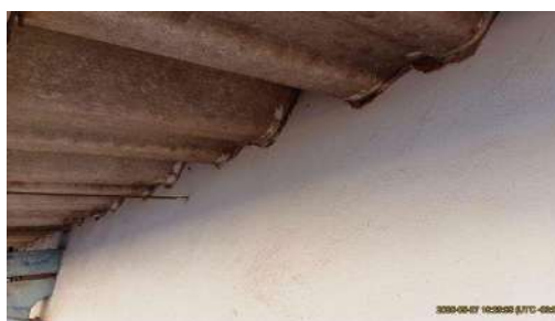
Foto 6 - A alvenaria das paredes segue até as telhas.
