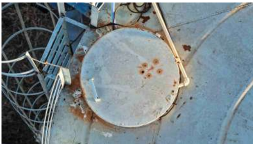
Foto 16 - Tampa de inspeção localizada na parte superior do reservatório.
