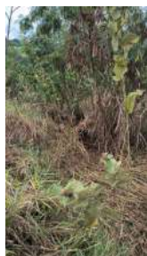
Foto 14 - PV encoberto por vegetação, na galeria à jusante das lagoas.
