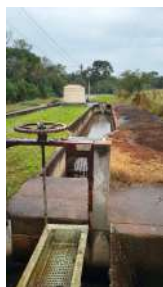
Foto 5 - Desarenador com gradeamento manual. Sedimento retirado do canal depositado à direita na imagem.
