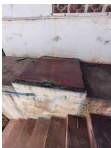
Foto 5 - Tampa de inspeção do reservatório.
