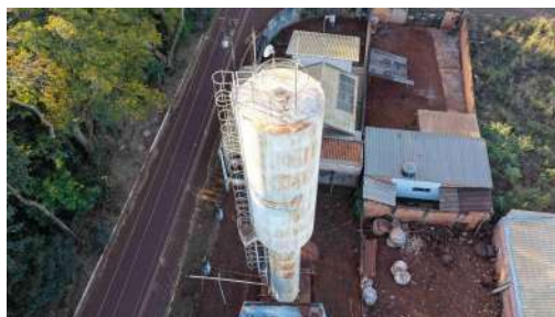
Foto 3 - Vista geral do reservatório.
