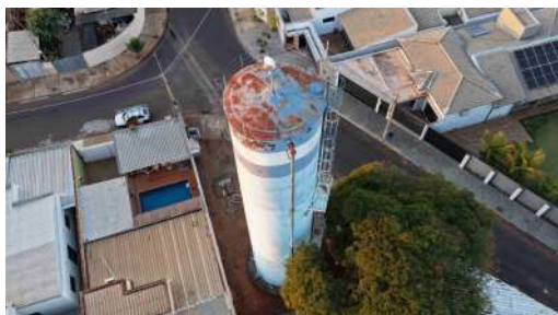
Foto 4 - Vista geral do reservatório.
