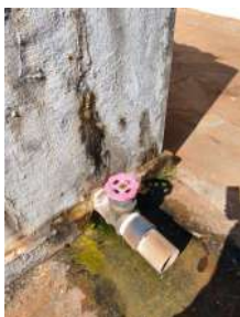
Foto 13 - Vazamento.
