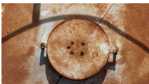
Foto 8 - Tampa de inspeção.
