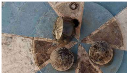
Foto 4 - Aberturas de ventilação no topo do reservatório 3.
