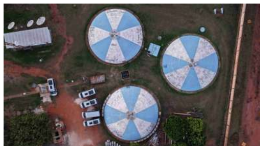
Foto 17 - Vista superior dos reservatórios.
