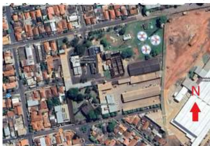
Foto 6 - Identificação dos três reservatórios de 1000 m3 junto à ETA.
