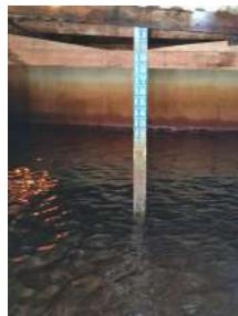
Foto 10 - Vista do interior do reservatório. Régua de nível.
