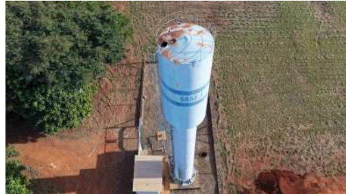
Foto 3 - Vista geral do reservatório.
