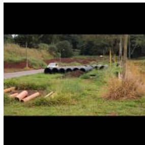
Foto 27 - Tubos depositados na área, a serem utilizados para a ligação da saída dos novos DAFAs.
