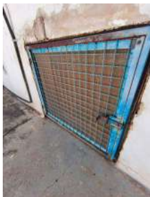
Foto 9 - Tampa de inspeção do reservatório.
