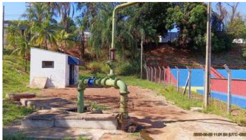
Foto 2 - Vista geral da captação.
