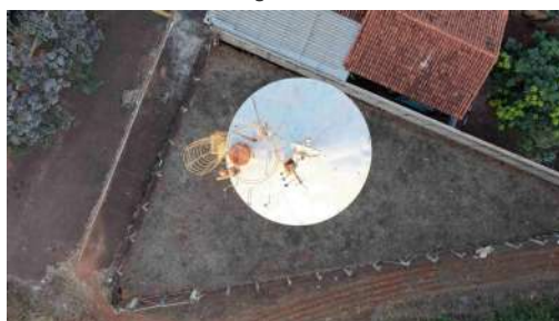
Foto 5 - Vista superior do reservatório.
