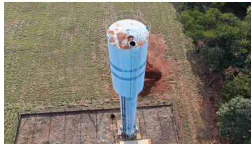
Foto 2 - Vista geral do reservatório.
