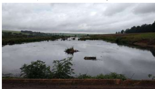
Foto 31 - Lagoa superior. Acúmulo de vegetação, indicativo de assoreamento.
