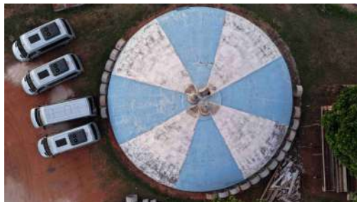
Foto 11 - Vista superior do reservatório 3.
