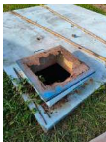
Foto 2 - Tampa da caixa de passagem adjacente aos reservatórios.
