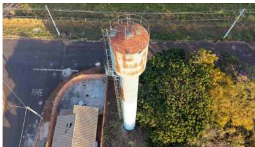
Foto 2 - Vista geral do reservatório.
