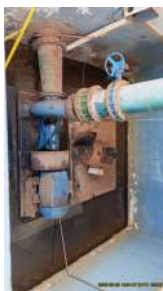
Foto 3 - Bomba chamada pelo prestador de booster.
