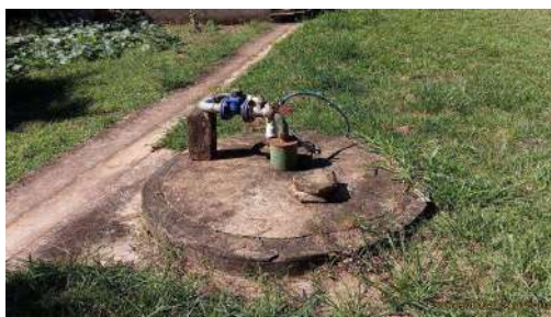
Foto 3 - Vista geral da captação.
