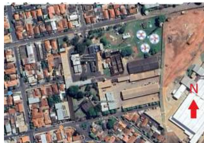
Foto 8 - Identificação dos três reservatórios de 1000 m3 existentes junto à ETA.
