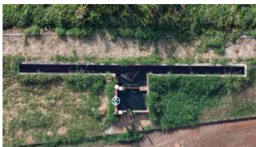
Foto 50 - Caixa de distribuição na entrada do DAFA 1.
