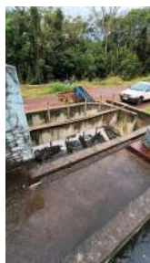
Foto 10 - Caixa de areia após os canais desarenadores.
