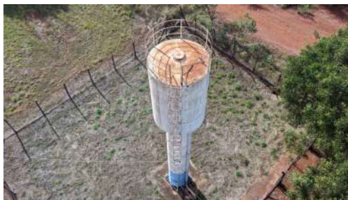
Foto 2 - Vista geral do reservatório.
