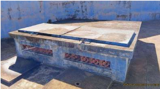
Foto 2 - Construção em alvenaria para abrigo das bombas.
