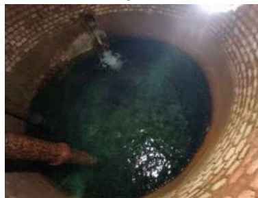
Foto 16 - Interior do reservatório onde são misturadas as água captadas na unidade.
