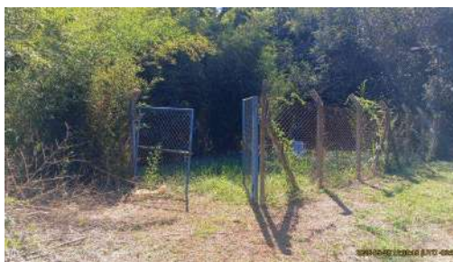
Foto 2 - Vista geral da unidade, evidenciando cercamento do perímetro.
