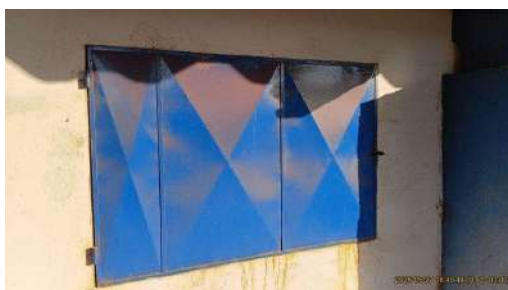
Foto 14 - Tampa de inspeção.
