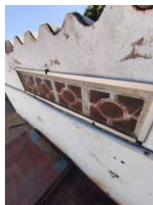
Foto 8 - Aberturas de ventilação.
