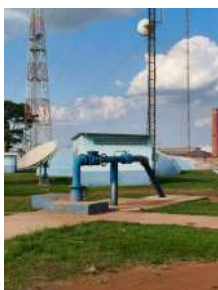
Foto 1 - Vista geral da captação.
