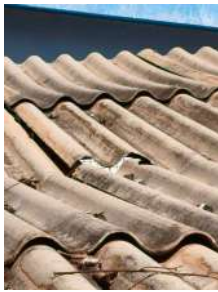
Foto 3 - Telha quebrada.
