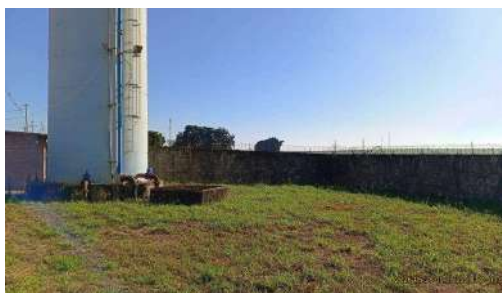
Foto 6 - Vista do interior da unidade, evidenciando cercamento com muro.
