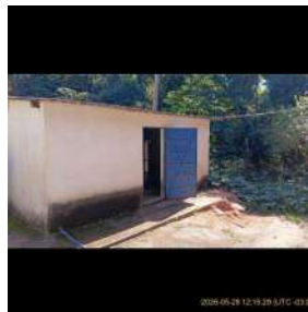
Foto 5 - Edificação onde está a caixa de passagem que recebe a água das minas e dos poços existente na área chamada Estiva.
