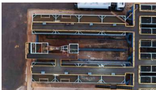
Foto 41 - Vista superior floculadores.
