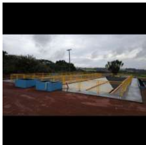
Foto 26 - DAFA 7 em construção.
