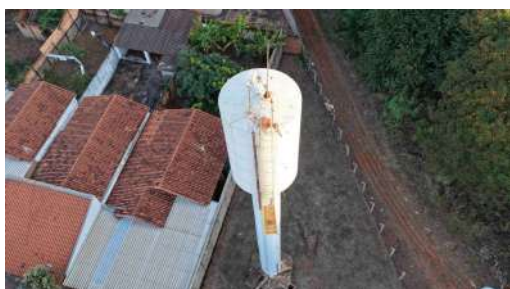
Foto 4 - Vista geral do reservatório.
