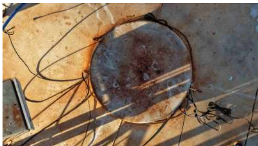
Foto 6 - Tampa de inspeção.
