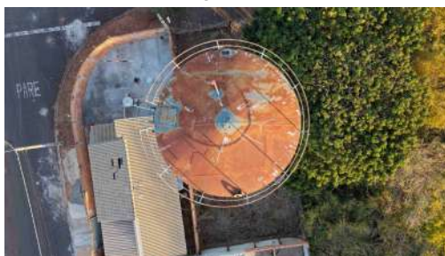
Foto 5 - Vista superior do reservatório.
