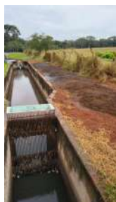
Foto 5 - Lodo depositado para secagem ao lado do canal de desarenação.
