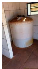
Foto 10 - Tanque de reagente para cloração.
