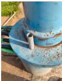
Foto 20 - Tubo para medição de nível.
