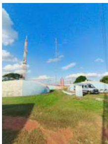
Foto 1 - Vista geral dos três reservatórios de 1000 m 3 vaso comunicantes existentes na ETA. N° 1 a esquerda, n° 3 a direita e n° 2 mais ao fundo.
