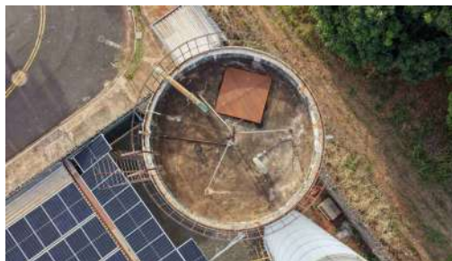
Foto 5 - Vista superior do reservatório.
