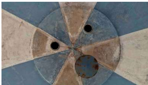
Foto 6 - Aberturas de ventilação no topo do reservatório.
