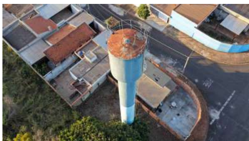
Foto 4 - Vista geral do reservatório.
