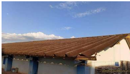
Foto 10 - Telhado do reservatório.
