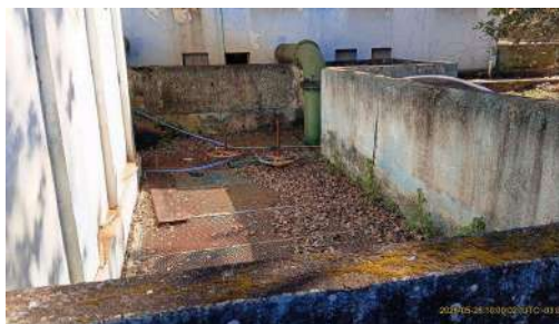
Foto 2 - Caixa de areia, a partir da qual as bombas succionam a água.
