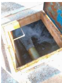
Foto 13 - Interior da caixa de passagem adjacente ao poço.
