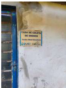
Foto 2 - Placa com identificação de edificação no local. Inativa.
