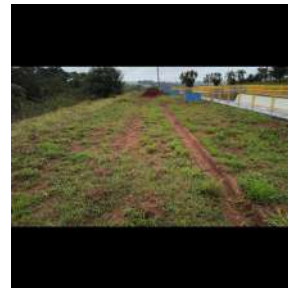
Foto 22 - Via adjacente aos DAFA 5 em construção, coberta por vegetação.
