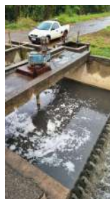
Foto 12 - Caixa de areia após os canais desarenadores.
