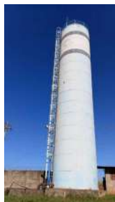
Foto 7 - Vista geral do reservatório.
