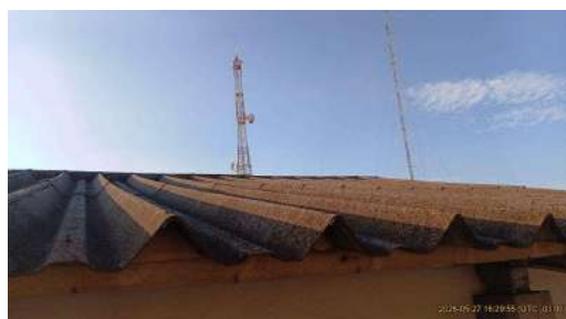
Foto 7 - Telhado do reservatório.
