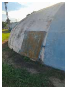
Foto 7 - Tampa de inspeção.
