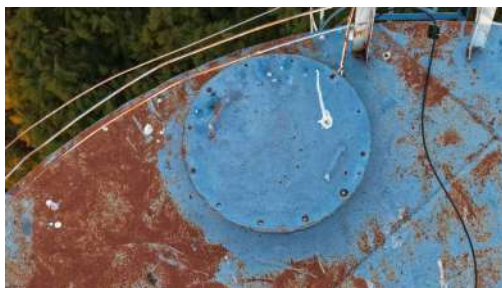
Foto 5 - Tampa de inspeção.
