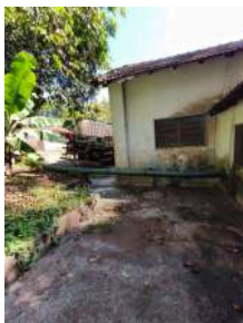
Foto 22 - Vista externa da edificação dentro da qual está o poço de sucção, a EEA e os tanques de reagentes empregados no tratamento.
