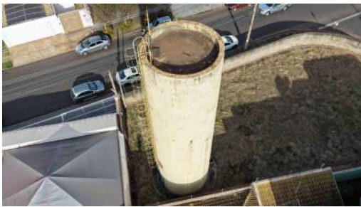
Foto 3 - Vista geral do reservatório.
