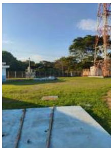
Foto 1 - Vista geral do interior da unidade onde se localiza o reservatório.
