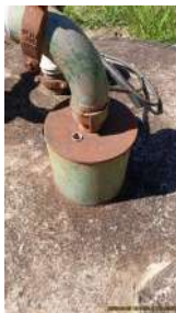
Foto 4 - Tubo para medição de nível. Recomenda-se fechar sua extremidade com cap.
