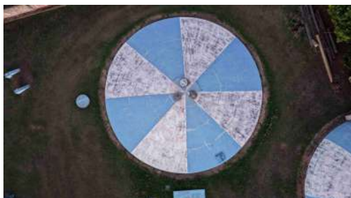
Foto 5 - Vista superior do reservatório 2.
