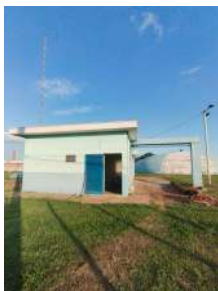
Foto 1 - Vista da edificação que abriga a EEA.
