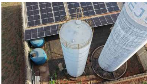
Foto 4 - Vista geral do reservatório.
