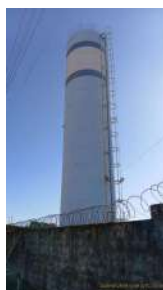
Foto 2 - Vista geral do reservatório.
