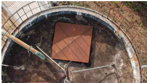
Foto 1 - Tapa de inspeção.
