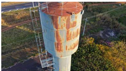
Foto 1 - Extravasor está fechado com tampa.
