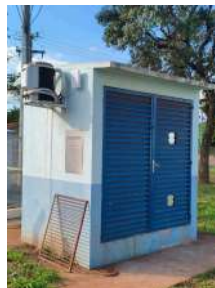
Foto 17 - Abrigo em alvenaria para o quadro de comando elétrico do poço.
