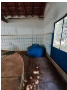
Foto 18 - Tanque do reagente para fluoretação.
