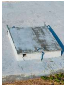
Foto 3 - Tampa de inspeção.
