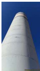
Foto 6 - Vista geral do reservatório.
