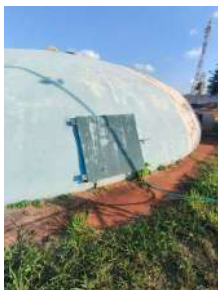
Foto 5 - Tampa de inspeção do reservatório.
