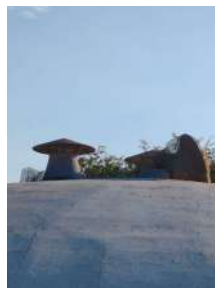
Foto 2 - Aberturas de ventilação sem tela de proteção.
