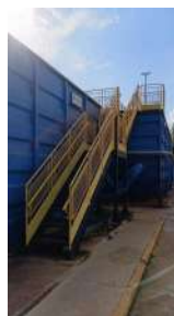
Foto 3 - Escada e guarda corpo para acesso à parte superior dos módulos.
