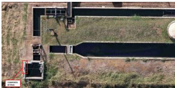
Foto 1 - Identificação da saída para by-pass.
