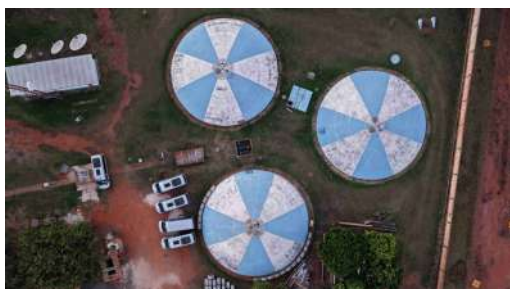
Foto 8 - Vista superior dos reservatórios.
