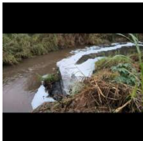
Foto 35 - Ponto de lançamento do efluente tratado no corpo receptor.
