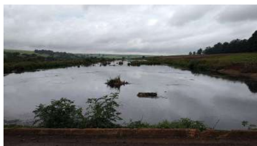
Foto 8 - Vegetação crescendo no interior da lagoa.
