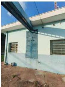
Foto 4 - Porta de acesso para manutenções.
