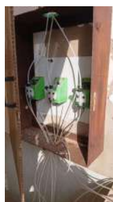
Foto 21 - Bombas peristálticas para dosagem de cloro na saída da ETA.
