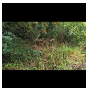
Foto 9 - PV próximo a entrada da lagoa inferior, encoberto por vegetação.
