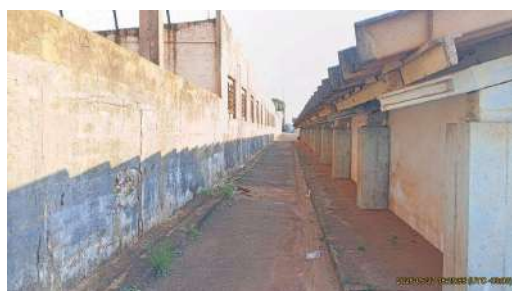
Foto 5 - Vista de uma das laterais do reservatório.
