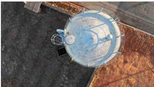
Foto 14 - Vista superior do reservatório.
