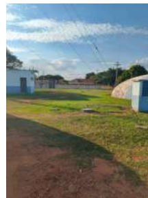
Foto 2 - Vista geral do interior da área onde se localizam os reservatórios.
