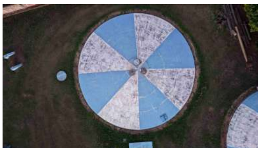
Foto 9 - Vista superior do reservatório 2.
