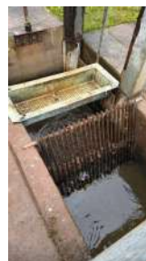
Foto 4 - Gradeamento grosseiro na caixa a montante dos desarenadores.
