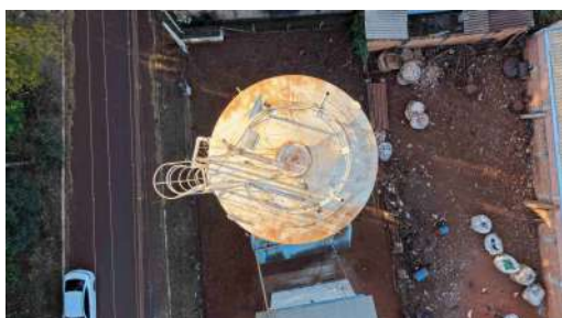
Foto 4 - Vista superior do reservatório.
