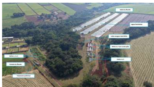
Foto 47 - Vista geral da unidade.
