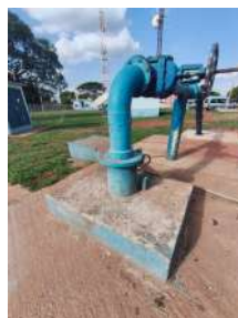
Foto 4 - Vista geral da captação.
