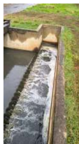
Foto 11 - Saída do efluente da caixa de areia.
