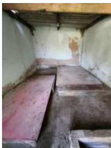
Foto 3 - Interior da edificação inativa.
