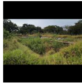
Foto 2 - Ao redor dos DAFAs 1 a 3, localizados próximo ao tratamento preliminar, não existe guarda corpo protegendo o perímetro, há risco de acidente. O mato alto existente no local dificulta a identificação dos limites dos DAFAs.
