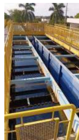
Foto 13 - Em cada linha da ETA há dois decantadores tipo colmeia.
