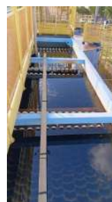
Foto 2 - Vertedores desnivelados.
