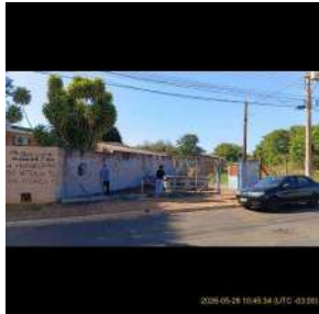
Foto 1 - Vista da unidade a partir do passeio público, evidenciando cercamento com alambrado..
