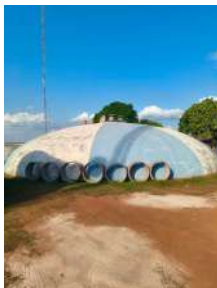
Foto 1 - Vista geral do reservatório nº 3.
