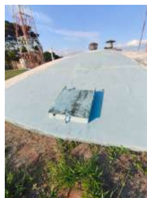
Foto 5 - Tampa de inspeção.
