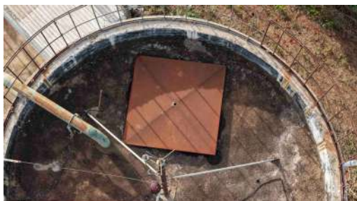
Foto 7 - Tampa de inspeção.
