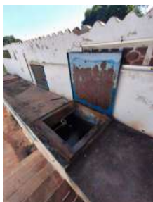
Foto 7 - Tampa de inspeção do reservatório.
