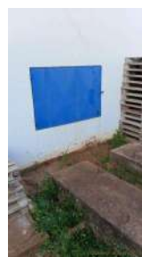
Foto 15 - Tampa de inspeção.
