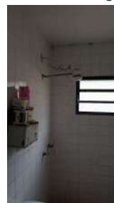
Foto 41 - Chuveiro no vestiário 1.
