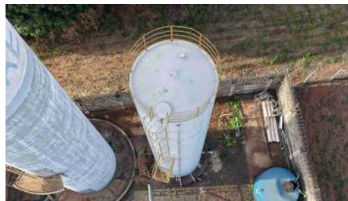
Foto 2 - Vista geral do reservatório.
