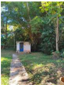
Foto 1 - Edificação para onde era direcionada a água captada nos drenos.
