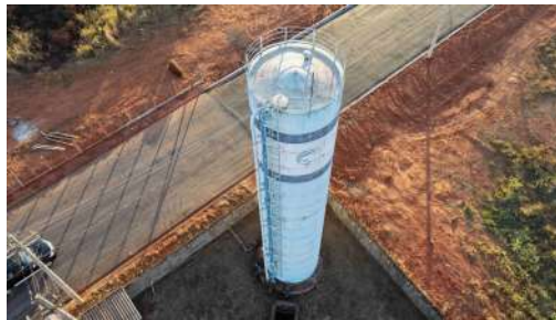
Foto 12 - Vista geral do reservatório.
