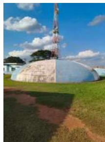
Foto 2 - Vista do reservatório n° 1.
