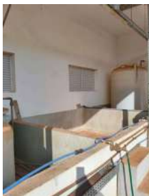
Foto 8 - Reservatórios dos reagentes utilizados no tratamento da água.
