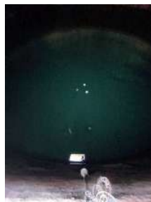
Foto 9 - Vista do interior do reservatório.
