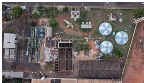
Foto 16 - Vista superior dos reservatórios.
