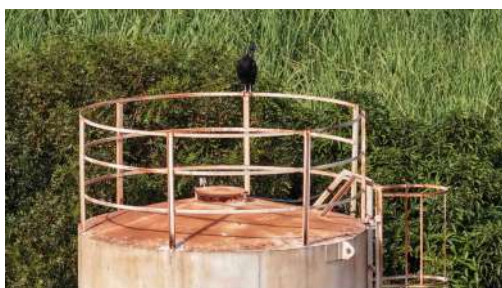
Foto 7 - Vista em perfil da parte superior do reservatório.
