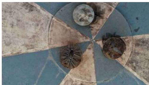
Foto 6 - Aberturas de ventilação no topo do reservatório 2.
