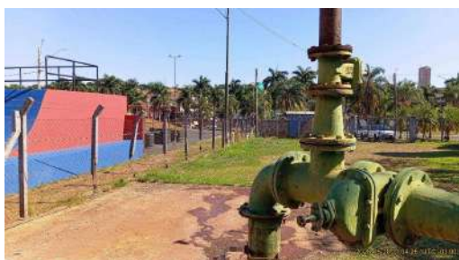
Foto 7 - Vista da área interna da unidade, evidenciando cercamento com alambrado.
