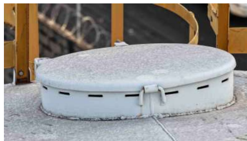
Foto 5 - Tampa de inspeção.
