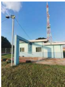
Foto 3 - Viga metálica para utilização de talha, quando de manutenções.
