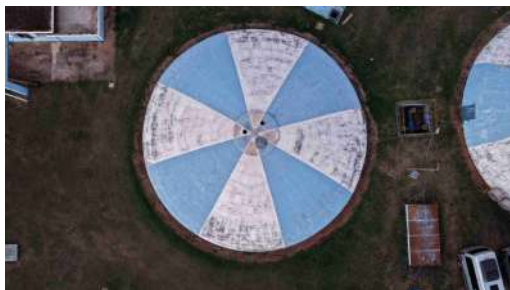
Foto 5 - Vista superior do reservatório.
