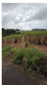
Foto 1 - Dano no cercamento, próximo à saída das lagoas.
