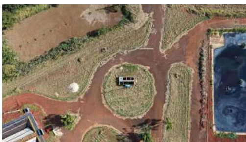
Foto 58 - Caixa de distribuição posicionada a montante das lagoas.
