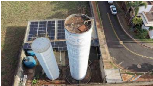
Foto 3 - Vista geral do reservatório.
