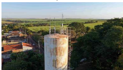
Foto 5 - Vista da parte superior do reservatório, em perfil, evidenciando antena do SPDA.
