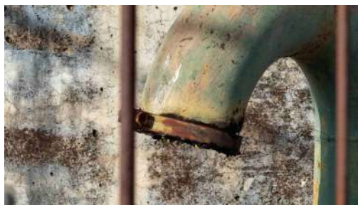
Foto 8 - Tubulação de ventilação no topo do reservatório.
