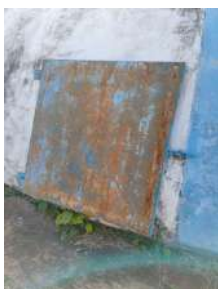
Foto 1 - Tampa de inspeção do reservatório.
