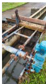
Foto 8 - Gradeamento automatizado.
