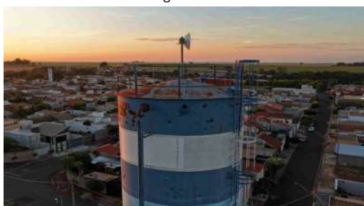
Foto 6 - Vista, em perfil, da parte superior do reservatório.
