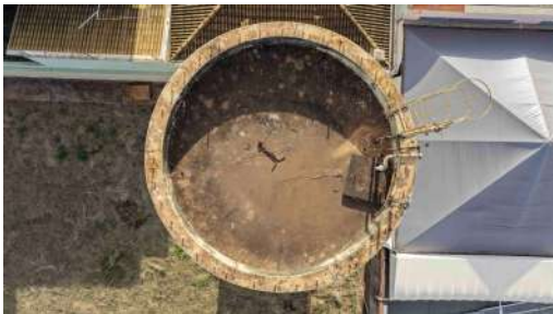
Foto 5 - Vista superior do reservatório.
