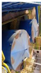
Foto 17 - O efluente dos filtros das duas linhas da ETA são direcionados a esses tanques de contato.
