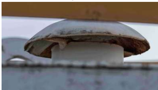
Foto 6 - Abertura de ventilação.
