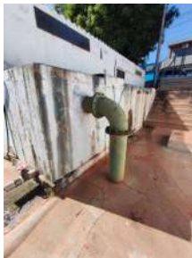
Foto 4 - Vista geral do reservatório.
