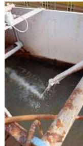
Foto 7 - Adição de cal para ajuste de pH antes da etapa de floculação.
