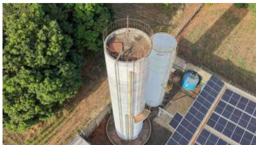
Foto 4 - Vista geral do reservatório. Da esquerda para a direita: tubo de alimentação, dreno e extravasor.
