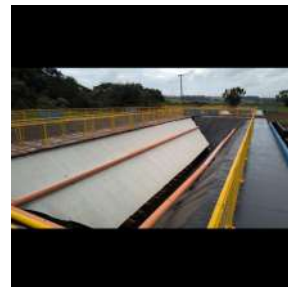
Foto 23 - DAFA 6 em construção. Representante do prestador informou ser preciso fazer a interligação da saída dos dois novos DAFA para eles iniciarem a operar.
