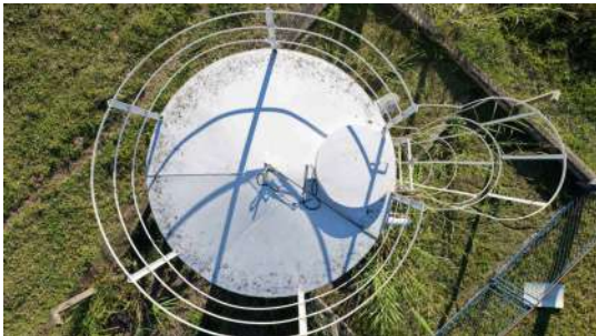
Foto 4 - Vista superior da cobertura
