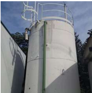
Foto 1 - Reservatório de recalque Meneguim
