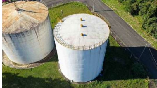
Foto 4 - Vista superior da cobertura do reservatório Panorama Tropical II
