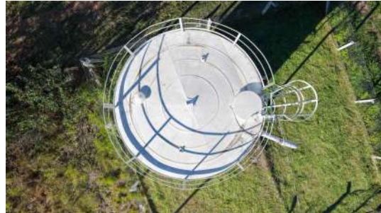
Foto 9 - Vista superior da cobertura do reservatório Meneguim
