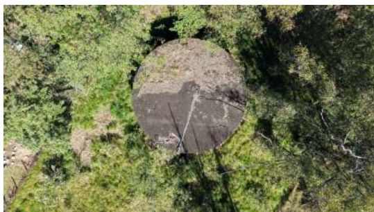
Foto 1 - Vista superior da área do reservatório
