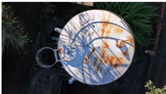
Foto 2 - Vista superior do reservatório de recalque Serra das Estâncias
