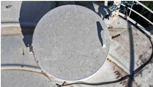
Foto 10 - Tampa de inspeção fechada
