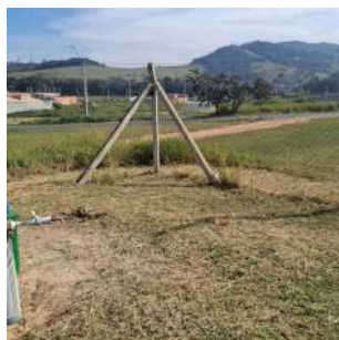
Foto 5 - Vista da limpeza da área
