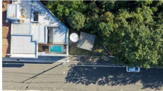
Foto 7 - Vista superior do cercamento da área
