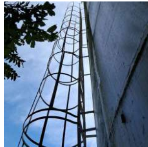
Foto 4 - Escada de acesso e guarda-corpo
