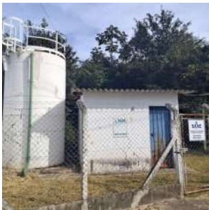
Foto 4 - Vista externa do reservatório de recalque e poço Meneguim
