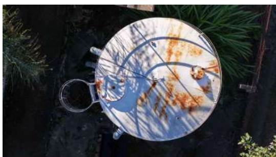
Foto 1 - Vista superior da cobertura do reservatório de recalque Serra das Estâncias
