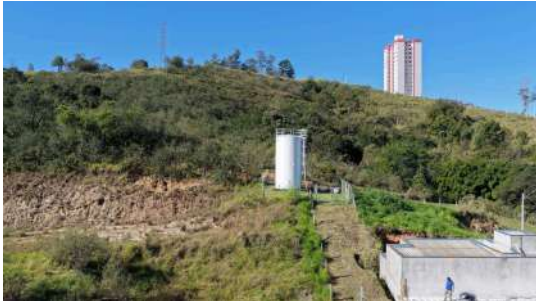
Foto 8 - Vista da área do reservatório Meneguim
