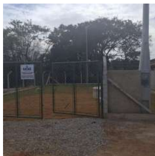
Foto 1 - Vista externa da estação elevatória de esgoto Vale Verde I
