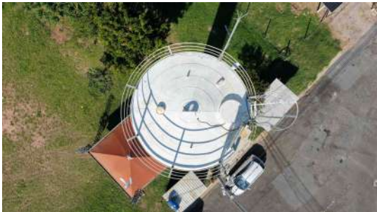
Foto 1 - Vista superior do reservatório
