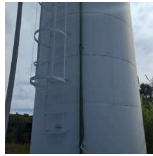
Foto 7 - Escada de acesso e guarda-corpo
