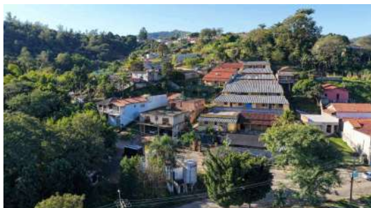
Foto 1 - Vista da área dos reservatórios de recalque Serra das Estâncias e Chácara das Águas
