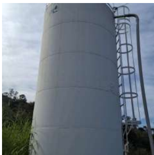
Foto 5 - Escada de acesso e guarda-corpo
