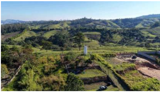
Foto 1 - Vista geral da área do reservatório Seabra
