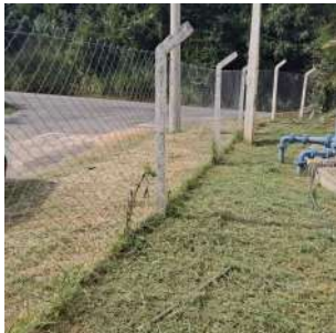
Foto 3 - Cercamento da área
