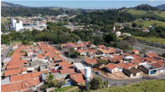
Foto 1 - Vista da área do reservatório Atílio Mazzini elevado
