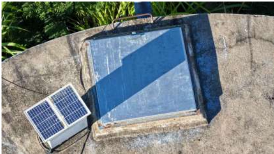
Foto 3 - Tampa de inspeção do reservatório Jardim Itália (circular)
