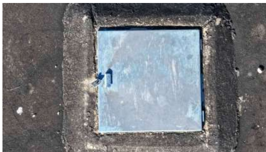
Foto 5 - Tampa de inspeção do reservatório Jardim Itália (retangular)
