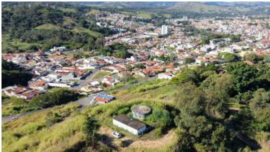
Foto 1 - Vista da área dos reservatórios Jardim Itália (circular e retangular)
