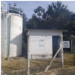
Foto 1 - Vista externa do reservatório de recalque e estação elevatória de água Meneguim
