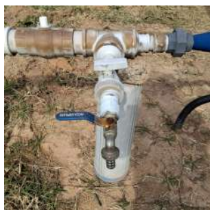
Foto 3 - Tomada de água
