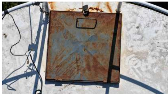
Foto 4 - Tampa de inspeção fechada
