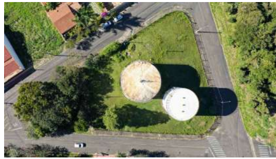
Foto 2 - Vista superior dos reservatórios Panorama Tropical
