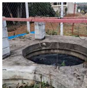
Foto 2 - Poço de sucção aberto
