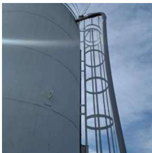
Foto 4 - Tubo de medição de nível (mangueira)
