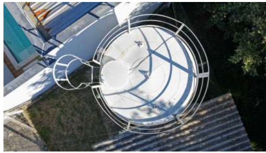
Foto 6 - Vista da cobertura do reservatório
