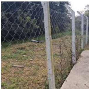
Foto 4 - Cercamento da área
