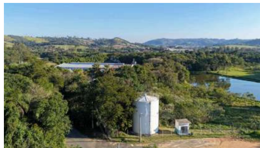
Foto 6 - Vista da área do reservatório e booster Morada da Baronesa
