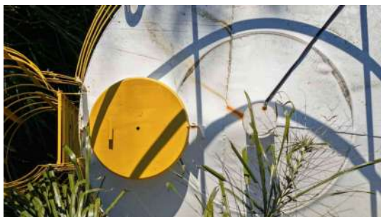
Foto 3 - Tampa de inspeção fechada
