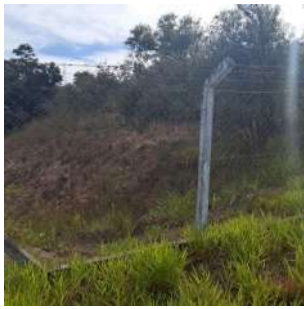
Foto 6 - Cercamento da área
