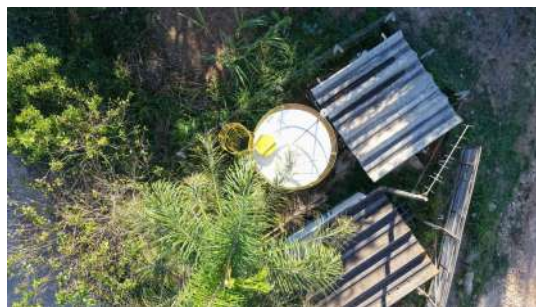
Foto 4 - Escada de acesso e guarda-corpo na cobertura do reservatório
