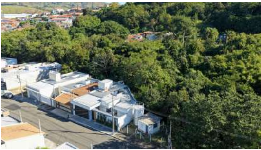
Foto 5 - Vista geral da área do reservatório e elevatória
