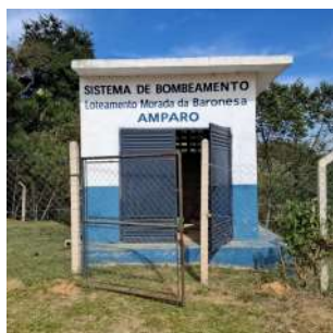
Foto 1 - Vista externa da área do booster
