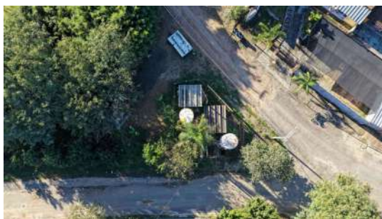
Foto 1 - Vista do reservatório de recalque Chácara das Águas
