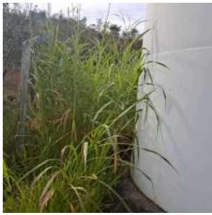
Foto 3 - Vista 3 do interior da área do reservatório
