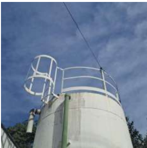
Foto 3 - Guarda-corpo na cobertura
