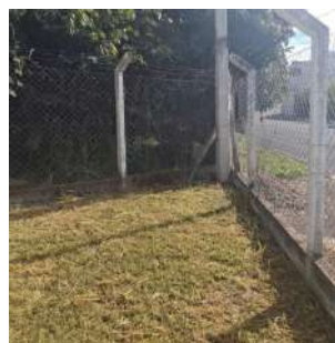
Foto 5 - Cercamento e limpeza da área
