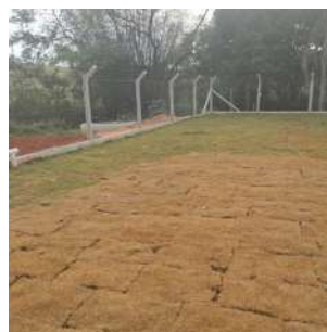
Foto 3 - Cercamento da área e limpeza da área
