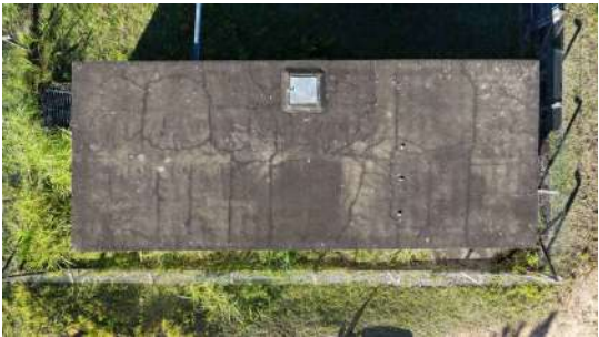
Foto 4 - Vista superior do reservatório Jardim Itália (retangular)
