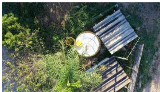
Foto 2 - Vista superior do reservatório de recalque Chácara das Águas
