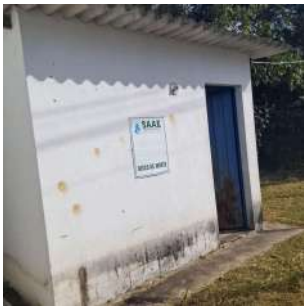
Foto 2 - Vista externa da casa de bombas
