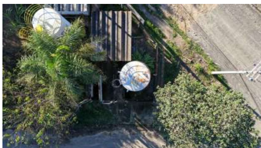
Foto 4 - Vista superior da área dos reservatórios de recalque Serra das Estâncias e Chácara das Águas
