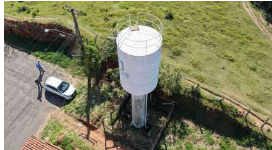
Foto 2 - Vista lateral do reservatório Atílio Mazzini elevado
