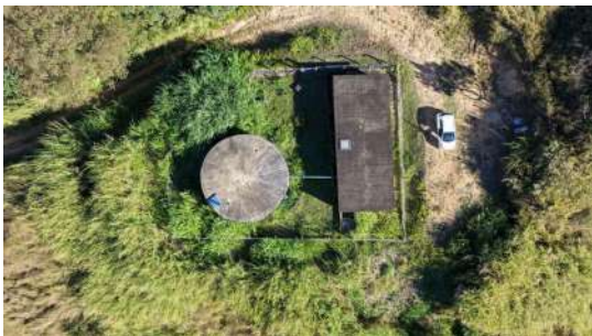
Foto 1 - Vista superior da área dos reservatórios Jardim Itália
