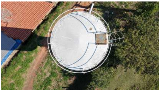
Foto 3 - Vista da cobertura do reservatório Atílio Mazzini elevado
