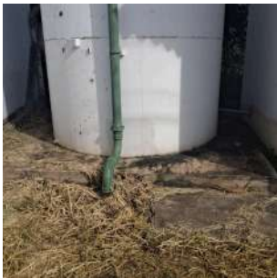
Foto 2 - Base do reservatório
