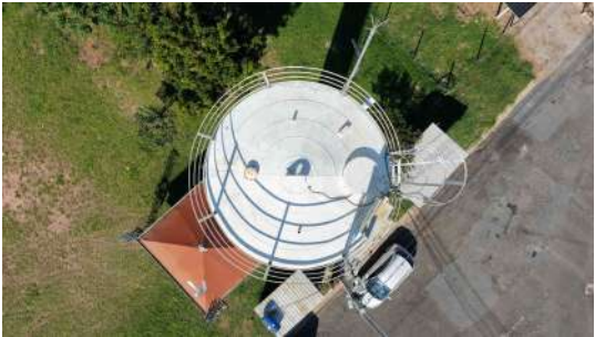
Foto 2 - Vista superior da cobertura do reservatório Quintas de Santiago
