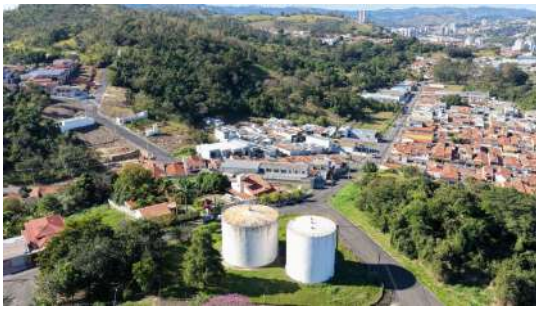
Foto 1 - Vista da área dos reservatórios Panorama Tropical
