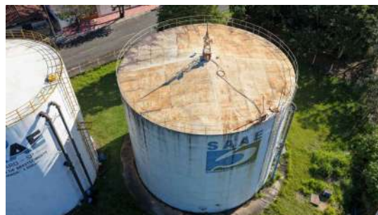
Foto 2 - Vista superior da cobertura do reservatório
