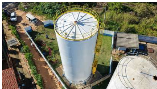
Foto 13 - Vista aérea do reservatório.
