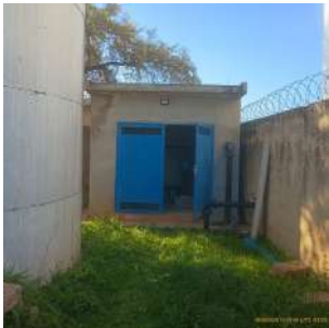
Foto 2 - Vista externa da casa de bombas.
