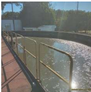
Foto 64 - Um dos tanques de adensamento de lodo.
