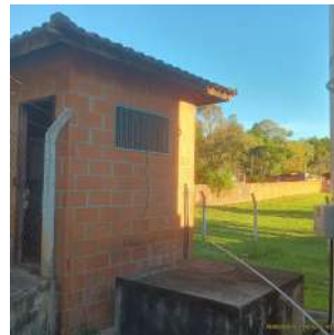
Foto 2 - Vista geral externa da área.
