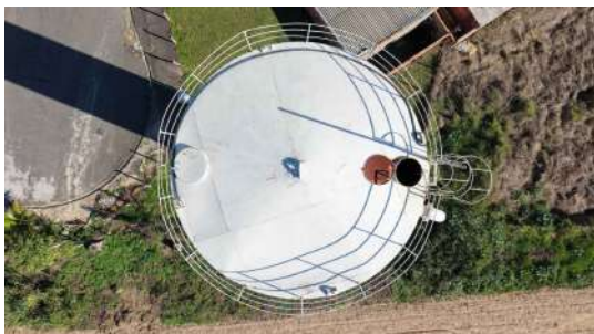
Foto 3 - Tampa de inspeção aberta.
