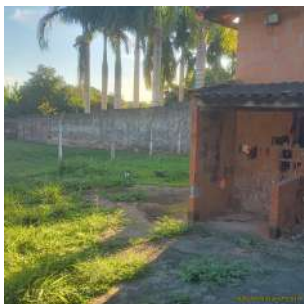
Foto 5 - Abrigo booster ao lado do reservatório.
