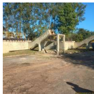
Foto 22 - Desarenador 2 (não estava em operação devido a um equipamento estar em manutenção).
