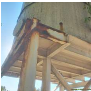
Foto 1 - Situação da base do reservatório.
