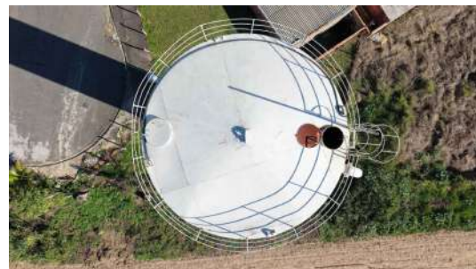
Foto 9 - Vista aérea da cobertura do reservatório.
