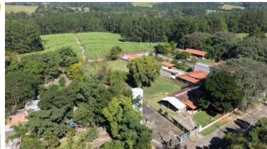
Foto 8 - Vista aérea geral do reservatório.
