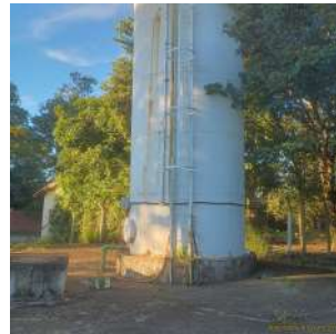
Foto 4 - Vista geral do reservatório.
