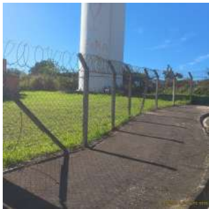
Foto 2 - Vista geral do reservatório.
