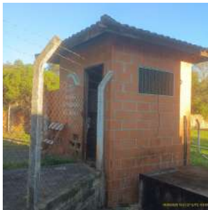
Foto 1 - Vista geral externa da área.
