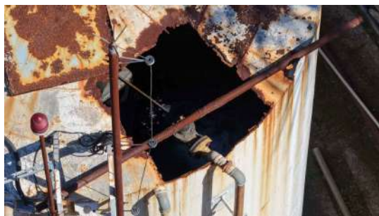
Foto 3 - Situação da cobertura do reservatório.
