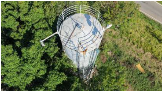
Foto 7 - Vista aérea da cobertura do reservatório.
