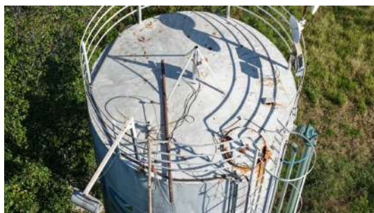
Foto 1 - Vista aérea da cobertura do reservatório.
