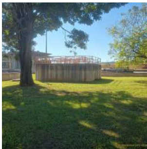
Foto 46 - Tanque de unificação de vazão, antes do direcionamento para os decantadores.
