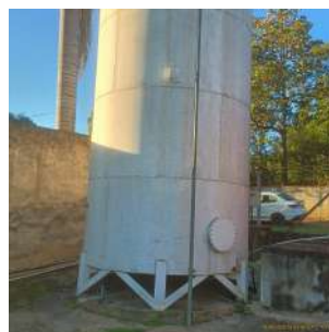
Foto 8 - Vista geral do reservatório.
