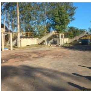
Foto 21 - Vista geral dos desarenadores.
