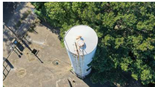
Foto 9 - Vista aérea do reservatório.
