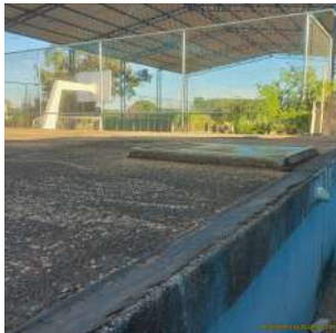
Foto 4 - Vista da cobertura do reservatório.
