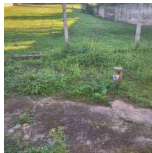
Foto 6 - Antigo poço desativado ao lado do reservatório.
