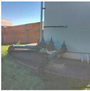
Foto 5 - Vista geral da base do reservatório.
