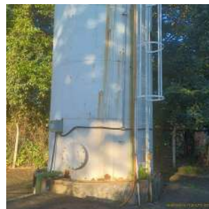
Foto 6 - Vista geral da base do reservatório.
