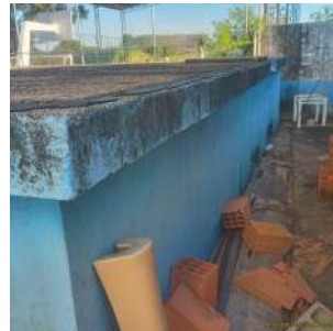
Foto 5 - Vista lateral do reservatório enterrado.
