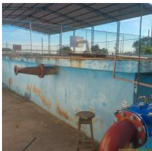
Foto 8 - Vista lateral do reservatório enterrado.
