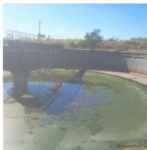
Foto 52 - Vista interna do decantador 3.
