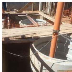
Foto 4 - Vista interna da EEAB.
