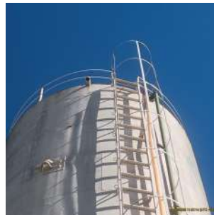
Foto 2 - Vista do tubo extravasor sem tela.
