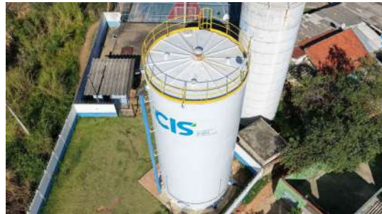
Foto 11 - Vista aérea do reservatório.
