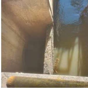
Foto 1 - Estrutura para desvio do esgoto do emissário Guaraú para o curso d'água.
