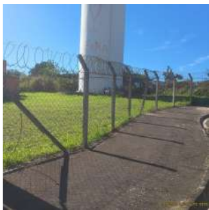
Foto 2 - Vista geral do reservatório.
