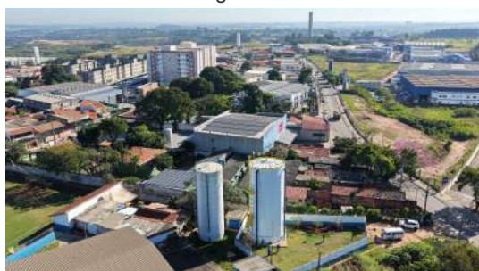
Foto 3 - Vista aérea dos dois reservatórios do local: o antigo (à esquerda - desativado) e o novo
