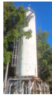
Foto 2 - Vista geral do reservatório.
