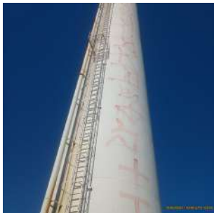
Foto 4 - Vista geral do reservatório.
