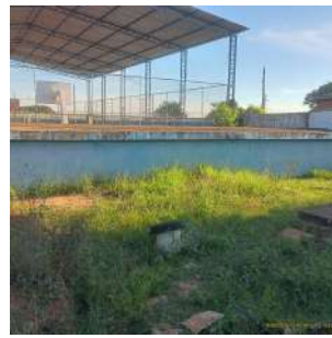
Foto 2 - Vista lateral do reservatório enterrado.
