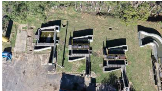
Foto 91 - Desarenadores (apenas do da direita estava em operação).
