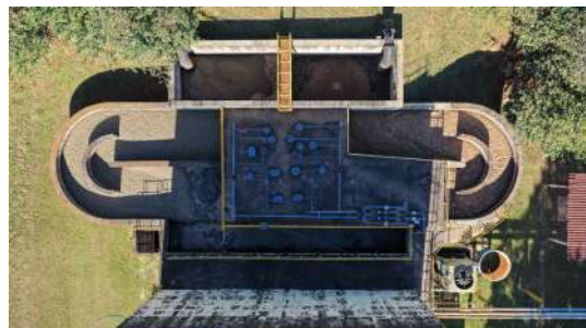
Foto 93 - Sistema Deep Shaft (apenas módulo da esquerda da foto estava em operação).
