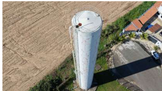
Foto 11 - Vista aérea geral do reservatório.
