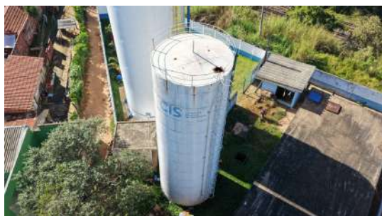
Foto 13 - Vista aérea do local (reservatório enterrado no lado direito da foto).
