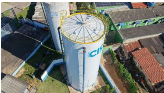
Foto 12 - Vista aérea do reservatório.
