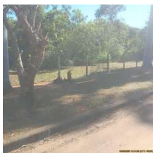
Foto 1 - Trecho da cerca danificada.
