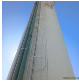
Foto 4 - Vista geral do reservatório.
