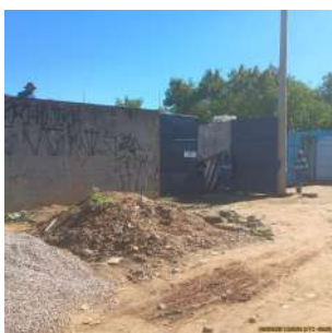
Foto 1 - Vista externa da EEAB.
