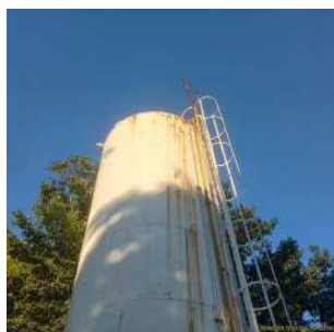
Foto 1 - Vista da parte superior do reservatório.
