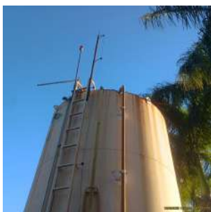
Foto 1 - Situação da parte superior do reservatório.
