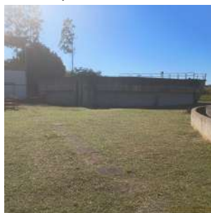
Foto 59 - Um dos tanques de adensamento de lodo.
