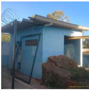
Foto 1 - Vista externa da casa de bombas.
