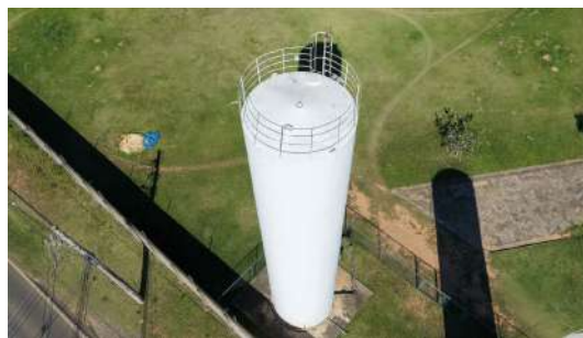
Foto 10 - Vista aérea do reservatório.
