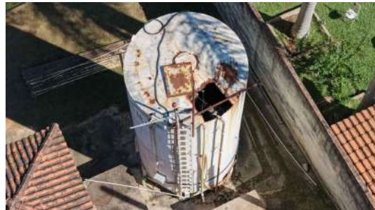
Foto 14 - Vista aérea do reservatório.
