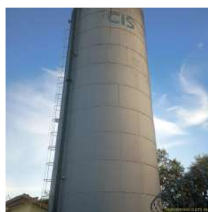
Foto 2 - Vista geral do reservatório.
