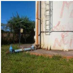
Foto 3 - Vista geral do reservatório.
