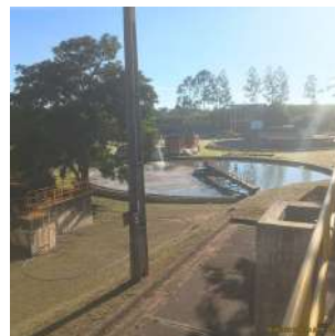
Foto 19 - Vista de um dos decantadores.
