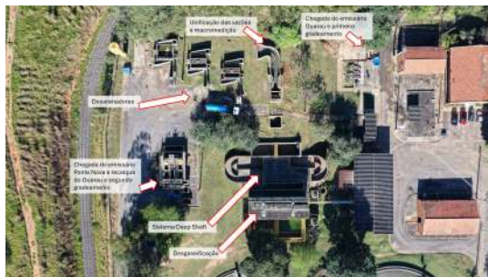
Foto 89 - Vista aérea de parte das estruturas da ETE.
