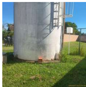
Foto 4 - Vista geral do reservatório.
