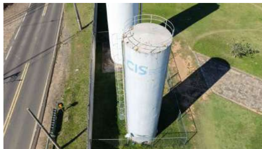
Foto 8 - Vista aérea do reservatório.
