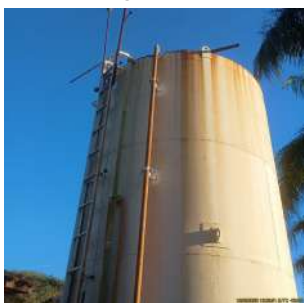
Foto 9 - Vista geral do reservatório.
