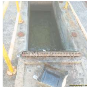
Foto 17 - Gradeamento do esgoto.
