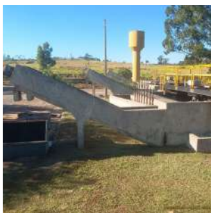
Foto 32 - Vista geral dos desarenadores.
