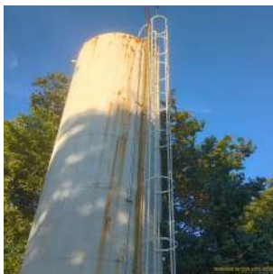
Foto 5 - Vista geral do reservatório.
