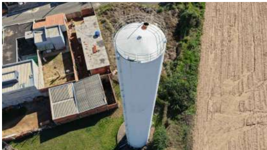
Foto 10 - Vista aérea geral do reservatório.
