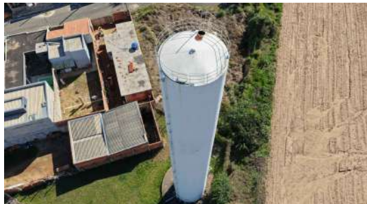
Foto 10 - Vista aérea geral do reservatório.
