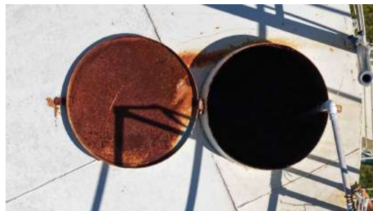
Foto 4 - Tampa de inspeção aberta.
