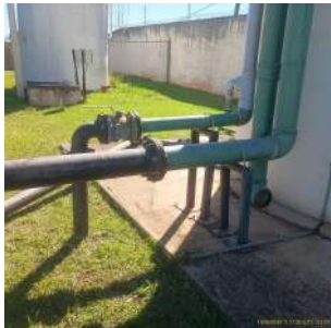
Foto 5 - Vista geral da base do reservatório.
