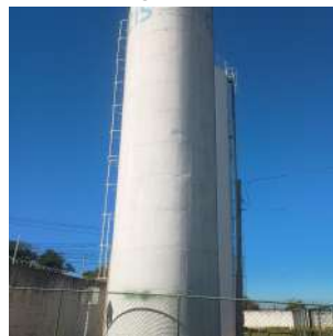
Foto 6 - Vista geral do reservatório.
