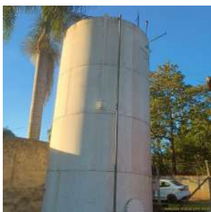
Foto 7 - Vista geral do reservatório.
