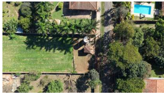
Foto 12 - Vista aérea geral do reservatório.
