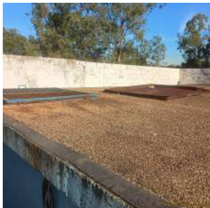
Foto 6 - Vista da cobertura do reservatório.
