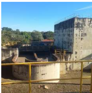
Foto 18 - Vista da estrutura externa do sistema Deep Shaft.
