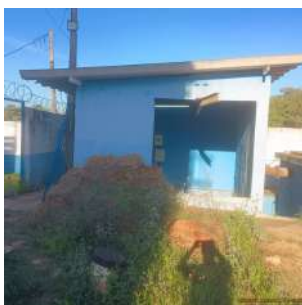
Foto 1 - Acúmulo de materiais (tapetes de grama) próximo à casa de bombas.
