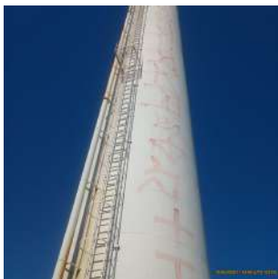
Foto 4 - Vista geral do reservatório.
