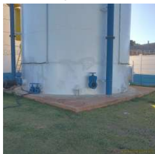
Foto 3 - Vista geral do reservatório.
