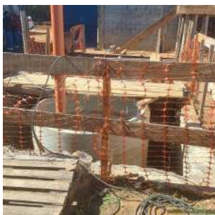
Foto 3 - Vista interna da EEAB.
