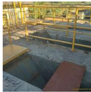
Foto 16 - Gradeamento do esgoto.
