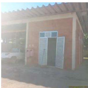
Foto 12 - Abrigo dos painéis elétricos e de comando de parte dos equipamentos da ETE Canjica (sopradores e compressores, recalque do esgoto vindo do Guaraú).
