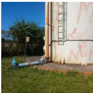
Foto 3 - Vista geral do reservatório.
