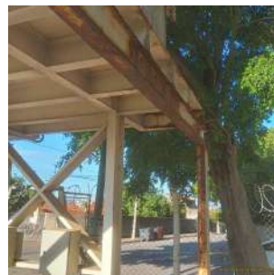
Foto 2 - Situação da base do reservatório.
