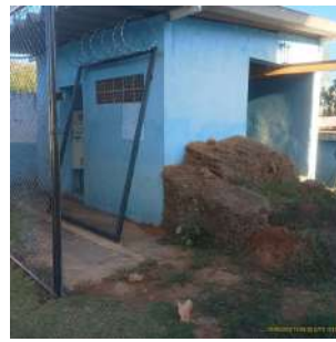
Foto 2 - Vista externa da casa de bombas.
