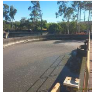
Foto 63 - Um dos tanques de adensamento de lodo.
