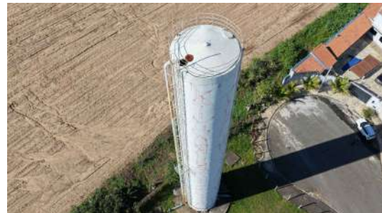
Foto 11 - Vista aérea geral do reservatório.
