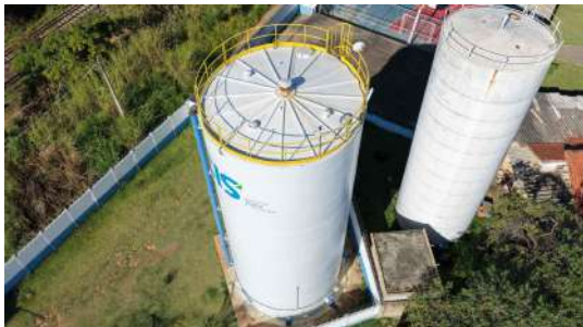
Foto 14 - Vista aérea do reservatório.
