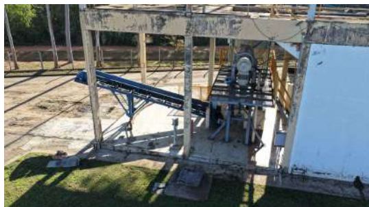
Foto 98 - Centrífuga de lodo.
