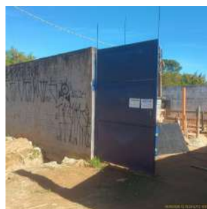
Foto 2 - Vista externa da EEAB.
