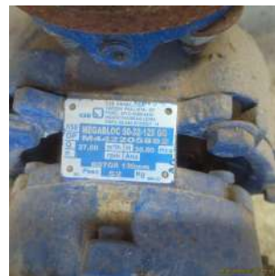
Foto 7 - Placa de especificações técnicas da bomba do conjunto 1.
