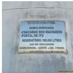
Foto 2 - Placa do reservatório, com especificações de volume e local de atendimento.
