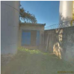
Foto 1 - Vista externa da casa de bombas.
