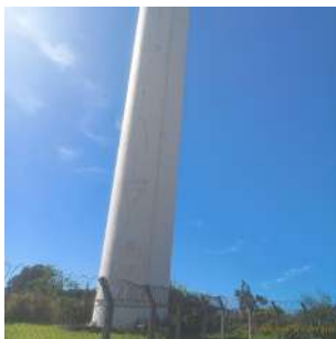
Foto 1 - Vista geral do reservatório.
