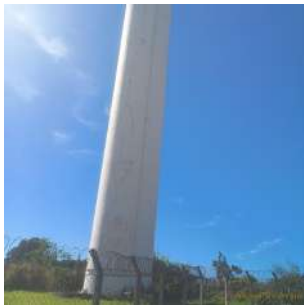
Foto 1 - Vista geral do reservatório.
