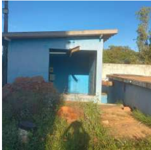
Foto 3 - Vista externa da casa de bombas.
