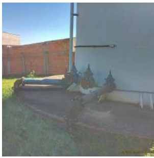
Foto 5 - Vista geral da base do reservatório.
