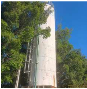
Foto 1 - Vista geral do reservatório.
