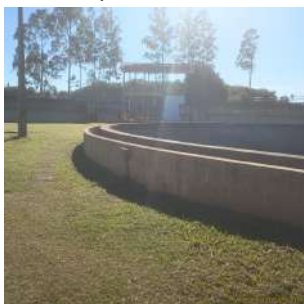
Foto 58 - Vista geral dos dois tanques de adensamento e, ao fundo, abrigo da centrífuga.
