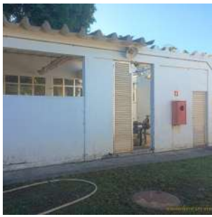
Foto 60 - Abrigo das bombas do lodo adensado para a centrífuga.
