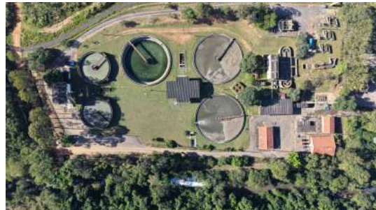
Foto 88 - Vista aérea geral da ETE.
