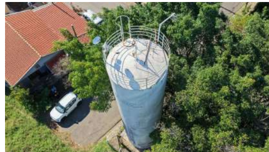
Foto 8 - Vista aérea do reservatório.
