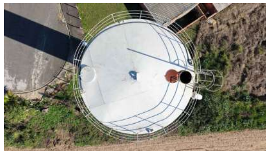
Foto 9 - Vista aérea da cobertura do reservatório.
