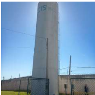
Foto 1 - Vista geral do reservatório.
