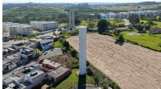
Foto 8 - Vista aérea geral do reservatório.
