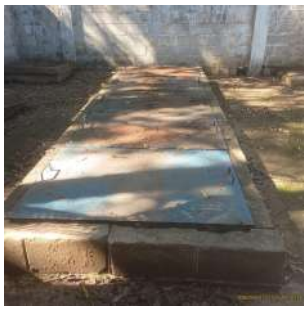
Foto 5 - Tampas de acesso ao poço seco das bombas.
