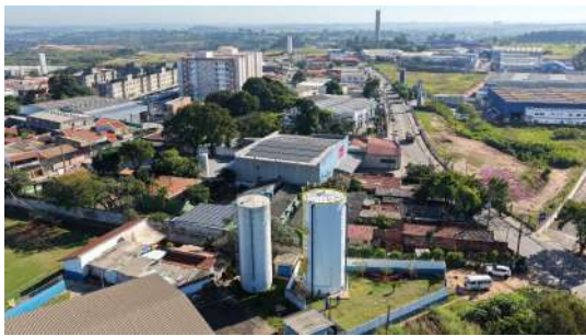
Foto 9 - Vista aérea geral da área (reservatório em operação no lado direito).
