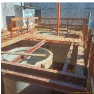
Foto 5 - Vista interna da EEAB.
