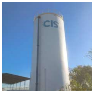
Foto 1 - Vista geral do reservatório.
