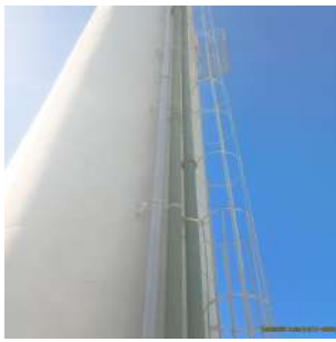
Foto 3 - Vista geral do reservatório.
