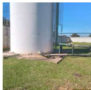
Foto 2 - Vista geral da base do reservatório.
