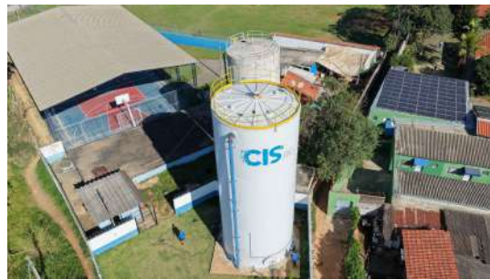
Foto 10 - Vista aérea do reservatório.
