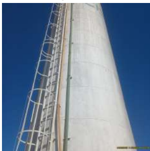
Foto 5 - Vista geral do reservatório.
