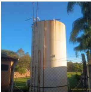
Foto 1 - Vista geral do reservatório.
