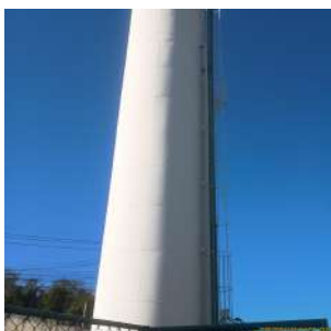
Foto 1 - Vista geral do reservatório.
