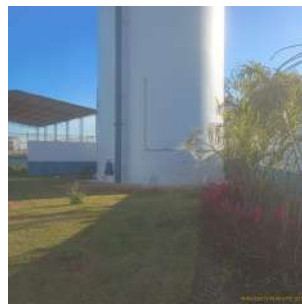
Foto 2 - Vista geral do reservatório.
