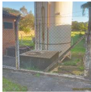
Foto 2 - Vista geral do reservatório.
