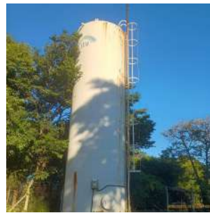
Foto 2 - Vista geral do reservatório.
