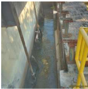
Foto 15 - Ponto de chegada do emissário da Ponte Nova e do recalque do emissário Guaruaú.
