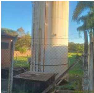
Foto 3 - Vista geral do reservatório.
