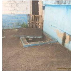
Foto 4 - Caixa de registros/passagem com fechamento adequado da tampa de concreto.
