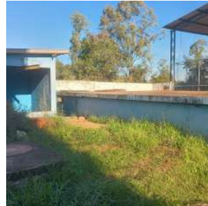
Foto 3 - Vista lateral do reservatório enterrado.
