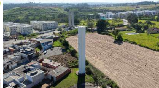
Foto 8 - Vista aérea geral do reservatório.
