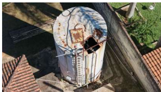
Foto 2 - Situação da cobertura do reservatório.
