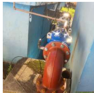
Foto 9 - Vista lateral do reservatório enterrado.
