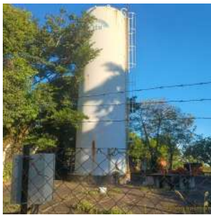
Foto 1 - Vista geral do reservatório.
