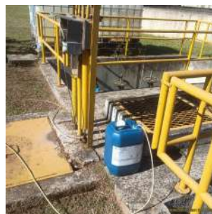
Foto 72 - Dosagem de antiespumante no efluente tratado.
