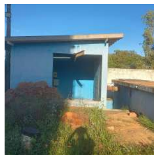
Foto 2 - Acúmulo de materiais próximo à casa de bombas.
