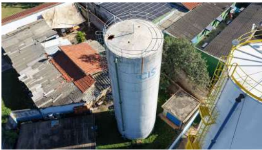
Foto 5 - Vista aérea do antigo reservatório - desativado.
