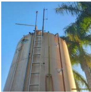
Foto 11 - Vista geral do reservatório.
