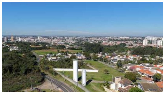
Foto 7 - Vista aérea dos reservatórios, sendo o da direita (menor) o objeto desta ficha.
