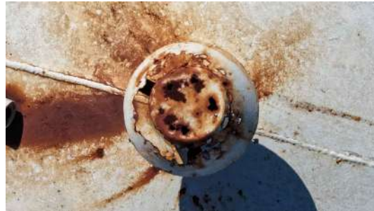
Foto 4 - Chapéu (cobertura) do tubo de ventilação do reservatório.
