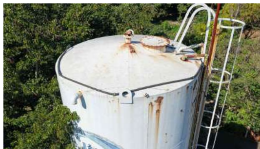
Foto 11 - Vista aérea do reservatório.
