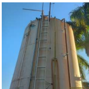
Foto 1 - Escada vertical do reservatório.
