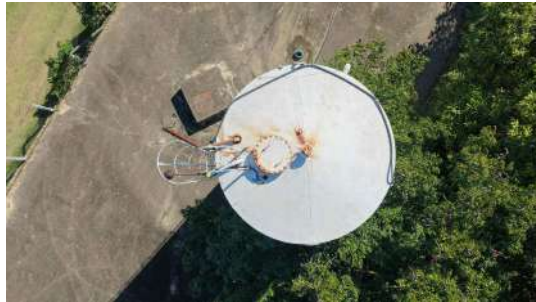
Foto 3 - Chapéu (cobertura) do tubo de ventilação do reservatório.
