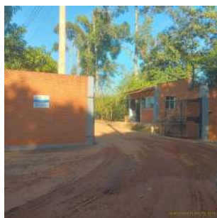
Foto 1 - Entrada da ETE e identificação.
