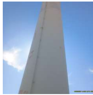
Foto 6 - Vista geral do reservatório.
