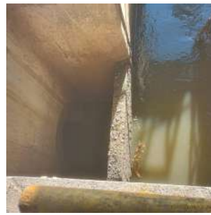
Foto 8 - Estrutura que permite transbordo e lançamento de esgoto no curso d'água na chegada do emissário Guaraú.
