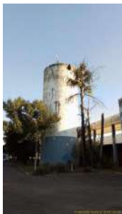
Foto 10 - Reservatório abastecido pela elevatória.
