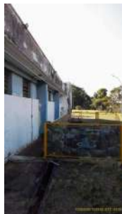
Foto 1 - Barriletes da elevatória.
