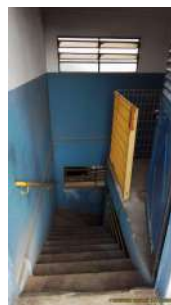
Foto 12 - Acesso à casa de bombas.
