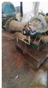
Foto 4 - Vazamento.
