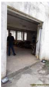
Foto 7 - Entrada da casa de bombas nova.
