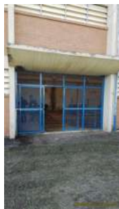
Foto 1 - Acesso à elevatória.
