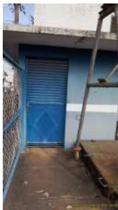
Foto 1 - Entrada da elevatória.
