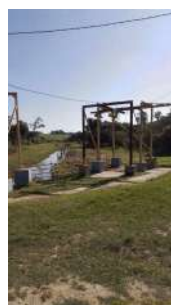
Foto 2 - Tomada de água da captação.
