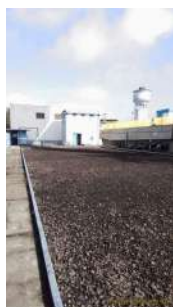
Foto 3 - Visão geral do reservatório. ETA à direita.
