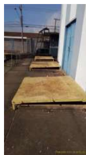
Foto 2 - Tampas de inspeção junto à elevatória..
