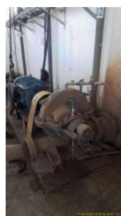
Foto 7 - Bomba da casa velha
