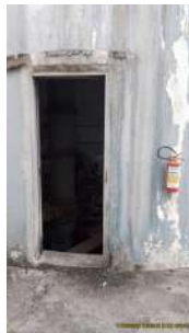
Foto 1 - Acesso à elevatória.
