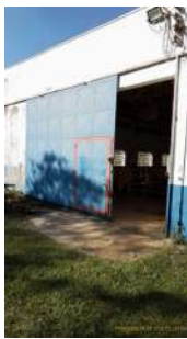
Foto 16 - Acesso Casa de Bombas nova
