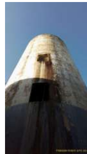
Foto 2 - Reservatório abastecido pela elevatória.
