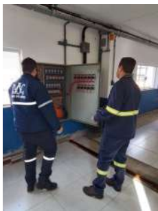
Foto 2 - Inspeção sendo realizada nos painéis dos filtros.
