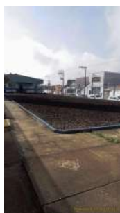
Foto 1 - Visão geral do reservatório enterrado.
