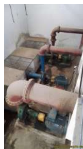
Foto 4 - Casa de bombas da elevatória.
