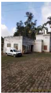
Foto 16 - Casa de bombas nova
