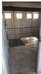
Foto 10 - Acesso à casa de bombas
