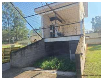
Foto 2 - Unidade de desidratação de lodo sem uso
