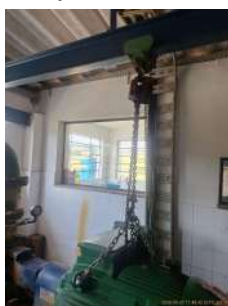
Foto 5 - Içamento de emergência e manutenção de bombas
