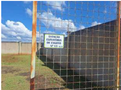
Foto 1 - Identificação da área e cercamento
