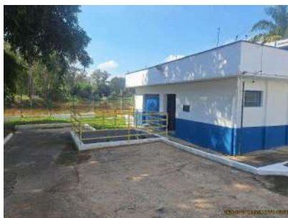
Foto 1 - Visão geral - casa de bombas e represa
