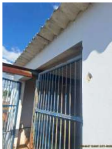
Foto 6 - Acesso aos conjuntos moto-bomba
