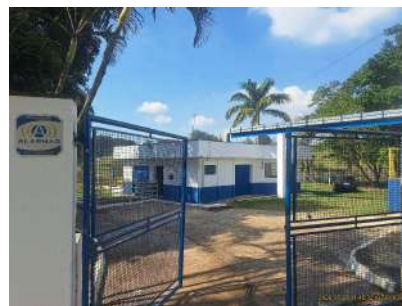
Foto 2 - Entrada da captação.
