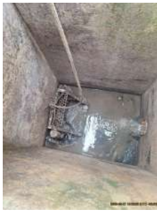
Foto 5 - Gradeamento com cesto
