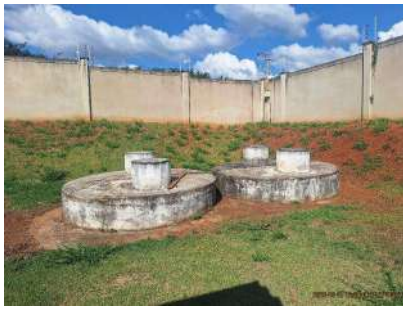
Foto 5 - Tanques pulmões
