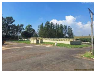
Foto 12 - Visão geral - reatores anaeróbios seguidos por filtros percoladores
