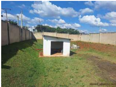
Foto 2 - Casa de bombas
