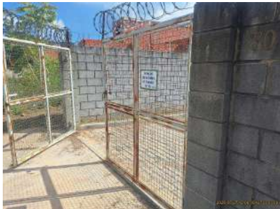
Foto 1 - Portão de acesso, identificação e cercamento de área
