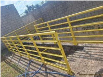
Foto 3 - Guarda-corpos instalados
