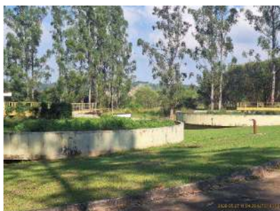
Foto 5 - Decantador secundário com cobertura de vegetação
