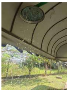
Foto 11 - Chuveiro em funcionamento
