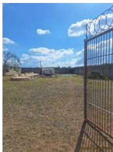
Foto 1 - Portão de entrada à área da estação elevatória
