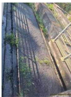
Foto 1 - Resíduos sólidos acumulados no reator biológico anaeróbio
