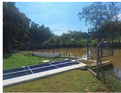
Foto 9 - Represa da captação
