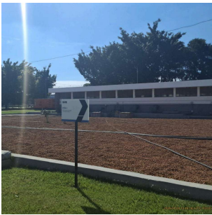
Foto 1 - Vista frontal do reservatório ETA I
