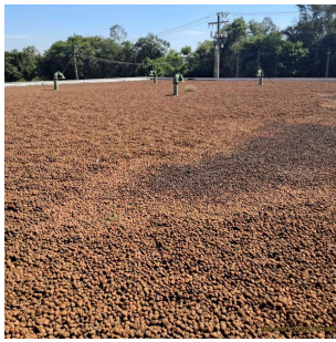
Foto 5 - Vista da cobertura do reservatório
