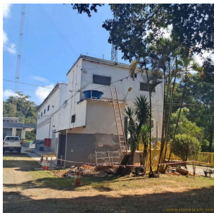
Foto 1 - Vista frontal da reforma para construção do vestiário e refeitório
