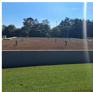
Foto 1 - Vista lateral do reservatório
