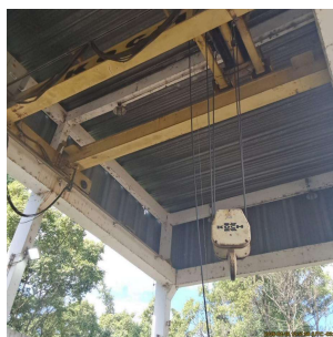
Foto 8 - Reforma da ponte rolante
