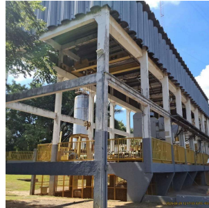
Foto 7 - Vista externa da captação
