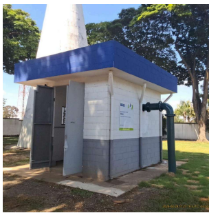
Foto 1 - Vista externa do booster
