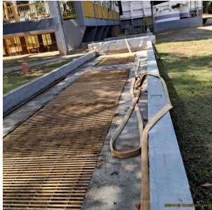
Foto 6 - Tomada de água
