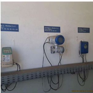
Foto 3 - Display dos medidores de vazão
