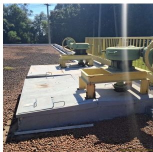
Foto 3 - Tampa de inspeção
