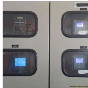
Foto 16 - Equipamentos de processo Turbidez Bruta, Cloro , Flúor,pH
