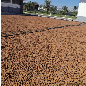
Foto 5 - Vista da cobertura do reservatório
