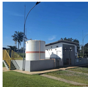
Foto 18 - Armazenamento de Dióxido de Cloro
