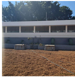
Foto 4 - Tampas de inspeção
