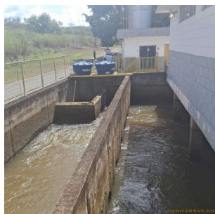
Foto 3 - Chegada da água da captação
