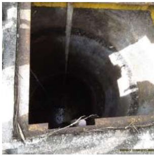
Foto 3 - Poço úmido
