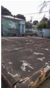
Foto 9 - Vista geral do reservatório
