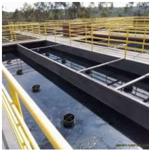
Foto 19 - Tanques anaeróbios
