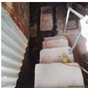
Foto 9 - Antiga casa de bombas conduzindo esgoto para o ladrão
