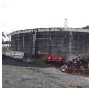
Foto 1 - Vista geral do reservatório
