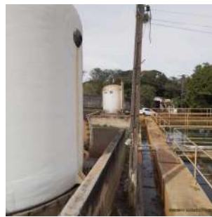
Foto 21 - Tanque de Ácido Fluossilílico
