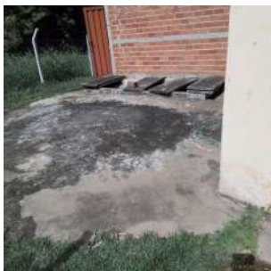
Foto 7 - Vista geral do poço úmido
