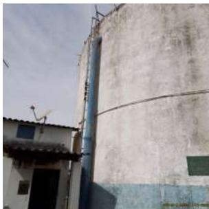
Foto 5 - Tubulação de entrada e escada de acesso em desuso
