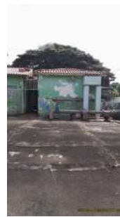
Foto 8 - Vista geral do reservatório
