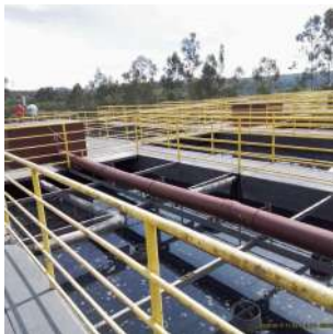
Foto 15 - Tanque anaeróbio
