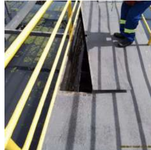
Foto 22 - Saída do tanque anaeróbio
