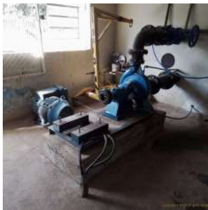
Foto 1 - Conjunto motobomba desmontado
