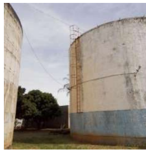
Foto 2 - Vista geral do reservatório e escada de acesso
