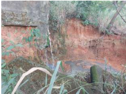
Foto 1 - Lançamento de esgoto in natura devido a não operação da EEEB Bela Vista 3
