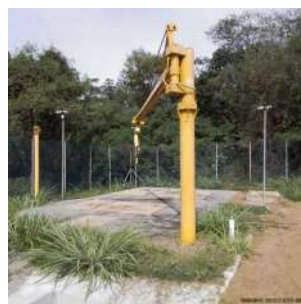
Foto 2 - Guindaste Giratório de Coluna para içamento das bombas
