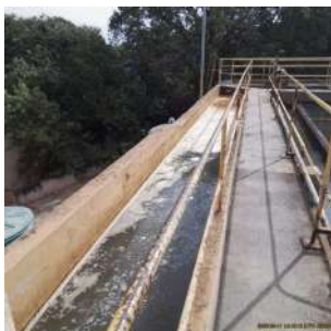
Foto 14 - Chegada da água bruta da ETA Nova
