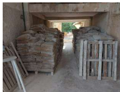
Foto 52 - Armazenamento de cal
