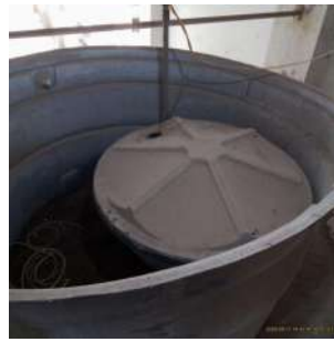
Foto 38 - Tanque de preparo do ácido fluossilícico
