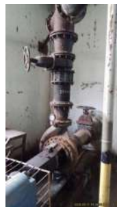
Foto 2 - Bomba centrífuga conduzindo água para o Santo Rizzo
