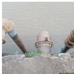
Foto 2 - Tubulação de sucção
