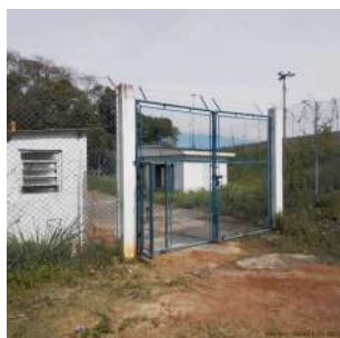
Foto 1 - Entrada da estação elevatória
