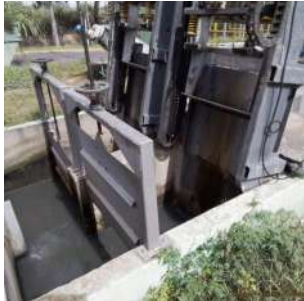
Foto 1 - Grade mecanizada
