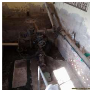
Foto 8 - Antiga casa de bombas conduzindo esgoto para o ladrão
