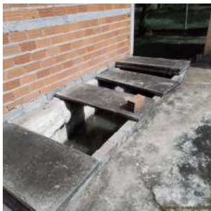
Foto 5 - Vista geral do poço úmido
