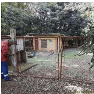
Foto 1 - Entrada da Estação Elevatória
