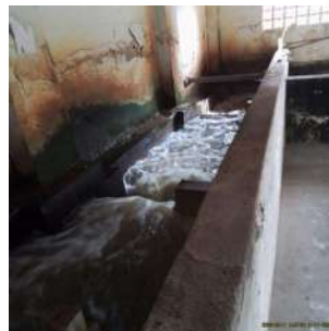
Foto 7 - Misturador hidráulico para início de formação dos flocos
