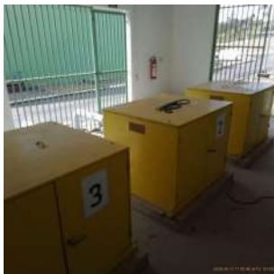
Foto 25 - Aeradores do tanque aeróbio
