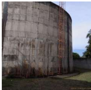
Foto 1 - Vista geral do reservatório
