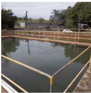
Foto 10 - Decantador da ETA Velha
