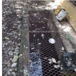
Foto 6 - Passagem de esgoto
