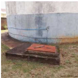
Foto 3 - Tampa de inspeção de acesso à válvula
