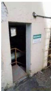
Foto 13 - Acesso a Sala de Recalque
