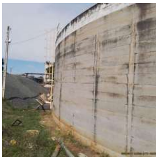
Foto 7 - Vista geral do reservatório
