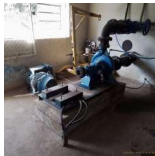
Foto 2 - Conjunto motobomba desmontado
