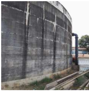
Foto 3 - Vista geral do reservatório
