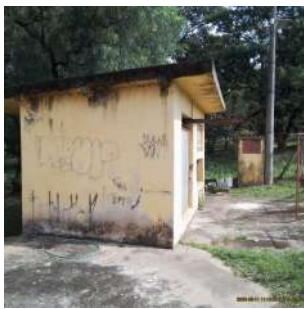
Foto 3 - Casa de bombas desativada
