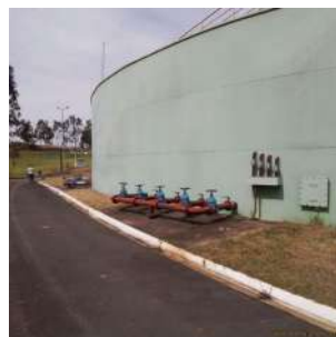
Foto 32 - Vista geral em torno do tanque
