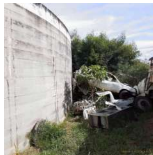
Foto 8 - Vista geral do reservatório
