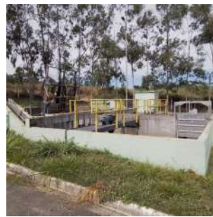
Foto 10 - Vista geral do tratamento preliminar
