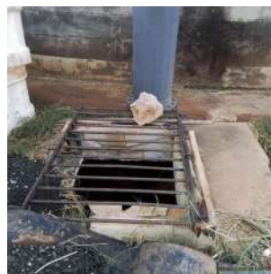
Foto 2 - Saída do extravasor
