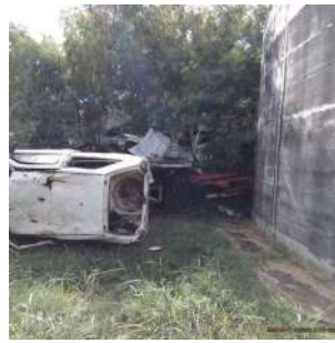
Foto 4 - Vista geral do reservatório
