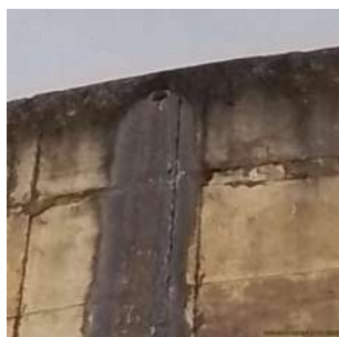
Foto 3 - Água de drenagem de cima do reservatório
