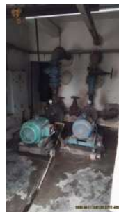
Foto 2 - Vista geral da casa de bombas
