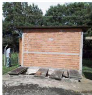
Foto 4 - Casa de bombas atual
