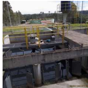
Foto 4 - Desarenador em manutenção
