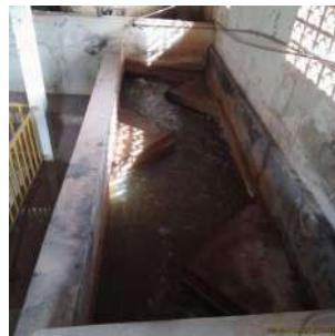
Foto 4 - Chicanas após a pré-oxidação
