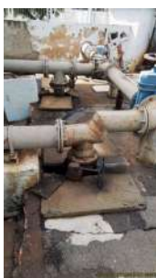
Foto 1 - Tampa de inspeção com aberturas
