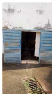
Foto 8 - Acesso para a Estação Elevatória
