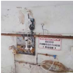
Foto 39 - Bomba dosadora do ácido fluossilícico
