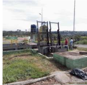
Foto 2 - Vista geral do tratamento preliminar
