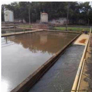
Foto 12 - Vista Geral ETA Velha
