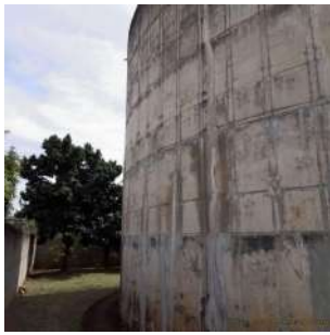
Foto 8 - Vista geral do reservatório
