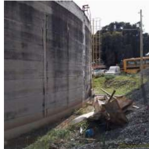
Foto 6 - Vista geral do reservatório
