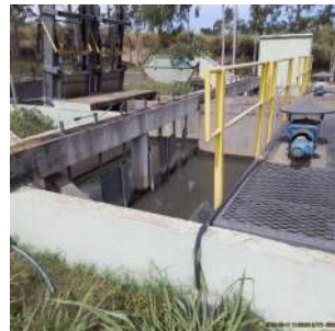
Foto 6 - Vista geral do tratamento preliminar
