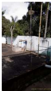
Foto 1 - Vista geral do reservatório
