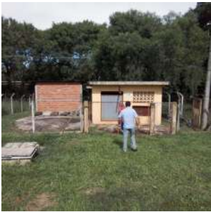
Foto 1 - Entrada da estação elevatória
