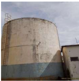
Foto 1 - Vista geral do reservatório
