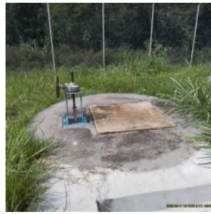
Foto 4 - Vista geral do poço úmido
