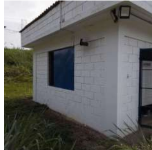
Foto 6 - Lateral da casa do gerador
