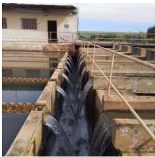
Foto 20 - Coleta da água decantada
