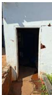
Foto 2 - Entrada da EEAT.
