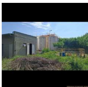
Foto 32 - Vista da ETE.
