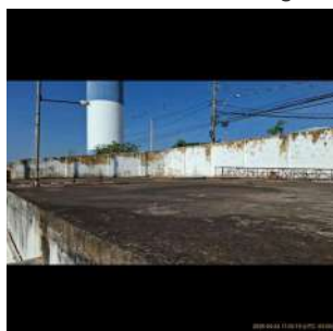
Foto 7 - Laje de cobertura do reservatório.
