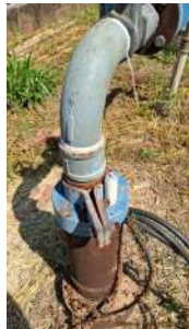
Foto 3 - Tubo de medição de nível.
