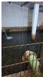
Foto 1 - Vista interna do reservatório.
