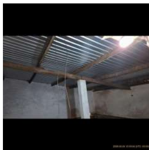
Foto 3 - Nova cobertura do reservatório.
