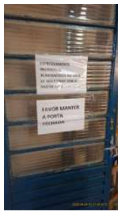
Foto 9 - Porta de entrada da EEA e do reservatório.
