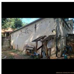
Foto 5 - Vista traseira do reservatório.
