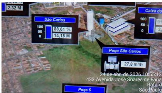
Foto 1 - CCO com o nível do reservatório.
