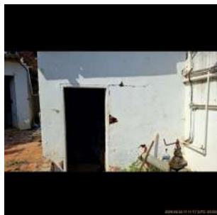
Foto 3 - Vista geral da EEAT.
