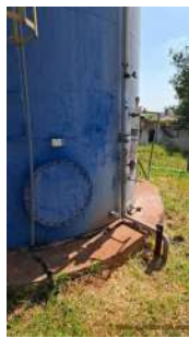
Foto 5 - Tubulação de entrada com sistema de tratamento.
