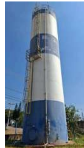
Foto 7 - Vista do reservatório.
