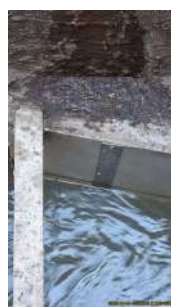
Foto 4 - Medição da calha Parshall.
