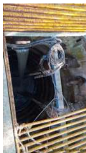
Foto 9 - Poço da elevatória.
