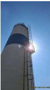
Foto 3 - Detalhe da escada e passarela de descanso.
