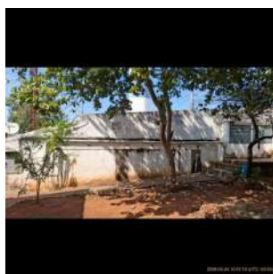
Foto 1 - Vista do reservatório.
