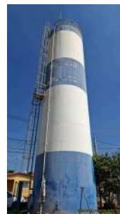
Foto 9 - Vista geral do reservatório.
