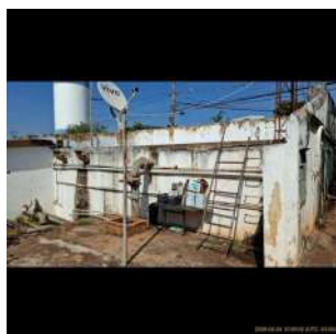
Foto 3 - Vista traseira do reservatório.
