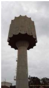
Foto 1 - Visão geral do reservatório.
