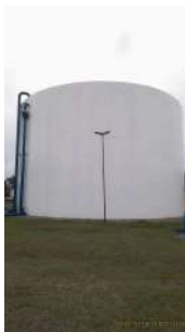
Foto 1 - Visão geral do reservatório.
