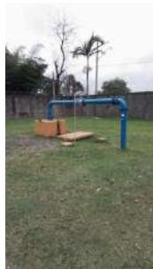
Foto 1 - Visão geral do poço.
