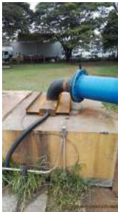
Foto 2 - Sucção com bomba submersa.
