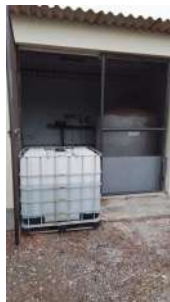
Foto 2 - Abrigo dos produtos químicos.
