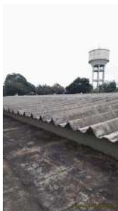
Foto 5 - Cobertura do reservatório.
