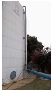
Foto 4 - Alimentação do reservatório.
