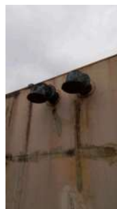
Foto 6 - Extravasores do reservatório em uso.
