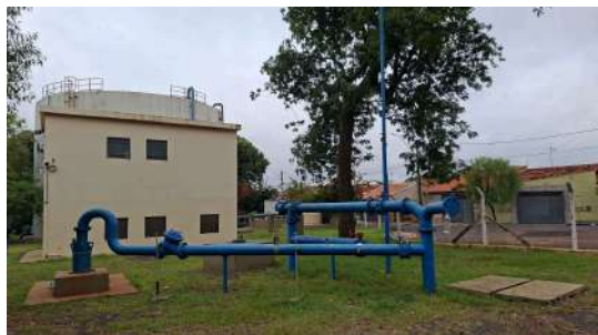
Foto 5 - Poço Iguatemi e R25 ao fundo.
