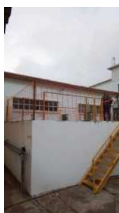
Foto 1 - Local sinalizado onde haverá substituição de guarda-corpo.
