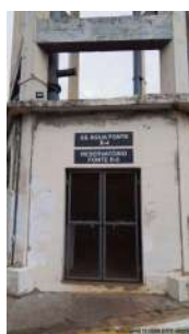
Foto 1 - Entrada da casa de bombas, situada sob o reservatório R6
