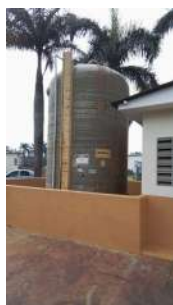
Foto 26 - Armazenamento de tanino, coagulante utilizado.
