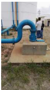
Foto 1 - Visão geral do poço, que abastece o R45.
