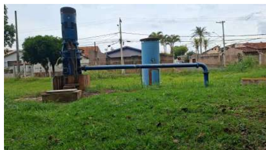
Foto 6 - Visão geral do poço.
