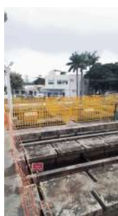
Foto 2 - À frente, área ainda sem guarda-corpo; ao fundo, módulo já com novos guarda-corpos.
