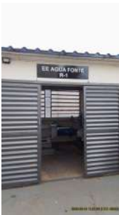
Foto 1 - Entrada da elevatória e identificação.
