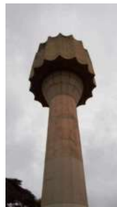
Foto 4 - Visão geral do reservatório.
