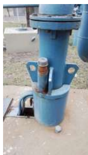
Foto 1 - Tubo para medição do nível.
