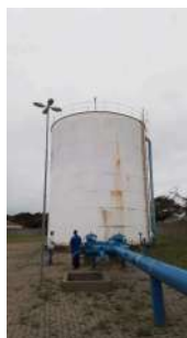
Foto 2 - Visão geral do reservatório.
