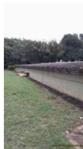
Foto 7 - Lateral do reservatório.
