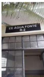
Foto 1 - Entrada e placa de identificação da elevatória.
