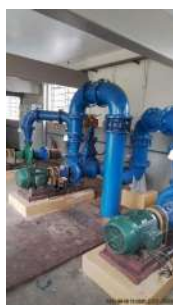
Foto 6 - Bombas que recalcam para o R6.
