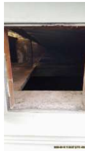
Foto 4 - Interior do reservatório.
