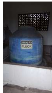
Foto 2 - Armazenamento de flúor.
