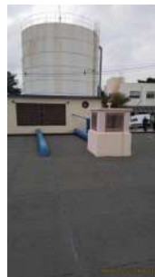
Foto 5 - R1, casa de bombas 1 e R39 ao fundo.
