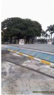
Foto 1 - Visão geral do reservatório.
