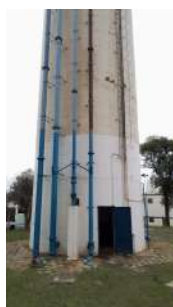
Foto 1 - Visão geral do reservatório e acesso à elevatória.
