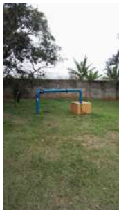
Foto 1 - Visão geral do poço.
