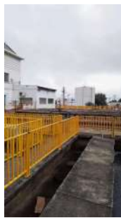
Foto 4 - Padrão dos novos guarda-corpos da ETA.
