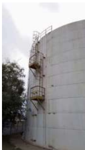
Foto 3 - Escada de manutenção.
