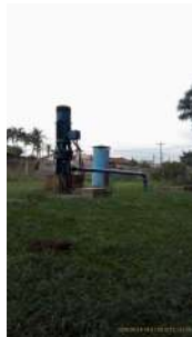
Foto 1 - Visão geral do poço.
