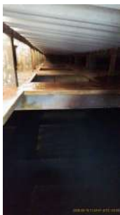
Foto 6 - Interior do reservatório.
