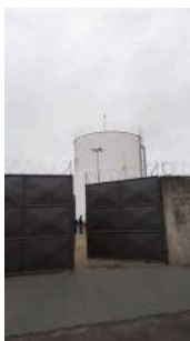
Foto 1 - Portão de acesso.
