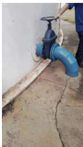
Foto 5 - Saída do reservatório.
