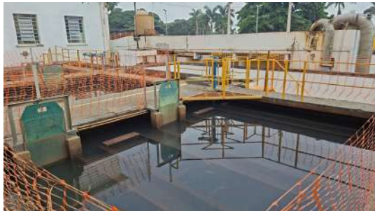
Foto 5 - Parte dos filtros onde serão instalados novos guarda-corpos.
