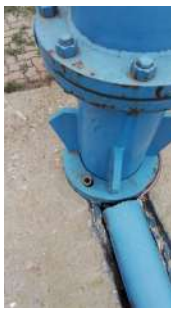
Foto 1 - Tubo para medição do nível.
