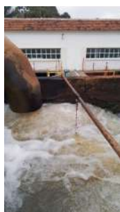
Foto 11 - Entrada de água bruta e aplicação de tanino, coagulante utilizado.
