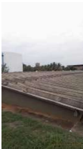
Foto 4 - Dispositivos para ventilação.
