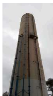
Foto 2 - Visão geral do reservatório.
