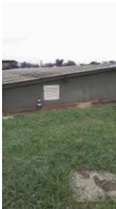
Foto 2 - Tampa para inspeção.
