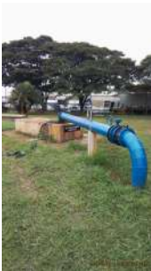
Foto 1 - Visão geral da elevatória.
