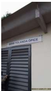
Foto 1 - Placa de identificação da elevatória.
