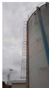
Foto 10 - Escada para manutenção.
