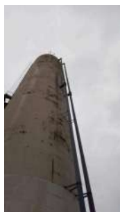
Foto 1 - Extravasores das câmaras inferior e superior.
