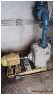
Foto 4 - Bomba centrífuga.
