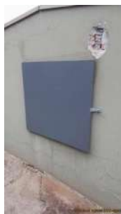
Foto 1 - Tampa de inspeção.
