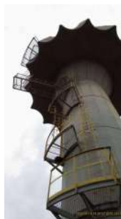
Foto 4 - Escada de acesso para manutenção.
