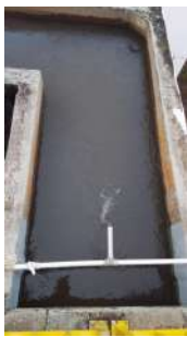
Foto 1 - Pré-cloração antes da decantação.
