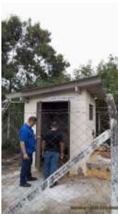
Foto 1 - Visão geral da elevatória.
