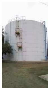
Foto 2 - Visão geral do reservatório.
