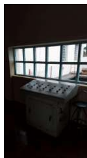
Foto 4 - Mesa de controle de um dos filtros: 6 no total
