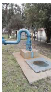
Foto 1 - Visão geral do poço.
