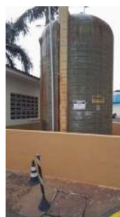
Foto 25 - Armazenamento de tanino, coagulante utilizado.
