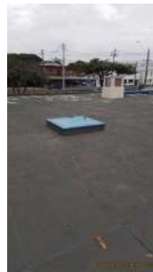
Foto 4 - Tampa de inspeção.
