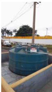
Foto 20 - Armazenamento de flúor.
