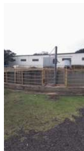
Foto 4 - Tanque de equalização.
