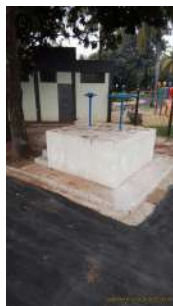
Foto 1 - Caixa do extravasor.
