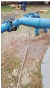
Foto 3 - Aplicação na entrada do reservatório R8, abastecido pelos poços A e B.
