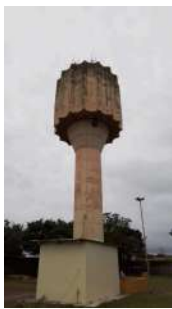
Foto 1 - Visão geral do reservatório.
