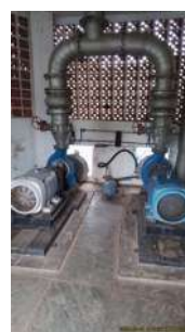
Foto 2 - As bombas abastecem o R6 a partir do R4.
