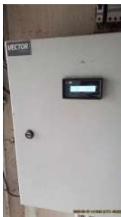
Foto 3 - Display da telemetria.
