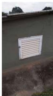
Foto 6 - Tampa para inspeção.
