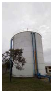
Foto 11 - Visão geral do reservatório e captor do SPDA na cobertura.
