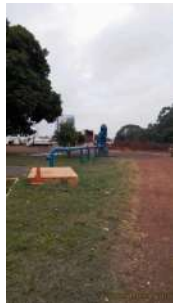
Foto 1 - Visão geral do poço.
