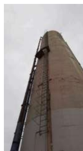
Foto 5 - Escada de acesso para manutenção.
