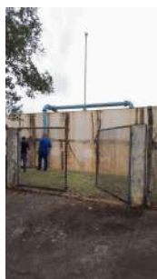
Foto 1 - Portão de acesso.
