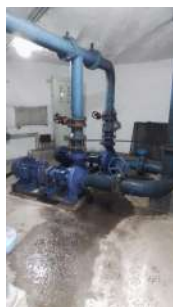
Foto 9 - Visão geral da elevatória.
