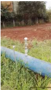
Foto 2 - Medidor de vazão na saída.
