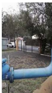
Foto 3 - Portão de acesso.
