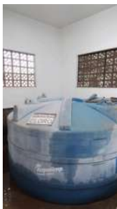
Foto 3 - Armazenamento de cloro.
