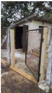
Foto 2 - Portão de entrada.
