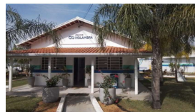
Foto 2 - Fachada do ponto de atendimento
