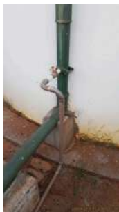
Foto 11 - Inserção do reagente hipoclorito na linha.
