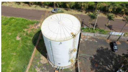
Foto 22 - Vista geral do reservatório.
