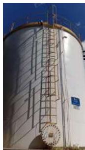
Foto 9 - Escada e guarda corpo instalados no reservatório.
