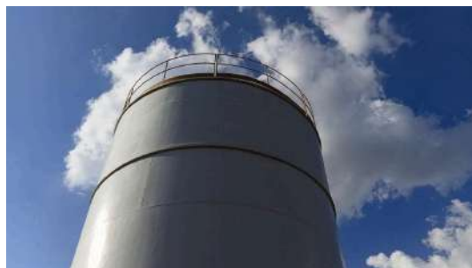
Foto 15 - Vista da parte superior do reservatório.
