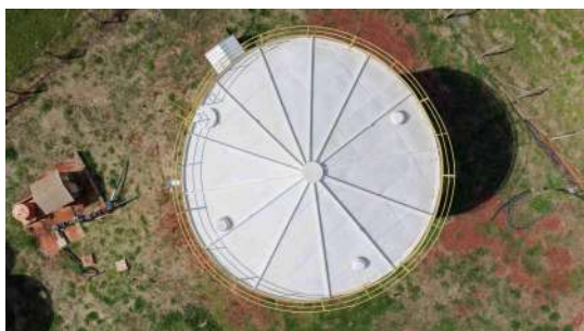
Foto 14 - Vista superior do reservatório.
