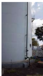
Foto 14 - Vista geral do reservatório.
