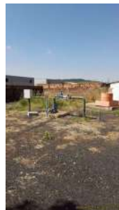
Foto 2 - Vista geral da captação.
