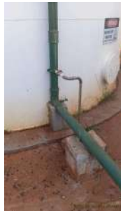
Foto 8 - Tubulação de alimentação do reservatório.
