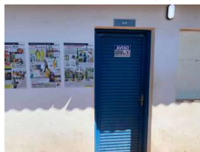
Foto 22 - Acesso ao CCO da SANEL.
