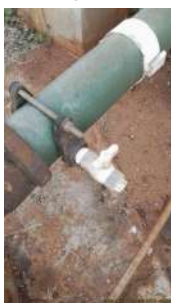
Foto 6 - Torneira para coleta de água bruta instalada na captação.
