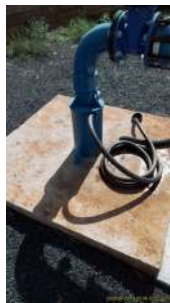
Foto 4 - Vista geral da captação.
