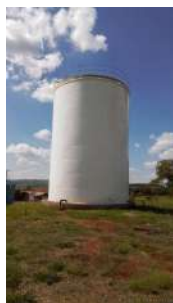
Foto 6 - Vista geral do reservatório.
