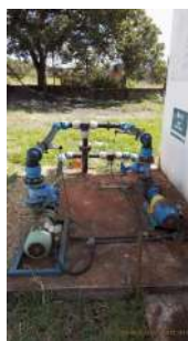
Foto 2 - Vista geral da captação.
