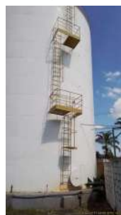
Foto 15 - Escadas e guarda corpos.
