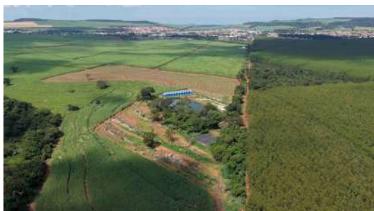
Foto 61 - Vista geral da área onde se localiza a ETE.
