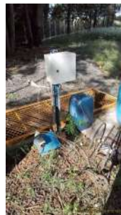
Foto 44 - Dispositivo para adição de antiespumante, empregado um ano atrás, quando não havia aeração.
