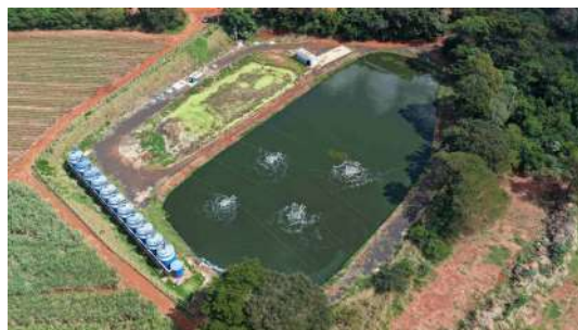
Foto 62 - Vista superior da ETE.
