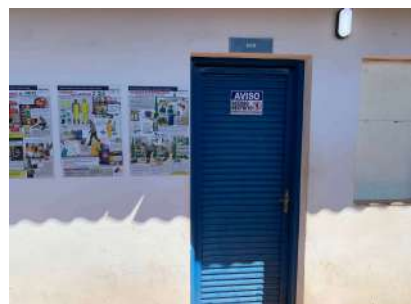
Foto 25 - Acesso ao CCO da SANEL.
