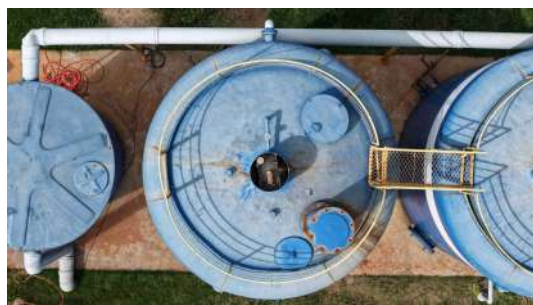
Foto 67 - Vista superior de um UASB.
