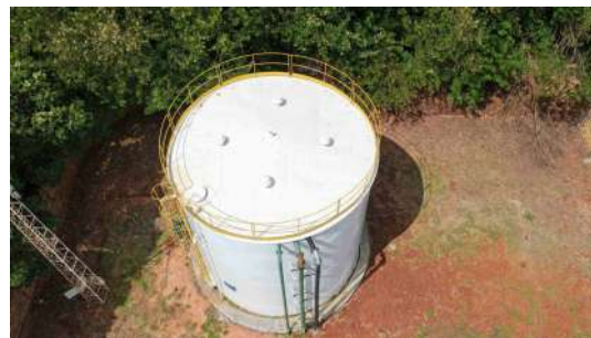
Foto 21 - Vista geral do reservatório.
