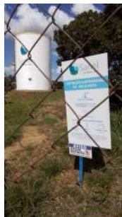
Foto 1 - Placa com identificação do local e reservatório ao fundo.
