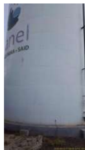
Foto 13 - Vista geral do reservatório.
