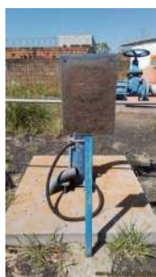
Foto 1 - Placa ilegível ao lado do poço.
