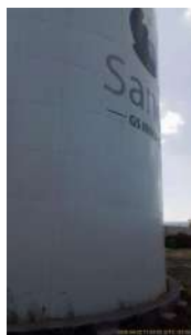
Foto 12 - Vista geral do reservatório.
