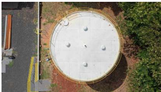
Foto 18 - Vista superior do reservatório.
