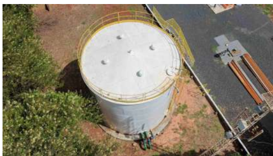
Foto 22 - Vista geral do reservatório.
