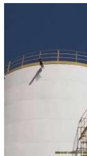
Foto 2 - Tubo extravasor próximo ao topo.
