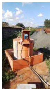
Foto 7 - Reservatório para reagente utilizado na fluoretação da água.
