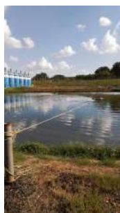
Foto 35 - Ancoragem do aerador 2.
