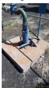
Foto 3 - Laje ao redor do tubo de saída.
