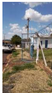
Foto 3 - Cercamento da área com alambrado e portão metálico.
