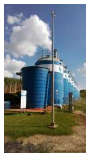
Foto 27 - Vista geral dos UASBs.
