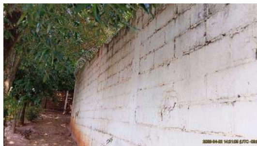
Foto 3 - Vista do muro de cercamento da unidade a partir do passeio público.
