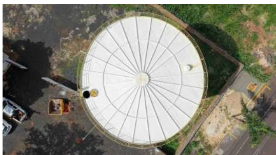
Foto 18 - Vista superior do reservatório.
