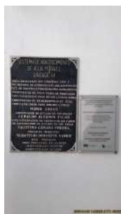
Foto 21 - Placas de identificação com marcos temporais da instalação.
