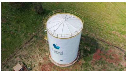
Foto 18 - Vista geral do reservatório.
