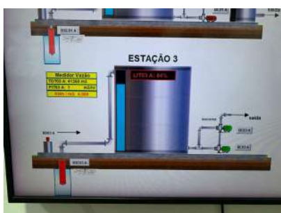
Foto 22 - Detalhes do reservatório 3 no CCO.
