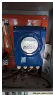
Foto 14 - Interface do macromedidor.
