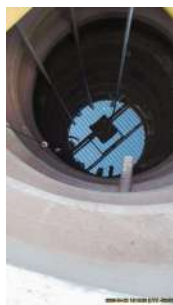
Foto 49 - Poço na unidade de tratamento de lodo.
