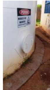
Foto 7 - Tampa de inspeção localizada na parte inferior do costado.
