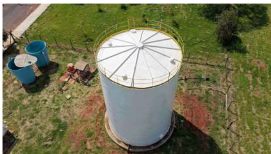
Foto 16 - Vista geral do reservatório.
