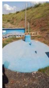
Foto 16 - Tanque de equalização após o tratamento preliminar.
