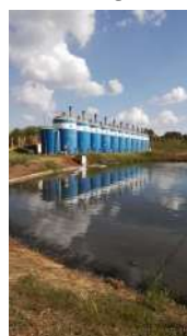
Foto 34 - Vista geral da lagoa e UASBs ao fundo.
