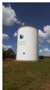
Foto 5 - Vista geral do reservatório.
