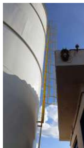
Foto 11 - Escada e guarda corpo instalados no reservatório.
