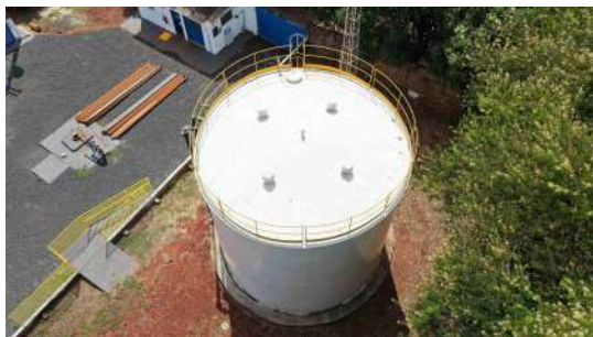
Foto 20 - Vista geral do reservatório.
