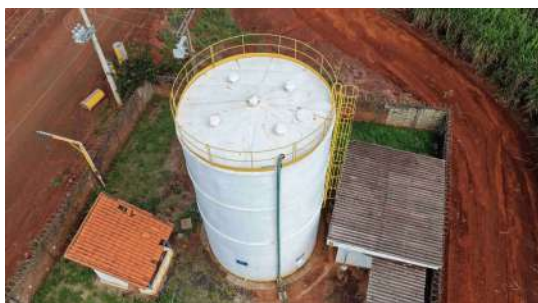
Foto 20 - Vista geral do reservatório.
