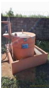
Foto 8 - Reservatório para reagente utilizado na fluoretação da água.
