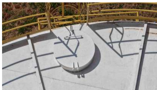
Foto 15 - Tampa de inspeção localizada na parte superior do reservatório.
