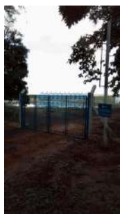
Foto 1 - Portão de entrada da área, evidenciando cercamento com alambrado.
