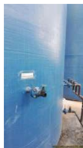
Foto 23 - Saída para coleta de amostra de efluente.
