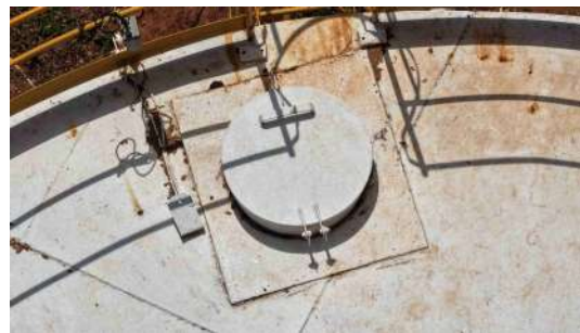
Foto 19 - Tampa de inspeção do reservatório.
