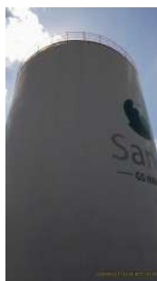
Foto 10 - Vista geral do reservatório.
