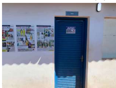
Foto 27 - Acesso ao CCO da SANEL.
