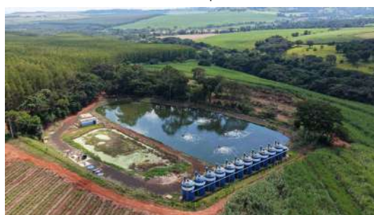
Foto 63 - Vista geral da ETE.
