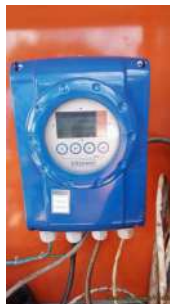
Foto 8 - Interface do macromedidor.
