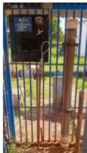
Foto 6 - Dosador de reagente cloro.
