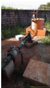
Foto 4 - Vista geral da captação.
