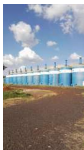
Foto 19 - UASBs da unidade. Cada unidade recebe 3L/s de efluente, mas sua capacidade nominal é 4,7L/s.
