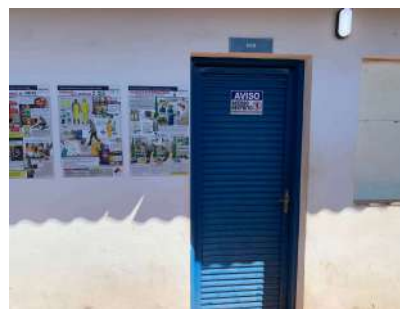
Foto 23 - Acesso ao CCO da SANEL.
