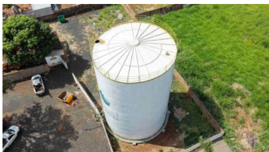
Foto 20 - Vista geral do reservatório.
