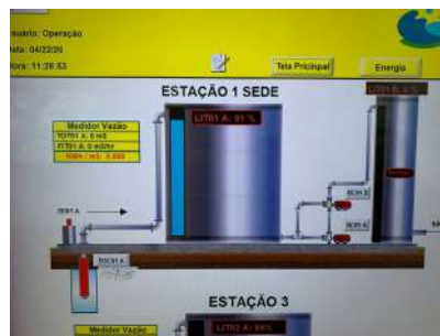
Foto 29 - Detalhes do poço 1 no CCO.
