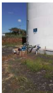
Foto 1 - Vista geral da unidade.
