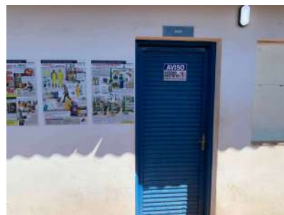
Foto 23 - Acesso ao CCO da SANEL.
