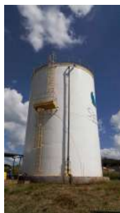
Foto 8 - Tubo extravasor próximo ao topo.
