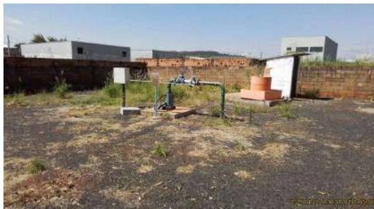
Foto 1 - Vista geral da captação.
