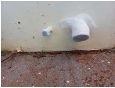
Foto 6 - Registro fotográfico enviado pelo prestador em 08/05/2026, via e-mail, evidenciando instalação de tela na abertura do extravasor do reservatório.
