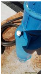
Foto 5 - Tubo para medição de nível.
