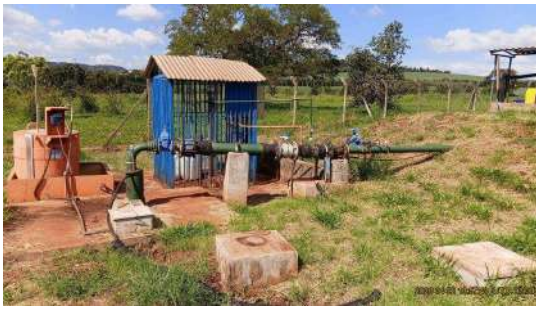
Foto 1 - Vista geral da captação.
