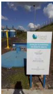
Foto 15 - Tanque de equalização após o tratamento preliminar.
