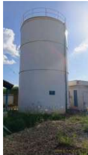
Foto 6 - Vista geral do reservatório, evidenciando guarda corpo na parte superior.
