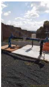
Foto 3 - Vista geral da captação.
