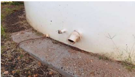
Foto 1 - Tela rompida na saída do extravasor.
