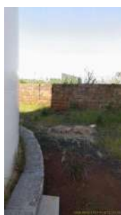
Foto 7 - Cercamento com muro ao redor da unidade.
