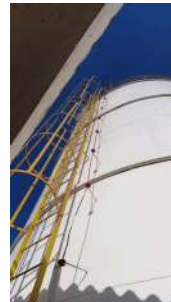
Foto 9 - Descida do condutor do SPDA.
