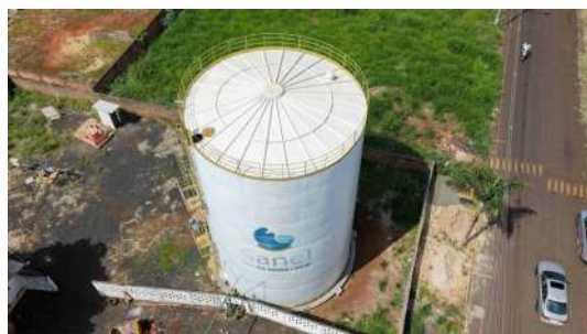
Foto 19 - Vista geral do reservatório.
