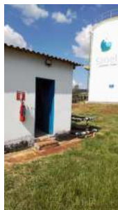
Foto 9 - Edificação que abriga os painéis elétricos da EEA.
