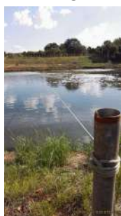
Foto 33 - Ancoragem do aerador 1.
