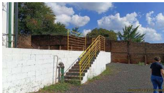
Foto 6 - Escada e guarda corpo para acesso ao patamar do terreno onde está instalado o reservatório.
