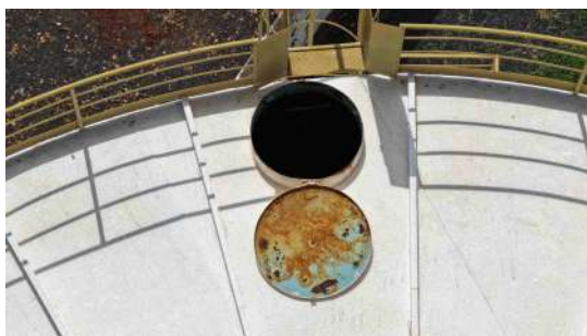
Foto 1 - Tampa de inspeção aberta na parte superior do reservatório.
