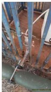
Foto 9 - Inserção do reagente fluoreto na linha.
