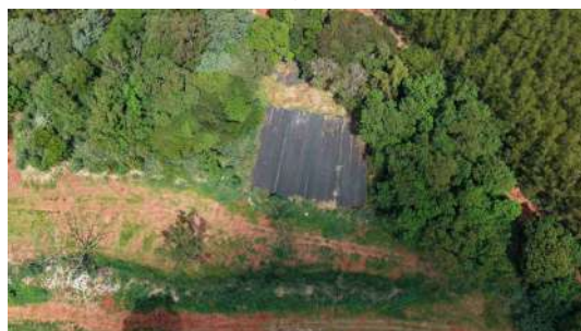
Foto 71 - Bags de lodo armazenados ao lado da unidade.
