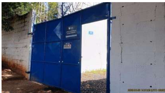
Foto 1 - Vista da unidade a partir do passeio público, indicando fechamento com portão metálico e muro.
