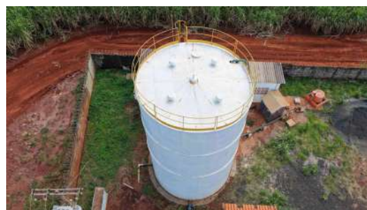
Foto 19 - Vista geral do reservatório.
