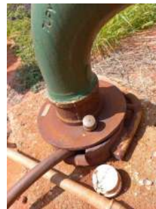
Foto 2 - Registro fotográfico enviado pelo prestador via e-mail em 08/05/2026 (antes do fechamento do relatório de fiscalização) evidenciando fechamento do tubo de medição com cap.
