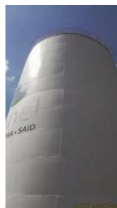
Foto 9 - Vista geral do reservatório.
