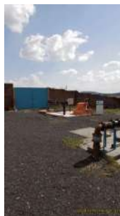
Foto 2 - Vista da área interna da unidade.
