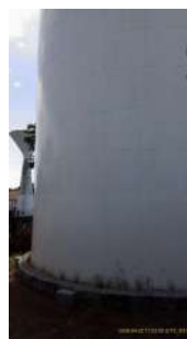
Foto 11 - Vista geral do reservatório.
