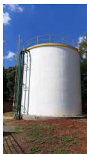
Foto 7 - Vista geral do reservatório.
