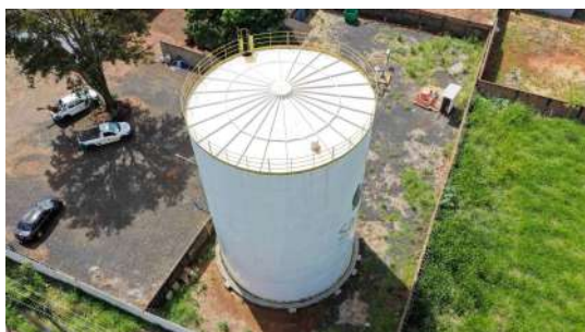
Foto 21 - Vista geral do reservatório.
