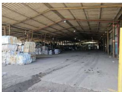
Foto 1 - Vista geral da entrada da planta
