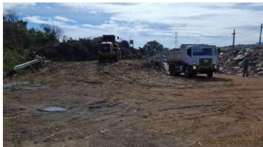
Foto 1 - Vista geral da área do Ecoponto e entorno
