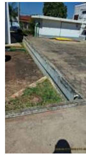
Foto 6 - Lateral do reservatório.
