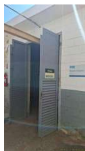
Foto 2 - Entrada da EEAT
