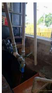
Foto 10 - Dosagem de PAC.
