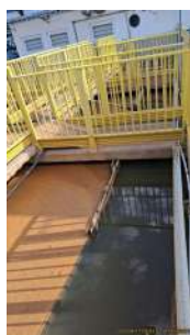
Foto 16 - Barreira de separação no floculador.
