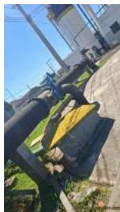
Foto 4 - Nova tubulação de abastecimento.
