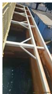
Foto 61 - Filtros da ETA compacta.
