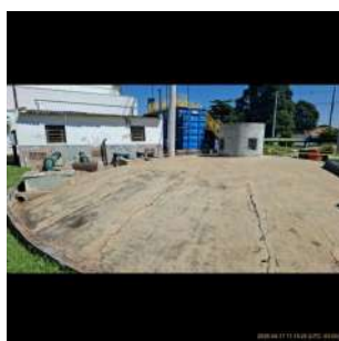
Foto 3 - Lateral do reservatório.
