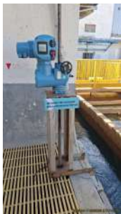
Foto 22 - Atuador da entrada da elevatória.
