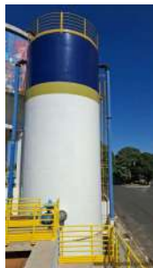
Foto 41 - Reservatório de água de lavagem dos filtros.
