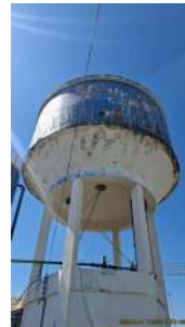
Foto 8 - Vista traseira do reservatório.
