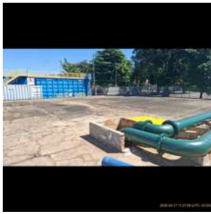
Foto 5 - Vista da cobertura do reservatório.
