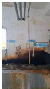
Foto 5 - Dosagem de hipoclorito de sódio e ácido fluossilícico..
