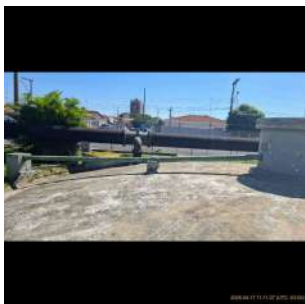
Foto 3 - Antiga tubulação de abastecimento.
