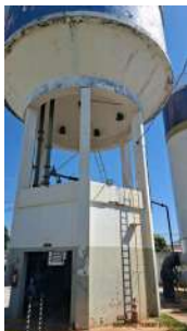
Foto 3 - Base do reservatório.
