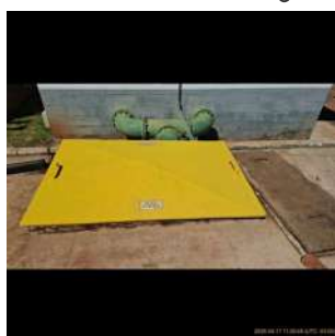
Foto 3 - Tampa de inspeção.
