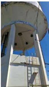
Foto 4 - Escada de acesso.
