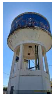
Foto 6 - Lateral do reservatório.
