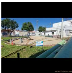
Foto 1 - Vista do reservatório.
