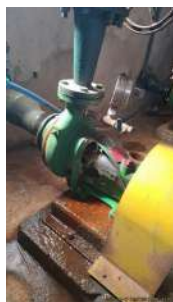
Foto 1 - Detalhe da drenagem da gaxeta.
