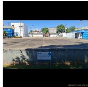
Foto 11 - Vista frontal do reservatório.
