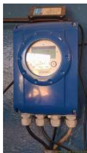
Foto 7 - medidor de vazão Franceschini
