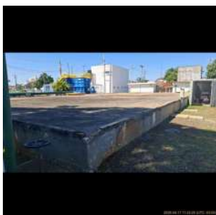
Foto 12 - Vista lateral do reservatório.
