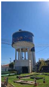
Foto 1 - Vista do reservatório.
