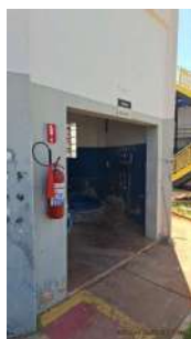
Foto 1 - Entrada da EEAT.
