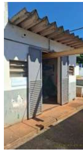
Foto 2 - Entrada da EEAT
