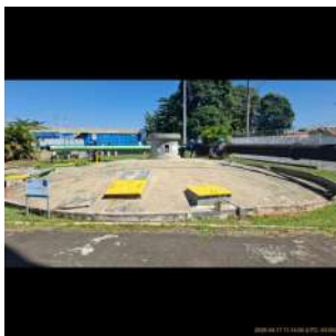
Foto 6 - Vista geral do reservatório.
