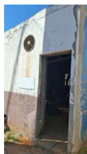
Foto 2 - Entrada da EEAT
