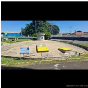
Foto 1 - Vista frontal do reservatório.
