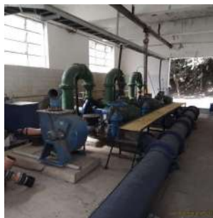
Foto 8 - Vista geral da casa de bombas 3, 4 e 5
