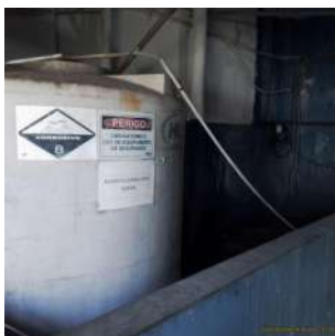
Foto 23 - Tanque de ácido fluossilícico
