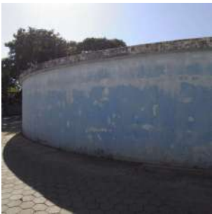
Foto 3 - Vista geral do entorno do reservatório
