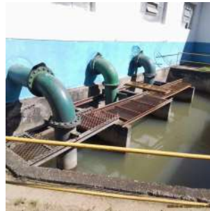
Foto 14 - Poço de sucção
