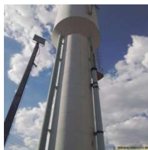
Foto 2 - Vista geral do reservatório
