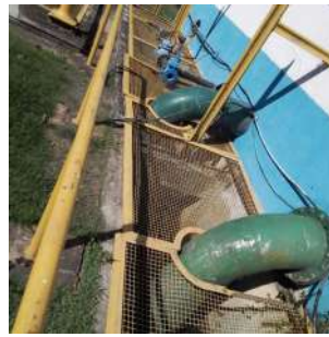
Foto 20 - Poço de sucção
