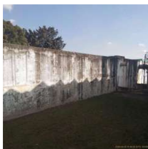
Foto 1 - Vista lateral do reservatório
