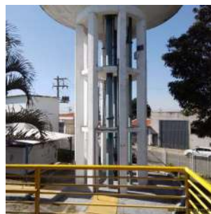
Foto 2 - Vista geral das tubulações de entrada e saída
