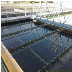
Foto 15 - Vista geral dos decantadores
