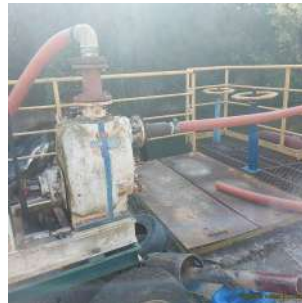
Foto 6 - Outra bomba para realizar a dragagem do tanque de entrada de água
