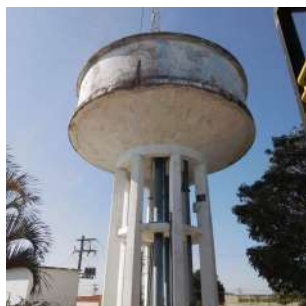
Foto 1 - Vista geral do reservatório
