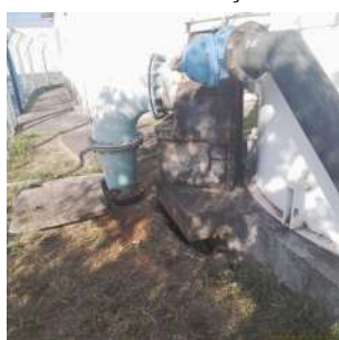
Foto 5 - Tubulação de saída
