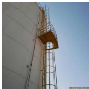
Foto 7 - Escada de acesso e fiação do SPDA
