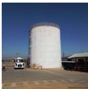
Foto 1 - Vista geral do reservatório
