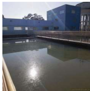
Foto 12 - Vista geral dos decantadores
