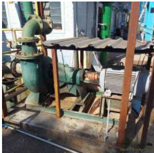
Foto 5 - Bomba para realizar a dragagem do tanque de entrada de água
