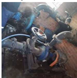
Foto 6 - Inspeção preditiva sendo realizada nas bombas
