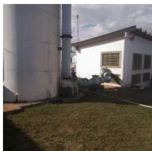
Foto 3 - Vista da tubulação de entrada
