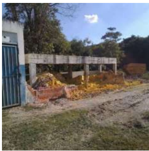
Foto 20 - Remoção de PAC vencido (operação em andamento)
