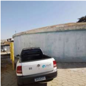
Foto 1 - Vista geral do entorno do reservatório
