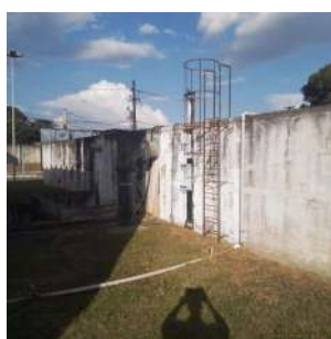
Foto 6 - Escada de acesso a parte de cima do reservatório
