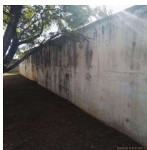
Foto 4 - Vista lateral do reservatório
