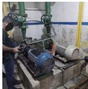
Foto 25 - Bombas de recalque para os reservatórios do Jd. América e Vila Martins
