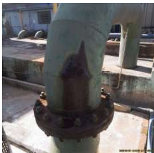
Foto 9 - Aplicação de hipoclorito de sódio para o tanque de contato
