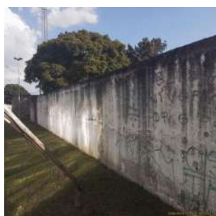
Foto 3 - Vista lateral do reservatório
