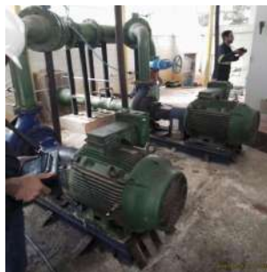
Foto 4 - Vista geral dos conjuntos 1 e 2
