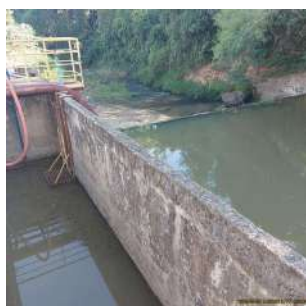
Foto 1 - Barragem do Buru
