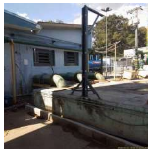
Foto 13 - Tubulação de sucção do tanque de contato
