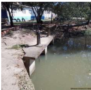
Foto 17 - Controle de entrada de água
