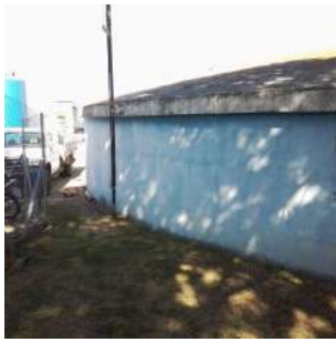
Foto 5 - Vista geral do entorno do reservatório
