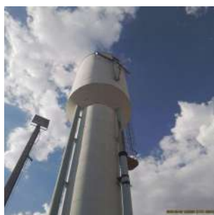
Foto 1 - Vista geral do reservatório
