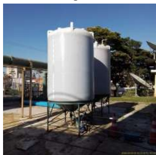
Foto 31 - Tanque provisório para realizar manutenção no tanque de PAC
