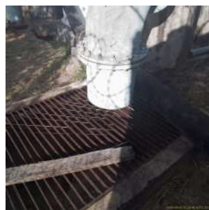
Foto 4 - Saída do tubo extravasor
