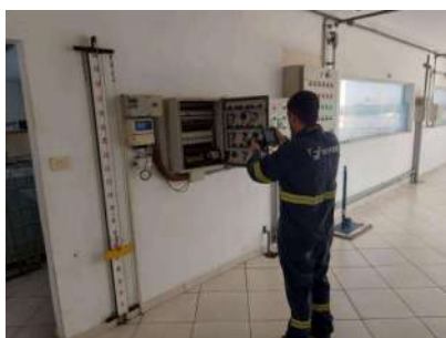
Foto 34 - Realização de inspeção preditiva na ETA
