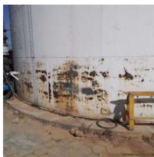
Foto 2 - Vista geral do reservatório
