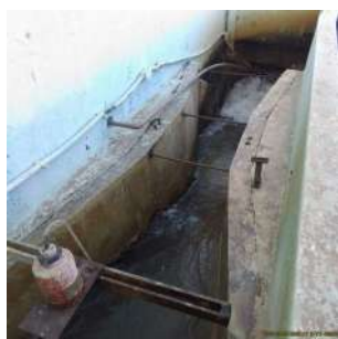
Foto 3 - Outra vista da Calha Parshall
