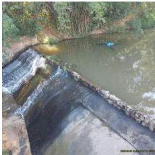
Foto 7 - Barramento e boia do mangote de dragagem
