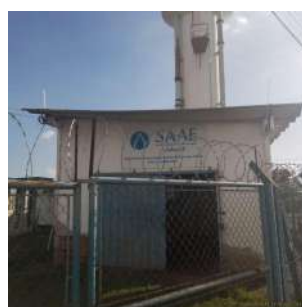
Foto 6 - Entrada do Centro de Reservação com identificação da área
