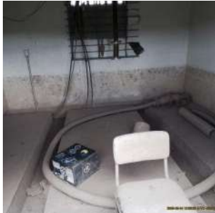
Foto 6 - Vista interna da estrutura de apoio
