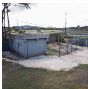
Foto 3 - Vista geral da EEE
