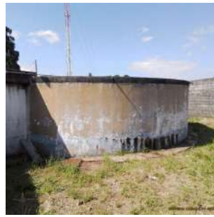
Foto 6 - Vista geral do reservatório
