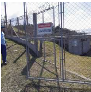
Foto 1 - Fachada do reservatório
