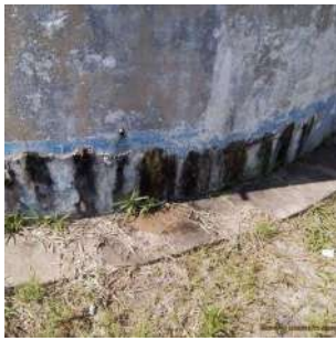
Foto 5 - Vazamentos aparentes
