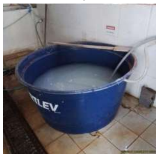
Foto 3 - Tanque de preparo de polímero
