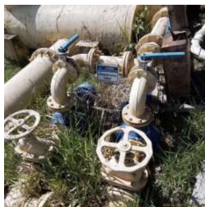
Foto 16 - Tubulação de lavagem dos filtros
