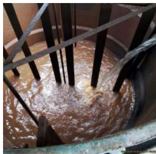
Foto 9 - Abastecimento do tanque
