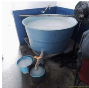
Foto 7 - Tanque de preparo do polímero
