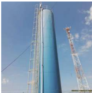
Foto 1 - Vista geral do reservatório
