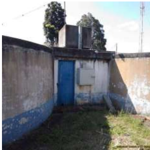
Foto 7 - Antiga casa de bomba
