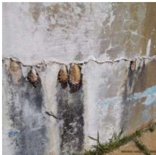
Foto 1 - Vazamentos aparentes
