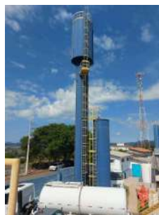
Foto 2 - Vista geral do reservatório tipo taça
