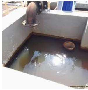
Foto 18 - Entrada de água na ETA
