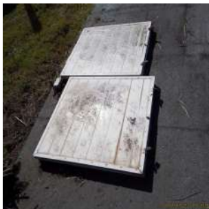
Foto 6 - Tampas de inspeção
