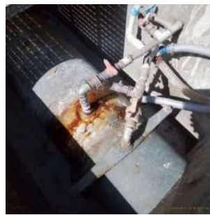
Foto 10 - Aplicação de hidróxido de cálcio na tubulação de água bruta que distribui para todas as ETAs
