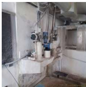
Foto 4 - Bomba dosadora de hidróxido de cálcio
