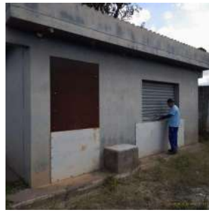
Foto 5 - Fachada da estrutura de apoio
