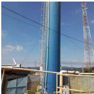
Foto 3 - Vista do reservatório
