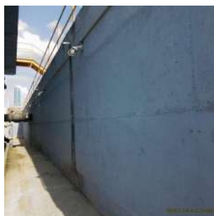
Foto 1 - Vista geral da parede do reservatório
