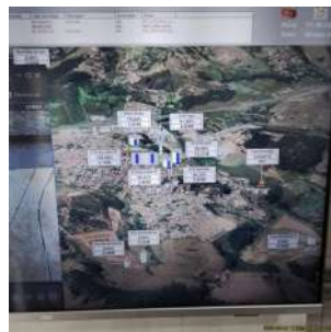
Foto 3 - Medição via telemetria do nível do reservatório
