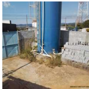
Foto 2 - Vista da base do reservatório
