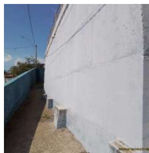
Foto 2 - Vista geral da parede do reservatório
