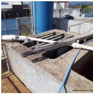
Foto 23 - Chegada de água do Ribeirão da Serra (7 m 3 por h)
