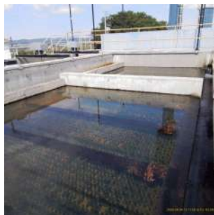
Foto 26 - Decantadores lamelares
