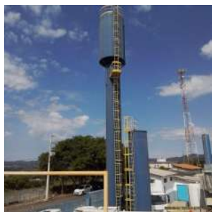
Foto 1 - Reservatório maior para distribuição de água e o menor para lavagem dos filtros
