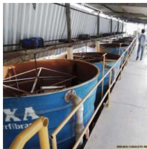
Foto 10 - Vista geral dos tanques
