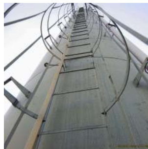
Foto 4 - Escada com guarda corpo e mangueira de nível para medição
