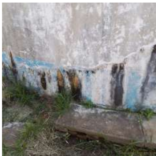
Foto 3 - Vazamentos aparentes
