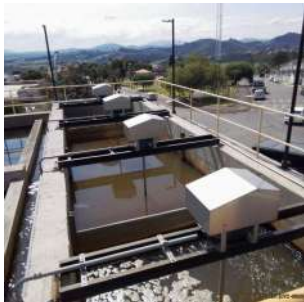
Foto 22 - Floclulação por misturadores mecânicos
