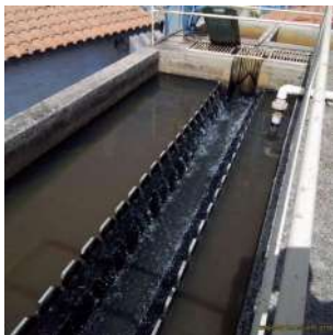
Foto 5 - Vista do decantador
