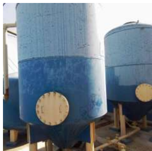
Foto 1 - Vista geral da ETA 1
