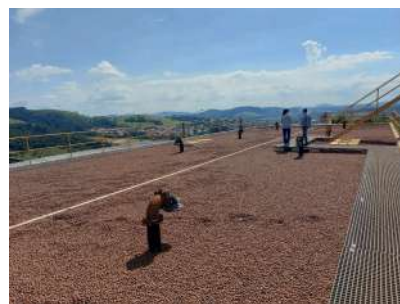
Foto 6 - Vista de cima do reservatório
