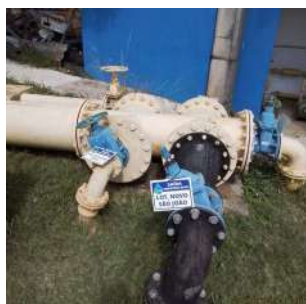
Foto 10 - Saídas de água após bombeamento
