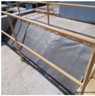
Foto 17 - Local de dosagem de hipoclorito de sódio e ácido fluossilícico da água tratada
