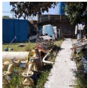
Foto 2 - Sucata espalhado pela área da ETA
