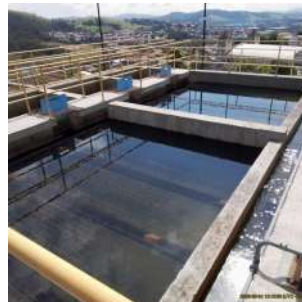
Foto 23 - Decantadores lamelares
