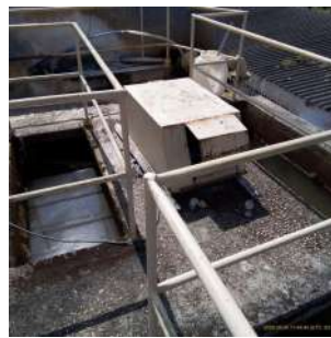
Foto 4 - Floculador mecânico
