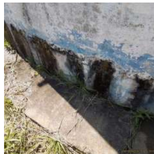
Foto 4 - Vazamentos aparentes
