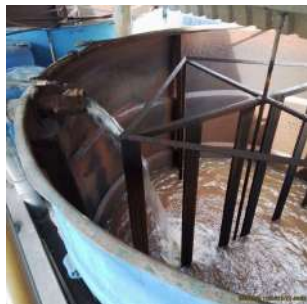
Foto 11 - Abastecimento do decantador
