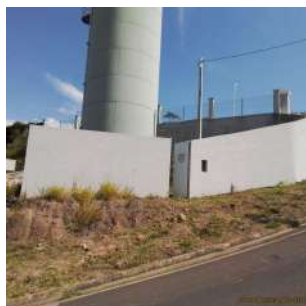
Foto 1 - Vista da fachada do reservatório
