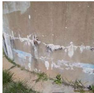
Foto 2 - Vazamentos aparentes
