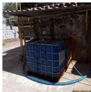
Foto 12 - Armazenamento do ácido fluossilícico
