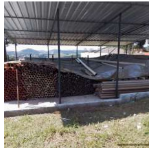
Foto 8 - Estoque de tubulação
