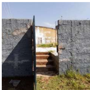
Foto 1 - Portão de Entrada
