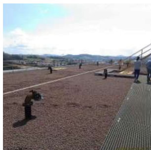
Foto 3 - Vista de cima do Reservatório Apoiado 2
