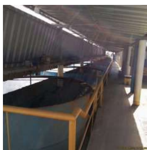
Foto 2 - Vista geral da ETA
