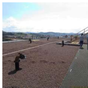
Foto 16 - Vista de cima do Reservatório Apoiado Novo
