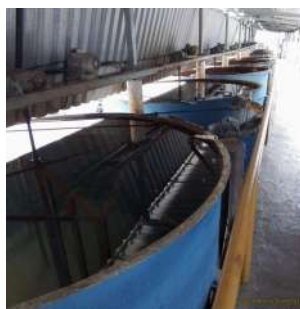
Foto 6 - Vista geral dos decantadores
