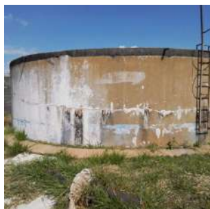
Foto 3 - Vista geral do reservatório
