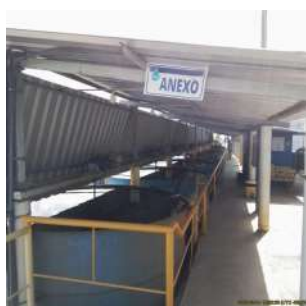
Foto 1 - Vista geral da ETA
