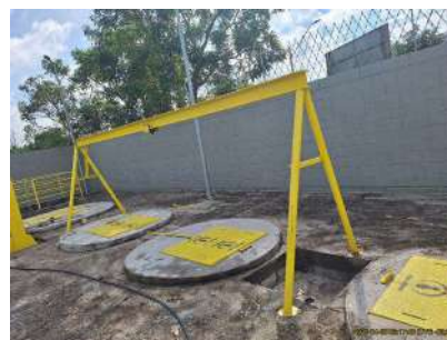
Foto 2 - Pórtico - acesso para manutenção
