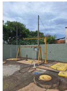
Foto 2 - Pórtico - acesso para manutenção
