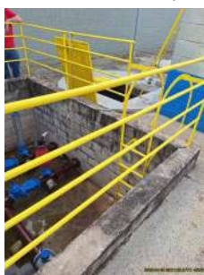
Foto 10 - Área protegida com guarda corpos
