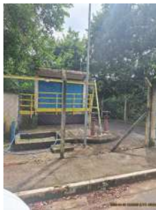
Foto 1 - Visão geral - cercamento com alambrado
