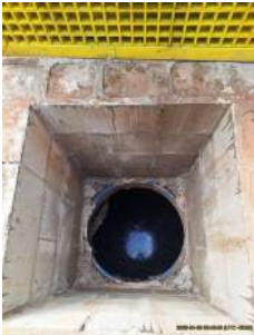
Foto 4 - Poço chegada do esgoto
