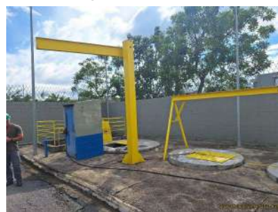
Foto 11 - Pórtico - acesso para manutenção
