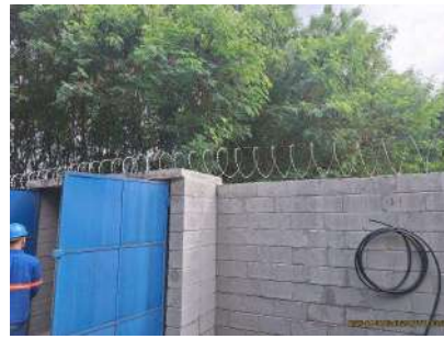
Foto 6 - Cercamento da área
