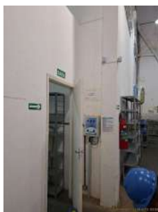
Foto 1 - Recinto interno com identificação da elevatória
