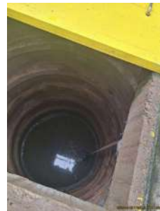
Foto 4 - Poço de chegada do esgoto
