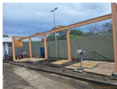
Foto 2 - Pórtico - acesso para manutenção
