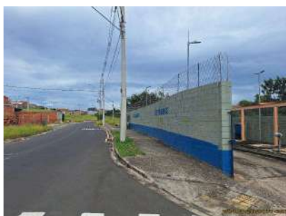
Foto 1 - Visão geral - muro com identificação
