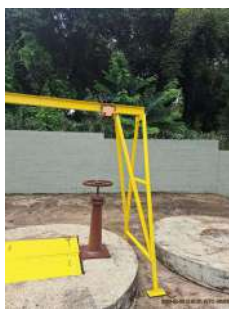
Foto 5 - Pórtico para acesso de manutenção
