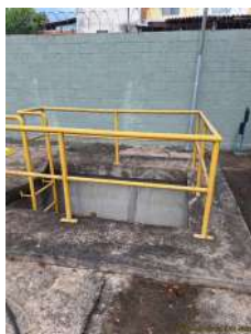
Foto 4 - Guarda-corpos na linha de recalque
