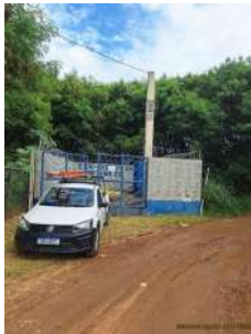
Foto 1 - Visão geral - EEE Fortuna 2
