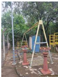
Foto 3 - Pórtico - acesso para manutenção
