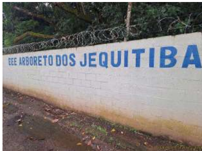
Foto 3 - Muro com identificação
