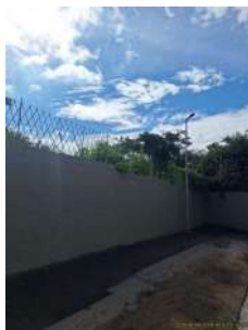
Foto 9 - Muro no entorno da estação elevatória
