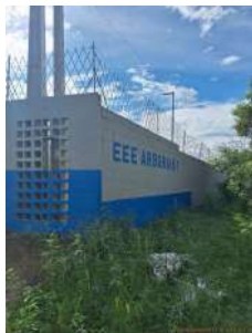
Foto 11 - Cercamento de área com identificação
