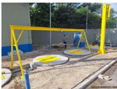
Foto 1 - Pórtico - acesso para manutenção
