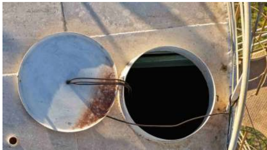
Foto 1 - Detalhe da abertura.
