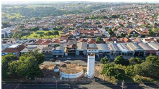
Foto 3 - Vista geral dos reservatórios BNH.
