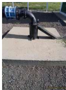
Foto 4 - Detalhe da laje do poço.
