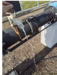
Foto 8 - Tomada para coleta de água bruta.
