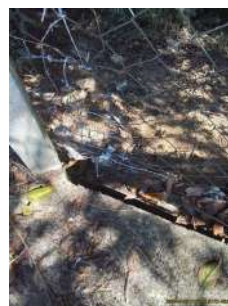
Foto 2 - Detalhe 2 da laje.
