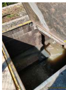
Foto 8 - Poço da EEE.
