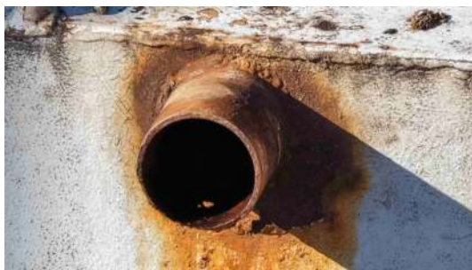
Foto 2 - Detalhe da tubulação.
