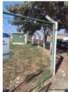
Foto 2 - Cercamento do local.
