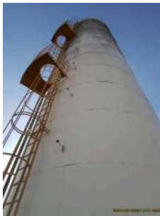
Foto 1 - Detalhe das hastes para fixação do condutor de descida.
