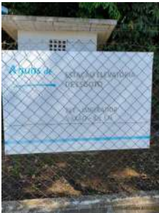
Foto 2 - Identificação do local.
