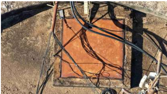
Foto 1 - Detalhe da tampa de inspeção.
