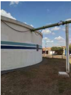
Foto 1 - Vista do reservatório.
