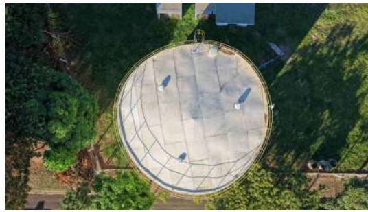
Foto 8 - Vista superior do reservatório Benassi.
