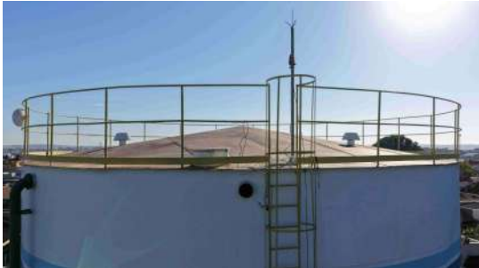
Foto 9 - Detalhe do topo do reservatório.
