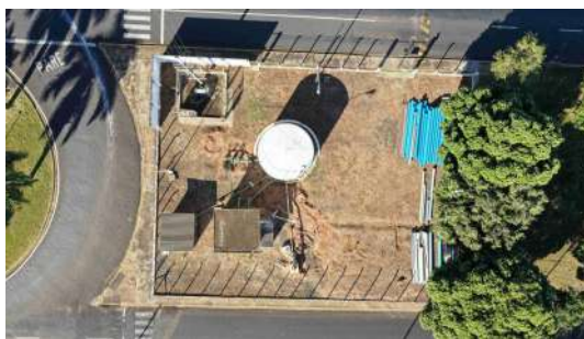
Foto 6 - Vista superior do local.
