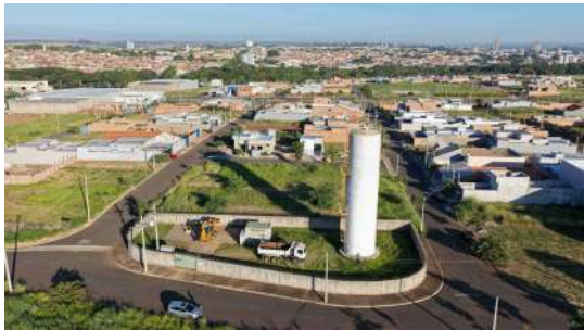
Foto 4 - Vista geral aérea do reservatório.
