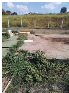
Foto 4 - Poço pulmão à direita.
