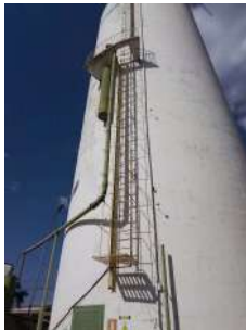
Foto 3 - Escada e guarda-corpos.
