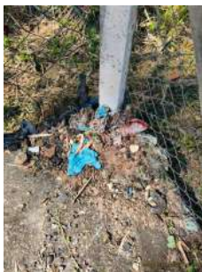
Foto 1 - Acúmulo de resíduos no piso da EEE.
