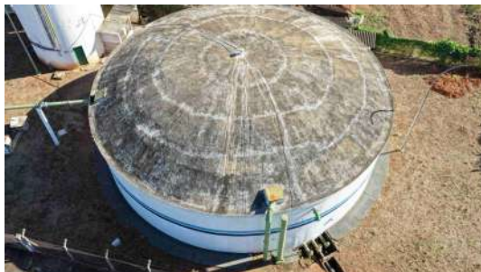
Foto 5 - Vista geral do reservatório apoiado.
