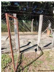
Foto 3 - Portão de acesso à EEE.
