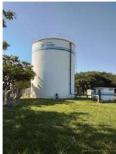
Foto 3 - Vista do reservatório.
