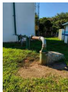
Foto 4 - Detalhe da proximidade do poço ao reservatório.
