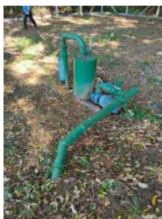
Foto 3 - EEE em operação.
