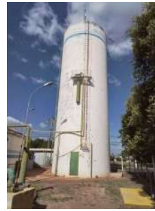
Foto 2 - Vista do reservatório.
