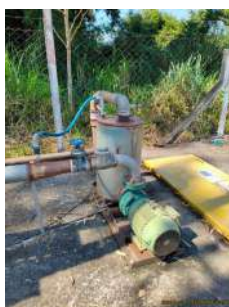
Foto 3 - EEE em operação.
