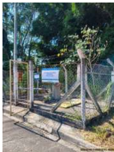
Foto 1 - Vista da EEE.
