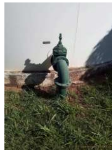
Foto 6 - Saída do reservatório.
