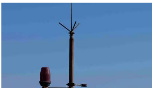
Foto 10 - Detalhe da haste do SPDA.
