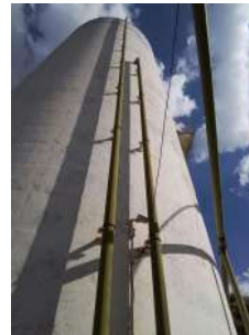
Foto 4 - Tubulações de alimentação do reservatório, que é dividido em duas câmaras.
