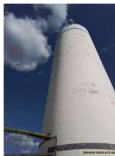
Foto 2 - Vista do reservatório elevado.
