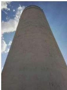
Foto 5 - Vista do reservatório.
