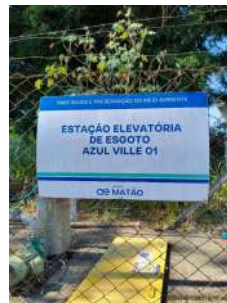
Foto 2 - Identificação do local.
