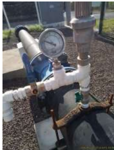
Foto 7 - Manômetro junto à tomada para coleta de água bruta.
