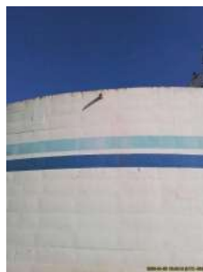
Foto 4 - Extravasador do reservatório.
