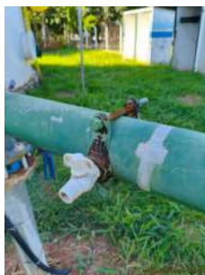
Foto 7 - Tomada para coleta de água bruta.
