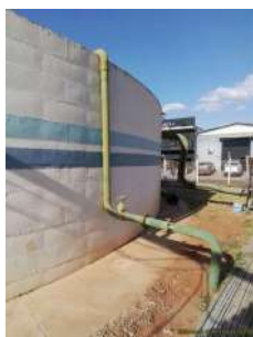
Foto 1 - Reservatório apoiado BNH.
