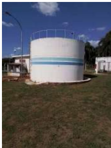
Foto 3 - Vista do reservatório.
