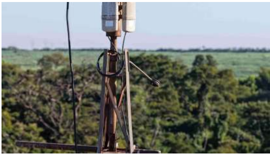
Foto 1 - Detalhe dos suportes instalados para o condutor de descida.
