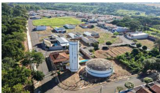
Foto 4 - Vista geral dos reservatórios Jd. Brasil.
