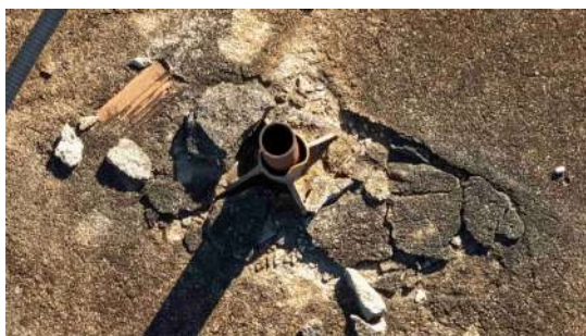
Foto 1 - Detalhe da abertura no topo do reservatório.
