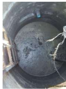
Foto 4 - Poço da EEE.
