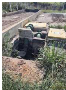
Foto 2 - Vista geral da EEE.
