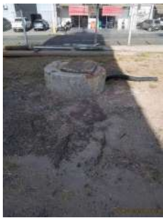
Foto 1 - Detalhe do tamponamento do poço.
