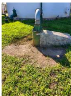
Foto 3 - Laje de proteção do poço.
