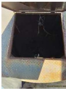
Foto 3 - Tampa para inspeção da EEE.
