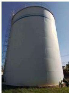
Foto 5 - Vista do reservatório.
