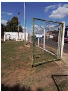
Foto 2 - Cercamento da área.
