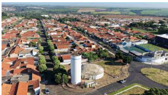
Foto 5 - Vista geral dos reservatórios Cardim.
