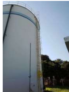
Foto 4 - Escada e guarda-corpos.
