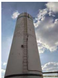
Foto 1 - Escada e guarda-corpos do reservatório.
