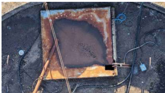
Foto 1 - Detalhe da tampa de inspeção.
