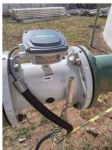
Foto 3 - Medidor de vazão. O visor está junto da EAT Cardim.
