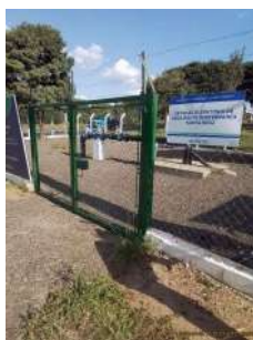
Foto 1 - Cercamento do local.
