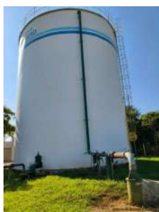
Foto 5 - Vista do reservatório.
