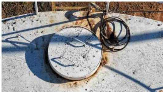
Foto 7 - Detalhe da tampa de inspeção.
