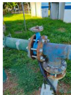
Foto 8 - Detalhe da junção das tubulações.
