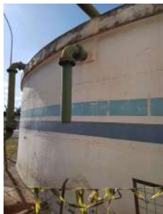
Foto 3 - Extravasador do reservatório.
