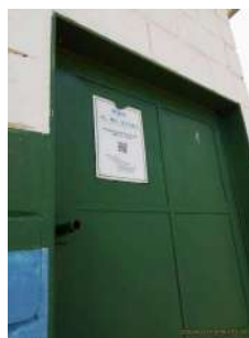
Foto 5 - Porta para acesso ao abrigo dos painéis elétricos.
