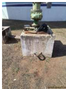
Foto 4 - Apoio/laje do poço.
