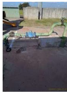
Foto 6 - Detalhe da laje do poço.
