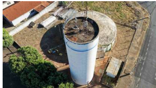
Foto 6 - Vista geral do reservatório elevado.
