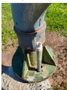
Foto 9 - Tubo de medição de nível.
