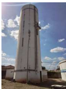
Foto 3 - Vista do reservatório.
