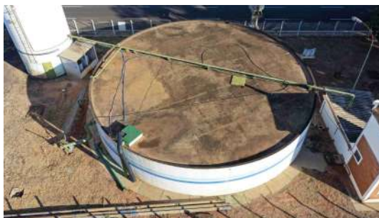
Foto 8 - Vista do reservatório apoiado.
