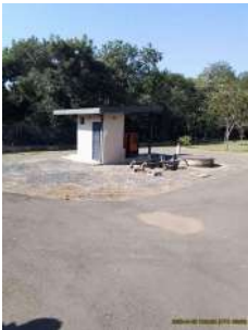
Foto 1 - Vista da EEE.
