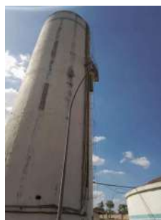
Foto 4 - Escada e guarda-corpos.
