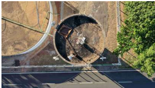
Foto 4 - Vista superior do reservatório elevado.
