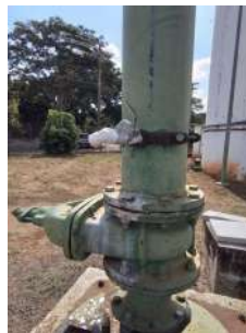
Foto 2 - Tomada para coleta de água bruta.
