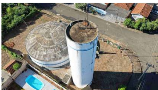
Foto 9 - Vista geral do reservatório elevado.
