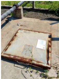
Foto 1 - Tampa de inspeção.
