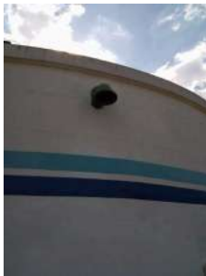
Foto 2 - Extravaso do reservatório.
