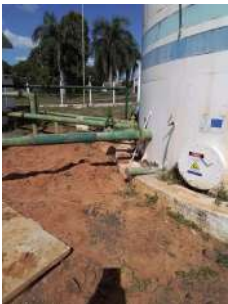
Foto 4 - Saída do reservatório.
