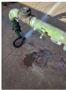
Foto 5 - Tomada para coleta de água bruta.
