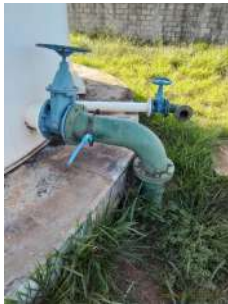
Foto 3 - Saída do reservatório.
