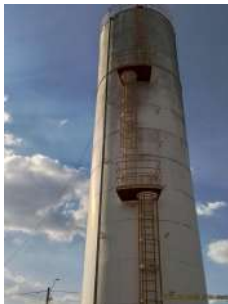
Foto 2 - Escadas e guarda-corpos do reservatório.
