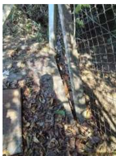
Foto 1 - Detalhe da laje ao fundo da EEE.
