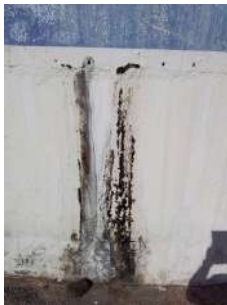
Foto 1 - Vazamento 1.
