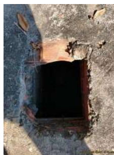
Foto 2 - Detalhe da abertura.
