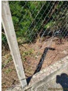
Foto 5 - Detalhe do reparo recente feito no cercamento.
