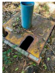
Foto 2 - Abertura próxima ao acesso de inspeção.
