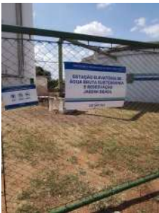
Foto 2 - Cercamento e identificação do local.
