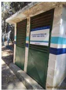
Foto 1 - Identificação do local.
