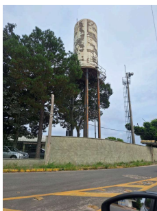
Foto 1 - Visão externa da escola, com reservatório dentro dos limites da instalação
