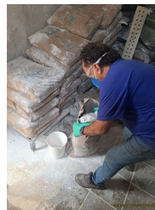
Foto 26 - Operador com EPI em preparação de cal
