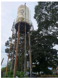
Foto 1 - Visão geral - reservatório elevado
