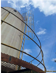
Foto 3 - Guarda-corpo, escada e extravasor
