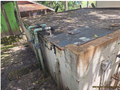
Foto 3 - Tampa de inspeção e tubulação de entrada de água do reservatório
