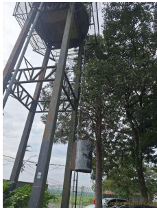
Foto 3 - Escada de acesso
