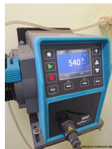
Foto 7 - Dosagem de Flúor (ácido fluossilícico)
