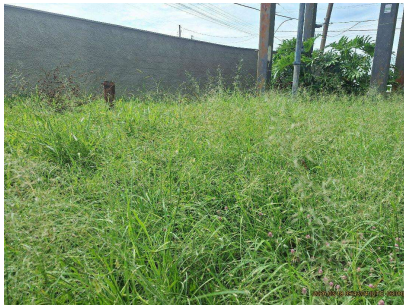
Foto 1 - Mato alto no entorno do reservatório.
