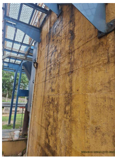
Foto 1 - Infiltração constatada
