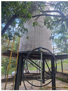
Foto 1 - Base do reservatório elevado
