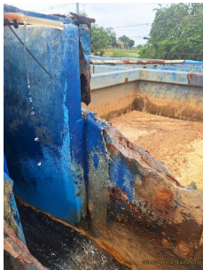
Foto 5 - Dosagem de PAC (coagulante)
