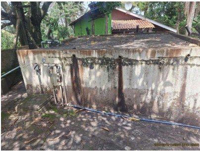
Foto 1 - Lateral do reservatório de concreto
