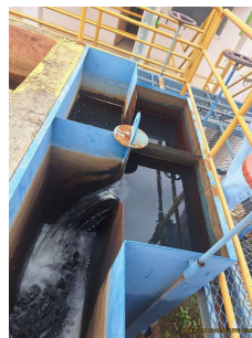
Foto 10 - Encaminhamento da água decantada aos filtros
