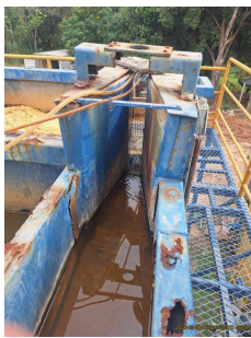
Foto 3 - Medidor Parshall
