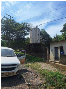
Foto 1 - Visão geral - instalação do subsistema
