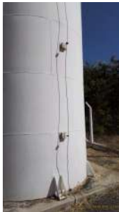
Foto 1 - Descida do aterramento.
