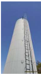
Foto 1 - Visão geral do reservatório.
