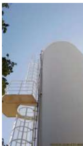
Foto 1 - Descida do extravasor.
