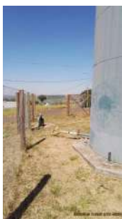
Foto 1 - Cerca no perímetro da área.
