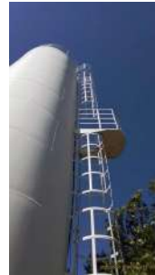
Foto 2 - Escada com proteção
