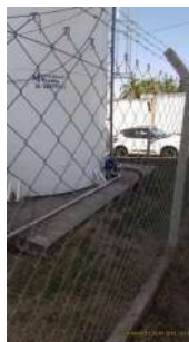
Foto 2 - Entrada e saída do reservatório.
