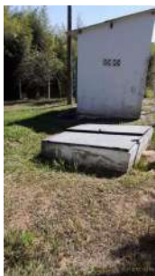
Foto 3 - Ausência de vazamento.
