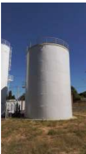
Foto 2 - Visão geral do reservatório
