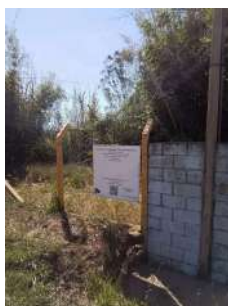
Foto 8 - laca de identificação da ETE.
