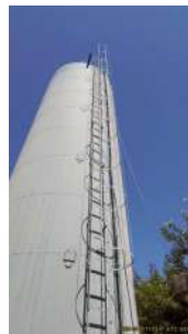
Foto 4 - Escada com proteção.
