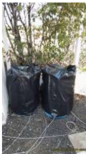
Foto 5 - Armazenamento de cloro e flúor.
