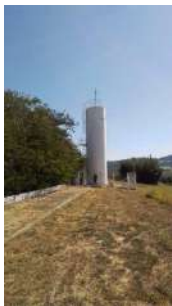
Foto 1 - Visão geral da área do poço e reservatório.
