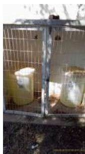
Foto 4 - Abrigo dos produtos químicos.
