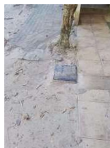
Foto 2 - Caixa e passagem do esgoto coletado no restaurante existente no local.
