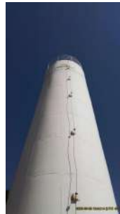
Foto 2 - Descida do aterramento.
