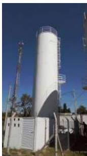
Foto 1 - Visão geral do reservatório.
