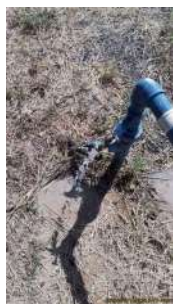
Foto 1 - Tomada de água bruta.
