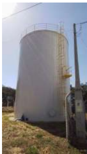
Foto 1 - Visão geral do reservatório
