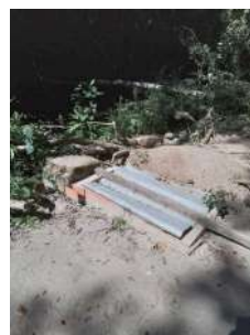
Foto 4 - Caixa do sistema de tratamento.
