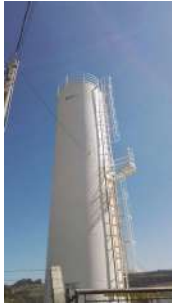
Foto 1 - Visão geral do reservatório.
