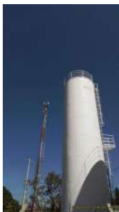
Foto 1 - Antena próxima ao reservatório.
