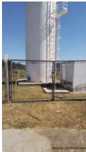
Foto 3 - Portão de acesso.
