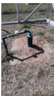
Foto 1 - Laje de concreto.
