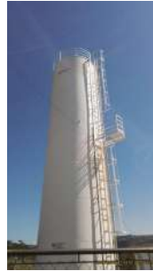
Foto 2 - Visão geral do reservatório.
