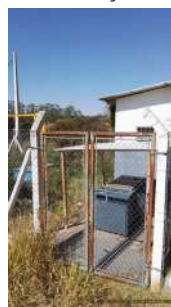
Foto 6 - Portão de acesso.
