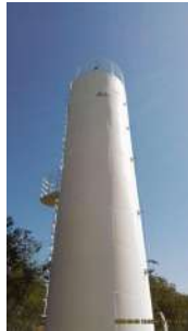
Foto 1 - Visão geral do reservatório.
