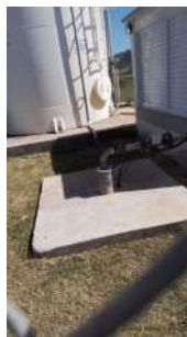
Foto 2 - Cavalete e laje de proteção.
