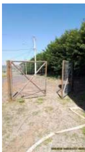
Foto 1 - PORTÃO DE ACESSO.
