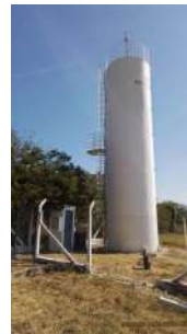
Foto 4 - Visão geral do reservatório.
