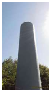
Foto 2 - Visão geral do reservatório.
