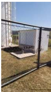
Foto 1 - Visão geral do poço.
