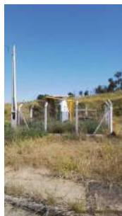
Foto 1 - Visão geral da elevatória de esgoto.
