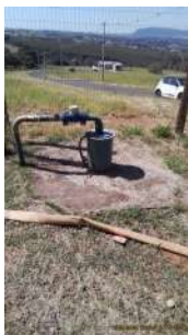
Foto 1 - LAJE DE CONCRETO.
