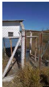
Foto 2 - Portão de acesso.
