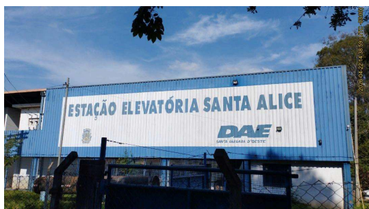
Foto 1 - Vista geral da captação a partir da Rua Cláudio Manoel da Costa.
