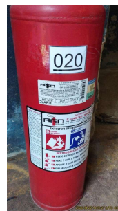
Foto 13 - Detalhe da etiqueta de controle de manutenções do extintor.
