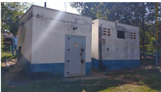
Foto 10 - Edificação que abriga o gerador de energia elétrica da elevatória.
