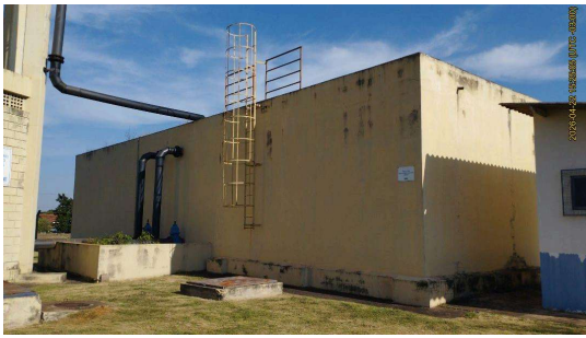
Foto 3 - Vista geral do reservatório.
