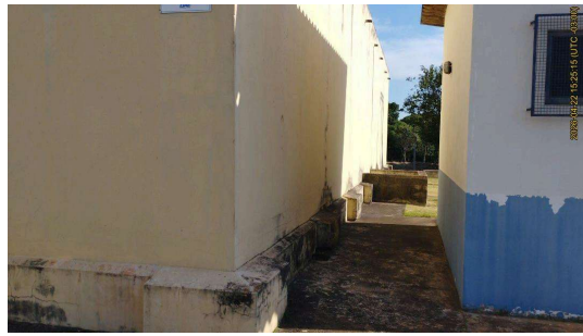
Foto 4 - Vista geral do reservatório.
