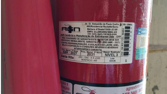
Foto 8 - Detalhe da etiqueta de controle de manutenções do extintor.
