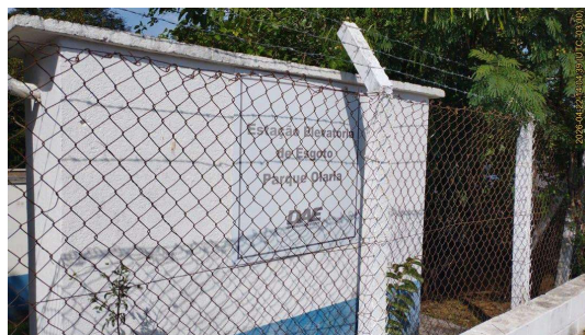
Foto 2 - Placa de identificação da elevatória, afixada em local visível a partir da Rua Vinte e Um de Abril.
