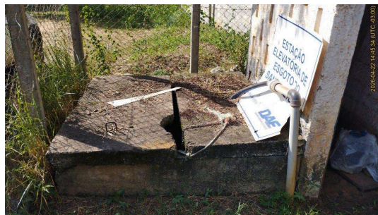
Foto 2 - Vista geral do poço de sucção da elevatória.
