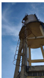
Foto 4 - Escadas de acesso ao topo do reservatório.
