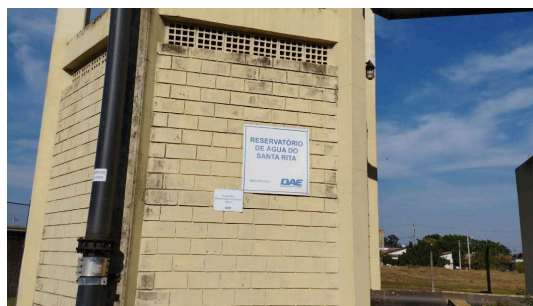
Foto 2 - Placa de identificação do reservatório.
