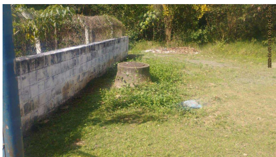
Foto 3 - PV do ponto de chegada do esgoto bruto na elevatória.
