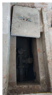
Foto 5 - Caixa de válvulas.
