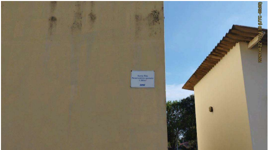
Foto 2 - Placa de identificação do reservatório.
