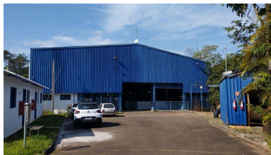
Foto 6 - Vista geral da casa de bombas da captação.
