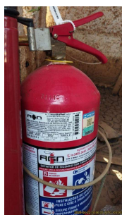
Foto 5 - Detalhe da etiqueta de controle de manutenções do extintor.
