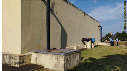
Foto 6 - Vista geral do reservatório.
