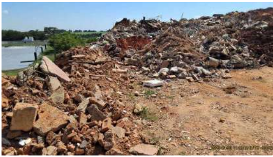
Foto 21 - Visão geral, RCC
