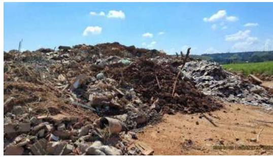
Foto 22 - Visão geral, RCC
