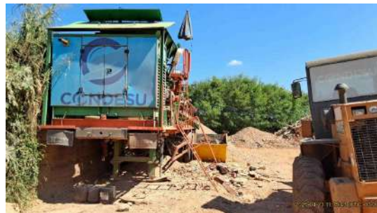
Foto 18 - Britador de RCC
