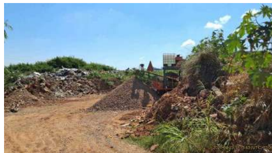
Foto 20 - Visão geral, RCC
