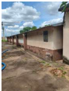
Foto 1 - Vista geral do reservatório.
