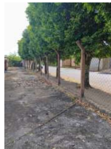
Foto 2 - Vista geral do cercamento da área com portal de metal para controle de acesso..
