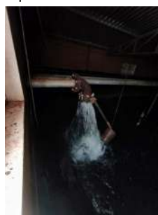
Foto 4 - Tubulação de retorno de água do reservatório P3 para reservatório semienterrado de 1.500.000 L.
