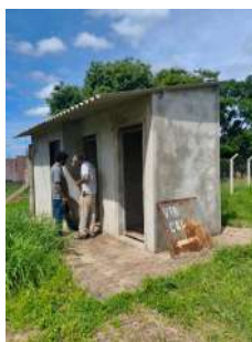
Foto 8 - Local de armazenamento e dosagem de produtos químicos.
