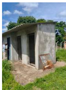
Foto 9 - Local de armazenamento e dosagem de produtos químicos.
