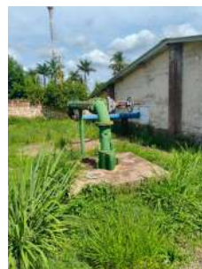
Foto 4 - Vista geral do poço.
