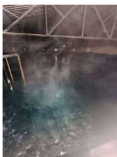
Foto 3 - Vista interna do reservatório.
