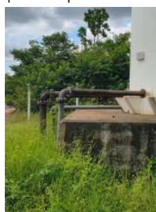
Foto 9 - Vista da tubulação de saída do reservatório.
