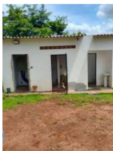
Foto 8 - Abrigo de armazenamento e dosagem de produtos químicos.
