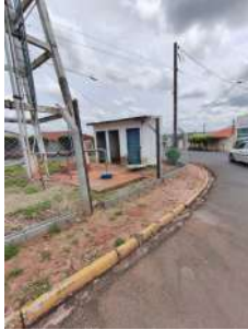
Foto 1 - Ausência de portão de acesso à unidade com Trecho da cerca aberto, permitindo livre acesso.
