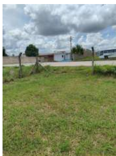
Foto 1 - Trecho da cerca aberto, permitindo acesso à área do reservatório.
