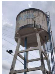
Foto 2 - Detalhe do reservatório elevado.
