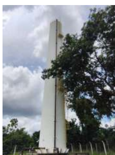
Foto 8 - Detalhe da tubulação, proveniente do poço 12, para abastecimento do reservatório.
