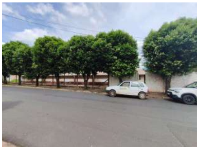
Foto 1 - Vista geral da localização da estação elevatória de água.
