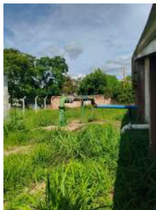
Foto 1 - Vista geral da localização do poço e condição do cercamento da área.
