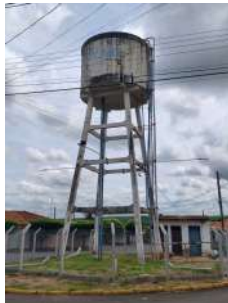
Foto 1 - Vista geral da localização do reservatório evidenciando cercamento da área.
