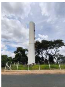
Foto 1 - Vista geral do reservatório.
