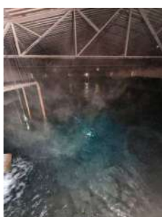
Foto 5 - Detalhe da estrutura interna do telhado de reservatório semienterrado com capacidade de 1.500.000 L, com destaque para o arranjo das armaduras, elementos de sustentação e estado geral de conservação.
