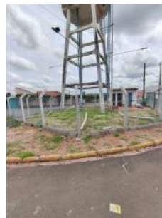
Foto 3 - Vista geral do cercamento da área.
