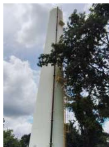
Foto 7 - Vista da escada e guarda-corpo para acesso a parte superior do reservatório.
