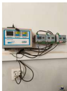
Foto 2 - Painel de visualização de nível na central de controle operacional desligado ou inoperante.
