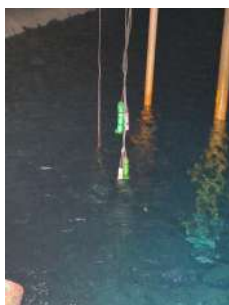
Foto 1 - Sensores de nível instalados sem funcionamento efetivo.
