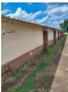
Foto 8 - Vista externa do reservatório
