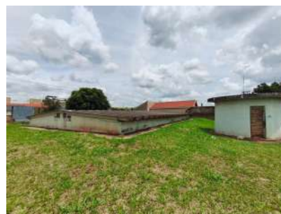
Foto 11 - Vista geral do reservatório semienterrado de 500.000 L e o local da estação elevatória de água.
