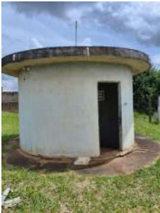
Foto 1 - Vista geral externa da Estação Elevatória de Água, evidenciando cercamento da área e controle de acesso através de portão metálico.
