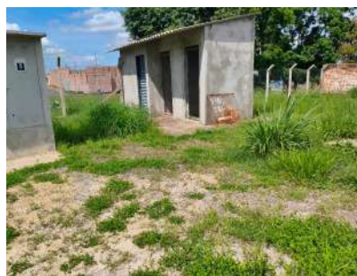
Foto 2 - Área com mato alto junto às instalações de dosagem.
