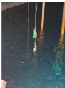
Foto 7 - Sensores para medição do nível do reservatório.
