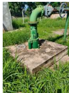
Foto 5 - Detalhe da laje de proteção.
