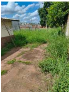
Foto 9 - Presença de vegetação alta no entorno da unidade fiscalizada, evidenciando a necessidade de roçada, conforme apontamento registrado na Ficha de Fiscalização nº 14.220.
