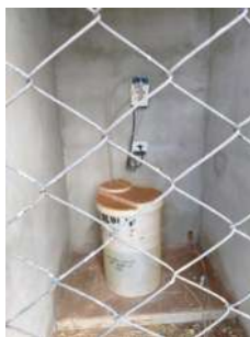
Foto 10 - Vista do local de armazenamento e de dosagem de cloro. Local estava fechado.
