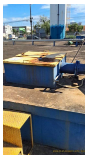
Foto 4 - Tampa de inspeção.
