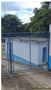
Foto 6 - Vista geral da estação elevatória.
