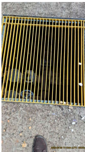
Foto 2 - Conjunto de válvulas e registros.
