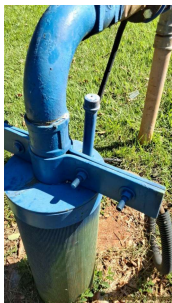
Foto 3 - Laje de proteção e medidor de nível.
