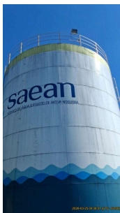
Foto 1 - Vista geral do reservatório.
