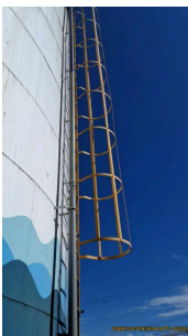
Foto 2 - Escada de acesso ao topo do reservatório.
