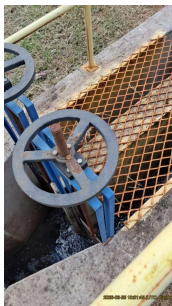
Foto 3 - Canal de passagem de esgoto com presença de comporta metálica.
