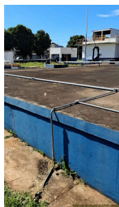
Foto 1 - Vista geral do reservatório.
