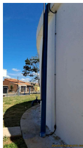
Foto 7 - Vista lateral do reservatório.
