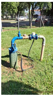
Foto 1 - Vista geral do poço.
