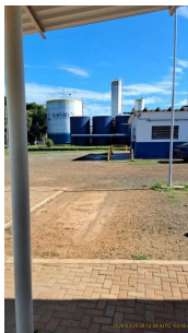
Foto 1 - Vista geral da Estação de Tratamento de Água (ETA III).
