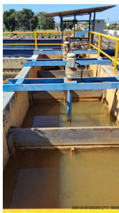
Foto 24 - Unidade de floculação de concreto.
