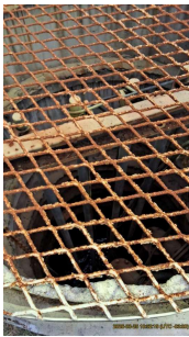
Foto 5 - Poço de sucção contendo o conjunto de motobombas destinado ao recalque do esgoto.
