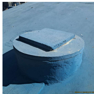
Foto 2 - Tampa de inspeção
