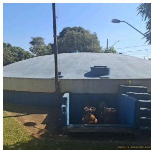
Foto 1 - Reservatório semienterrado ETA
