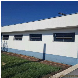
Foto 2 - Vista frontal da EEAT Klavin
