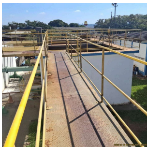
Foto 9 - Escada de acesso e guarda-corpos
