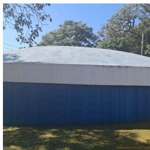
Foto 3 - Vista lateral do reservatório
