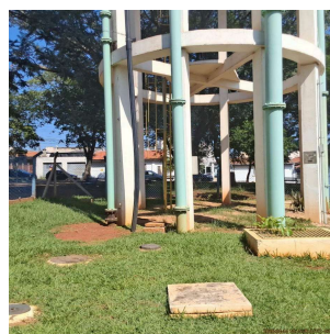
Foto 2 - Base do reservatório Castelo
