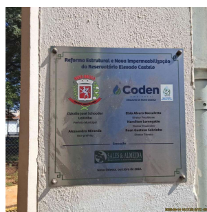
Foto 4 - Placa da última reforma estrutural e impermeabilização (out.22)
