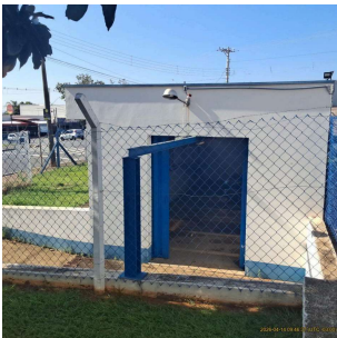
Foto 1 - Vista lateral da EEAT Klavin
