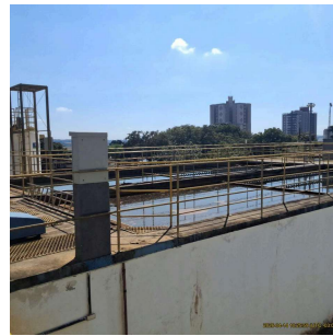
Foto 6 - Vista lateral da ETA
