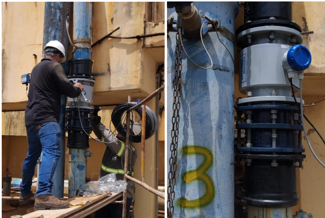
Figura TEC 3 – Instalação de macro medidores.
