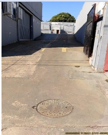
Figura TEC 31. Intervenção para passagem de rede de esgoto, através de servidão, vinda da rua paralela acima (Rua Vicente Segula) para a Rua Agostinho Ênes.
