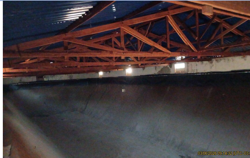
Figura TEC 20. Cobertura Reservatório Bairro Alto.
