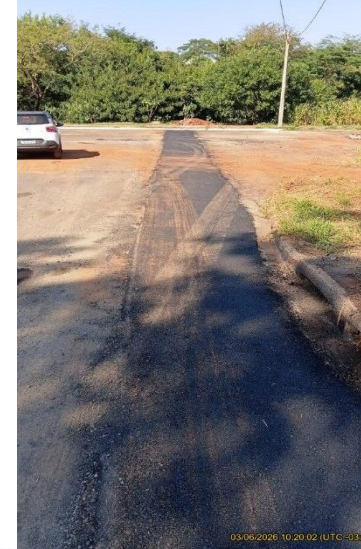
Figura TEC 28. Intervenção na Av. Jihei Hori, próximo ao encontro com Rua Pref. Ângelo Berchieri.
