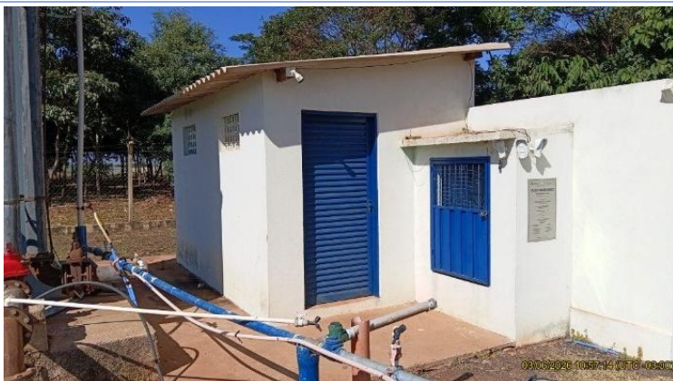
Figura TEC 6. Casa de química poço Monterrey.
