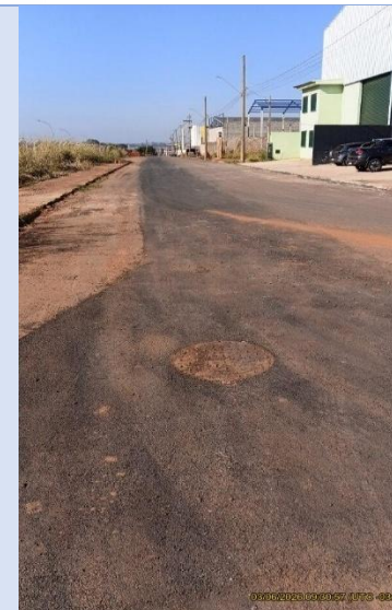
Figura TEC 30. Intervenção na Av. Dr. José Antonio Miziara.
