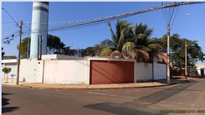
Figura TEC 25. Intervenção no cruzamento da Rua Hilário Morello com a Rua Horácio Pinto Ferreira.
