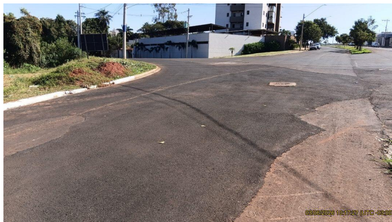
Figura TEC 27. Intervenção no encontro da Rua Cesário Martins com a Av. Jihei Hori.
