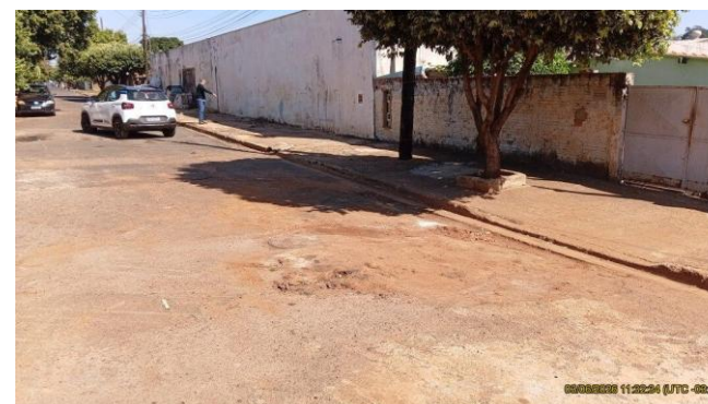
Figura TEC 32. Intervenção a partir de PV na Rua Vicente Sagula, para execução de novo trecho de rede de esgoto.
