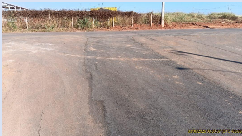
Figura TEC 29. Intervenção na Av. Alfeu Martini, próximo a Rua Angelo Pedro Colucço.
