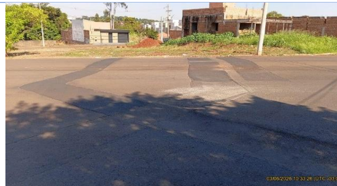
Figura TEC 11. Encontro da adutora executada com outra já existente, Rua Waldir Turco com a Av. Jihei Hori.
