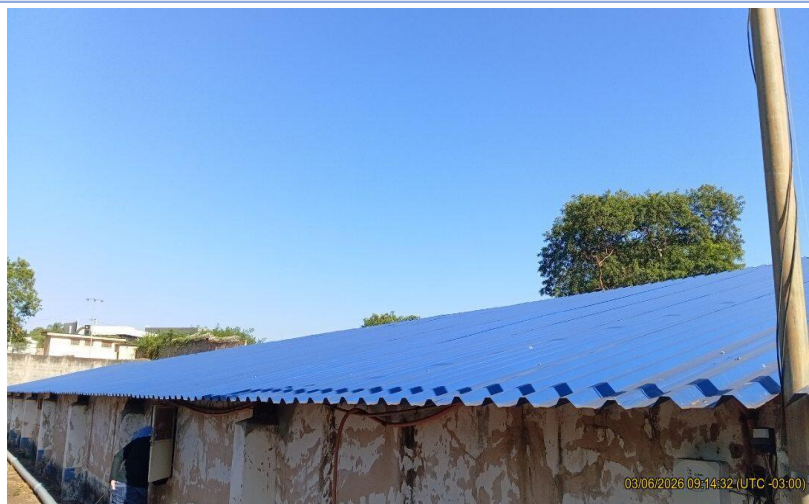
Figura TEC 19. Cobertura Reservatório Bairro Alto.
