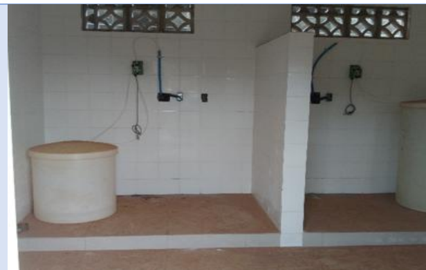
Figura TEC 14. Dosagem de produtos químicos, Poço Montebello (imagem do Prestador).
