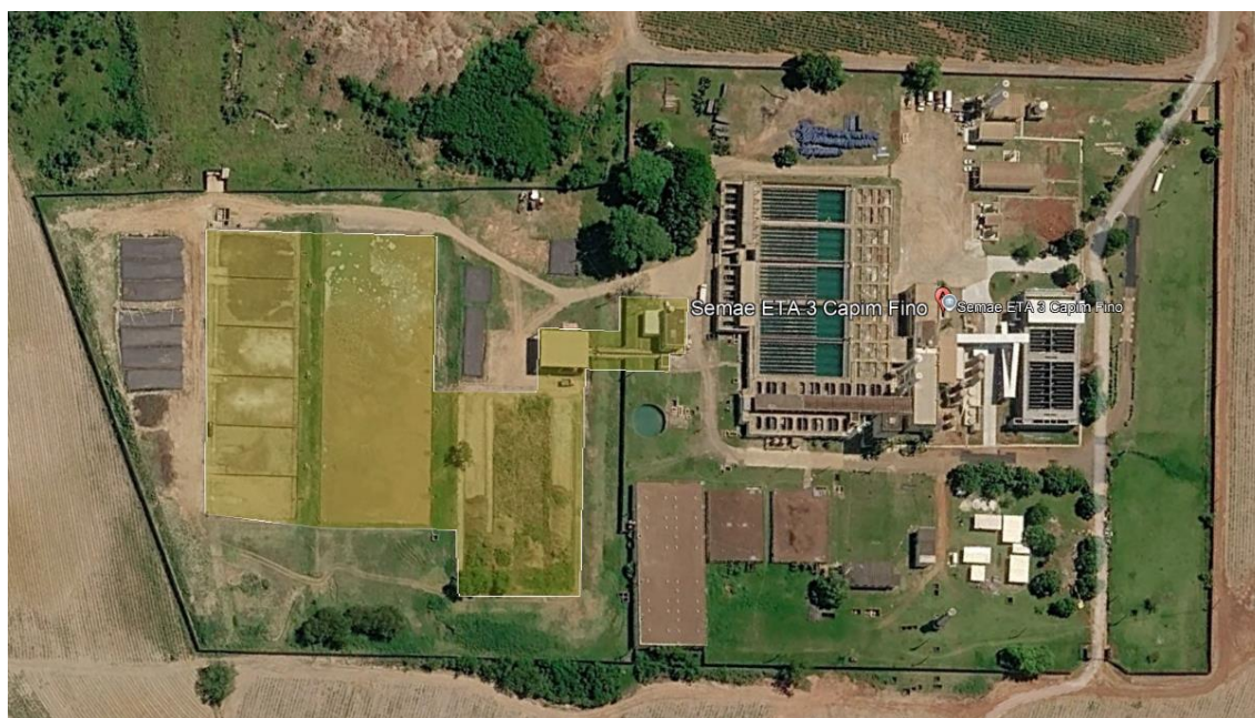
Figura 1 – Área (Em amarelo) de desidratação de lodo ETA Capim Fino
