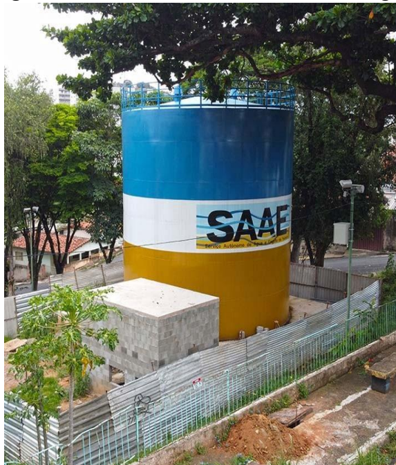
Figura TEC 3 – Reservatório Vila Monte Alegre
