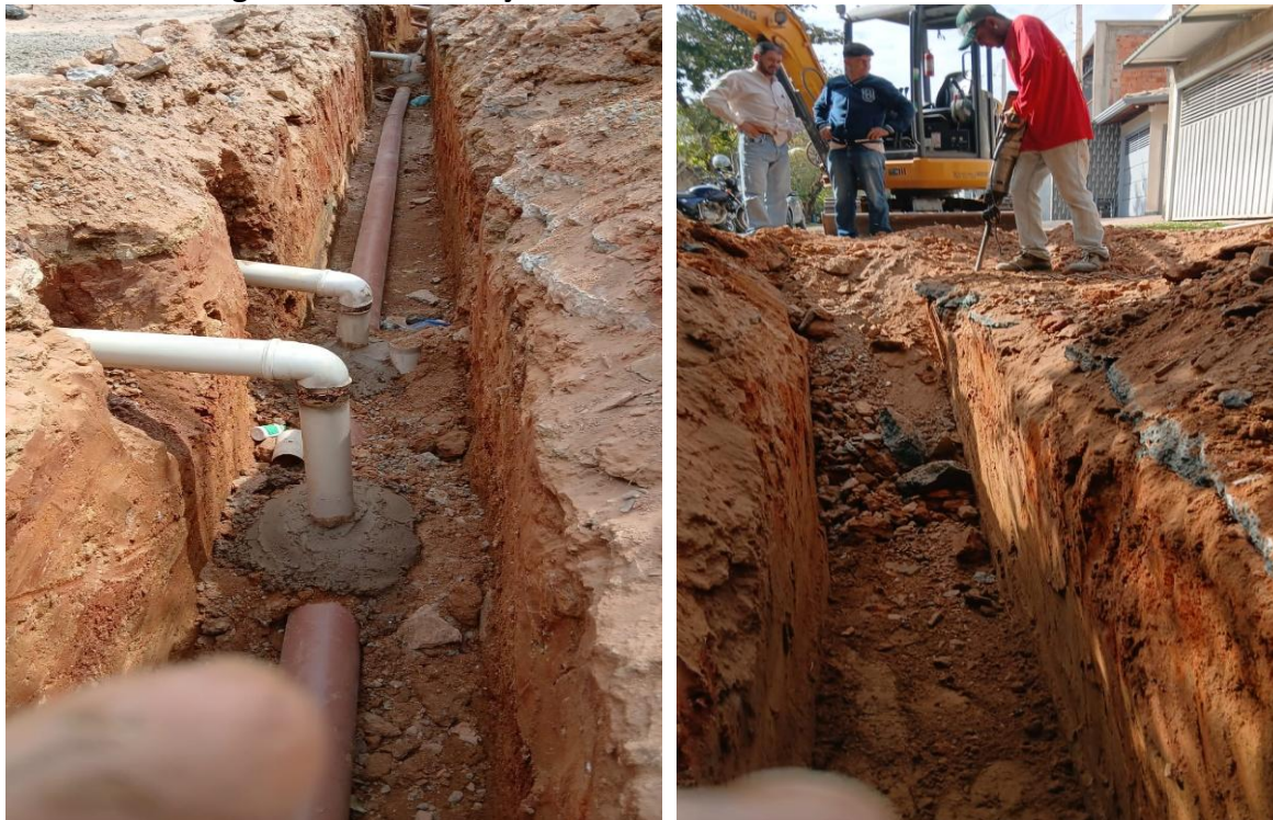
Figura TEC 8 – Execução de rede coletora na Rua Primo Pazini
