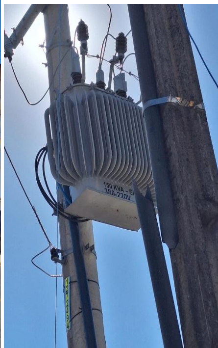
Figura TEC 4 – Transformador – 150KVA para utilização no Sistema de Abastecimento de Água
