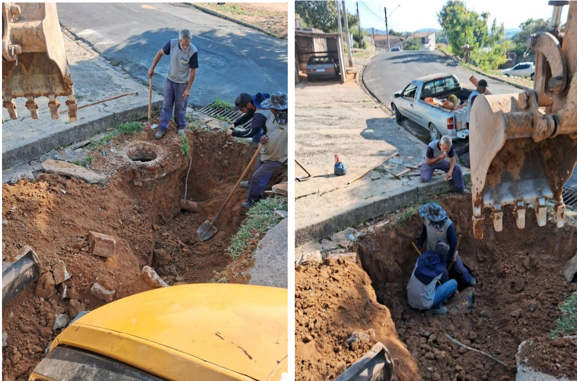
Figura TEC 7 – Execução de rede coletora do Jardim Andrade
