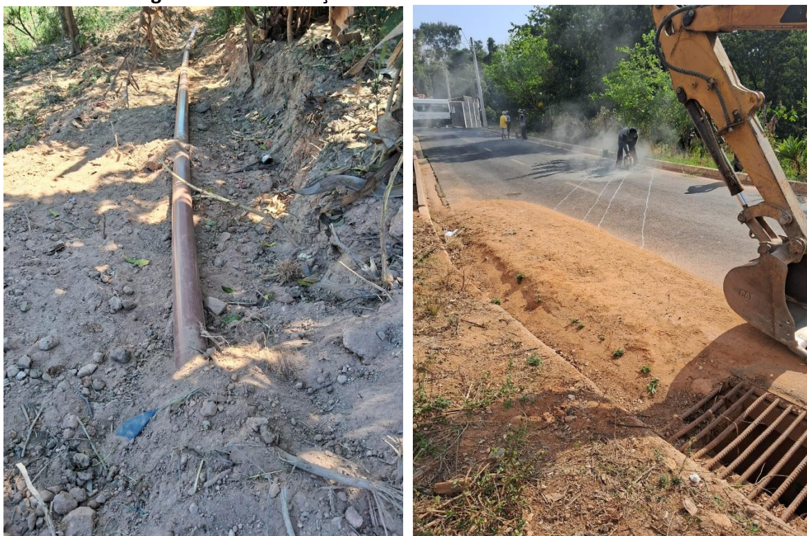
Figura TEC 6 – Execução de rede coletora do Jardim Andrade
