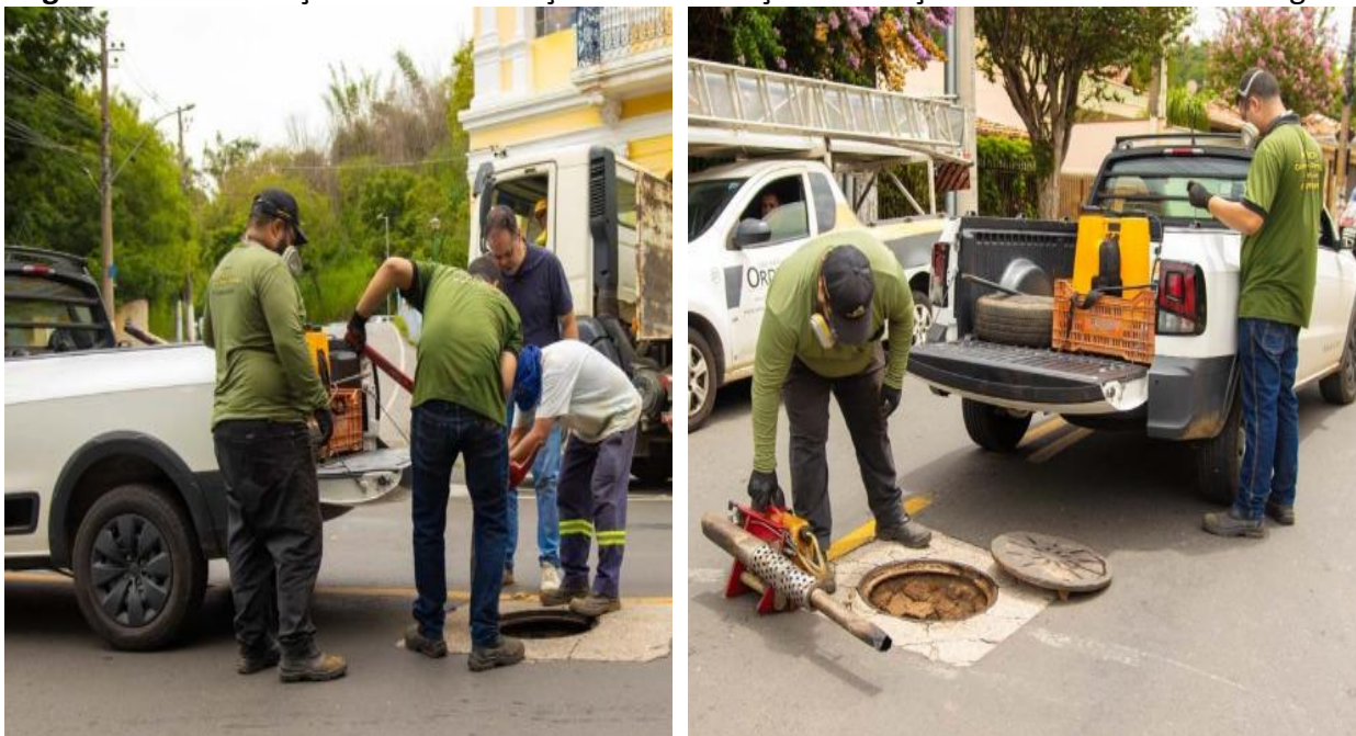
Figura TEC 5 – Serviço de Desinsetização e Desratização dos Poços de Visita da rede de esgoto
