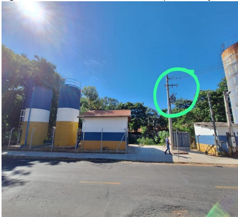
Figura TEC 4 – Transformador – 150KVA para utilização no Sistema de Abastecimento de Água
