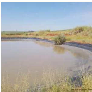
Foto 3 - Lagoa 1 - Recebimento do esgoto bruto
