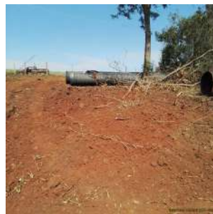
Foto 3 - Tubulação que sobrou da manutenção
