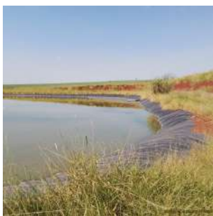
Foto 11 - Entrada da Lagoa 2 (desnívelamento das entradas)
