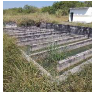
Foto 18 - Tanque de Contato (Chicanas)
