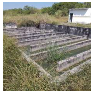
Foto 3 - Tanque de Contato (Chicanas)
