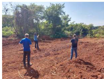
Foto 7 - Vista geral do trecho do emissário substituído
