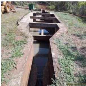
Foto 3 - Vista Geral EEE
