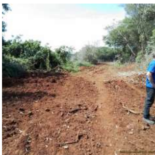
Foto 4 - Trecho do emissário substituído
