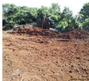
Foto 5 - Trecho do emissário substituído
