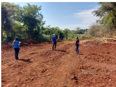
Foto 6 - Vista geral do trecho do emissário substituído
