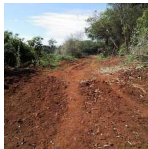
Foto 2 - Trecho do emissário substituído
