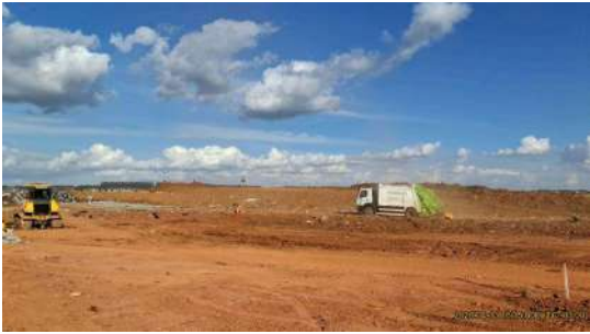
Foto 3 - Frente de operação
