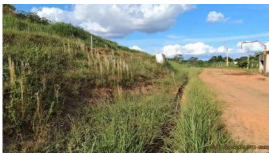
Foto 19 - Drenagem de águas pluviais
