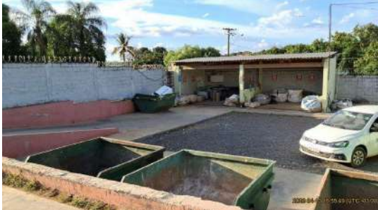
Foto 15 - Visão geral, interna
