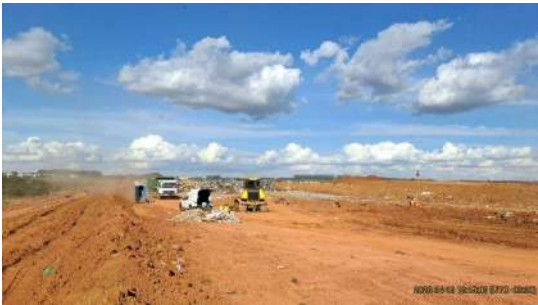
Foto 2 - Frente de operação
