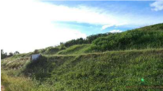
Foto 27 - Talude do aterro, sul
