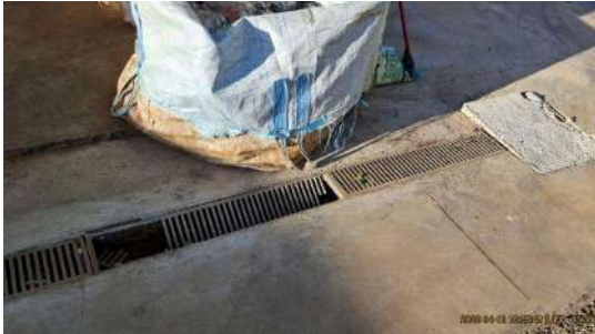
Foto 5 - Visão geral, interna
