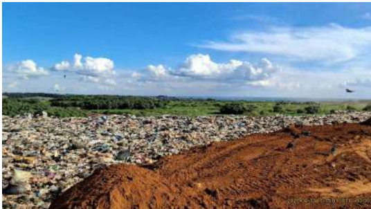
Foto 11 - Frente de operação
