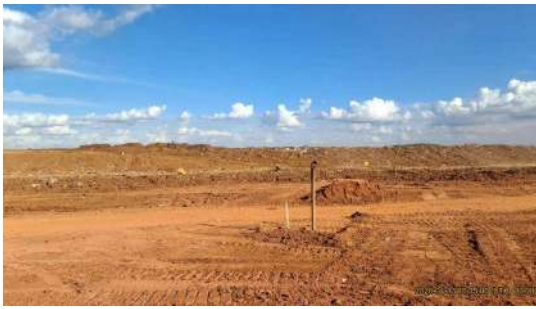
Foto 5 - Frente de operação
