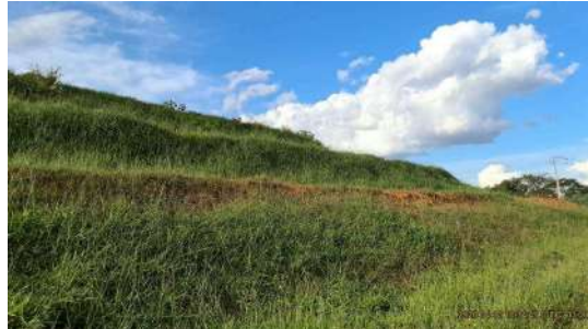
Foto 28 - Talude do aterro, sul
