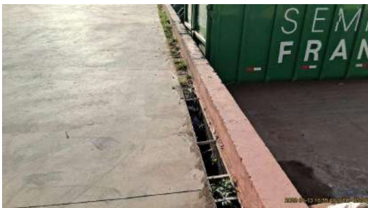
Foto 11 - Visão geral, interna
