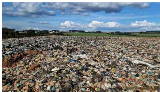
Foto 16 - Frente de operação
