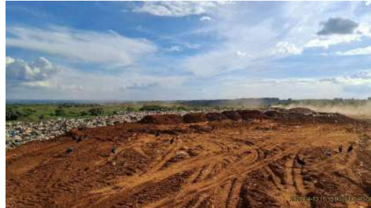
Foto 8 - Frente de operação
