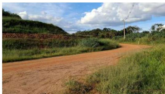
Foto 24 - Talude do aterro, sul
