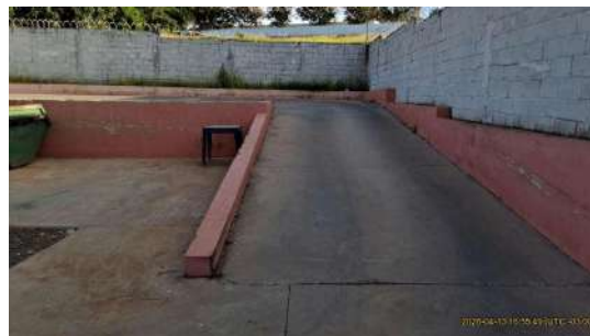
Foto 8 - Visão geral, interna
