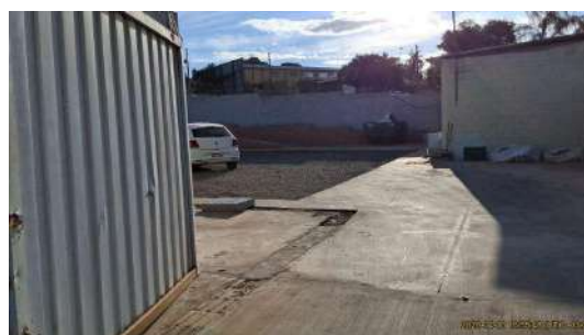
Foto 2 - Visão geral, acesso
