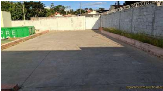
Foto 9 - Visão geral, interna
