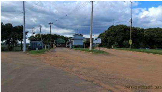
Foto 1 - Acesso e balança rodoviária
