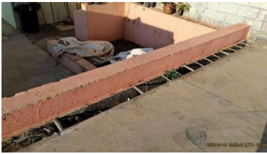
Foto 13 - Visão geral, interna
