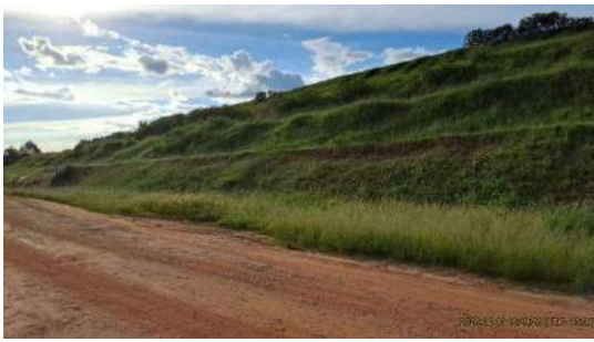
Foto 25 - Talude do aterro, sul
