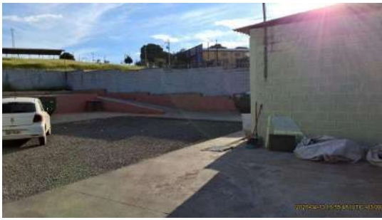
Foto 3 - Visão geral, interna
